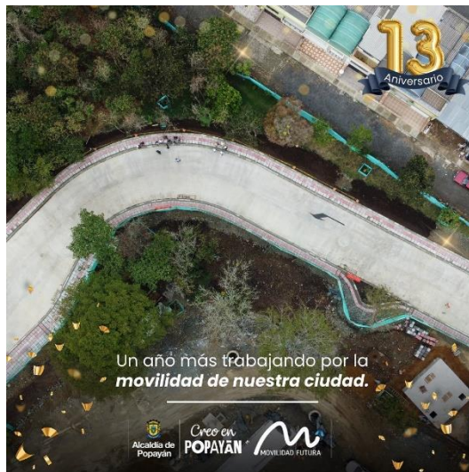
Imagen 65. Ausencia de sobre ancho en el eje 5
