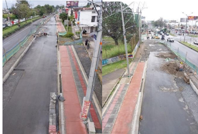
Imagen 32. Estado aguas arriba y aguas abajo de la fase 3 a la altura del puente peatonal del CC Campanario (Archivo personal)
