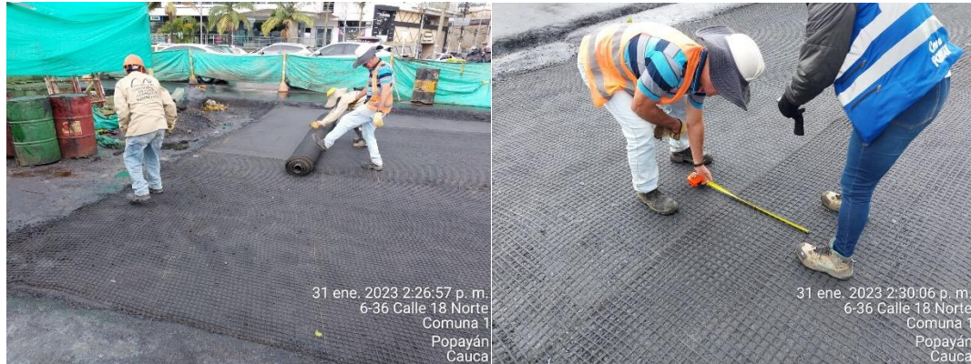
Imagen 41. Extensión, anclaje y traslape en la geomalla (Archivo personal)
