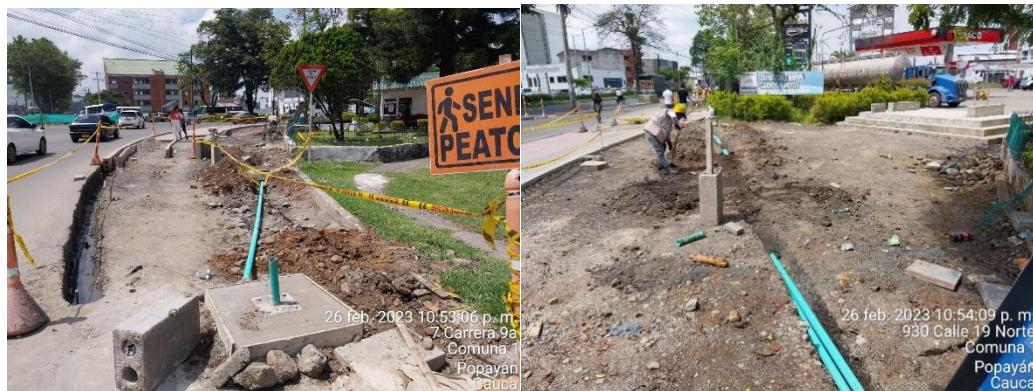
Imagen 48. Instalación de tubería y pedestales para semaforización (Archivo personal)
