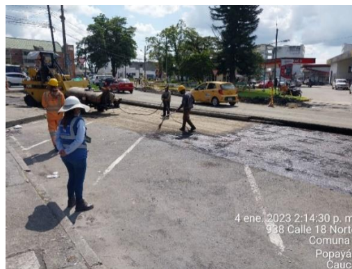
Imagen 35. Aplicación de la emulsión asfáltica (Archivo personal)
