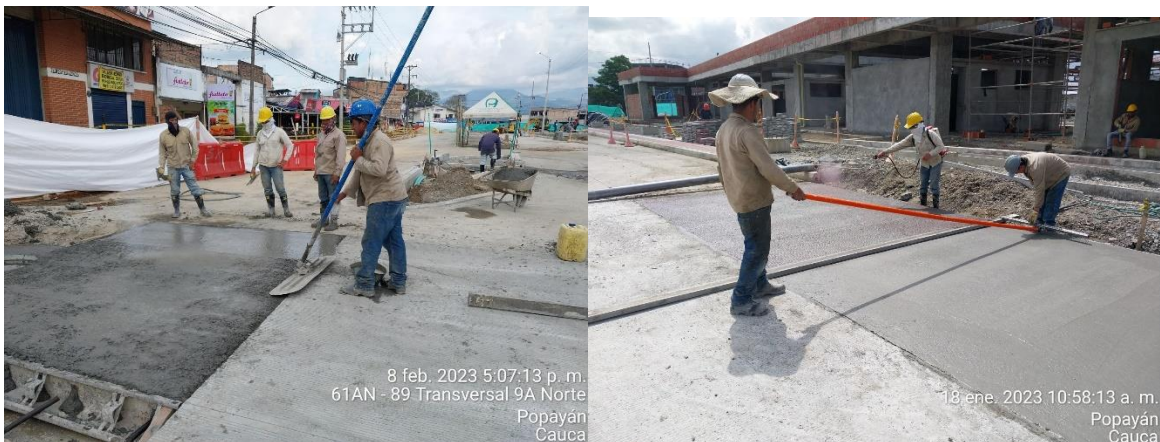
Imagen 15. A la izquierda, enrasado del concreto; a la derecha, aplicación del antisol (Archivo personal)
