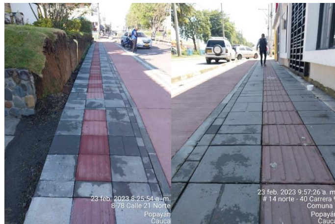
Imagen 42. Rampas de acceso y losetas guía (Archivo personal)
