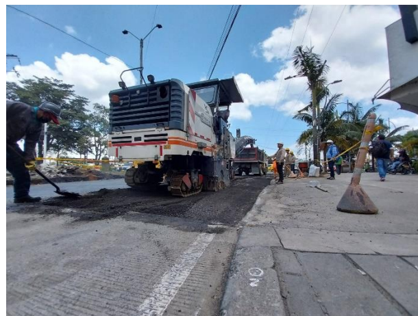
Imagen 33. Fresado de capa existente - Sector de Catay (Archivo personal)
