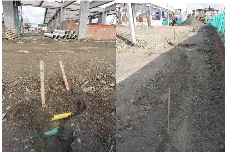
Imagen 20. Interferencia de red de gas madre con el eje 4 (Archivo personal)
