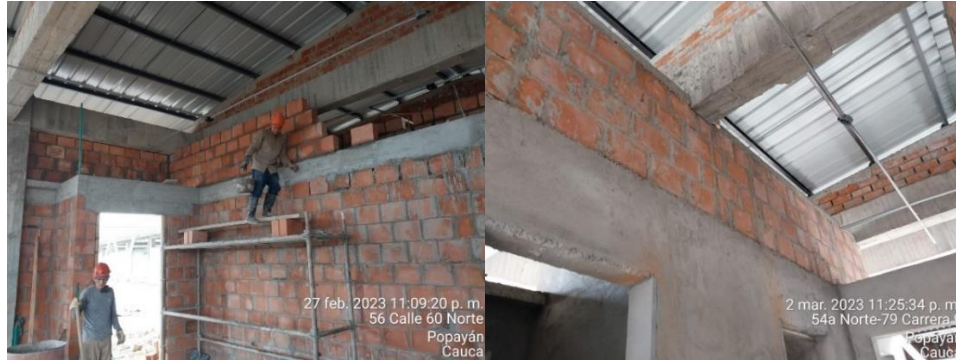
Imagen 18. A la izquierda, armado de muretes y colocación de dovelas; a la derecha, vigas cinta o de amarre (Archivo personal)
