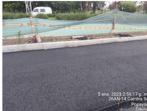
Imagen 67. Cimbra por encima del nivel de la capa al pasar la finisher (Archivo personal)
