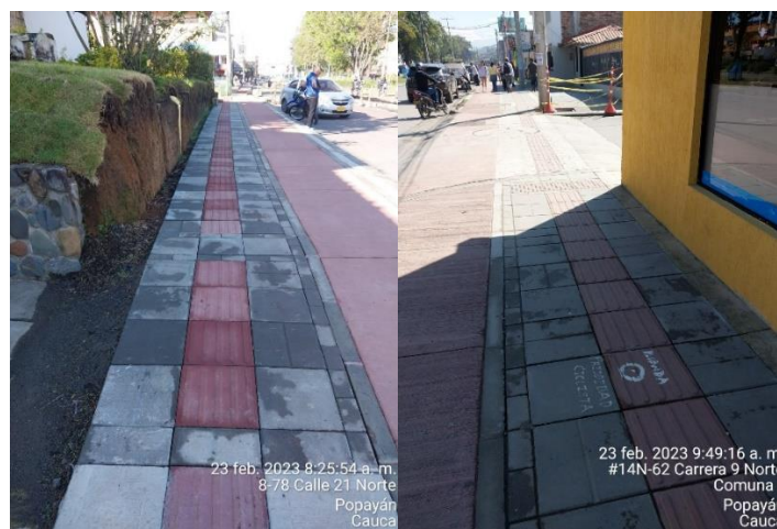
Imagen 73. Discontinuidad en loseta guía e incorrecta localización señales (Archivo personal)
