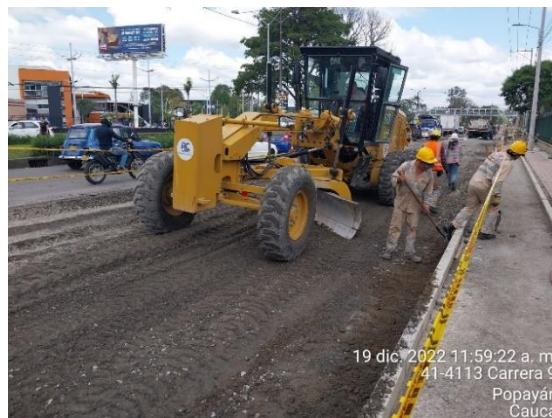
Imagen 34. Extensión de base granular (Archivo personal)
