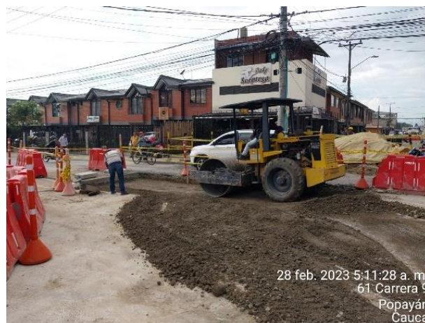
Imagen 7. Compactación de subbase en la trans. 9na (Archivo personal)
