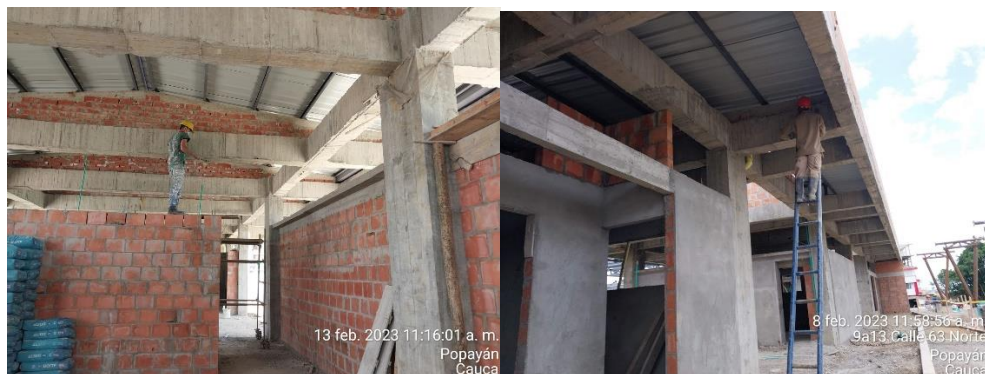
Imagen 58. Retiro de rebabas de vigas aéreas interna y externas (Archivo personal)
