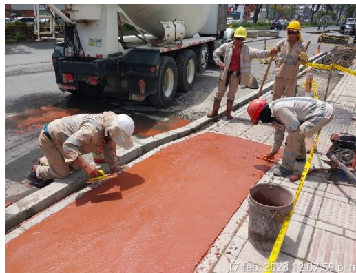
Imagen 44. Fundición de cicloruta - Sector Catay (Archivo personal)
