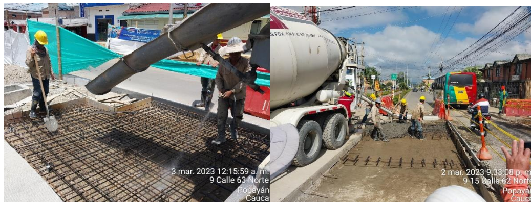
Imagen 13. Humedecimiento de la zona de influencia y vaciado del concreto (Archivo personal)
