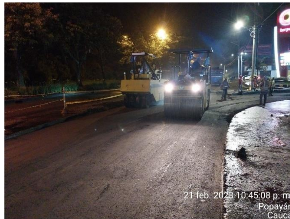
Imagen 38. Rodillo vibratorio y compactador de llantas sellando la mezcla tipo MDC19 (Archivo personal)
