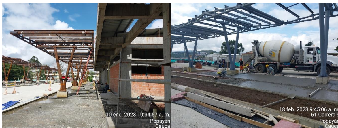
Imagen 25. Pasarelas metálicas y fundición de concreto en las mismas (Archivo personal)
