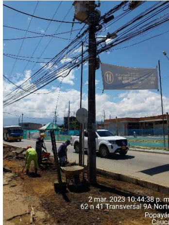
Imagen 22. Poste eléctrico a remover en espacio público del eje 2 (Archivo personal)
