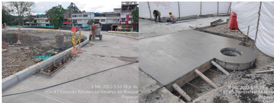
Imagen 24. A la izquierda, fundición de sumidero in situ del eje 4; a la derecha, fundición del brocal monóticamente (Archivo personal)
