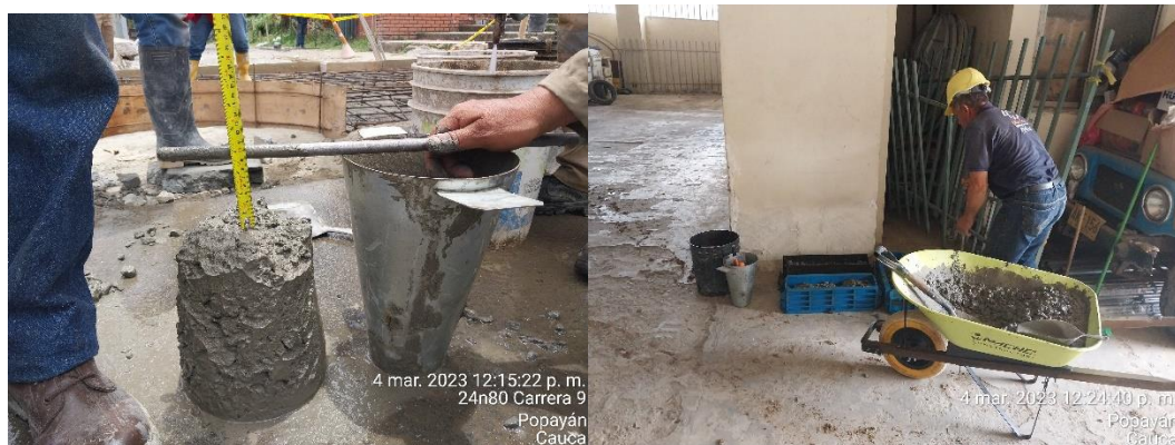
Imagen 45. Ensayo de Slump y toma de testigos de concreto (Archivo personal)
