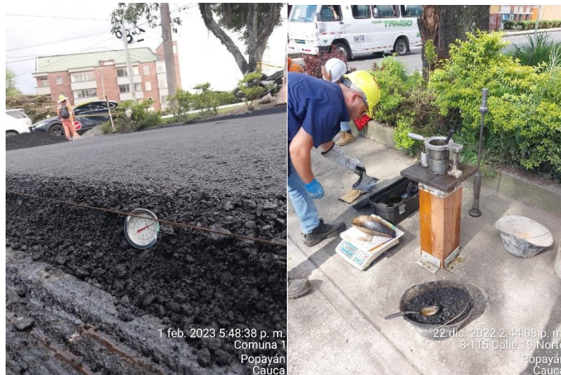
Imagen 36. A la izquierda, toma de temperatura; a la derecha, realización de briquetas Marshall in situ (Archivo personal)
