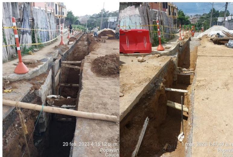
Imagen 19. Brecha para instalación de redes para el descole (Archivo personal)
