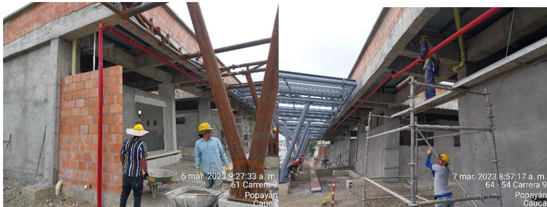
Imagen 23. Instalación de la tubería para red contra incendios (Archivo personal)
