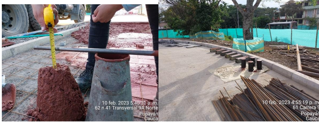
Imagen 26. Ensayo de asentamiento y toma de muestras de concreto (Archivo personal)
