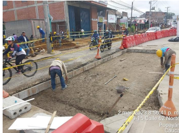
Imagen 10. Colocación de formaletas y sujetadores (Archivo personal)
