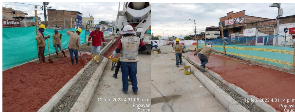
Imagen 27. Extensión y enrasado del concreto (Archivo personal)
