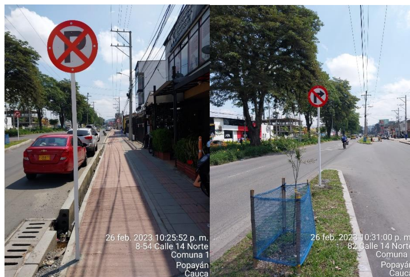
Imagen 49. Instalación de señalización vertical (Archivo personal)
