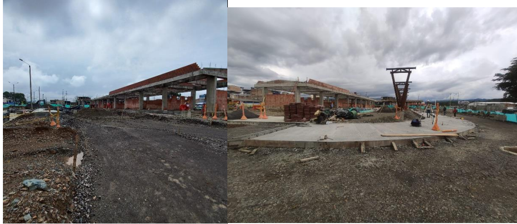
Imagen 4. A la izquierda eje 4 en subbase, a la derecha eje 6 y pasarela 3 (Archivo personal)
