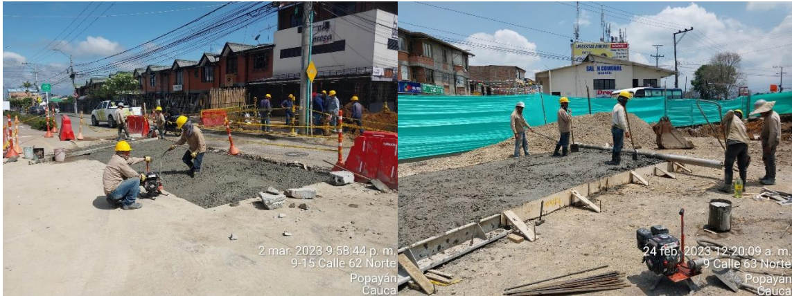
Imagen 14. A la izquierda, vibrado del concreto; a la derecha, compactación del concreto (Archivo personal)
