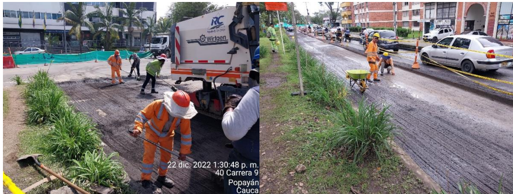
Imagen 40. Empleo del soplete para remoción de partículas finas (Archivo personal)
