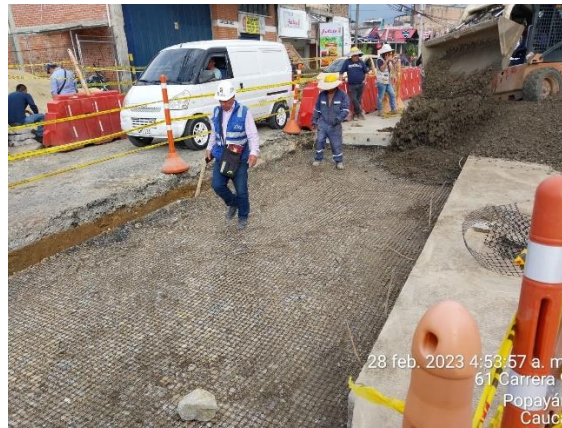
Imagen 9. Geomalla instalada y anclada, extensión de subbase (Archivo personal)
