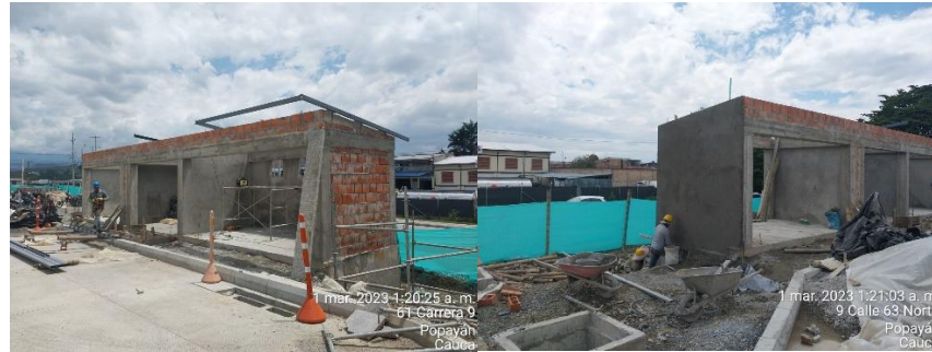
Imagen 29. Construcción del cuarto de máquinas (Archivo personal)
