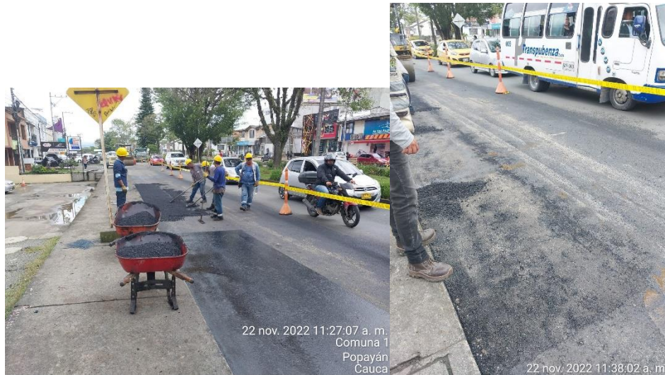
Imagen 72. Arreglo a empozamiento generado (Archivo personal)
