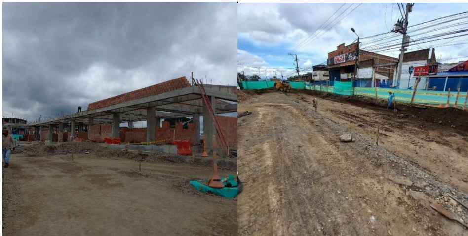
Imagen 3. A la izquierda módulo 1 con mampostería, a la derecha eje 2 en proceso de cajeo (Archivo personal)
