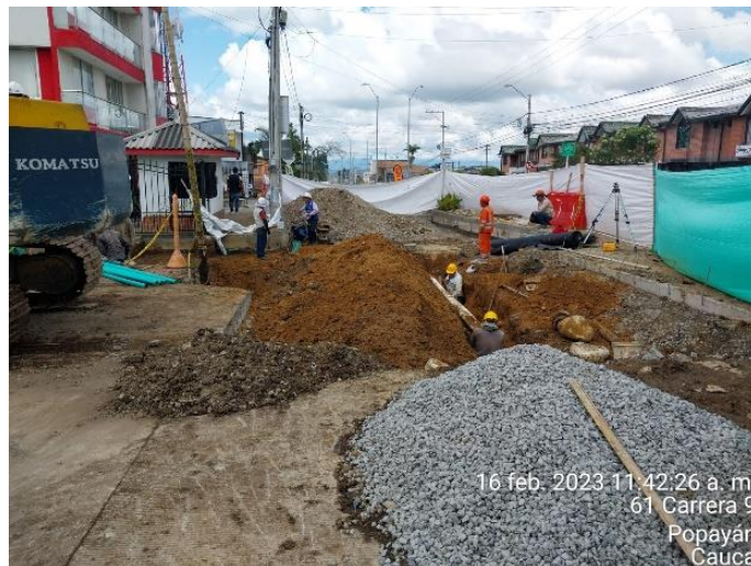
Imagen 5. Cajeo y refuerzo del empalme en la transversal 9na (Archivo personal)
