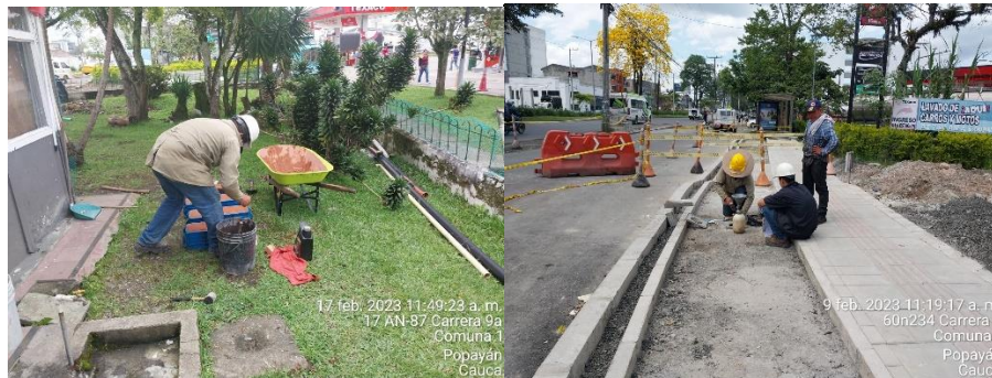
Imagen 43. Toma de testigos de concreto y ensayo de densidad (Archivo personal)
