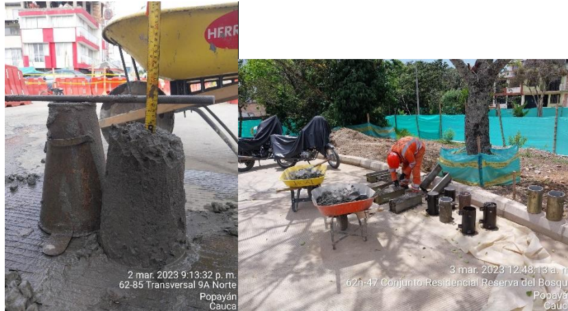
Imagen 12. A la izquierda, ensayo Slump; a la derecha, toma de testigos de concreto (Archivo personal)
