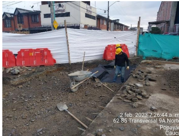
Imagen 6. Instalación del geotextil tipo T2100 en la transversal 9na (Archivo personal)
