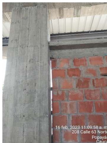
Imagen 60. Disminución de la sección del elemento (Archivo personal)
