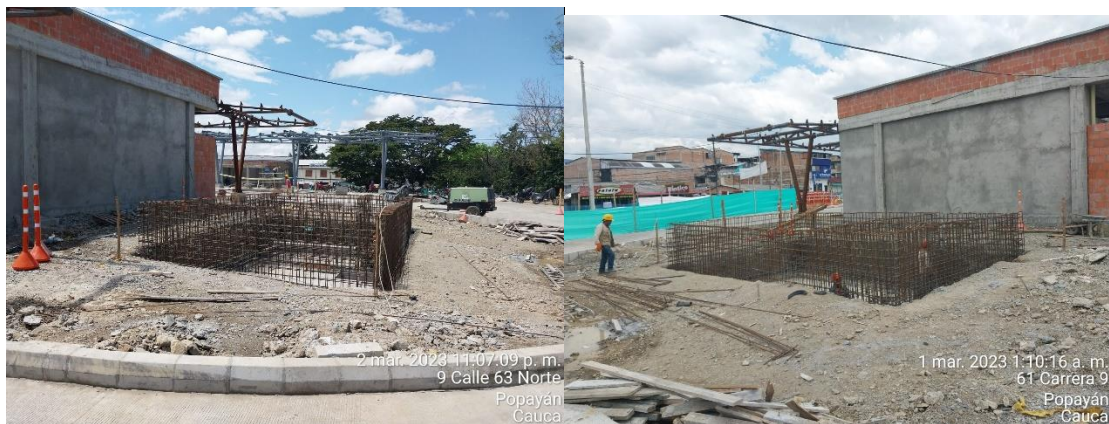
Imagen 28. Tanque hermético para red contra incendios (Archivo personal)
