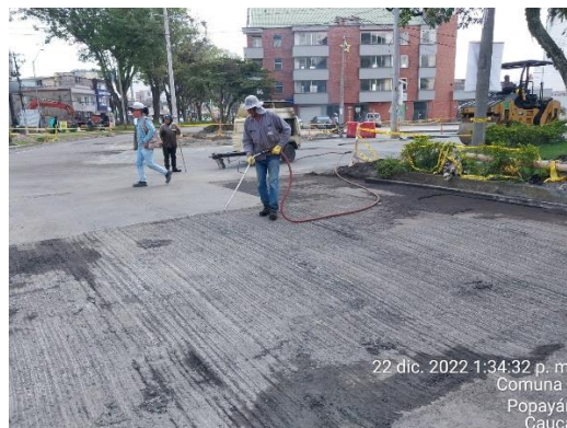
Imagen 40. Empleo del soplete para remoción de partículas finas (Archivo personal)
