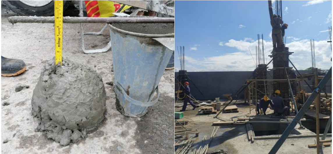
Figura 98. Colocación del Concreto de 21Mpa - 3000 Psi - Columnas
