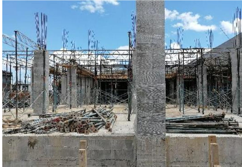
Figura 102. Instalación de Soportes Para Segundo Piso
