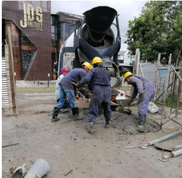
Figura 96. Colocación de Rampa de Acceso
