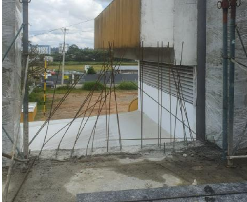
Figura 107. Acero Para Pantallas
