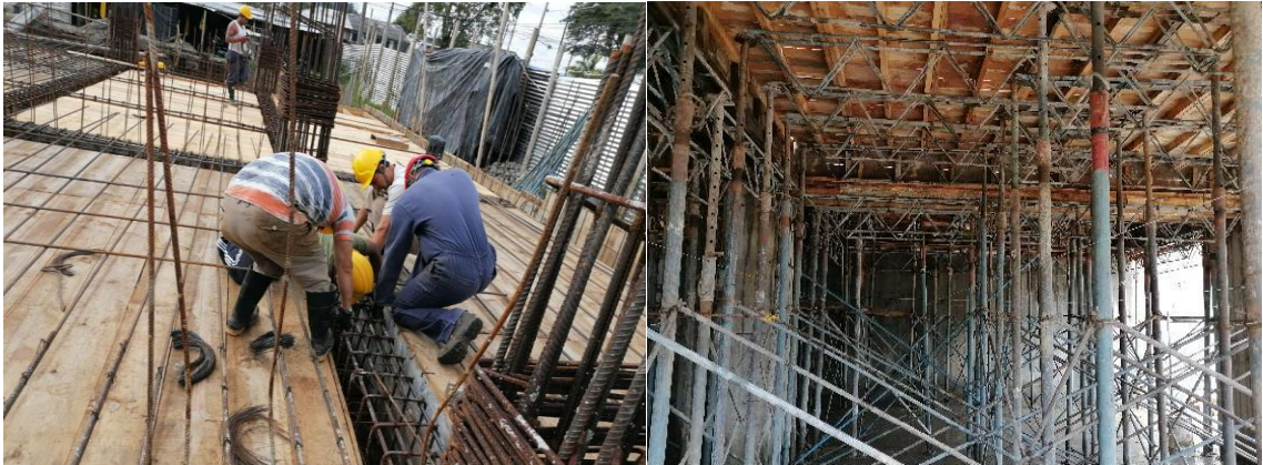
Figura 90. Formaleta Para Vigas y Losa - Primer Nivel (2)
