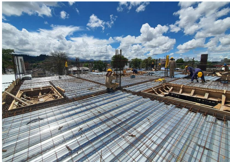
Figura 109. Formaleta Tercer Nivel
