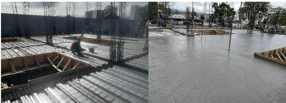
Figura 104. Instalación de Lámina y Formaleta Para Segundo Piso
