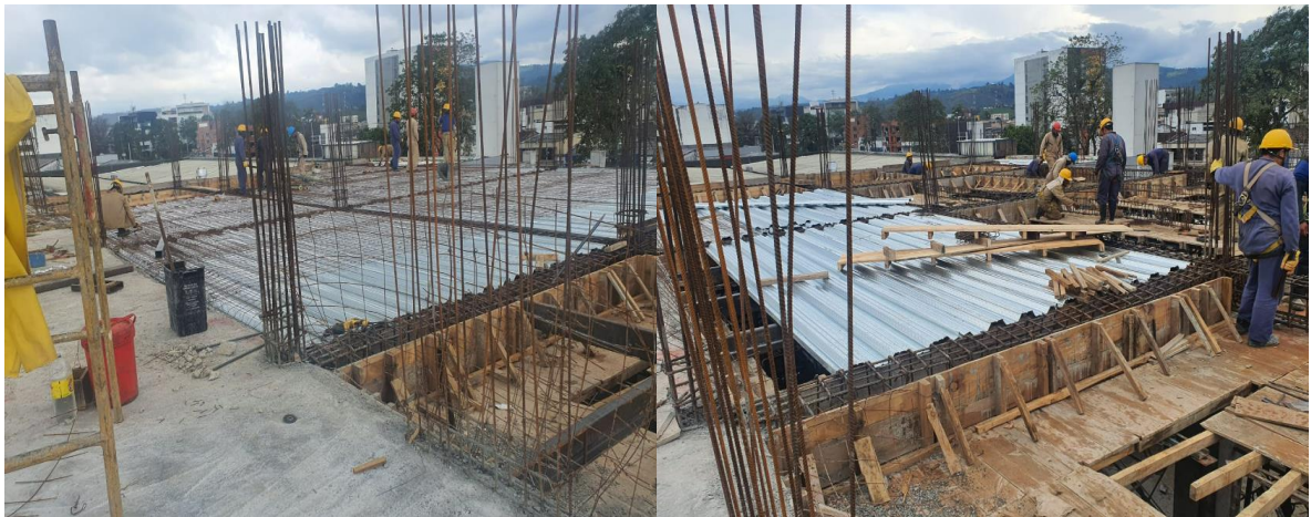
Figura 103. Formaleta Para Vigas y Losa - Primer Nivel (3)
