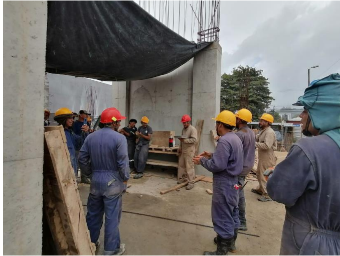
Figura 94. Descansos y Compartir con Personal de Obra
