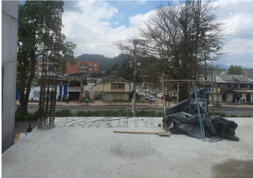
Figura 106. Armado de Acero Para Columnas
