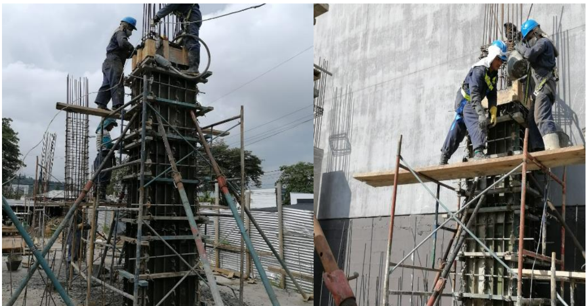
Figura 95. Formaleta Para Columnas - Segundo Nivel
