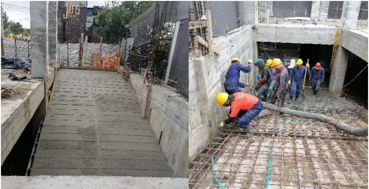
Figura 101. Colocación de Concreto 21Mpa - Rampa de Acceso Sótano
