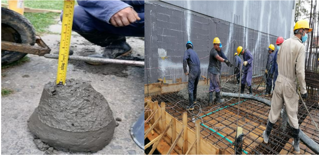
Figura 92. Colocación del Concreto de 21Mpa - 3000 Psi
