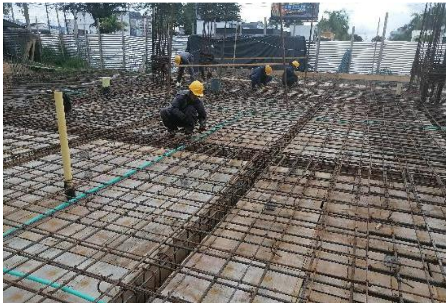
Figura 91. Instalación de Acero Para Primer Nivel
