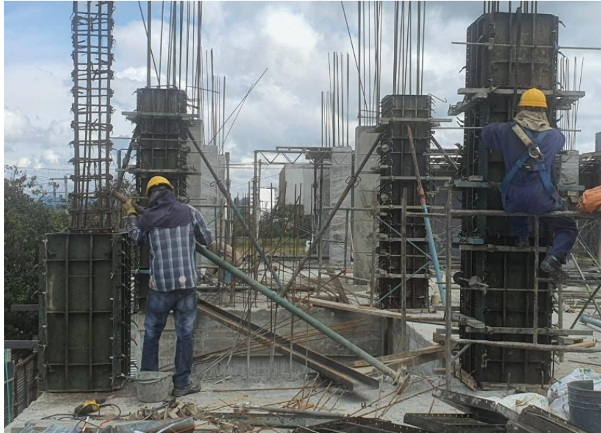
Figura 108. Formaleta de Columnas Tercer Nivel
