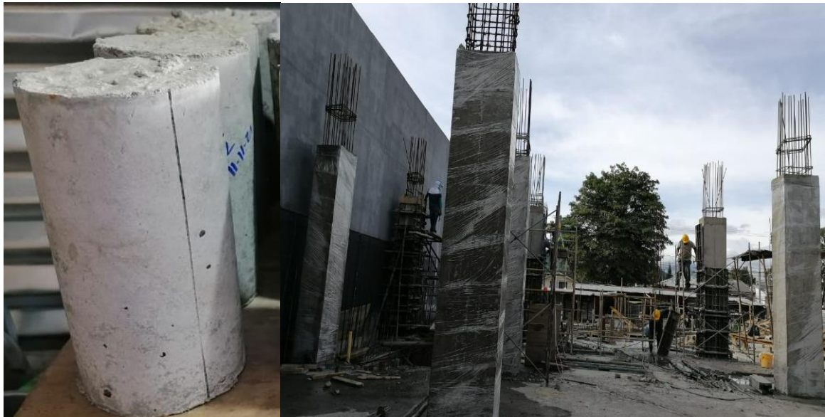
Figura 99. Curado de Columnas Concreto de 21Mpa – Segundo Nivel
