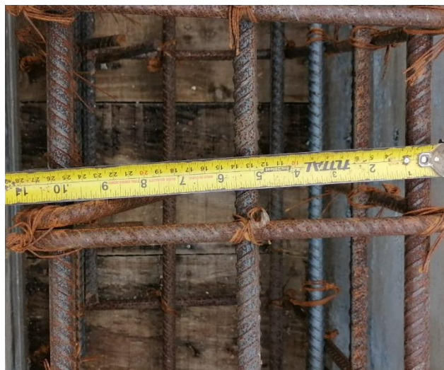
Figura 97. Acero de Refuerzo Columnas
