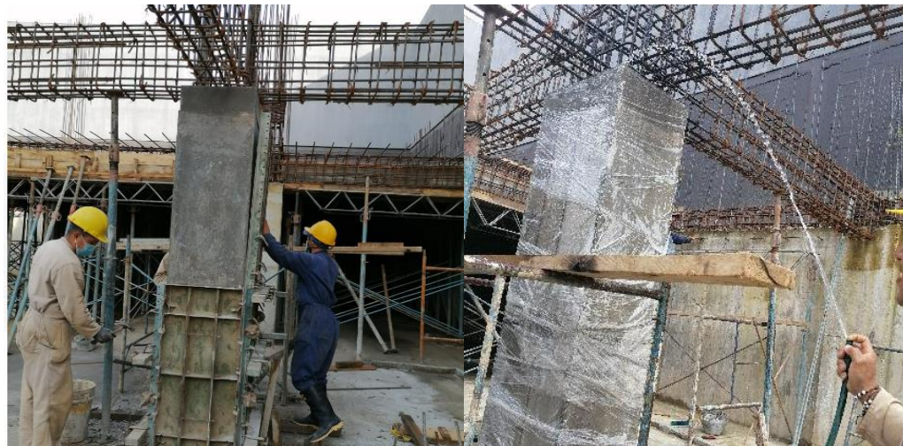
Figura 87. Humedecimiento de Columnas
