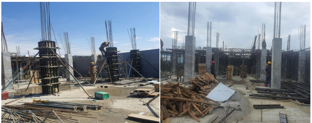
Figura 85. Desencofrado de Columnas Sótano - Piso 1
