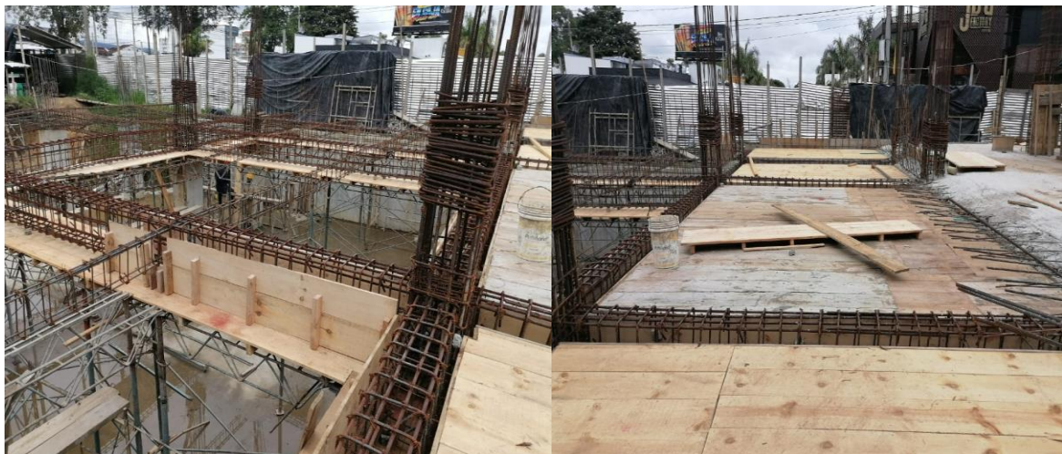
Figura 89. Formaleta Para Vigas y Losa - Primer Nivel (1)
