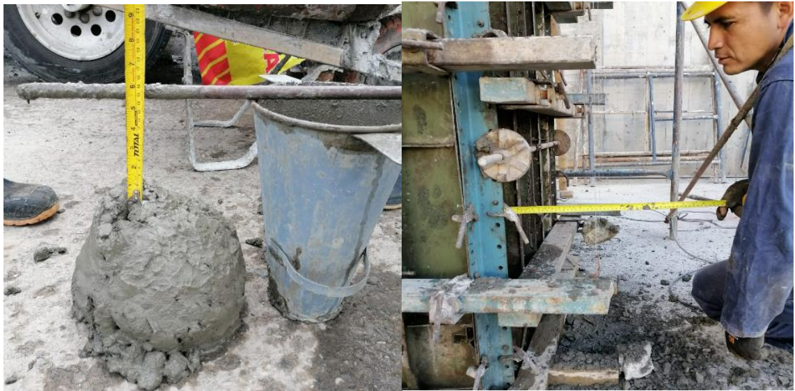
Figura 86. Prueba del Slump – Chequeo Columnas
