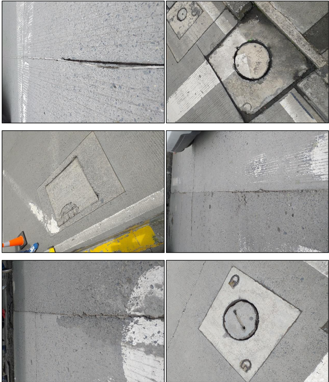
Fuente: Registro fotográfico Auscultación Tramo 3D-B
