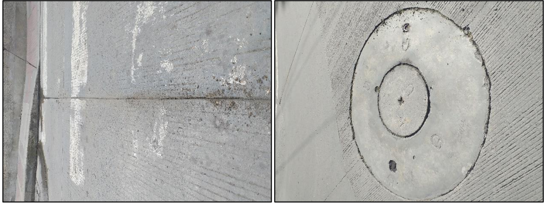
Fuente: Registro fotográfico Auscultación Tramo 3D-C
