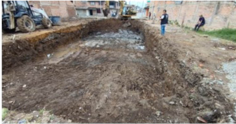
Ilustración 13. Avance de las obras durante la iniciación de la práctica
