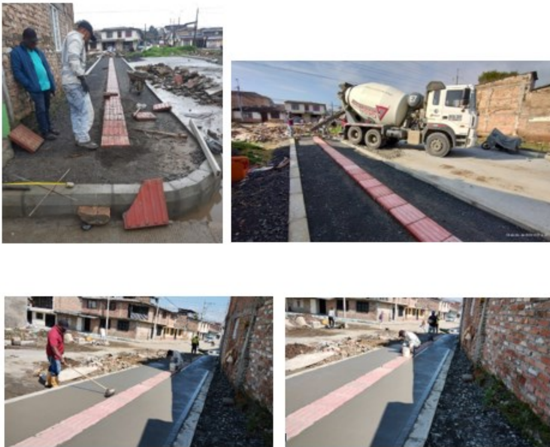
Ilustración 28. Fundición espacio público Barrio Alfonso López.
