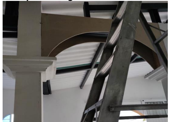
Ilustración 46. Detalle de arreglos, proceso Iglesia Retiro Alto
