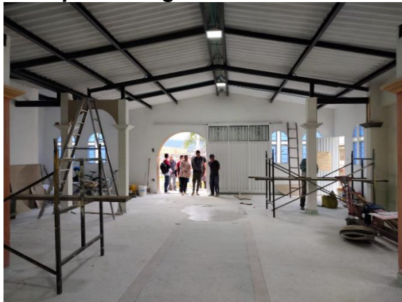
Ilustración 45. Detalle de arreglos, proceso Iglesia Retiro Alto
