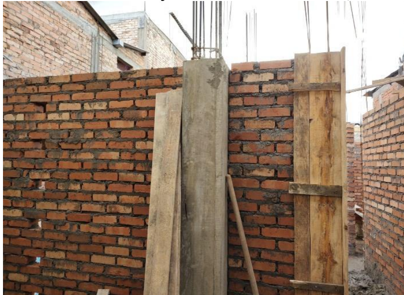
Ilustración 22. Encofrado y fundición de columnas, obra Palacé
