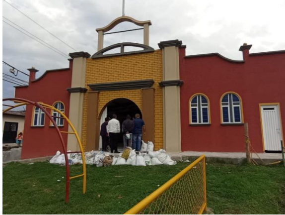
Ilustración 43. Detalle de arreglos, proceso Iglesia Retiro Alto
