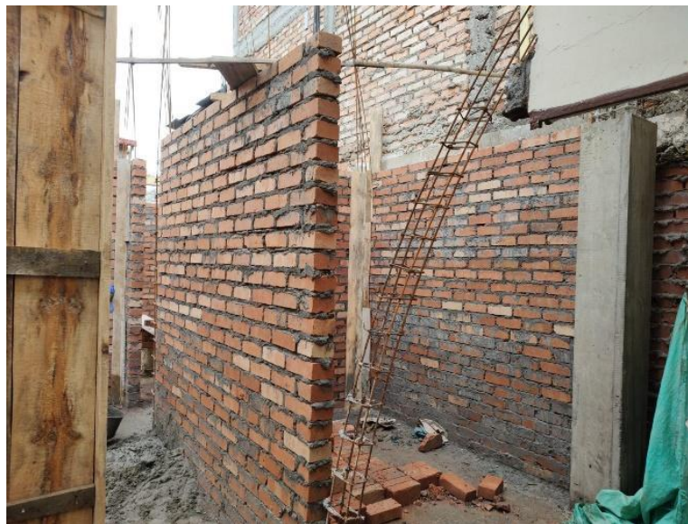
Ilustración 23. Construcción de muros en mampostería confinada, obra Palacé
