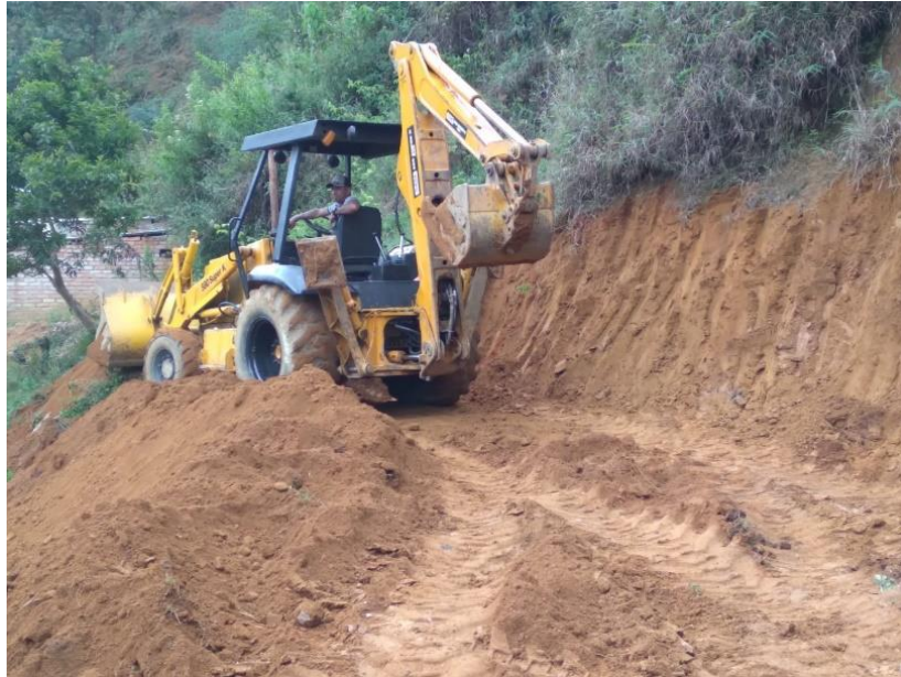
Ilustración 51. Evidencia del movimiento de tierra realizado, proceso Poblado los Sauces, Lote 125
