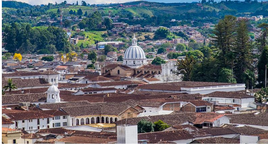
Ilustración 1. Vista panorámica de la ciudad de Popayán
