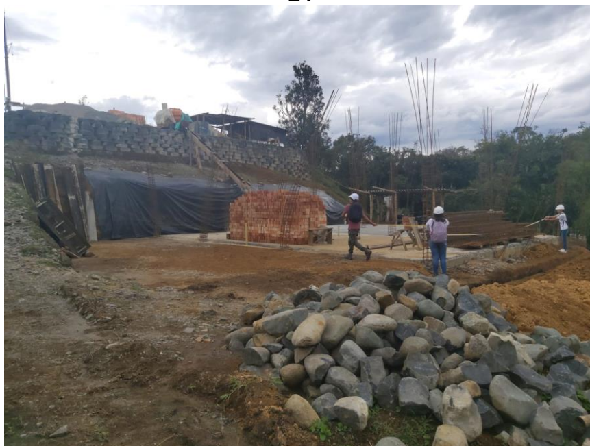
Ilustración 41. Avance de construcción lote 3), proceso San Francisco, Lote 24
