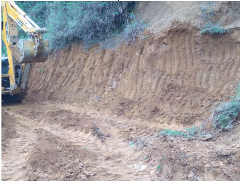
Ilustración 52. Evidencia del movimiento de tierra realizado, proceso Poblado los Sauces, Lote 125
