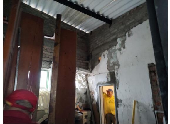
Ilustración 44. Detalle de arreglos, proceso Iglesia Retiro Alto
