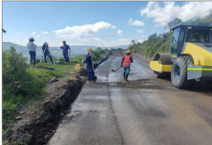
Ilustración 13.52 Compactación de subbase, km3+800
