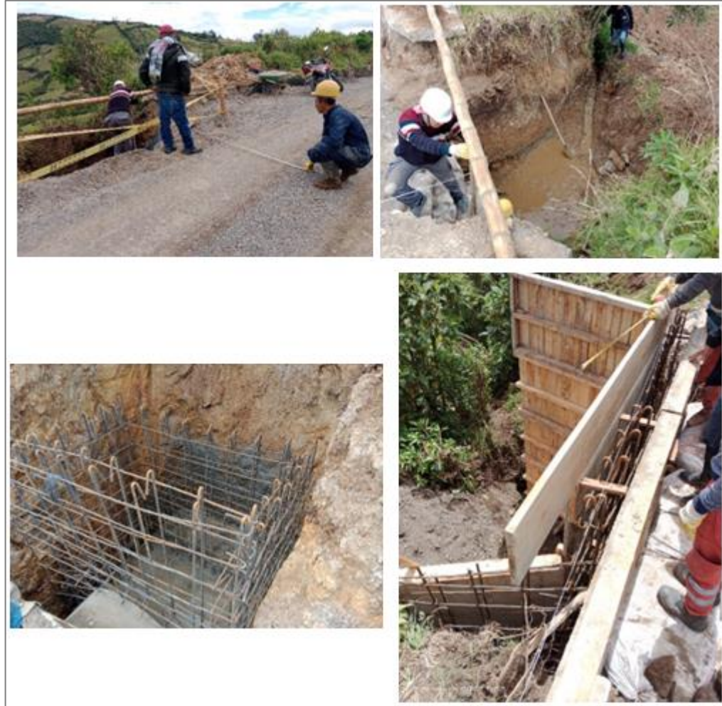
Ilustración 13.57 Construcción de alcantarillas, tramo de Guaitarilla.
