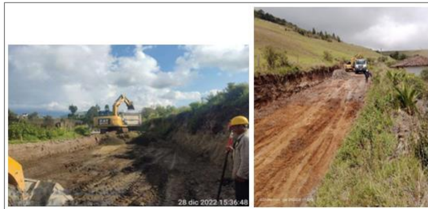
Ilustración 13.46 Desalojo de material producto de excavación. km2+160
