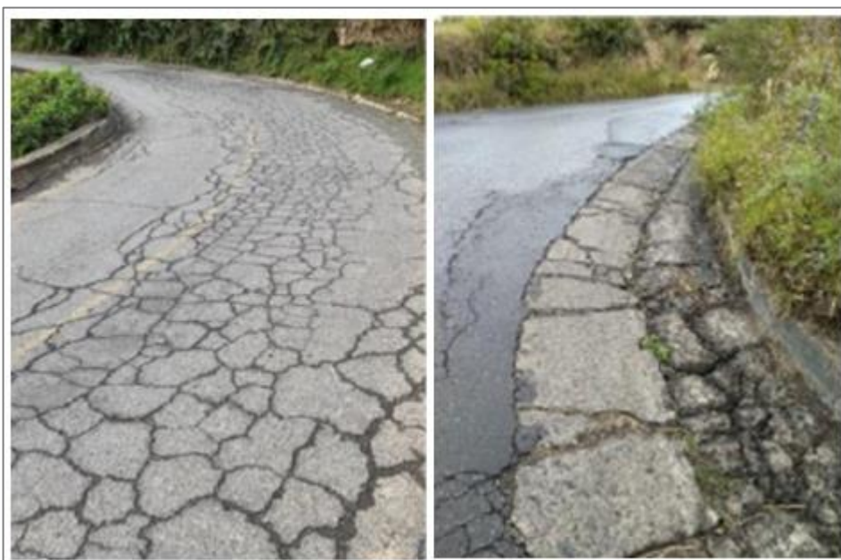
Ilustración 12.1 Evidencia fotográfica vía existente
