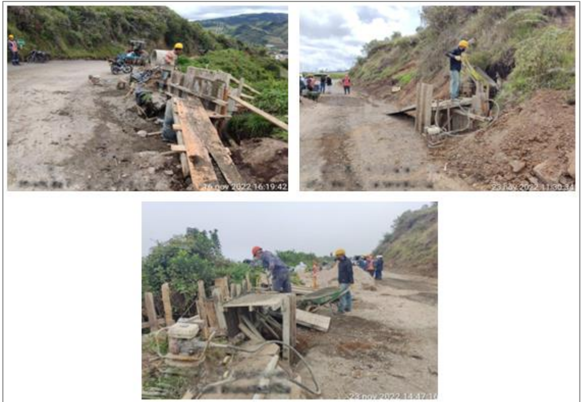
Ilustración 13.29 Fundición y vibrado de una alcantarilla, km11+350
