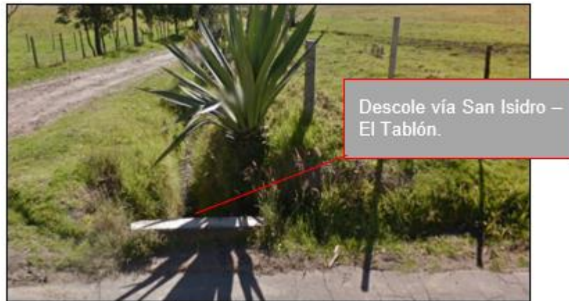
Ilustración 13.66 Actividades no previstas en la alcantarilla en el km4+270
