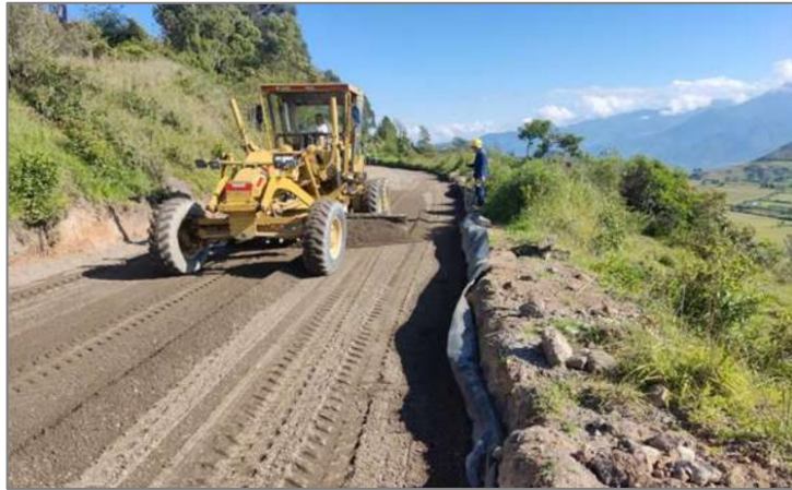
Ilustración 13.50 Extensión de subbase. km3+750
