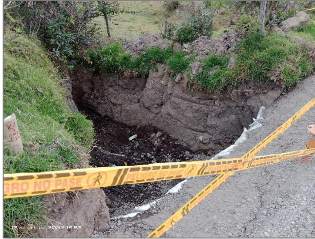
Ilustración 13.63 Actividades no previstas en la alcantarilla en el km4+270
