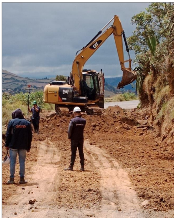
Ilustración 13.4, Demolición de carpeta asfáltica existente
