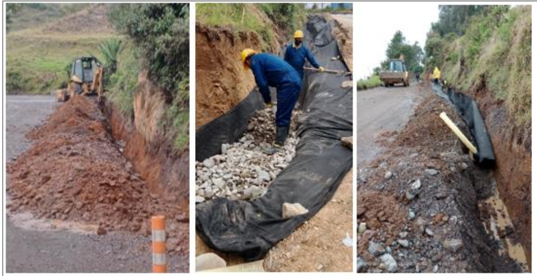
Ilustración 13.59 construcción filtro francés.
