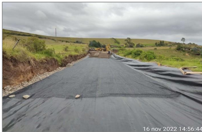
Ilustración 13.19 Instalación de geotextil y geomalla, km2+970
