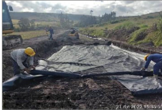
Ilustración 13.48 Instalación de geotextil y geomalla
