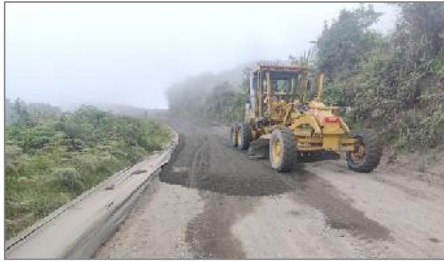
Ilustración 13.54 Avance de expansión de base, km11+270.
