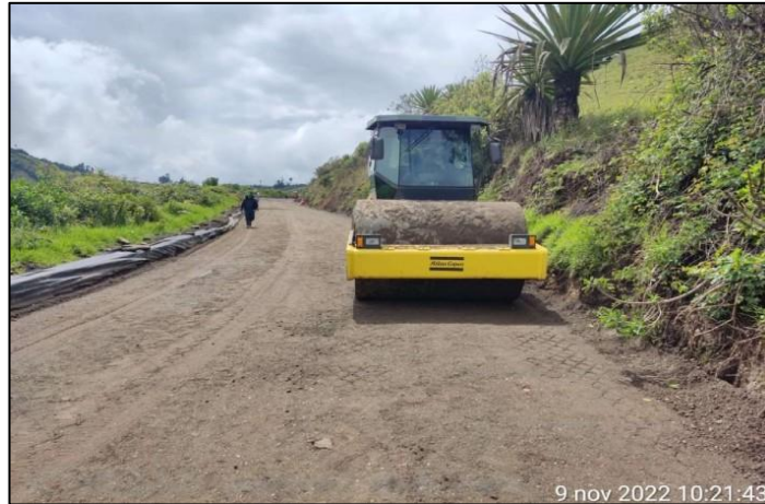
Ilustración 13.26 Compactación de subbase, km11+010
