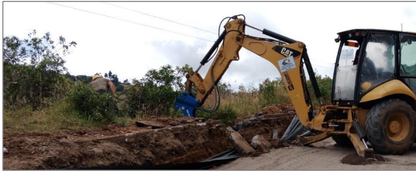
Ilustración 13.3 Demolición de cunetas
