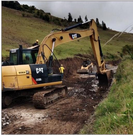
Ilustración 13.1 Excavación y demolición de pavimento y cunetas
