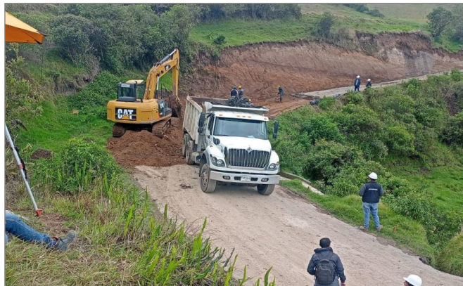
Ilustración 13.2 Desalojo de material hacia el ZODME
