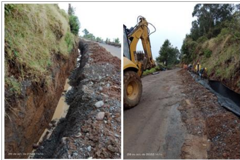
Ilustración 13.6 Excavación para filtro geo dren
