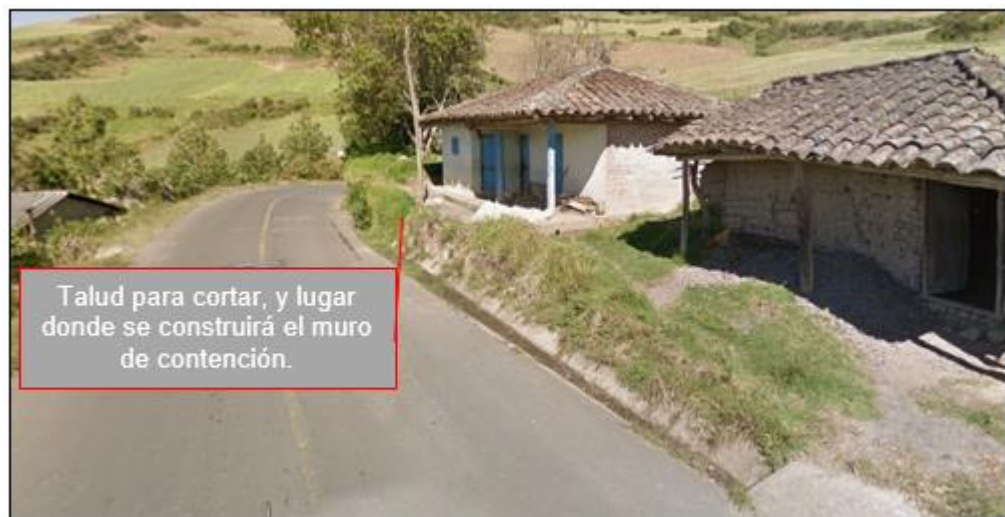
Ilustración 13.33 Casa de la señora Clara Tello donde se construirá un muro de contención
