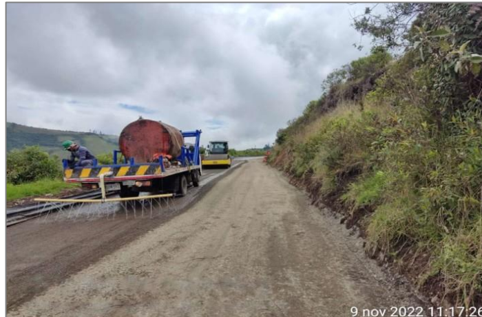
Ilustración 13.27 Humectación y compactación de subbase, km11+000
