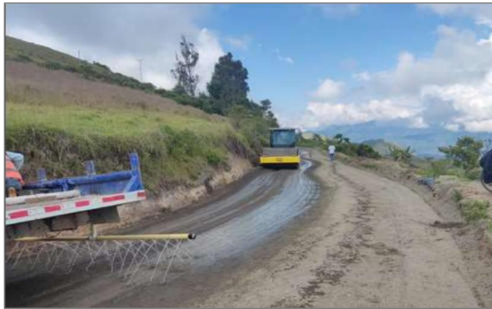
Ilustración 13.51 Humectación y compactación de subbase, km3+700
