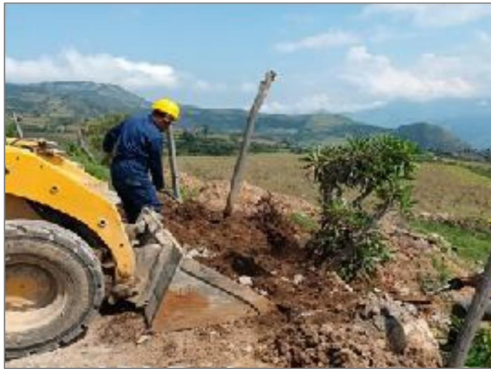
Ilustración 13.60 Desalojo de escombros depositado al costado de la vía.
