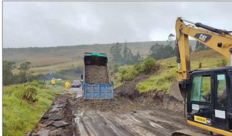
Ilustración 13.22 Descargue de material para construcción de pedraplen.km2+900
