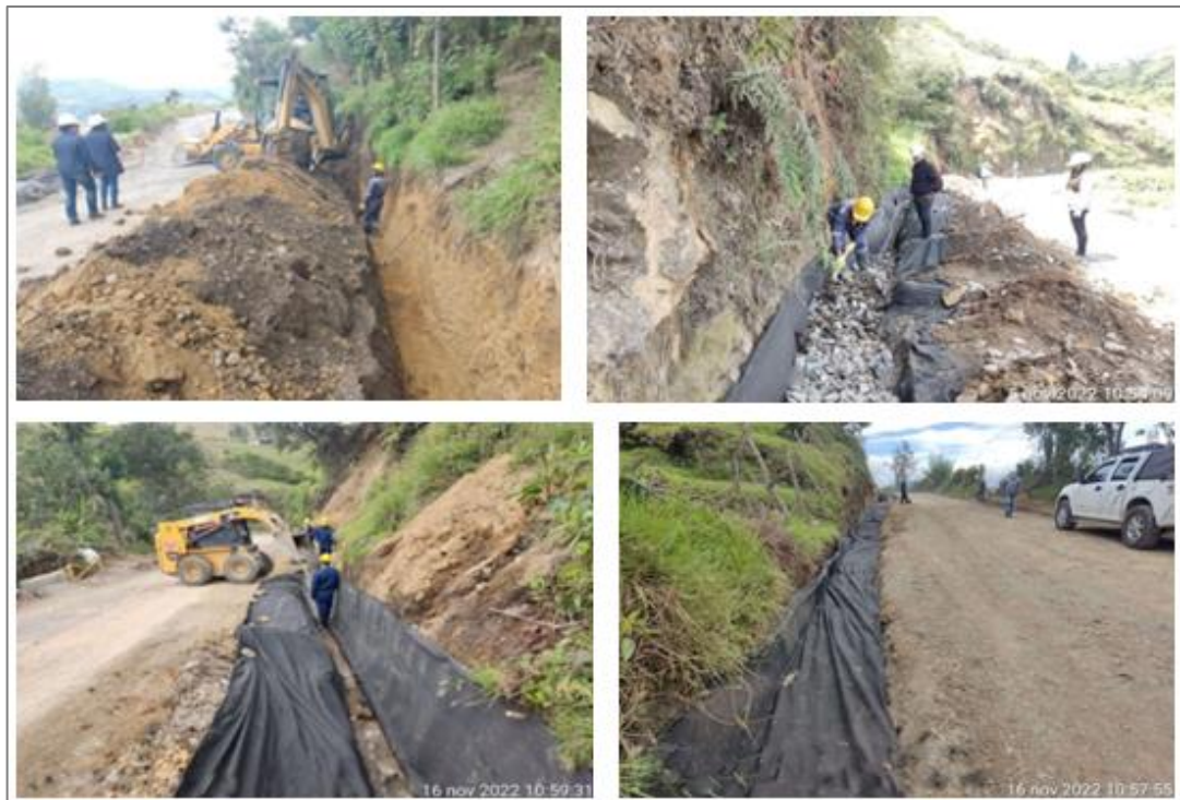
Ilustración 13.23 Construcción de filtro Geo dren
