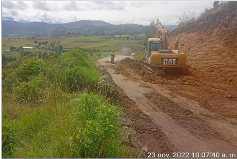
Ilustración 13.18 Corte de talud y explanación, km2+620
