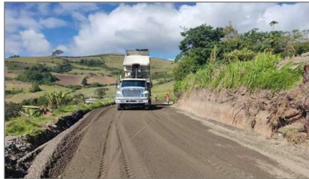
Ilustración 13.49 Descargue de subbase. km3+600.
