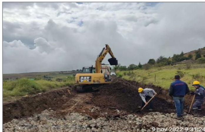
Ilustración 13.17 Desalojo de material producto de excavación, Km3+000
