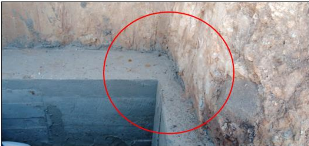
Ilustración 13.15 Alcantarilla con espesores no uniformes
