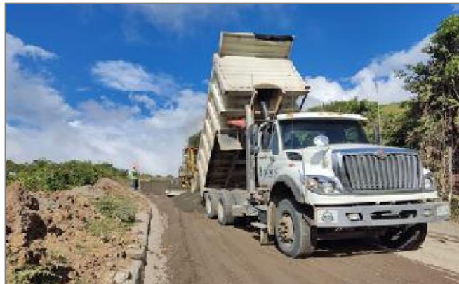
Ilustración 13.53 Descargue de base, km11+230
