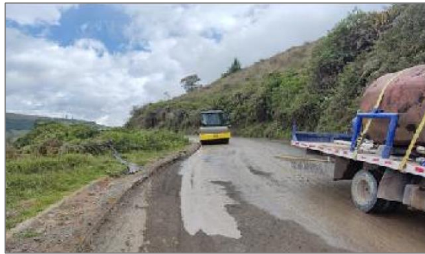
Ilustración 13.55 Compactación y humectación de base, km11+150.
