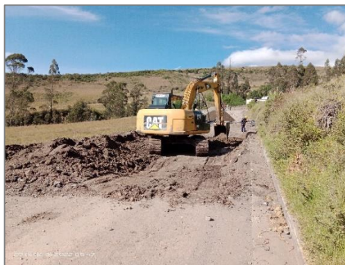
Ilustración 13.47 Demolición de pavimento y cunetas
