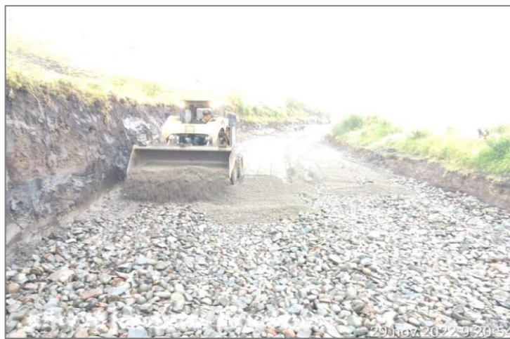
Ilustración 13.21 Colocación de pedraplén y subbase para el mejoramiento de la subrasante.km 2+900
