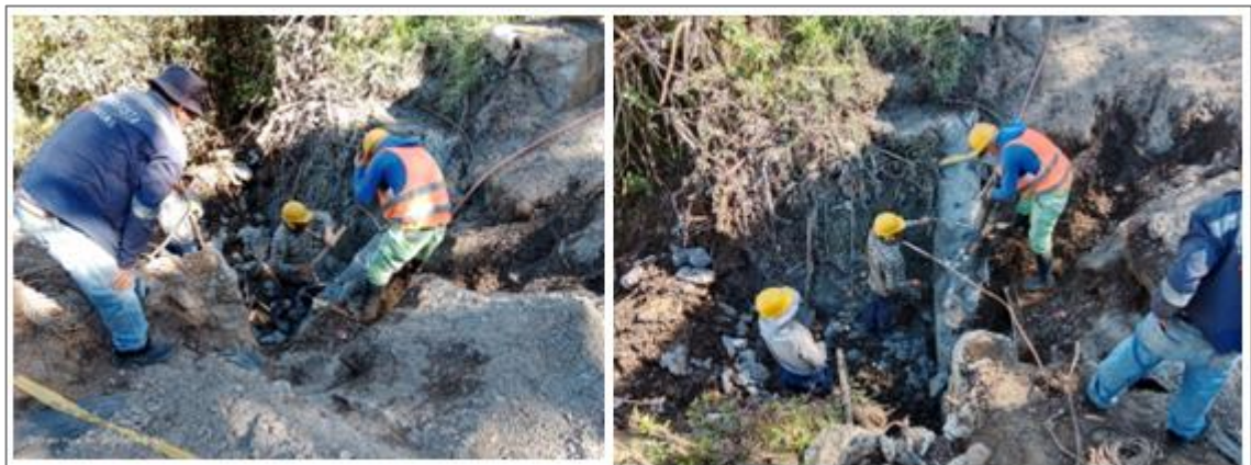
Ilustración 13.56 Demolición de alcantarillas existentes.
