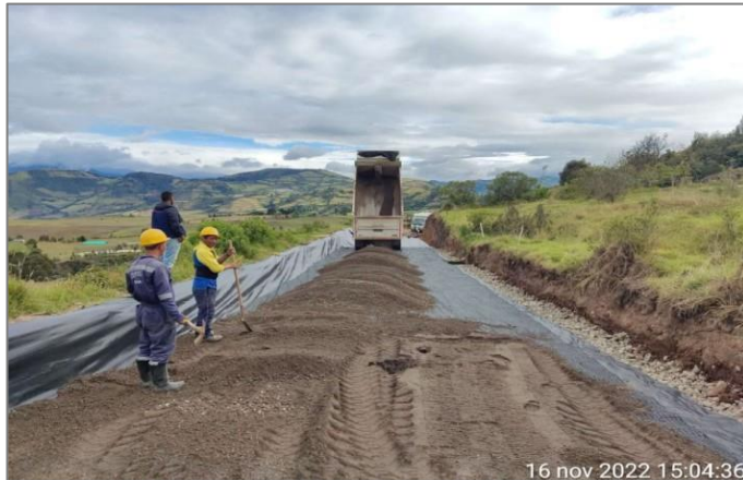
Ilustración 13.20 Descargue de material granular de subbase km2+950.
