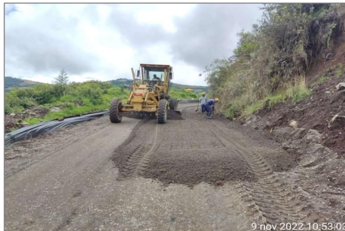
Ilustración 13.25 Expansión de subbase, km11+070
