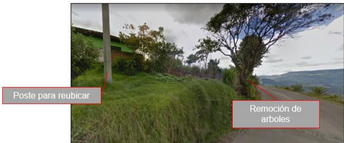
Ilustración 13.12, Ampliación de curva, corte de talud y reubicación de poste de energía.
