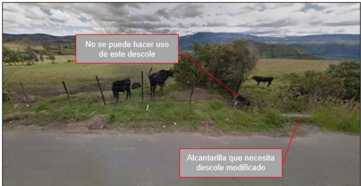
Ilustración 13.64 Actividades no previstas en la alcantarilla en el km4+270
