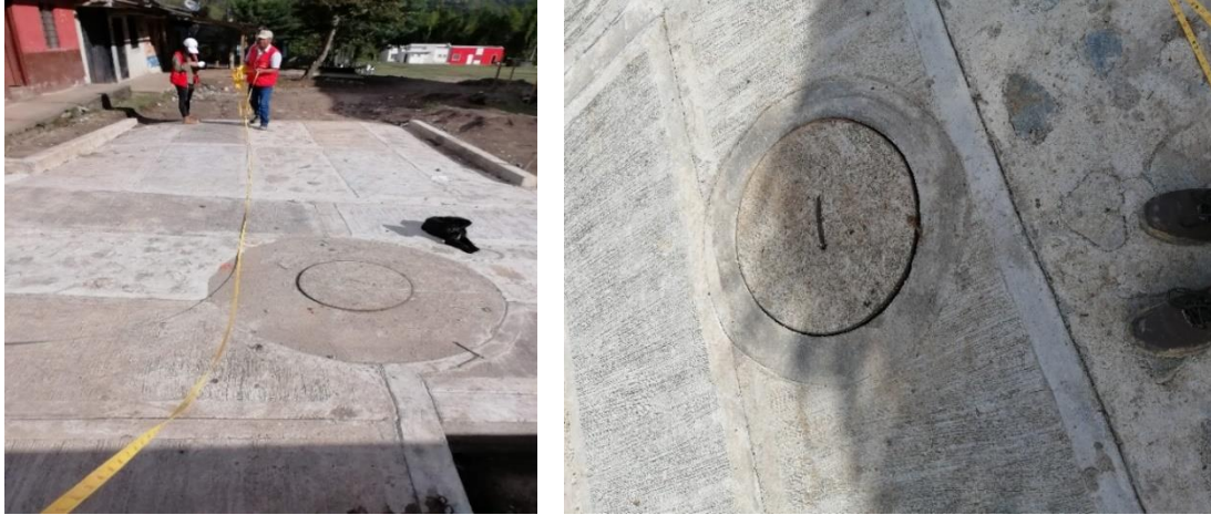
Figura 44: Brocales en Placa huella - Reasentamiento de Guapio, Páez, Cauca.
