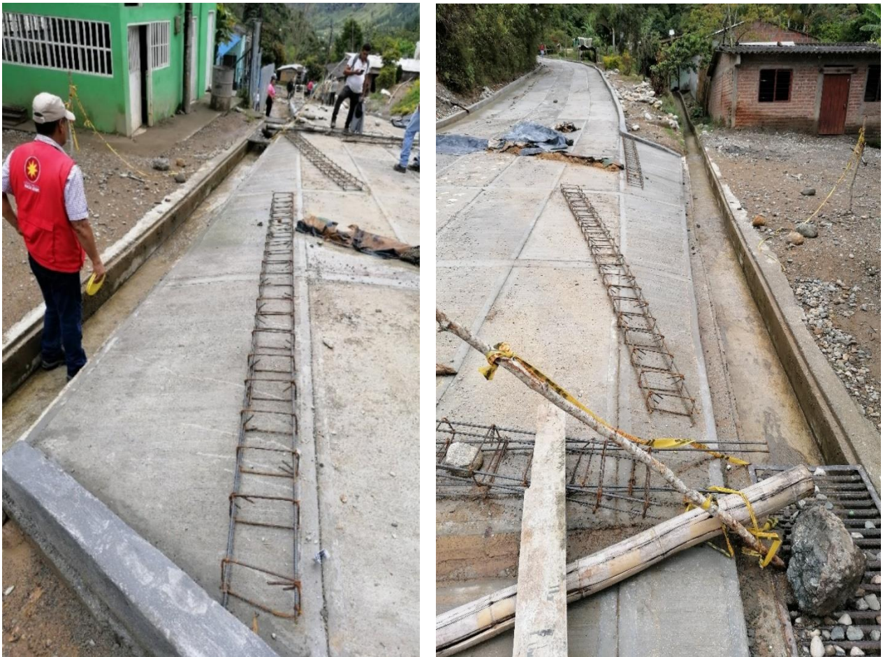
Figura 40: Cuneta rectangular, Drenaje Longitudinal Placa-huella en el eje vial de Caloto Cohetando, Páez, Cauca.
