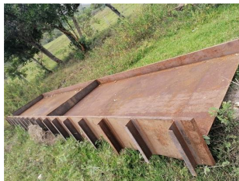
Figura 79: Vigas metálicas del Puente sobre la Quebrada La Macana.
