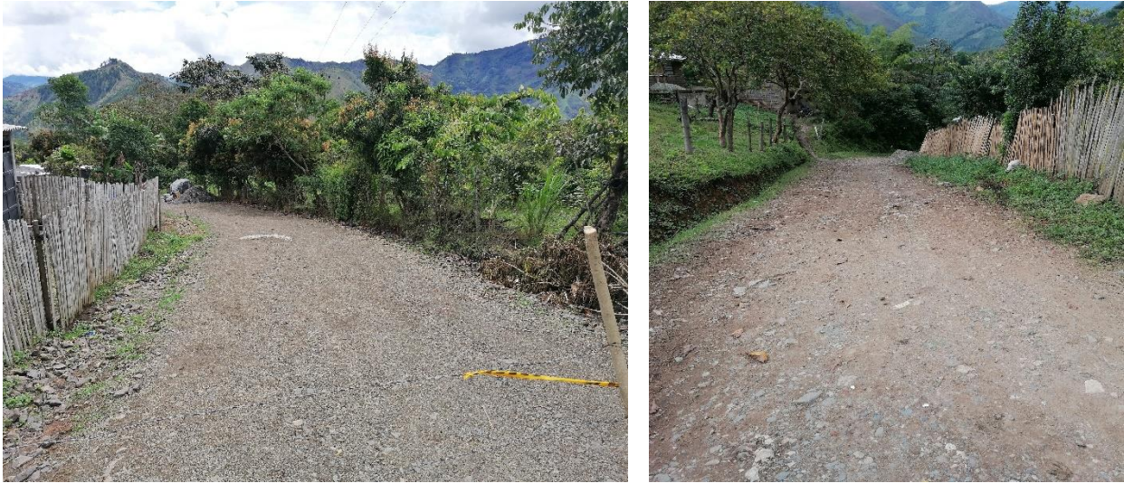
Figura 12: Estado de la Subrasante tramos a intervenir: Izquierda: tramo Las Delicias; Derecha: tramo El Carmen, Páez, Cauca.
