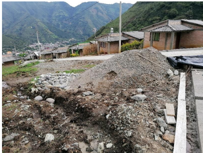
Figura 20: Materiales de construcción empleados para elaboración del concreto en obra. Placa-huella vía de acceso al Reasentamiento de Avirama, Páez-Cauca.
