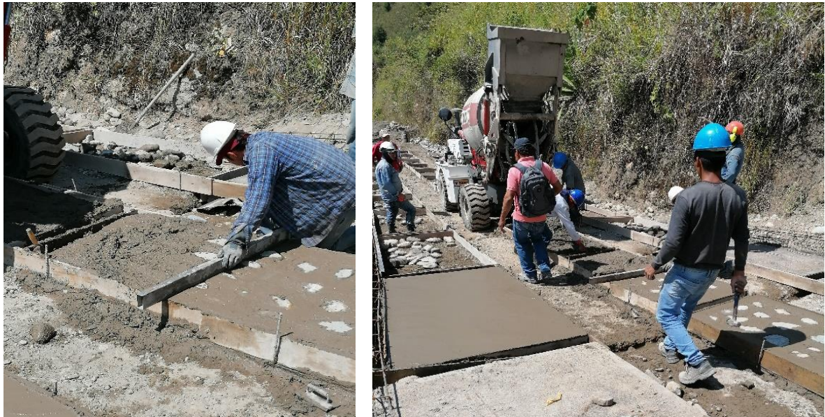
Figura 28: Agregado ciclópeo, Izquierda: Placa-huella Reasentamiento de Las Delicias; Derecha: Placa-huella Mesa de Togoima, Páez, Cauca.
