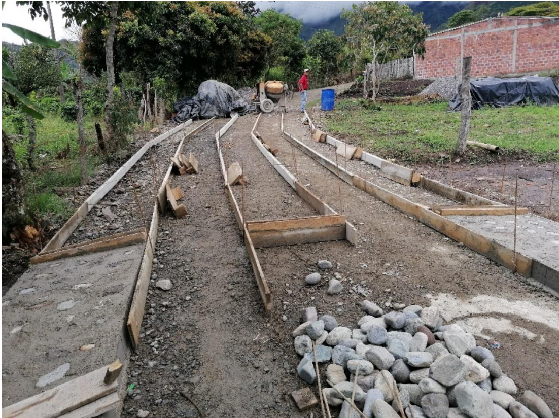
Figura 95: Construcción Placa huella Las Delicias, octubre 2022.
