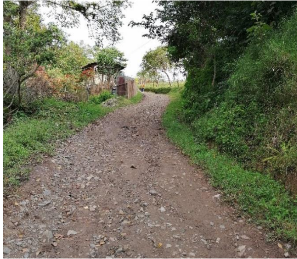
Figura 91: Estado de la subrasante para la construcción de la Placa huella, El Rodeo, noviembre 2022.
