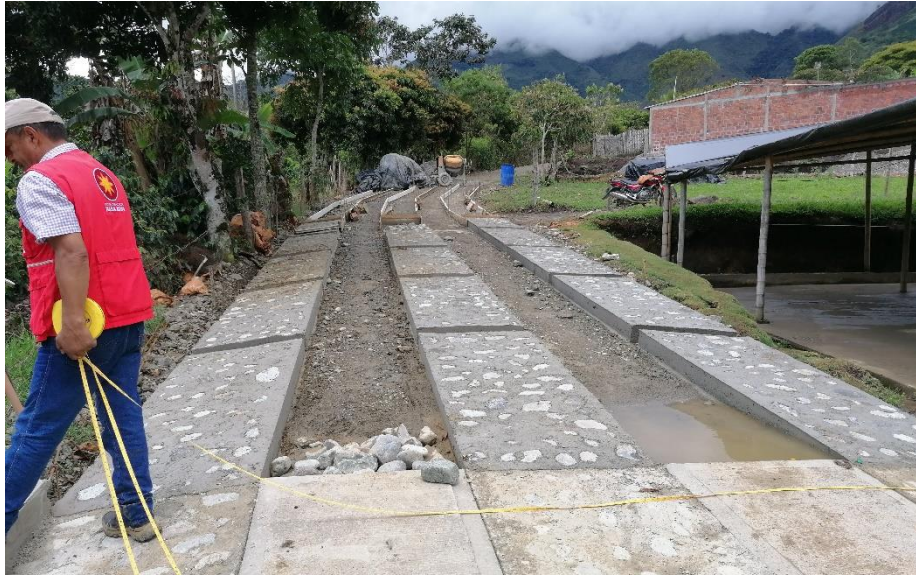
Figura 30: Fundición de las placas en pedraplén 60% concreto 40% agregado ciclópeo. Las Delicias, Páez Cauca.
