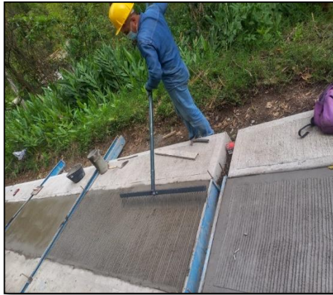
Figura 33: Texturizado de huellas principales para mejorar adherencia de vehículos y mejorar el terminado, placa huella, Reasentamiento de el Carmen.
