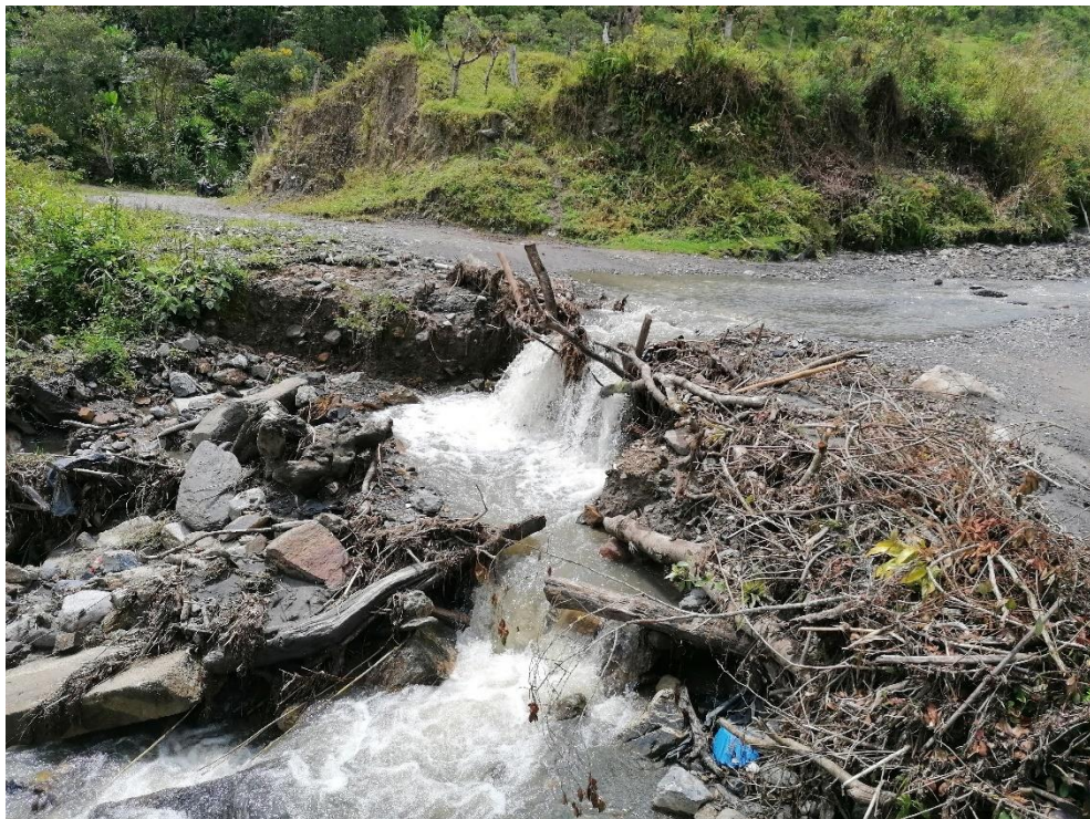
Figura 83: Inspección de la obra a construir Puente Vehicular sobre quebrada Sufiyú.
