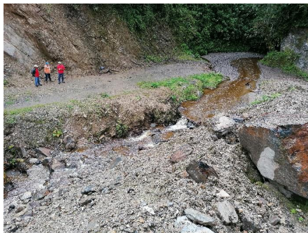
Figura 102: Inspección de la zona de construcción del Puente Cresta de Gallo, noviembre 2022.
