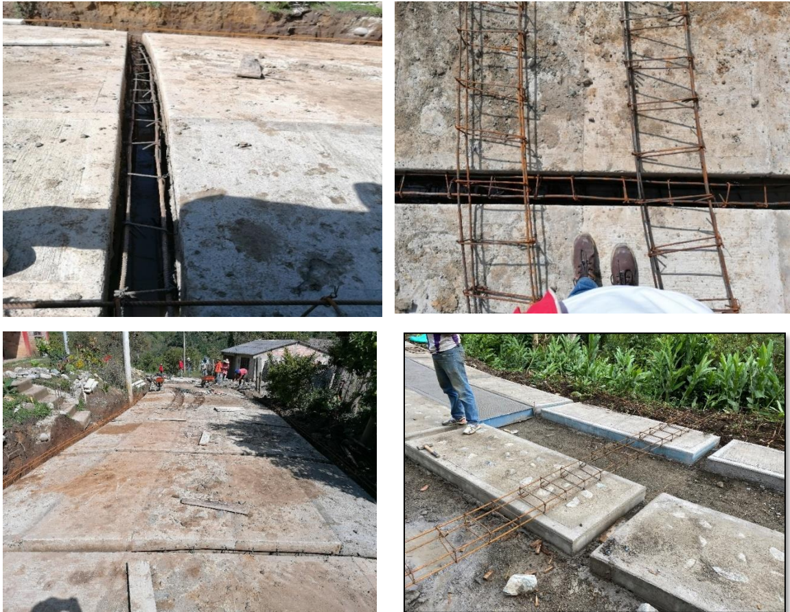
Figura 34: Instalación del acero de las riostras, placa huella Mesa de Belalcázar.
