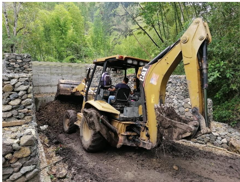
Figura 81: Relleno de material de la zona. Puente Vehicular sobre la Quebrada la Macana.
