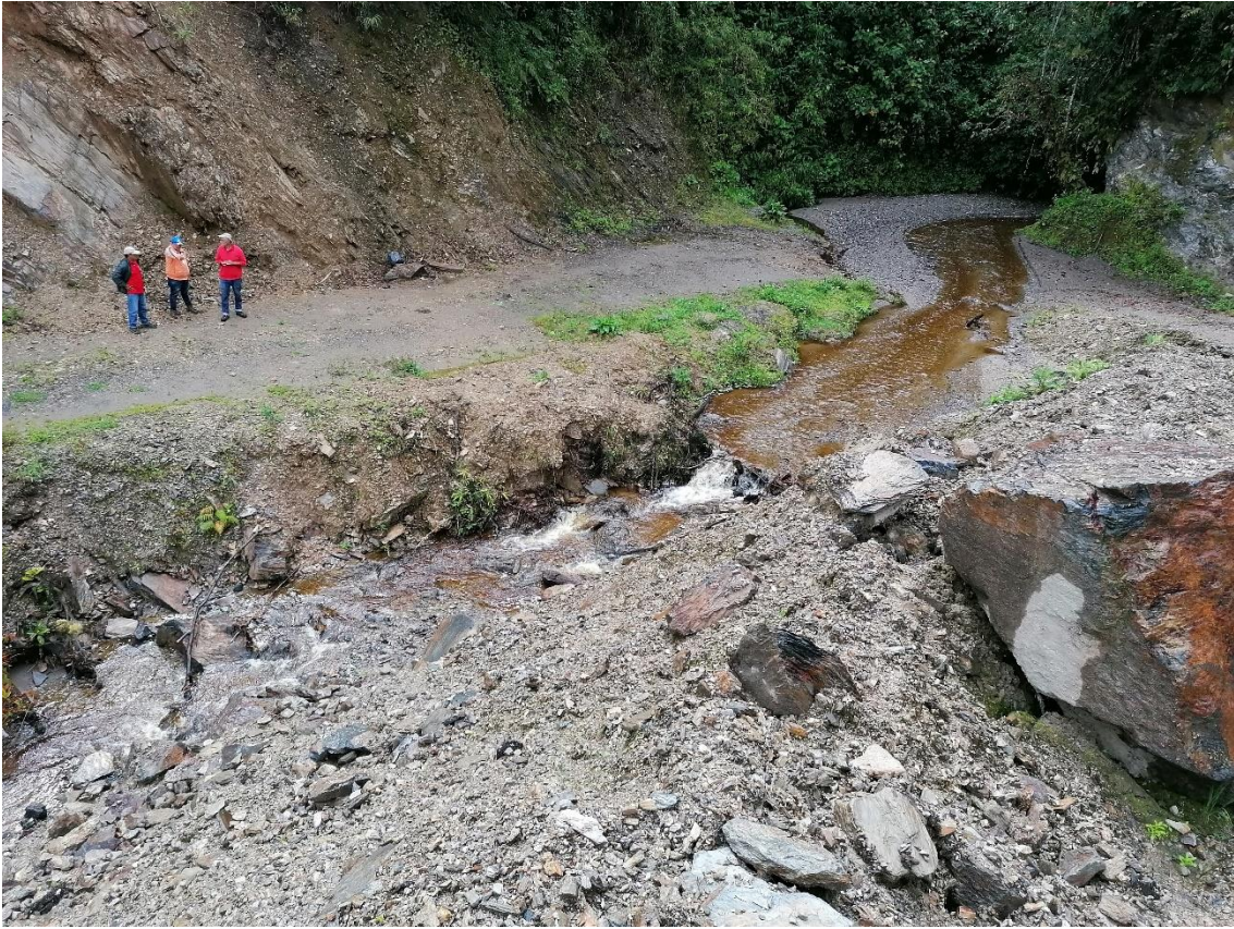
Figura 74: Inspección de la zona que requiere el Puente vehicular sobre quebrada Cresta de Gallo.
