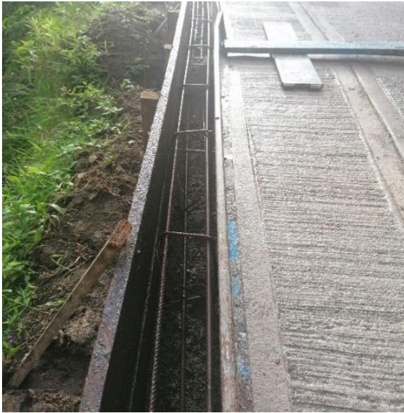
Figura 37: Formaleta Cuneta Bordillo - Placa-huella Reasentamiento El Carmen, Páez Cauca.
