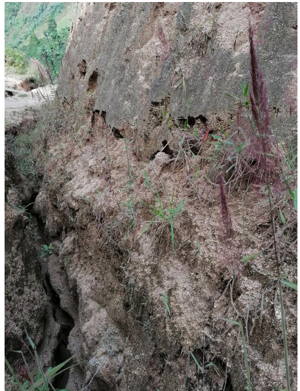
Figura 71: Erosión hídrica - Cárcavas. Eje vial Taravira-Guaquiyó-Avirama.
