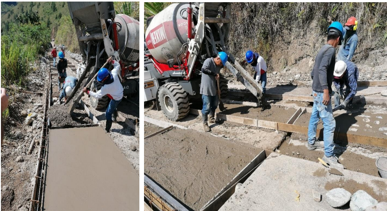
Figura 22: Consistencia del Concreto: Placa-huella Mesa de Togoima, Páez, Cauca.
