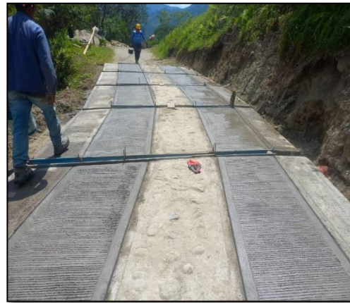
Figura 33: Texturizado de huellas principales para mejorar adherencia de vehículos y mejorar el terminado, placa huella, Reasentamiento de el Carmen.
