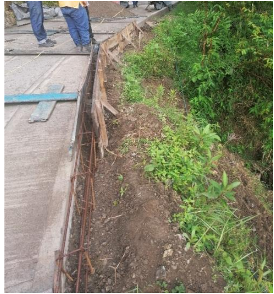
Figura 37: Formaleta Cuneta Bordillo - Placa-huella Reasentamiento El Carmen, Páez Cauca.
