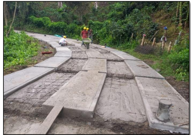
Figura 32: Izquierda: Solado de limpieza y nivelación de concreto de 2000 psi; Derecha: Construcción de huellas principales en concreto 3000 psi con respectivo acero de refuerzo de \frac{1}{4} ". Placa huella, El Carmen.
