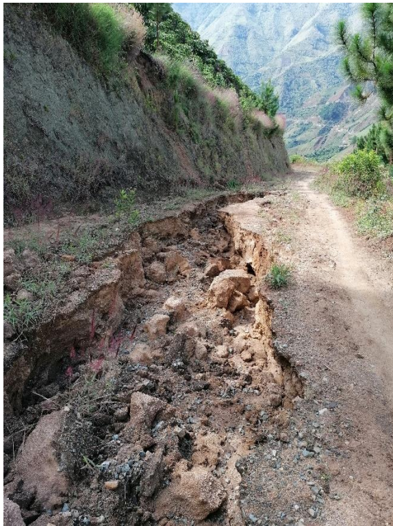
Figura 71: Erosión hídrica - Cárcavas. Eje vial Taravira-Guaquiyó-Avirama.
