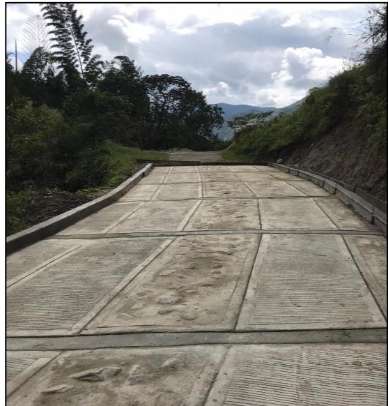
Figura 38: Proceso constructivo de bordillos y vigas riostras, placa huella El Carmen.
