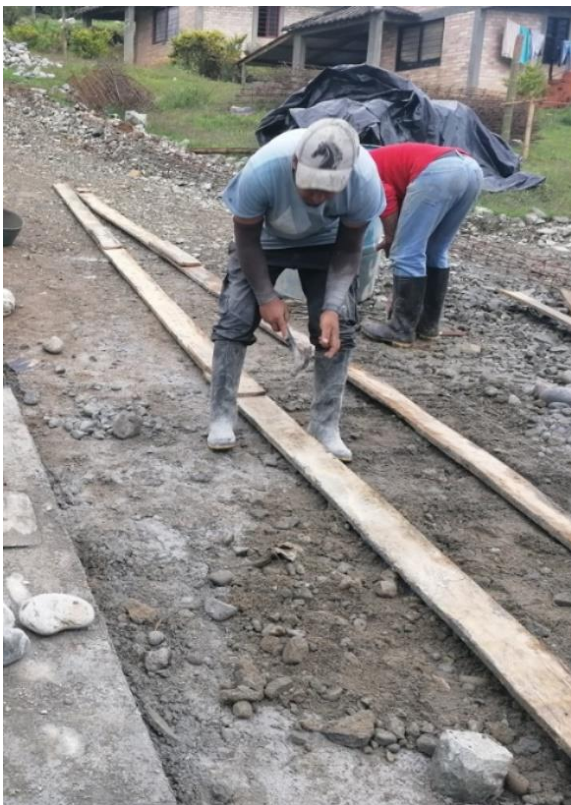
Figura 14: Nivelación del terreno a mano para instalación del solado. Placa Huella vía de acceso al Reasentamiento de Avirama, 2022.
