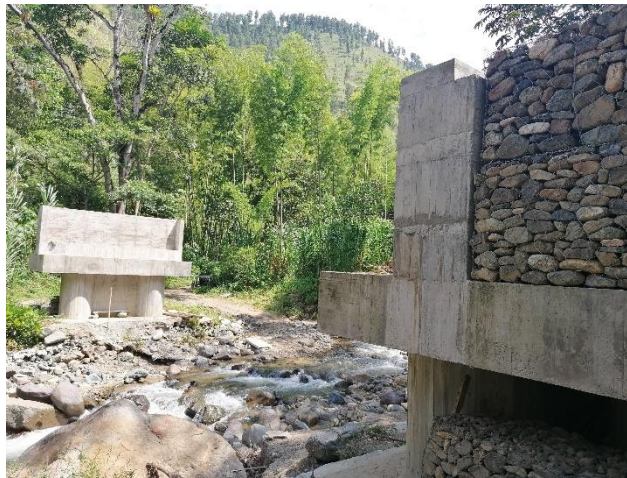
Figura 88: Estribos y muro en gaviones del Puente Vehicular sobre la quebrada la Macana. septiembre 2022
