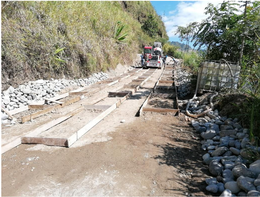
Figura 16: Instalación de Formaleta en madera, Placa-huella Mesa de Togoima, Páez Cauca.
