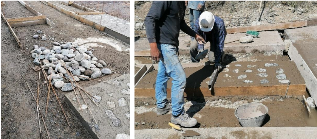
Figura 28: Agregado ciclópeo, Izquierda: Placa-huella Reasentamiento de Las Delicias; Derecha: Placa-huella Mesa de Togoima, Páez, Cauca.
