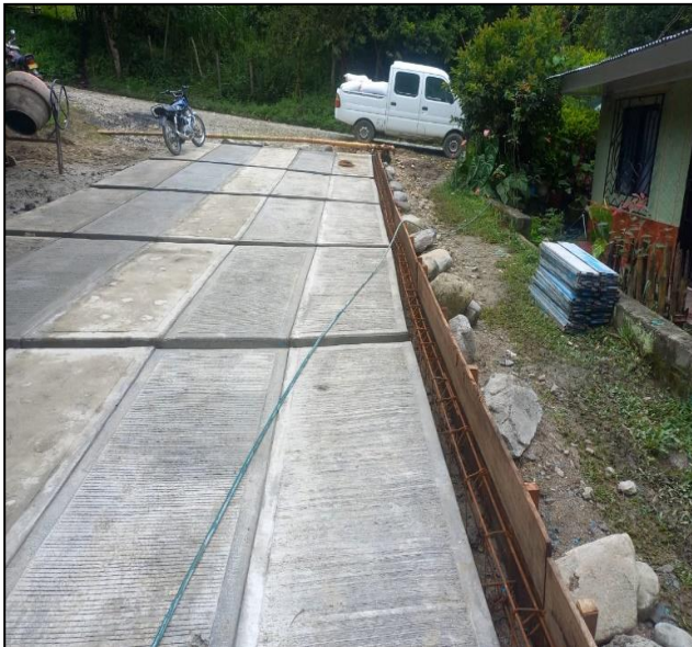
Figura 38: Proceso constructivo de bordillos y vigas riostras, placa huella El Carmen.
