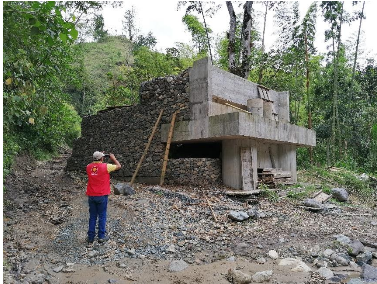
Figura 80: Estribo y Muro en Gaviones. Puente Vehicular sobre la Quebrada la Macana.
