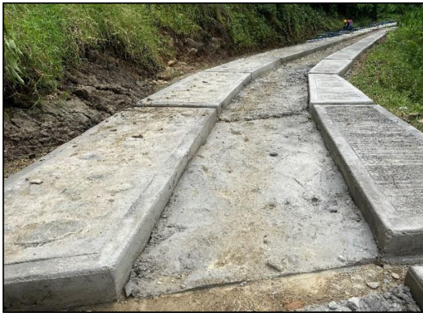
Figura 32: Izquierda: Solado de limpieza y nivelación de concreto de 2000 psi; Derecha: Construcción de huellas principales en concreto 3000 psi con respectivo acero de refuerzo de \frac{1}{4} ". Placa huella, El Carmen.
