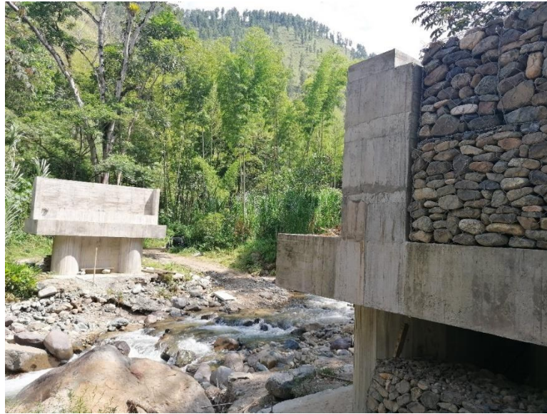
Figura 78: Estribos del Puente Vehicular sobre la Quebrada la Macana.
