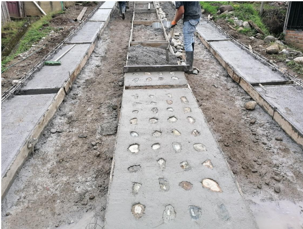
Figura 97: Construcción Placa huella Minuto de Dios, octubre 2022
