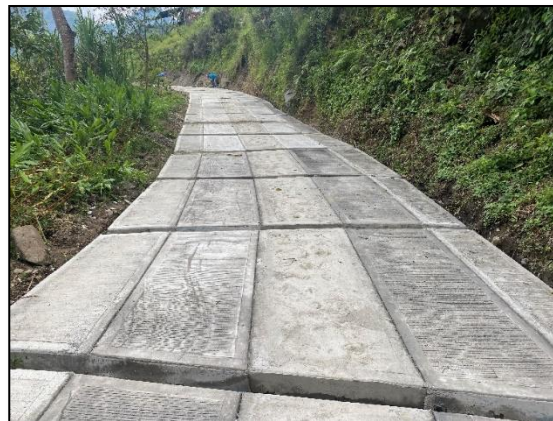
Figura 35: Placas en concreto ciclópeo y concreto reforzado terminadas y dilatadas entre ellas El Carmen.
