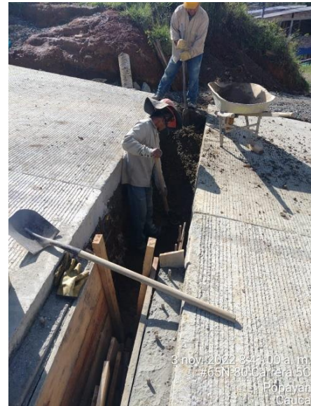
Ilustración 53. Construcción de Cárcamos. Tomada in situ.
