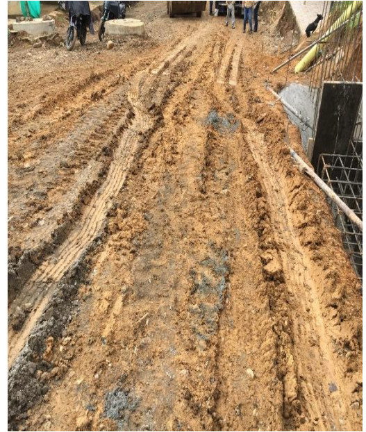
Ilustración 22. Material de Subrasante Sobresaturado. Tomada in situ.
