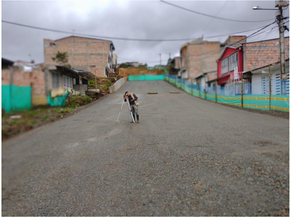
Ilustración 73. Verificación de Cotas de Diseño a Material de Subbase.
