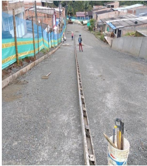
Ilustración 30. Formaleta Fija en Acero. Tomada in situ.
