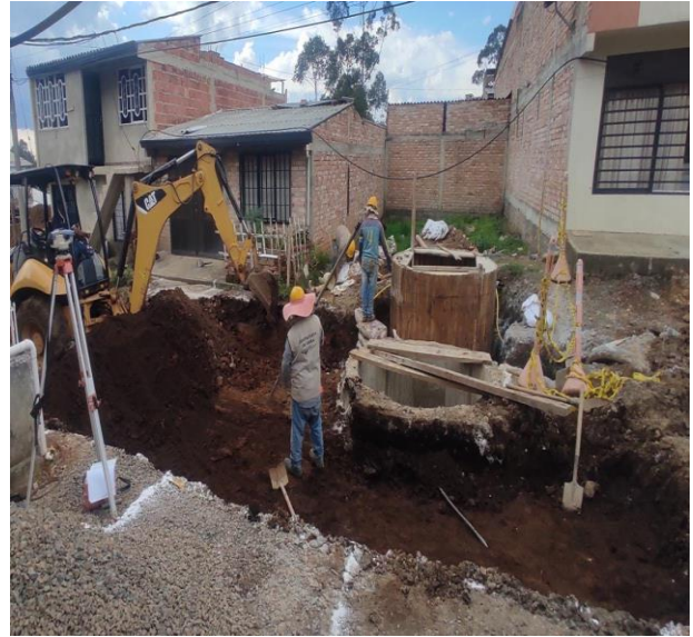
Ilustración 51. Proceso Constructivo Recamaras 2.10m Tramo 2. Tomada in situ.
