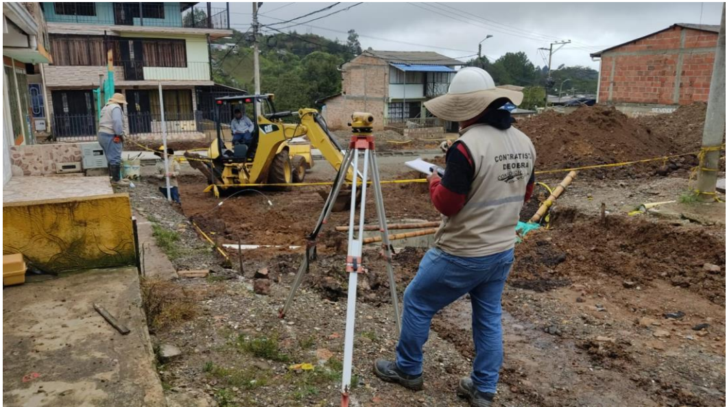
Ilustración 72. Chequeos topográficos.
