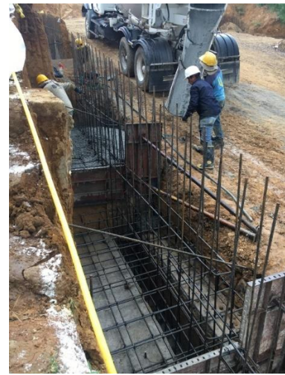
Ilustración 58. Fundición de Zapatas de Módulos. Tomada in situ.
