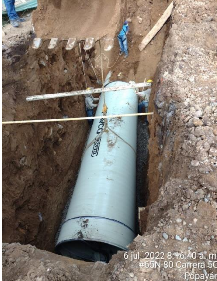
Ilustración 45. Instalación de Tubería para Red de Alcantarillado. Tomada in situ.
