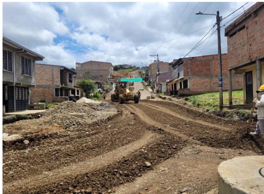
Ilustración 23. Extensión de material de mejoramiento. Tomada in situ.
