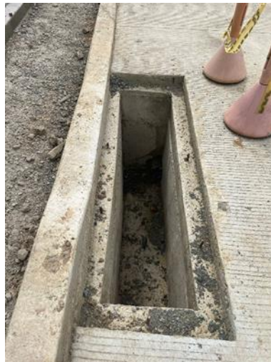
Ilustración 52. Sumideros Construidos. Tomada in situ.
