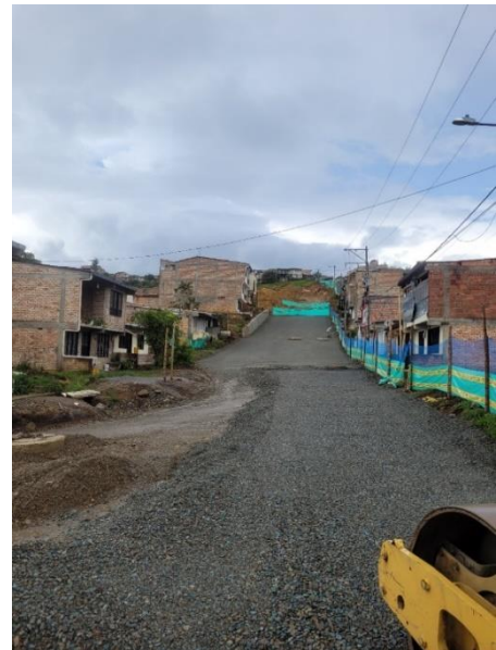
Ilustración 27. Compactación de Material de Subbase. Tomada in situ.
