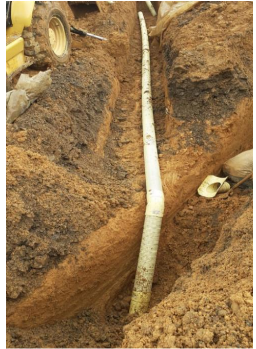
Ilustración 18. Excavaciones para Tubería Sanitaria. Tomada in situ.
