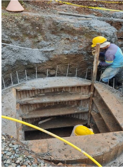
Ilustración 50. Formaleta de Madera. Tomada in situ.
