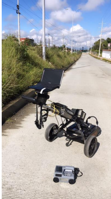
Ilustración 76. Verificación de espesores de losas en Calle 53 N.
