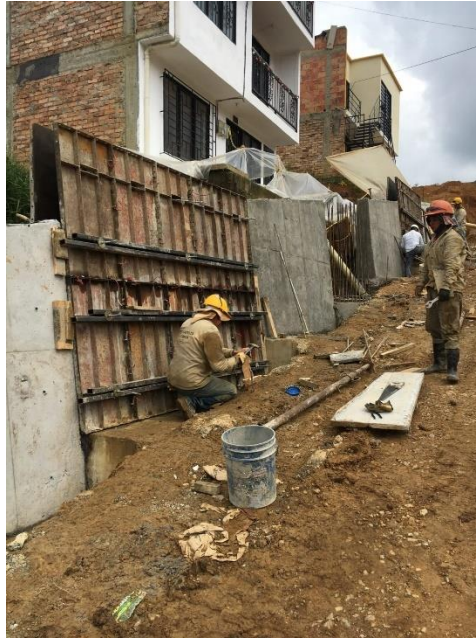
Ilustración 60. Fundición Alternada de Vástagos en Módulos. Tomada in situ.
