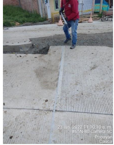
Ilustración 41. Aplicación de Sello de Juntas. Tomada in situ.
