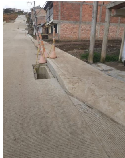
Ilustración 63. Andenes Fundidos Tramo 1. Tomada in situ.
