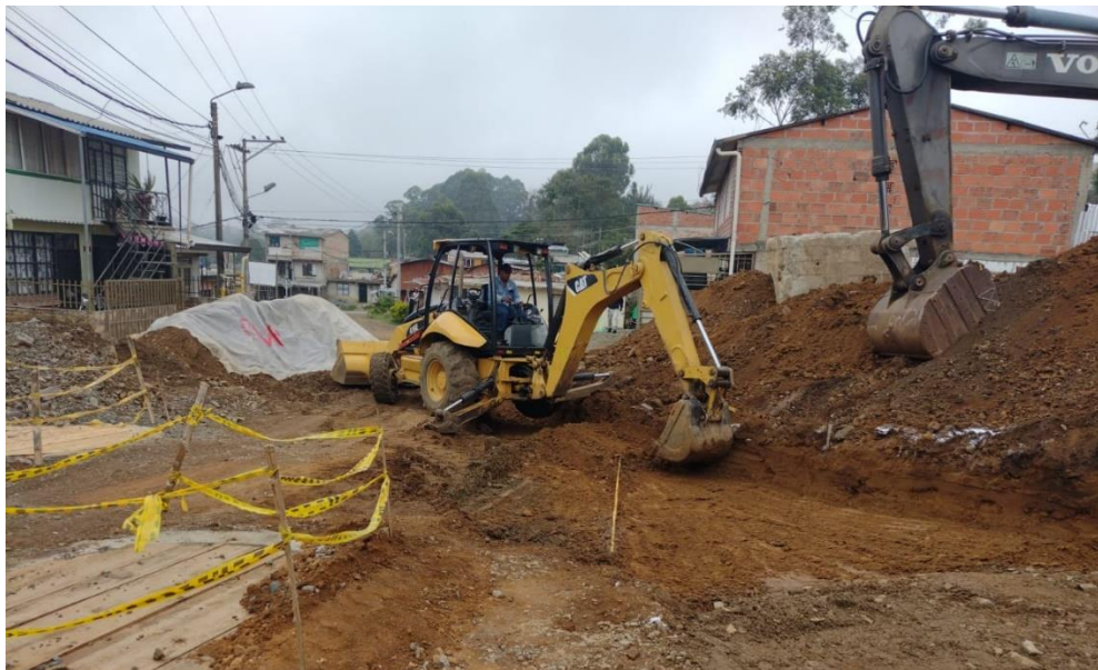
Ilustración 15. Actividades de Cajeo Tramo 2. Tomada in situ.
