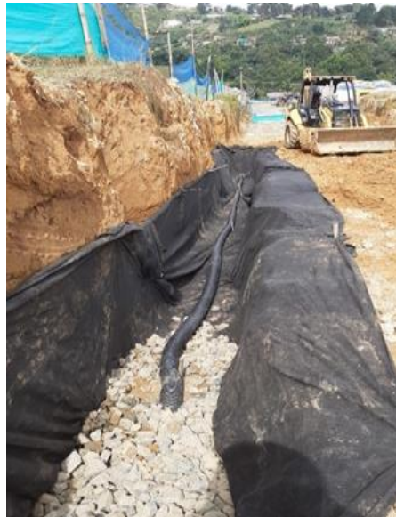
Ilustración 54. Construcción Filtros Longitudinales. Tomada in situ.
