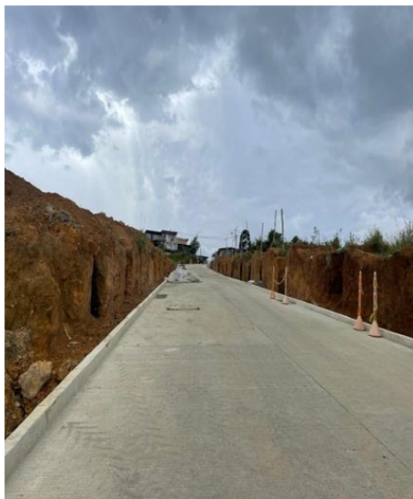
Ilustración 64. Bordillos Construidos Tramo 1. Tomada in situ.
