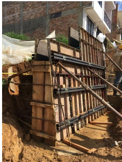
Ilustración 59. Formaleteo de Módulos. Tomada in situ.
