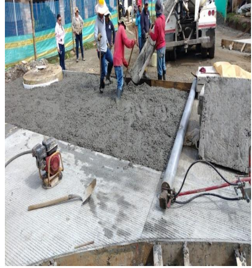
Ilustración 31. Extendido de Concreto. Tomada in situ.
