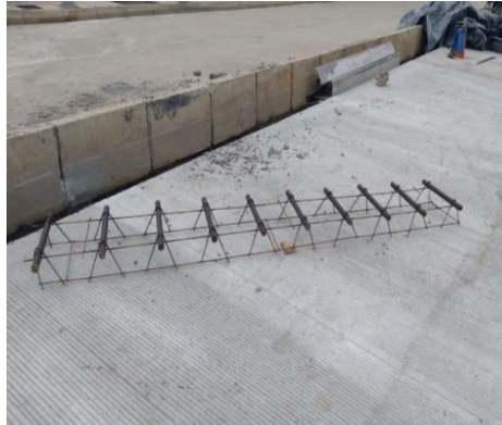
Ilustración 35. Pasajuntas Dispuestos en Canastillas. Tomada in situ.
