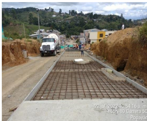
Ilustración 36. Parillas de Refuerzo en Tramo 1. Tomada in situ.
