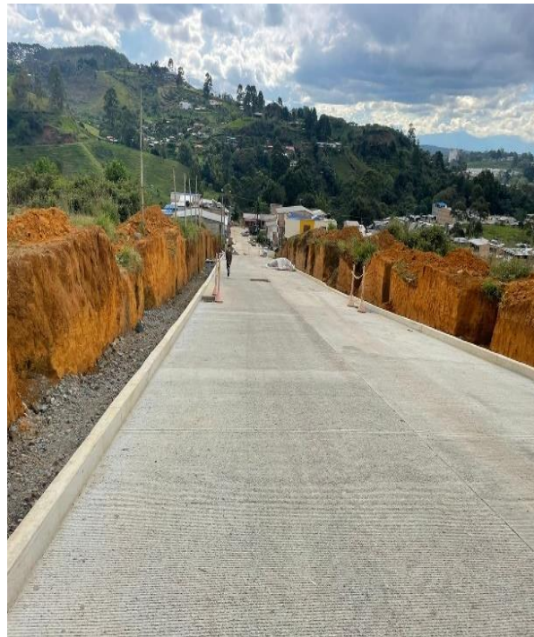
Ilustración 43. Losa de Concreto Terminada. Tomada in situ.
