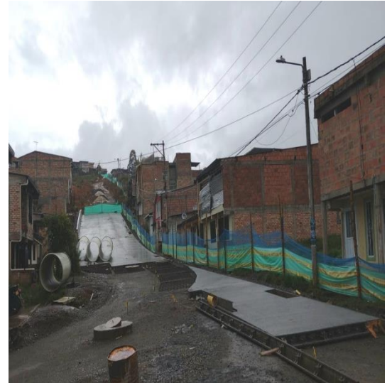
Ilustración 39. Proceso de Fraguado de Concreto. Tomada in situ.
