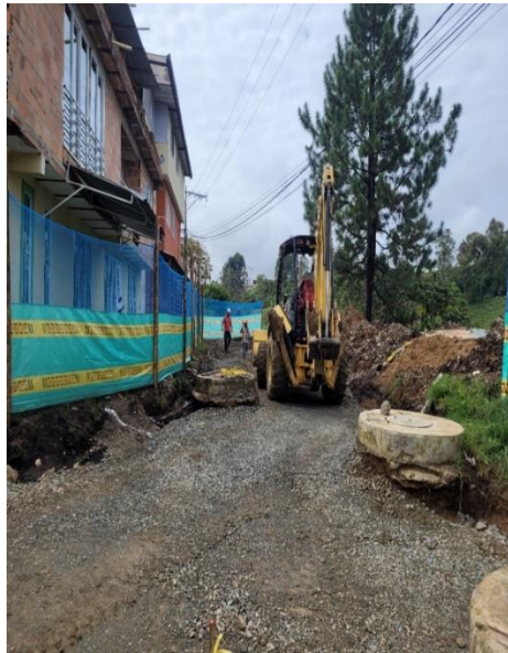
Ilustración 26. Extensión de Material de Subbase. Tomada in situ.
