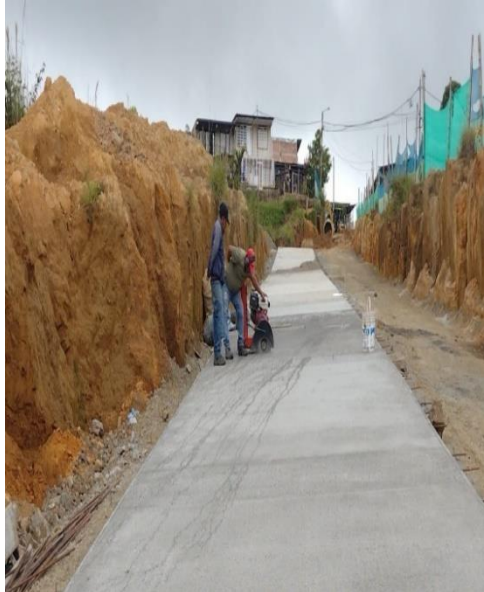
Ilustración 42. Corte de Juntas. Tomada in situ.
