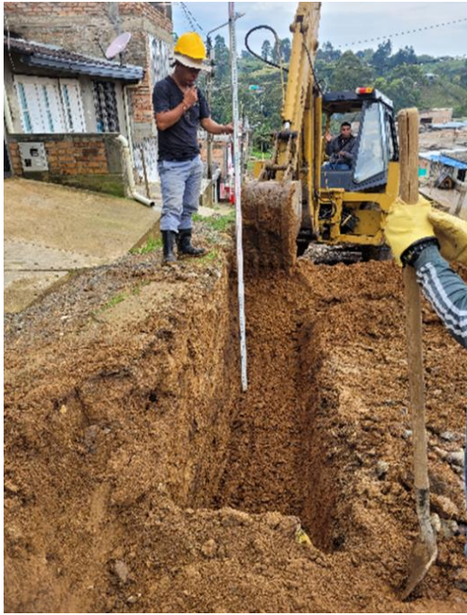
Ilustración 17. Excavaciones para Filtro Lateral. Tomada in situ.
