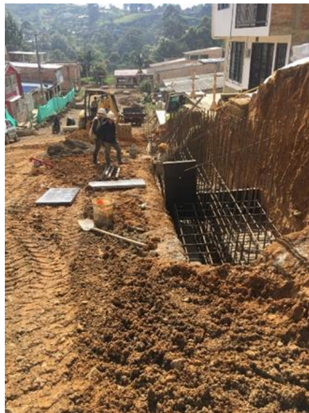
Ilustración 61. Subrasante Saturada. Tomada in situ.
