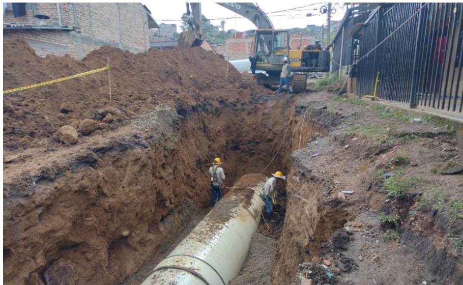
Ilustración 19. Excavaciones para Tubería Pluvial. Tomada in situ.
