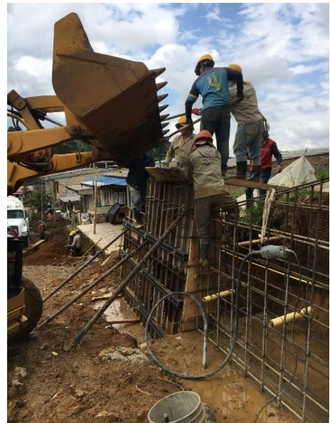
Ilustración 62. Alternativa de Vaceado de Concreto. Tomada in situ.
