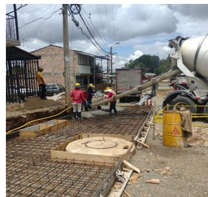
Ilustración 37. Parillas de Refuerzo en Tramo 3. Tomada in situ.
