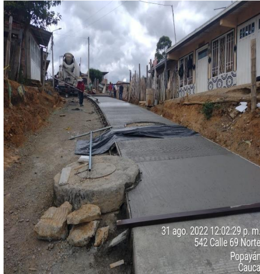
Ilustración 40. Texturizado de Concreto. Tomada in situ.
