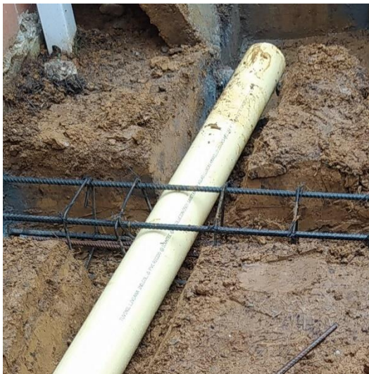
Figura 81. Tubería embebida. Obra No.17
