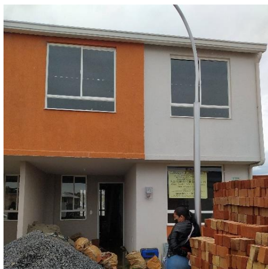
Figura 65. Vista frontal. Obra No. 18
