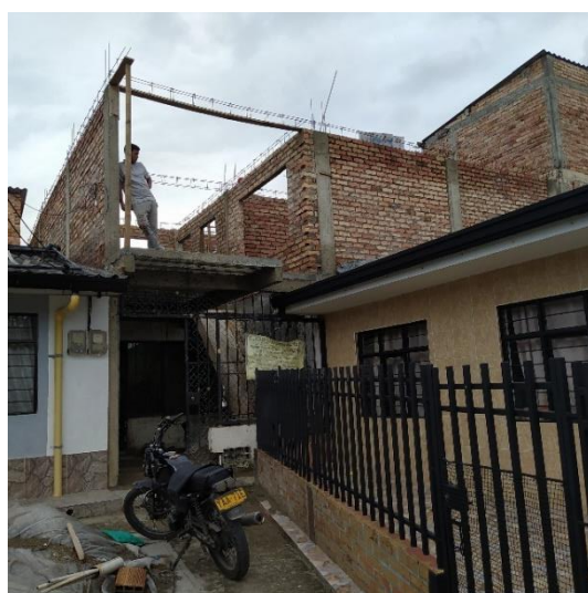
Figura 28. Vista frontal. Obra No. 8
