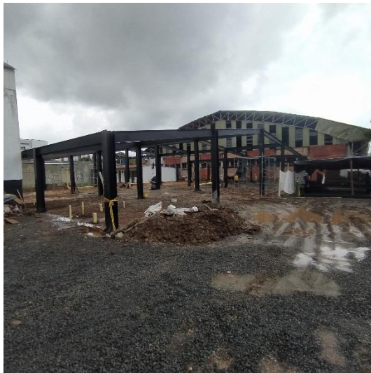
Figura 53. Vista frontal. Obra No. 14
