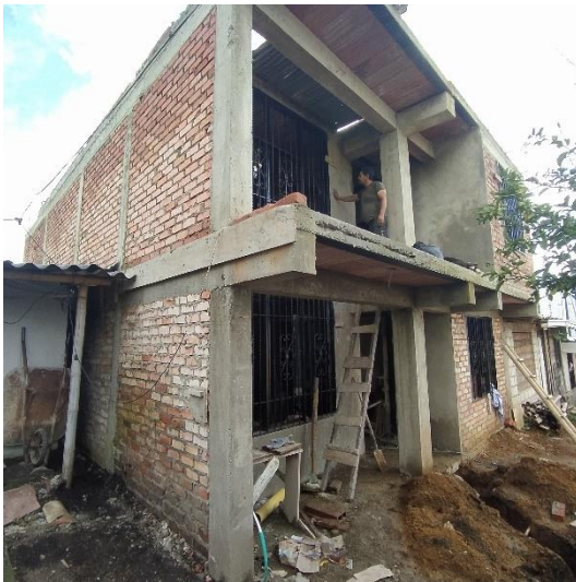
Figura 36. Vista frontal. Obra No.10
