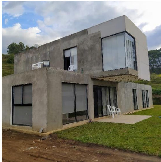
Figura 1. Vista frontal. Obra No. 1
