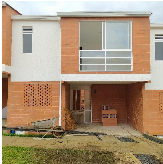
Figura 61. Vista frontal. Obra No.17
