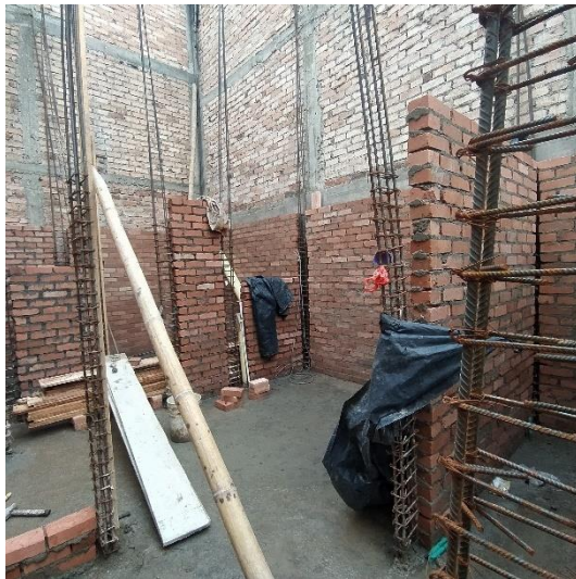
Figura 26. Vista al interior de la construcción. Obra No. 7
