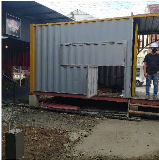
Figura 19. Vista frontal. Obra No. 5
