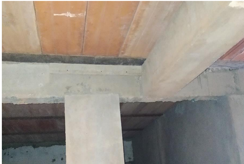
Figura 43. Detalle reforzamiento estructural en primer piso. Obra No.11
