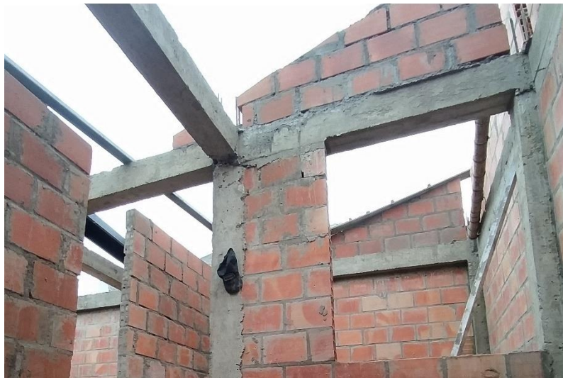
Figura 52. Detalle estructura en segundo piso. Obra No.13
