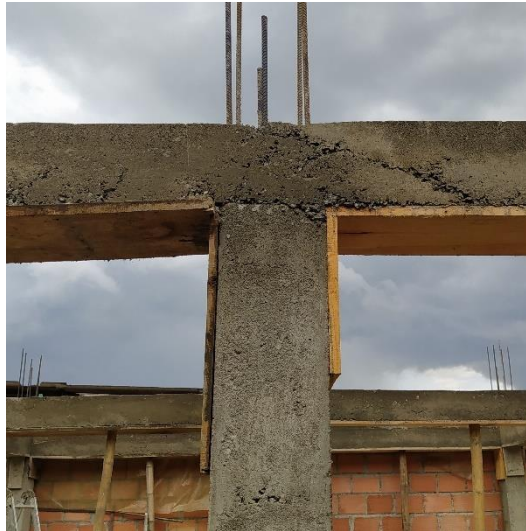
Figura 73. Detalle de junta en concreto de viga. Obra No.4
