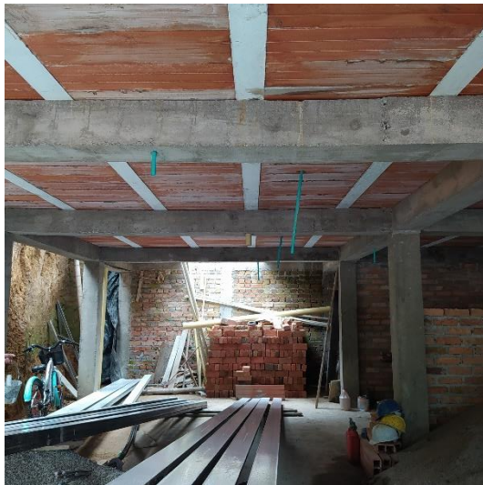
Figura 14. Vista interior de la construcción. Obra No. 4
