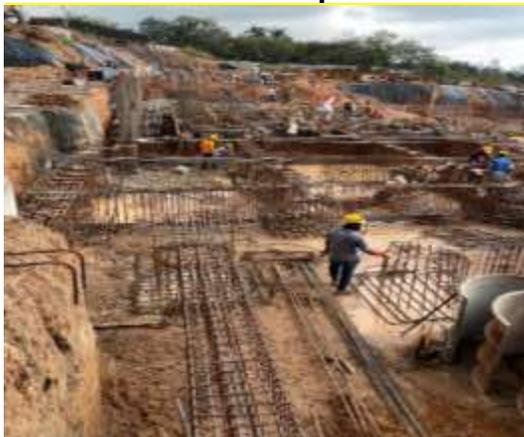
**Figura 14. Instalación de formaletas de cimentación**
