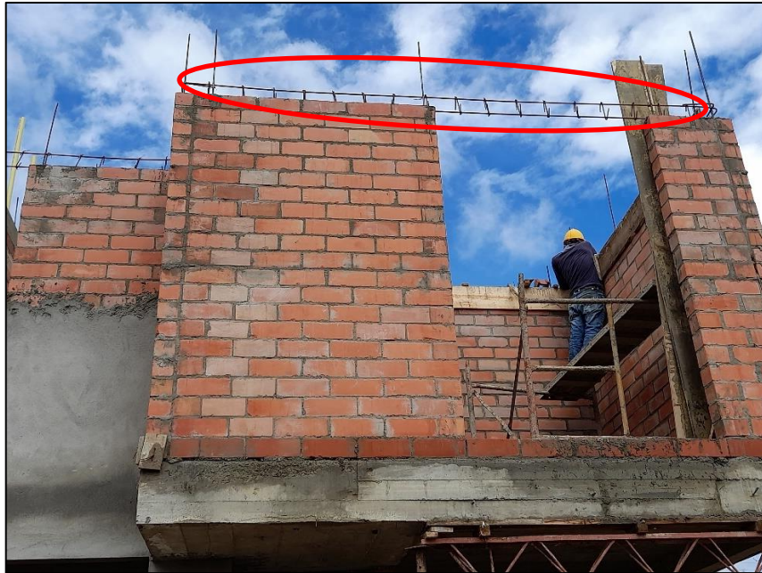
Figura 28. Castillo viga de amarre. Fuente: Propia
