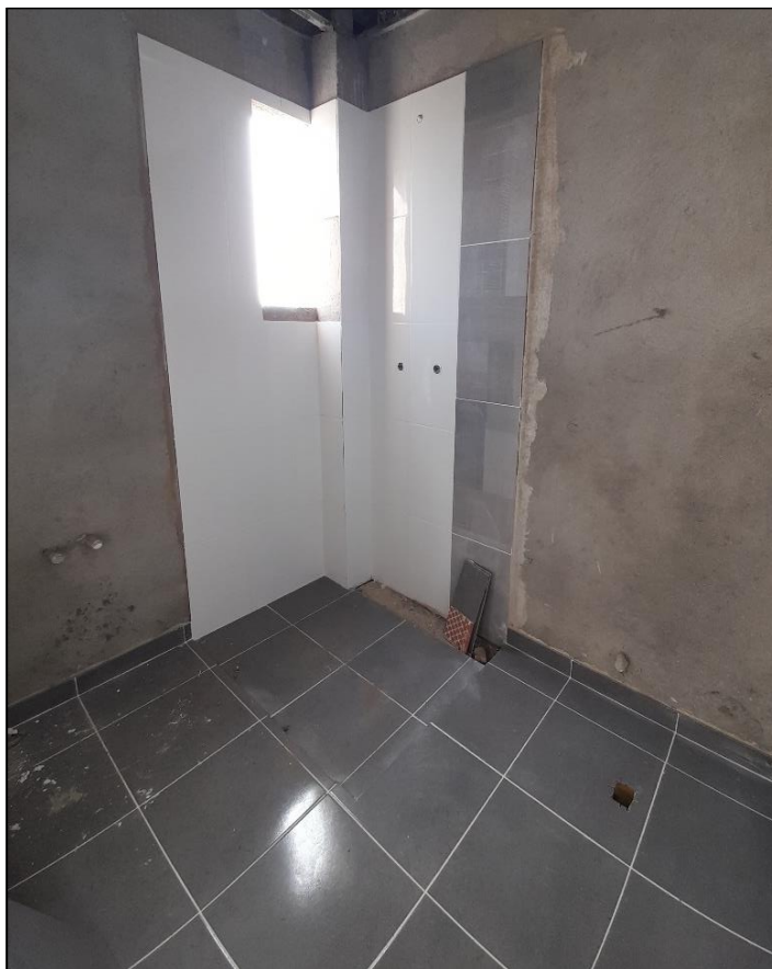
Figura 45. Cerámica baño privado. Fuente: propia
