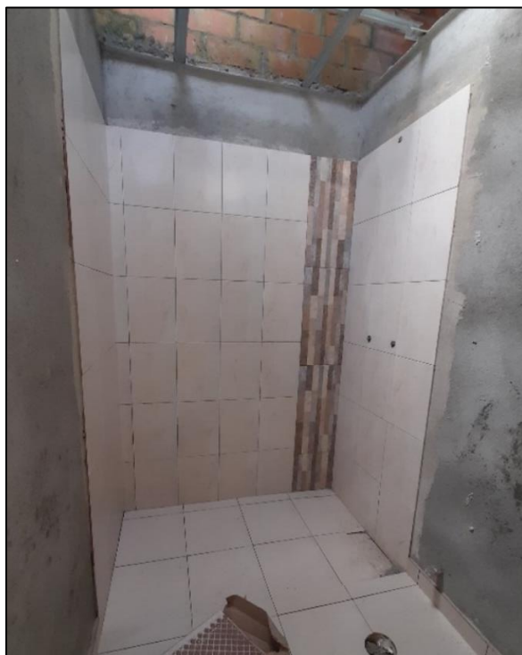
Figura 44. Cerámica baño social segundo piso. Fuente: Propia
