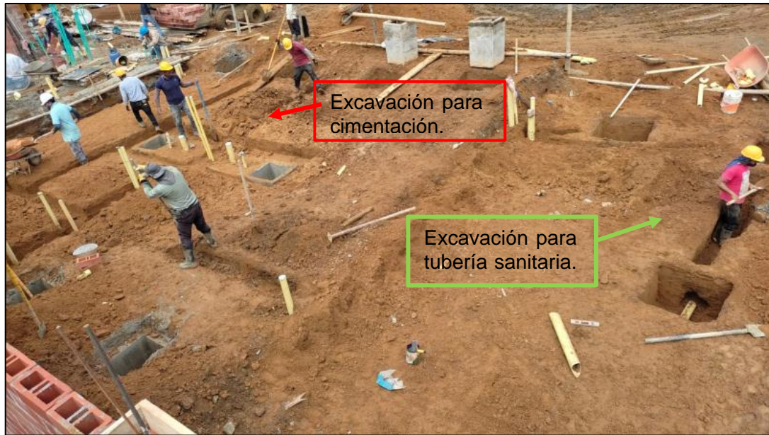
Figura 10. Excavación e instalación de tubería sanitaria. Fuente: propia.
