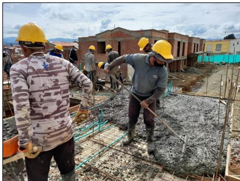
Figura 25. Fundición losa de entre piso. Fuente: Propia
