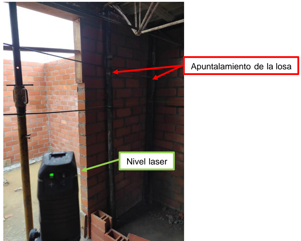
Figura 21. Nivelación losa de entrepiso. Fuente: Propia.
