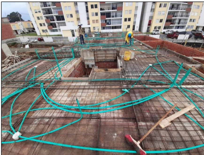
Figura 23. Cuadrilla eléctricos en losa de entrepiso. Fuente: Propia
