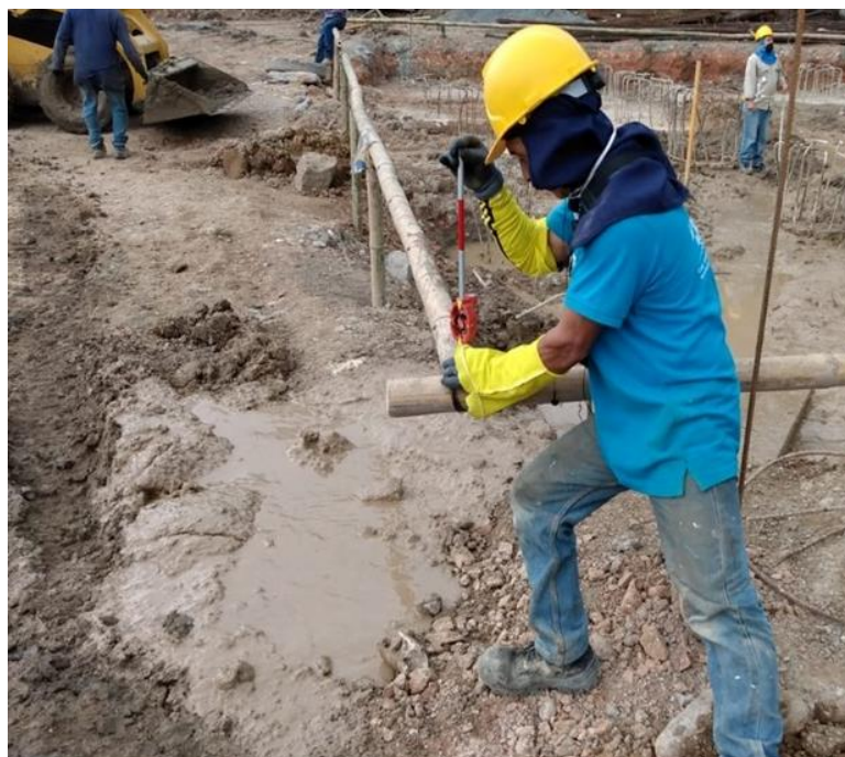
Figura 8. Localización de ejes. Fuente: Propia.
