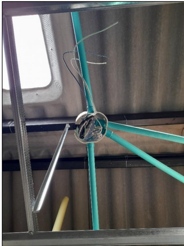
Figura 37. Alambrado de ductos. Fuente: Propia.
