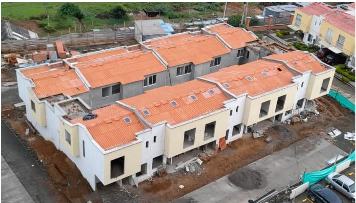
Figura 31. Cubierta casas Llanos de Calibío. Fuente: Propia.
