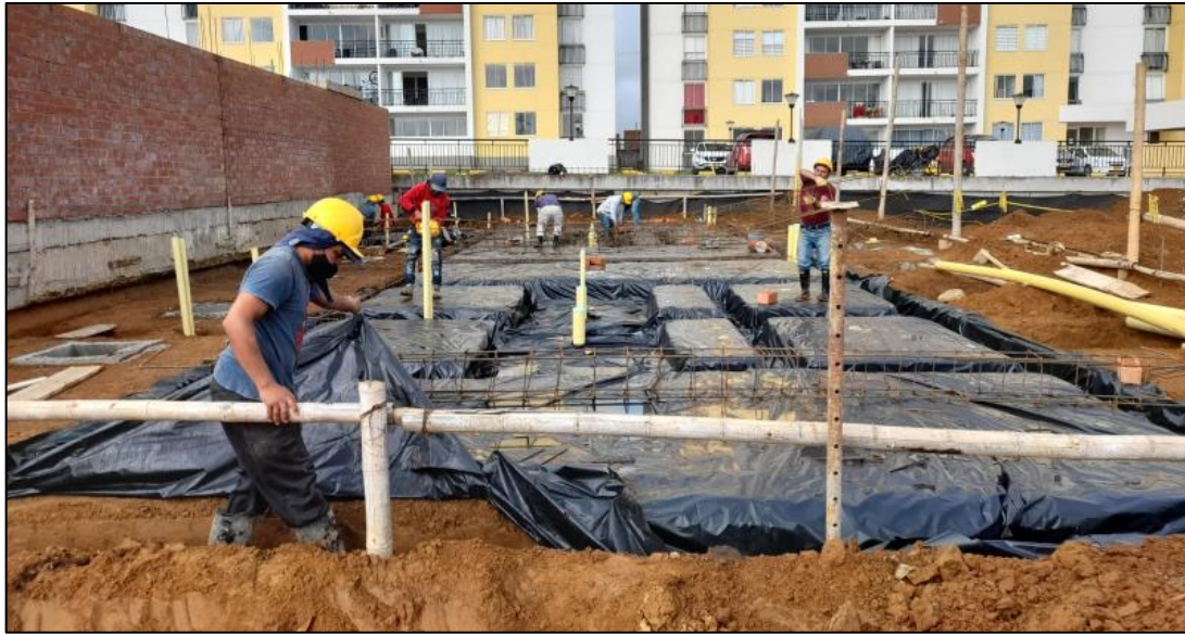
Figura 12. Colocación de castillos de vigas de cimentación. Fuente: Propia
