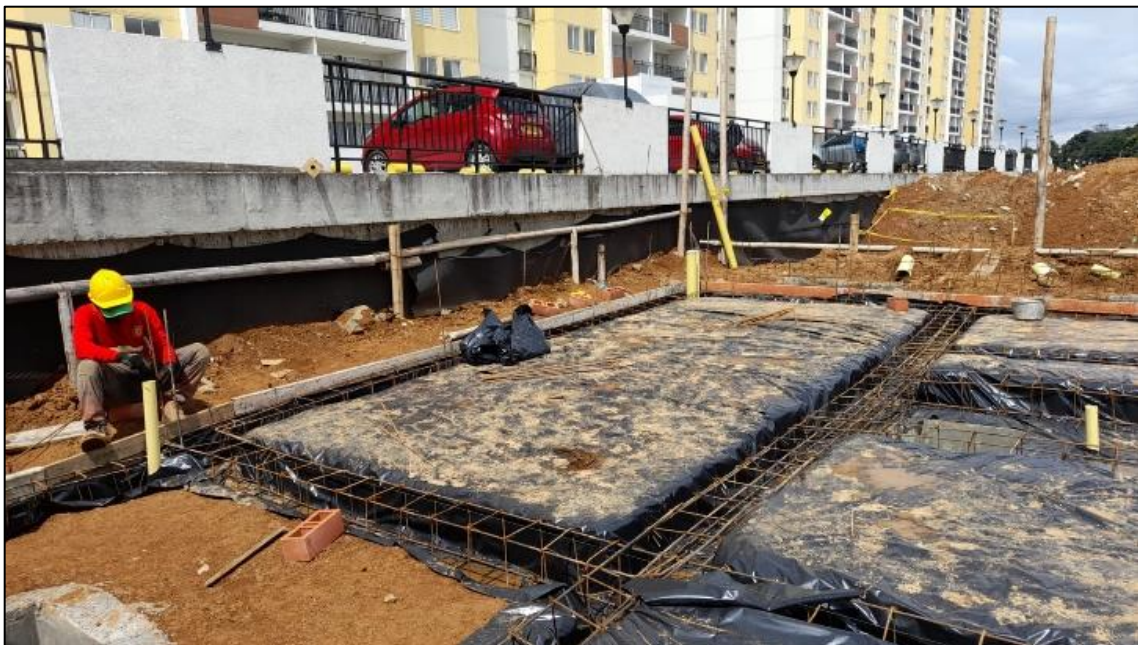
Figura 13. Arranques para dovelas. Fuente: Propia
