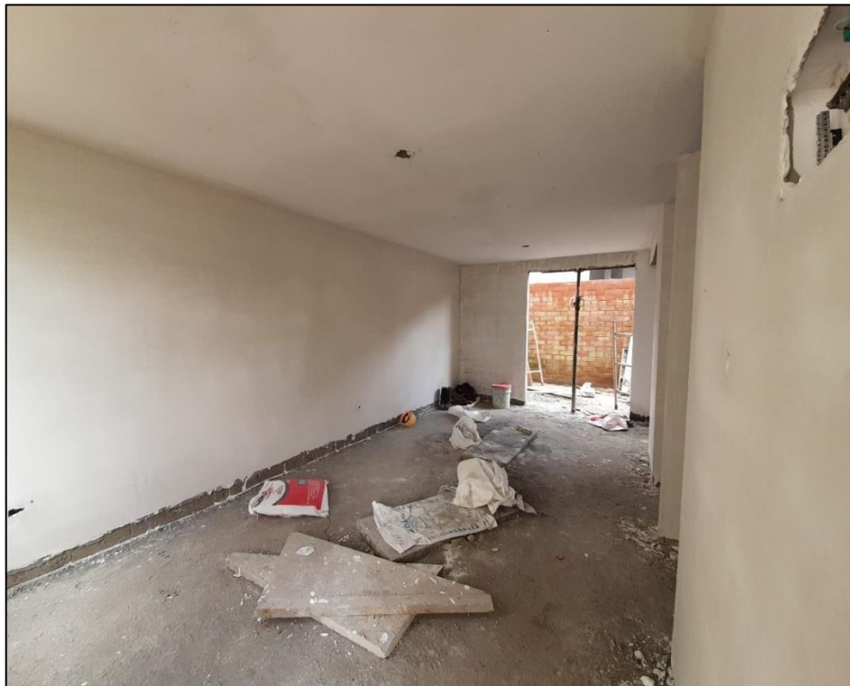
Figura 33. Estuco de muros. Fuente Propia
