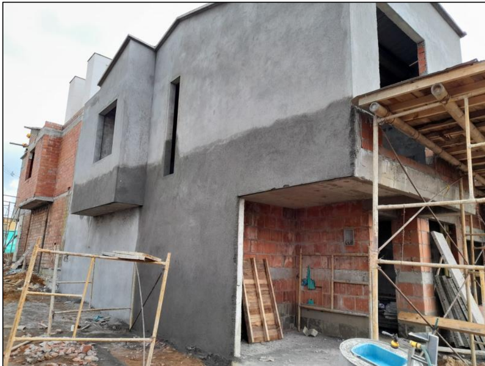
Figura 40. Repello de fachadas. Fuente: Propia.
