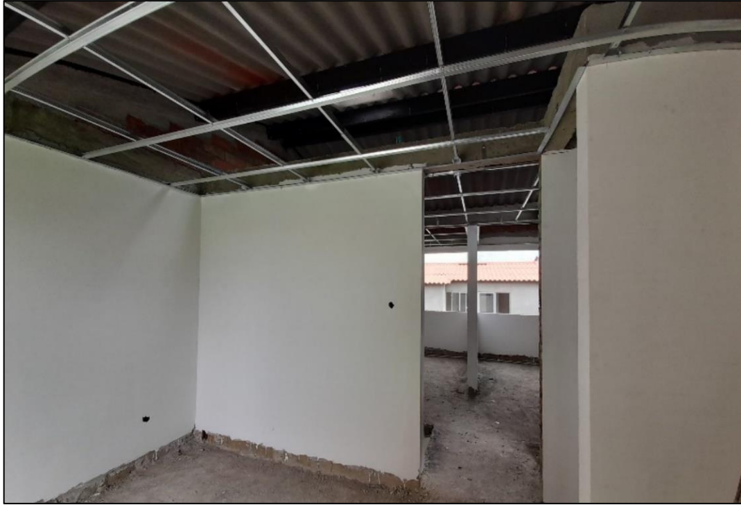
Figura 35. Estructura cielo raso. Fuente: Propia
