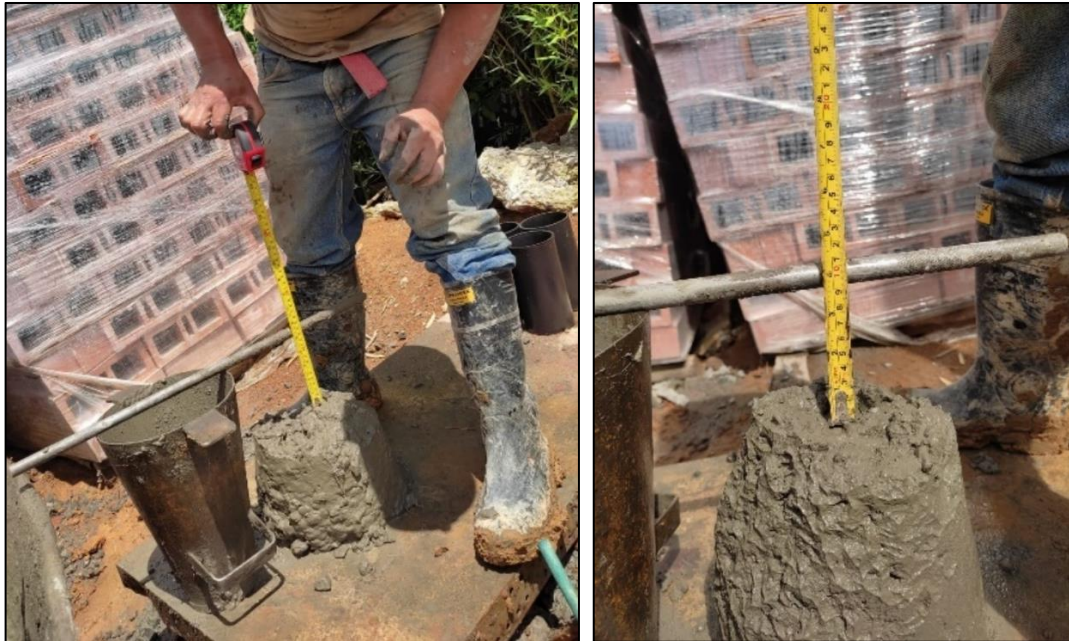
Figura 16. slump para concreto de cimentación. Fuente: Propia
