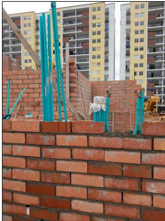
Figura 19. Prolongación de tuberías eléctricas en muros. Fuente: Propia.
