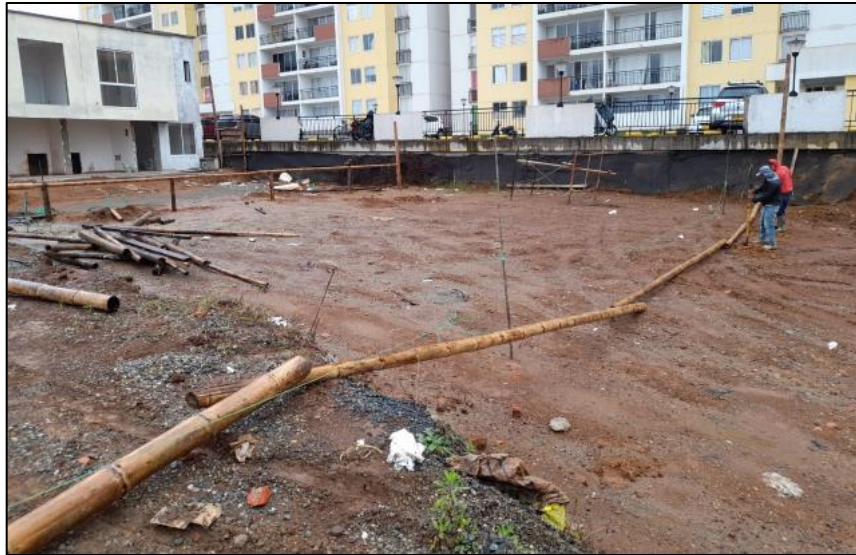
Figura 7. Instalación de caballetes. Fuente: Propia.
