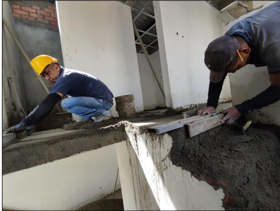
Figura 42. Repello de pisos. Fuente: Propia.
