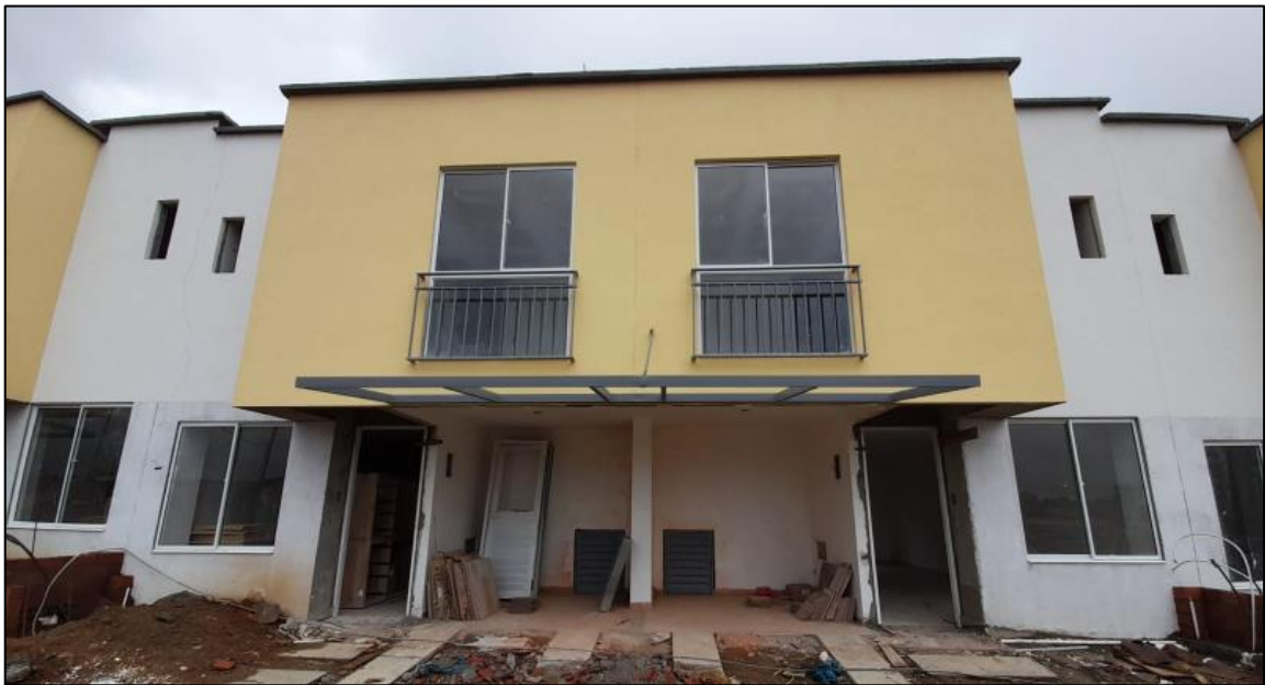
Figura 41. Granotex en fachada. Fuente: Propia
