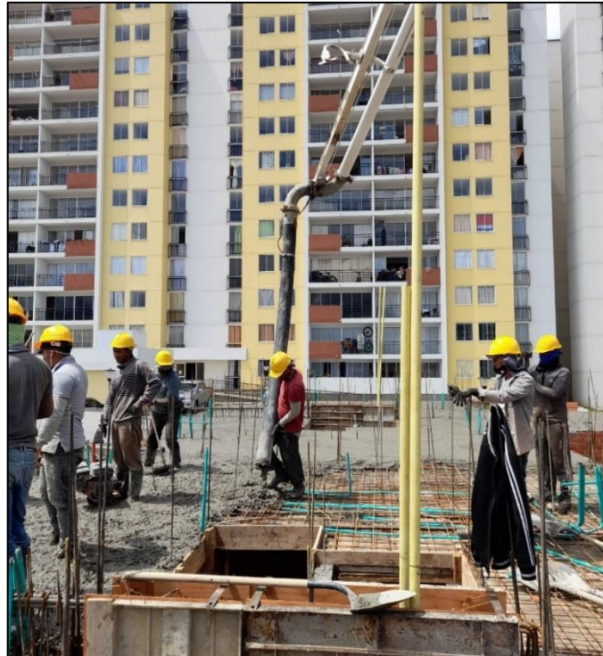
Figura 24. Fundición losa de entrepiso con autobomba. Fuente: Propia
