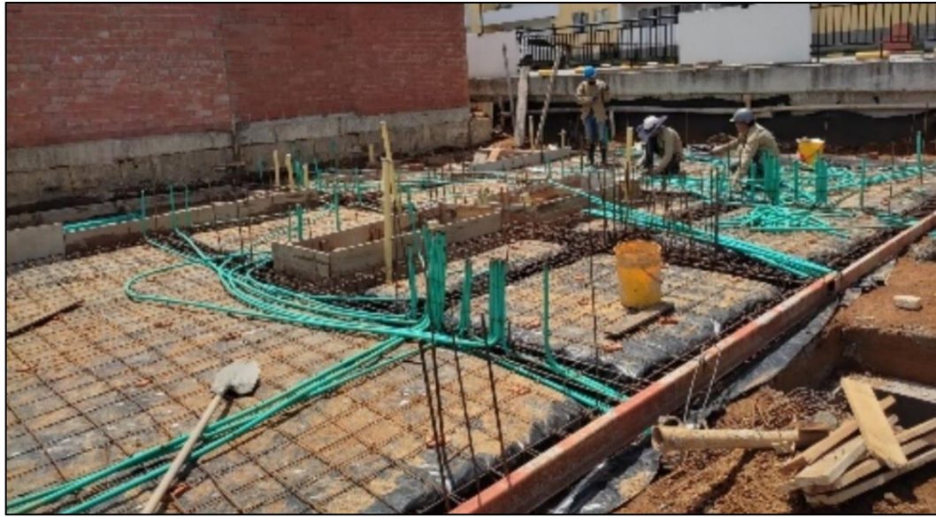
Figura 15. cuadrilla eléctrica para cimentación. Fuente: Propia
