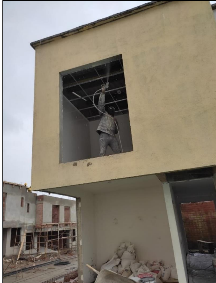
Figura 34. Pintura de muros internos. Fuente: Propia
