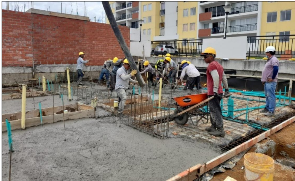
Figura 14. Vaciado del concreto. Fuente: Propia
