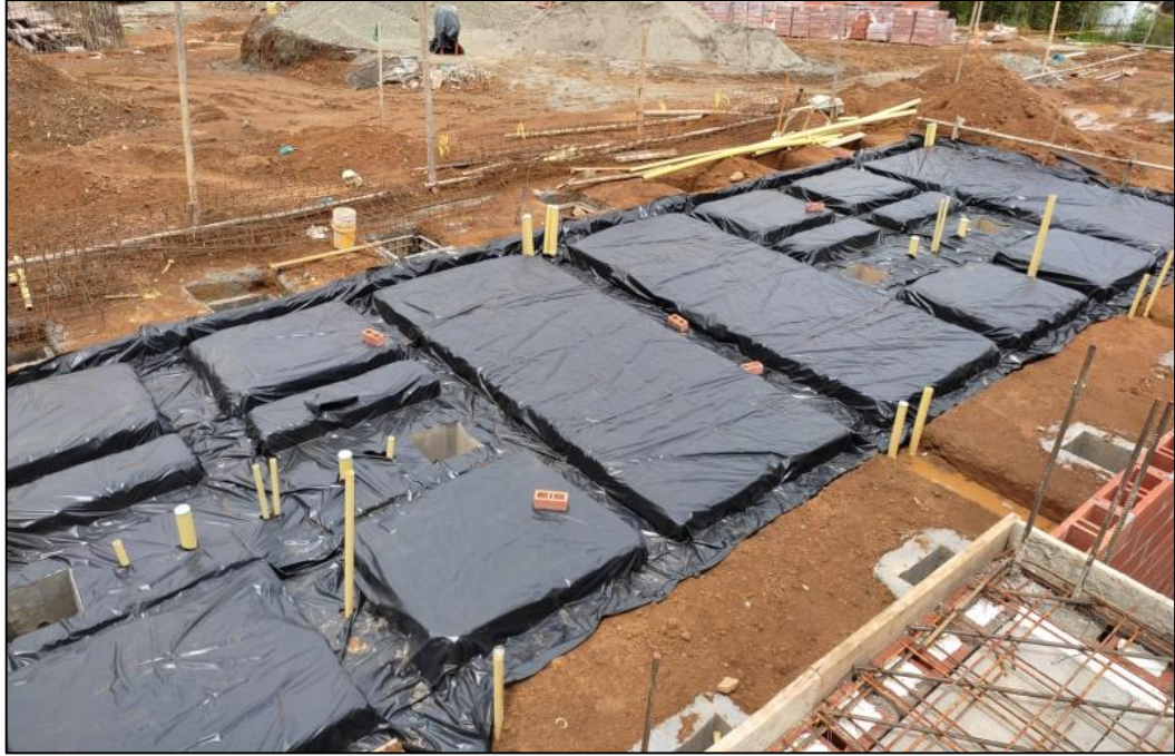
Figura 11. Cimentación de vivienda en etapa de Polisecc. Fuente: Propia
