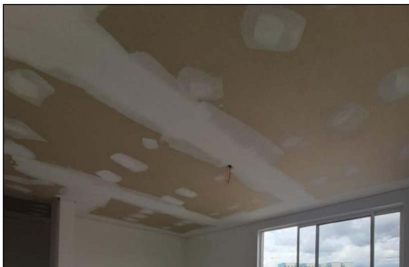
Figura 39. Tratamiento para panel yeso. Fuente: Propia
