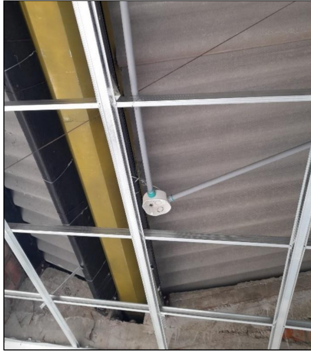
Figura 36. Instalación de ductos eléctricos. Fuente: Propia.
