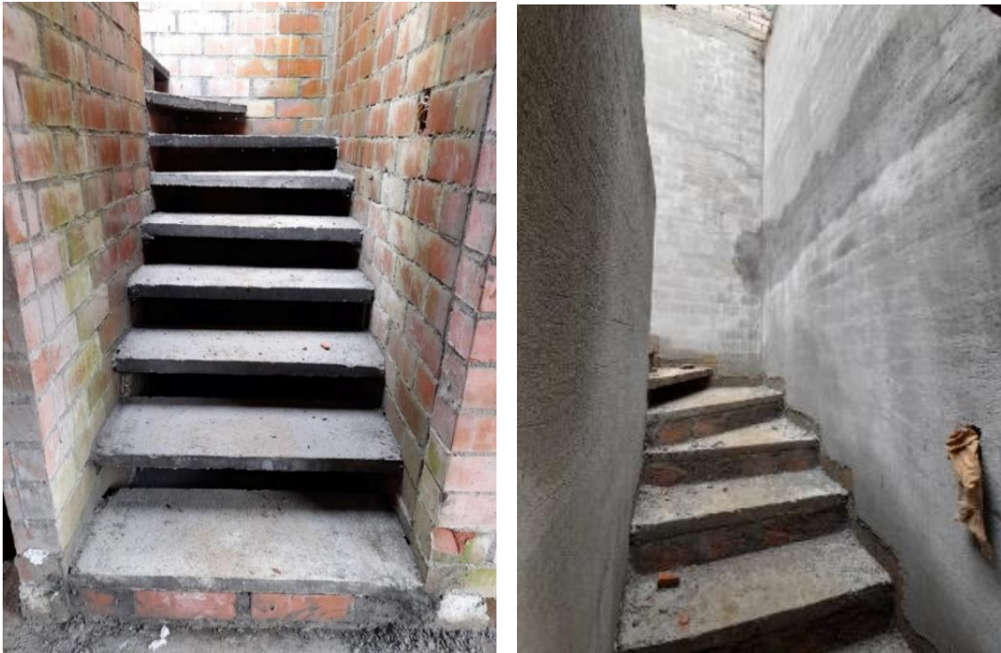
Figura 26. Escalera en obra gris. Fuente: Propia
