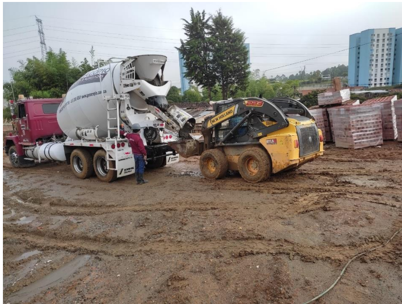
Figura 50. Transporte de concreto premezclado con minicargador. Fuente: Propia.
