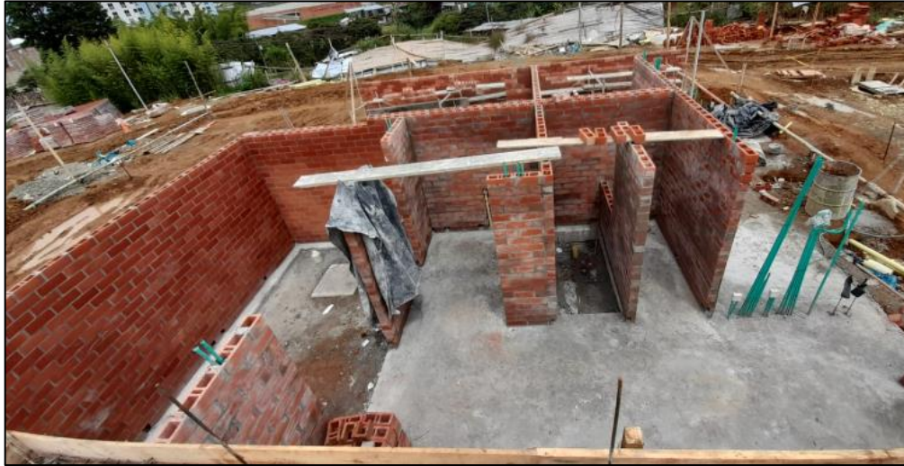
Figura 18. Mampostería estructural primer piso. Fuente: Propia.
