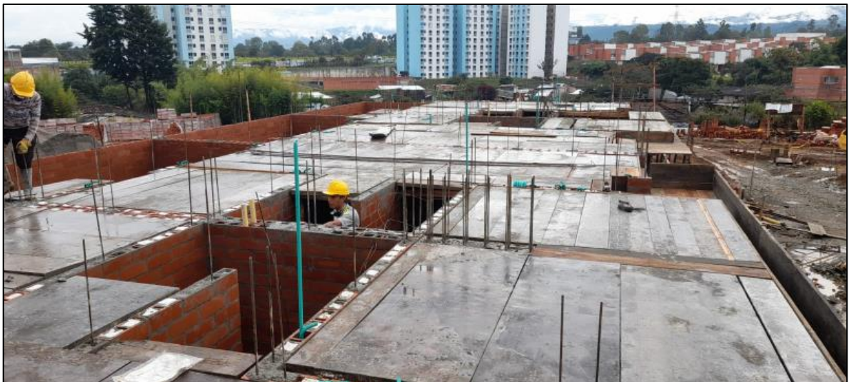
Figura 20. Formaleta losa de entrepiso. Fuente: Propia.
