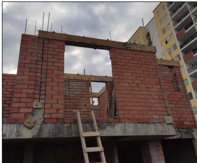
Figura 29. Encofrado vigas de amarre. Fuente: Propia
