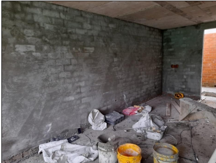
Figura 32. Relleno acrílico en muros. Fuente: Propia
