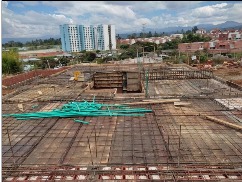
Figura 22. Losa de entrepiso etapa refuerzo positivo. Fuente: Propia
