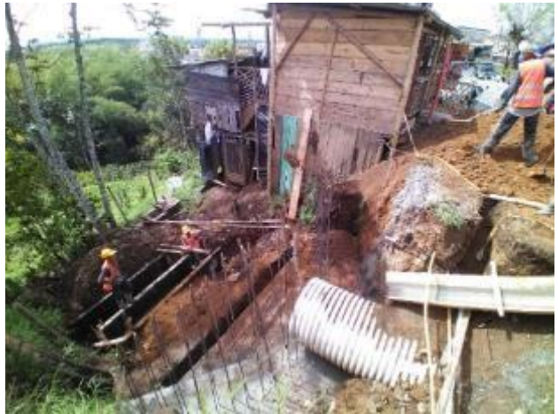
Imagen 76. Relleno con tierra amarilla para los disipadores de alcantarilla. Barrio Obrero.
