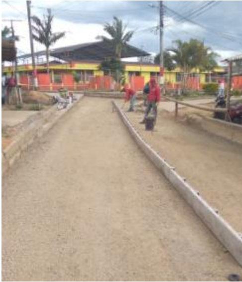
Imagen 133. Instalación de la formaleta para la respectiva fundición. Barrio Patio Bonito.
