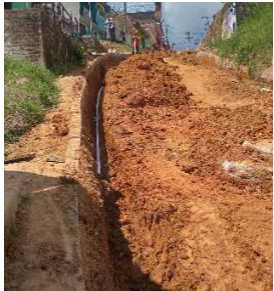
Imagen 158. Cambio de red principal de agua potable. Sector Galería.
