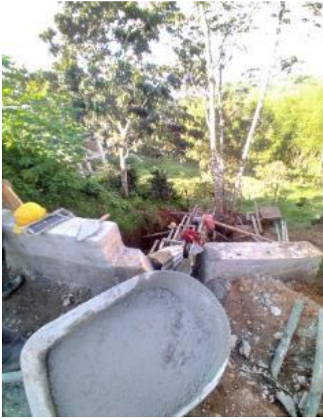
Imagen 84. Fundición de las paredes de los disipadores con mezclador mecánico y vibrador. Barrio Obrero.
