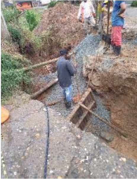
Imagen 18. Relleno con material de mejoramiento y triturado y compactación con pistón manual. Barrio La Playa.
