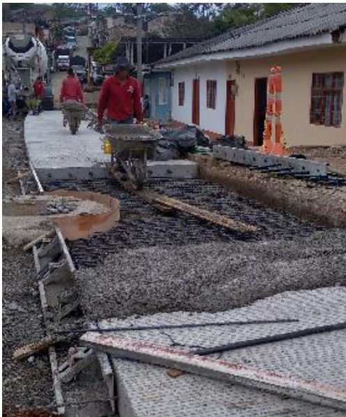
Imagen 143. Fundición de las placas alrededor del brocal. Barrio Patio Bonito.
