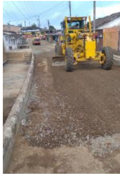
Imagen 128. Adecuación de la subbase después de la intervención por parte del personal del acueducto. Barrio Patio Bonito.
