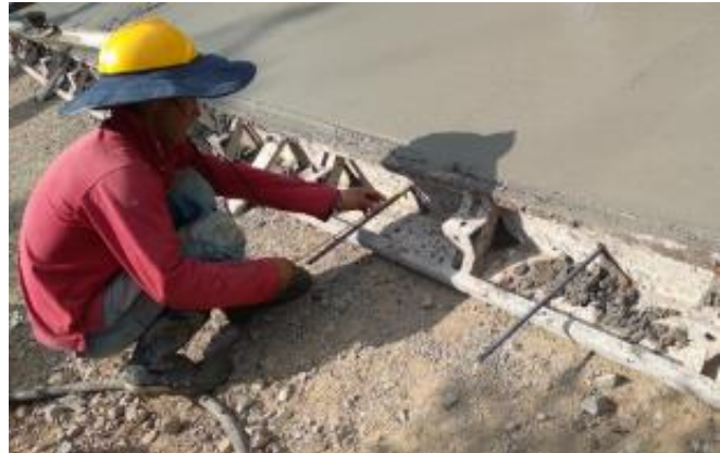
Imagen 39. Colocación de conectores para el empalme con la placa del segundo carril. Barrio La Capilla.
