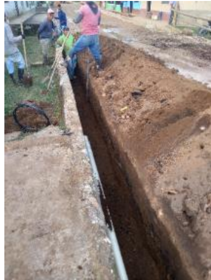
Imagen 105. Excavación por parte del personal del acueducto. Barrio Patio Bonito.
