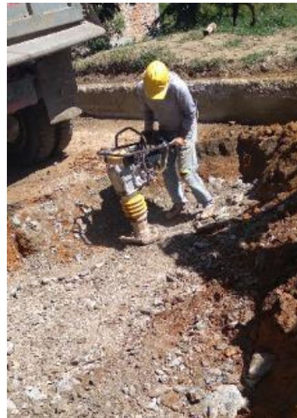
Imagen 116. Relleno de la excavación con roca muerta y compactación con saltarín. Barrio Patio Bonito.
