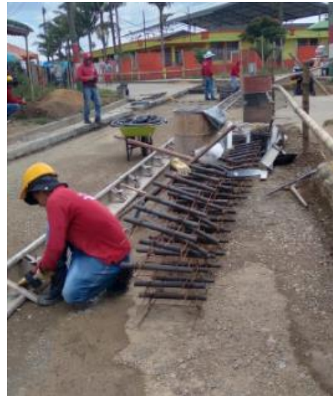
Imagen 132. Instalación de formaletas y dovelas para la fundición. Barrio Patio Bonito
