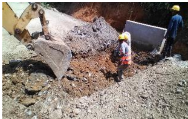
Imagen 97. Excavación con retroexcavadora para retirar el material saturado. Barrio Obrero.
