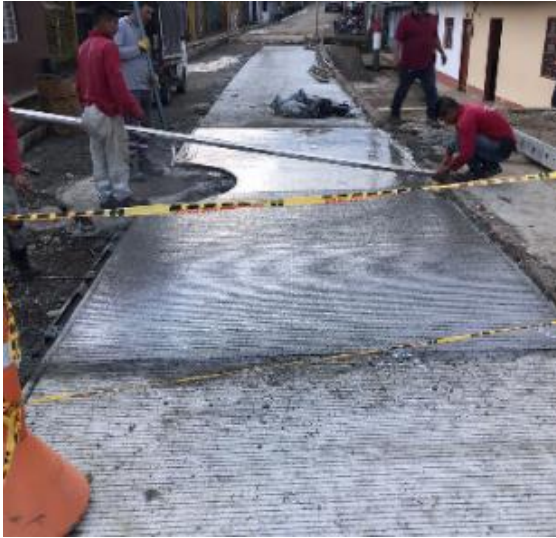
Imagen 144. Acabados de las placas reforzadas. Barrio Patio Bonito.
