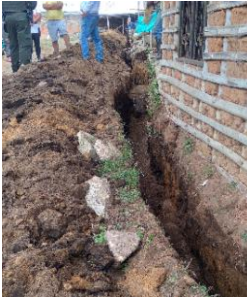
Imagen 149. Excavación por parte del personal del acueducto para el cambio de la red principal de agua potable. Barrio Villa del sol.
