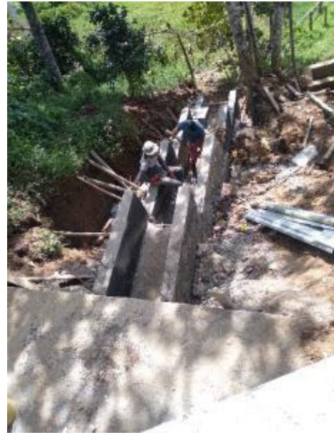
Imagen 83. Retiro de las formaletas de las paredes de los disipadores. Barrio Obrero.
