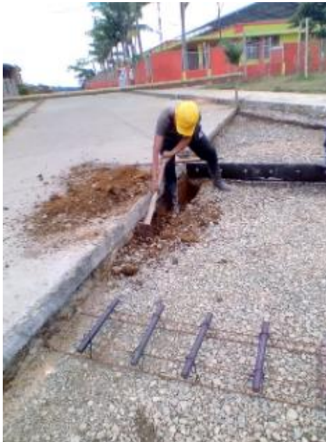
Imagen 134. Excavación manual para la viga de transición. Barrio Patio Bonito.
