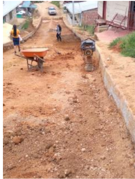
Imagen 160. Compactación del relleno por parte del personal del acueducto. Sector Galería.
