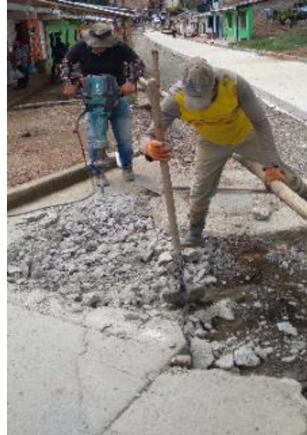
Imagen 145. Demolición con rotomartillo para adecuar placas en mal estado. Barrio Patio Bonito.
