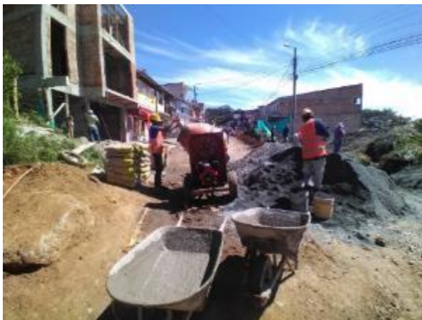
Imagen 63. Fundición de cabezal de alcantarilla con mezclador mecánico. Barrio Obrero
