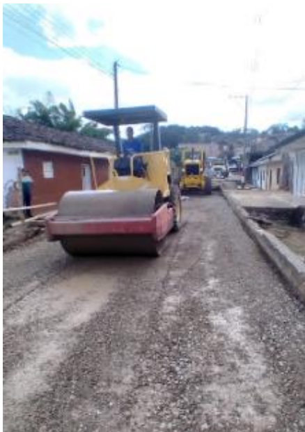
Imagen 131. Compactación final de la subbase. Barrio Patio Bonito.
