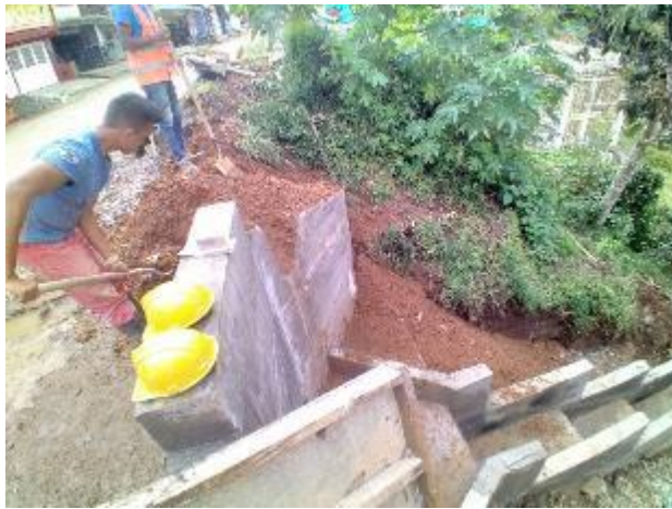
Imagen 85. Relleno con tierra amarilla a los lados de los disipadores. Barrio Obrero.
