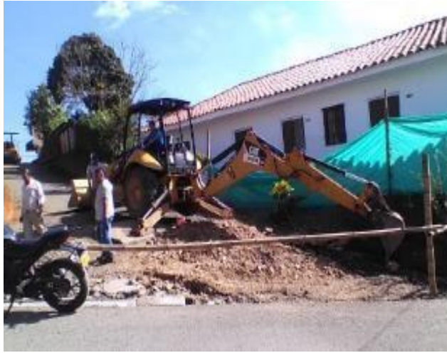
Imagen 28. Retiro de material contaminante con la retroexcavadora. Barrio La Capilla.
