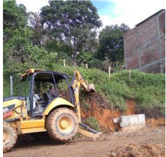
Imagen 73. Perfilación de talud que está junto al cabezal de la alcantarilla. Barrio Obrero.
