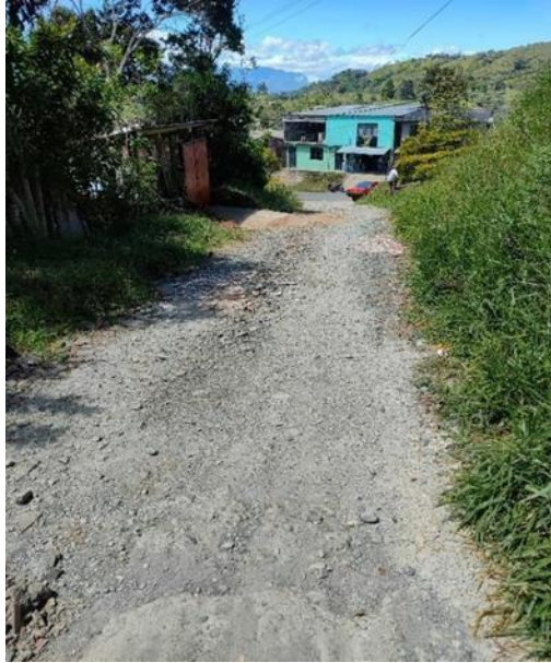
Imagen 6. Estado inicial, Barrio La Capilla.
