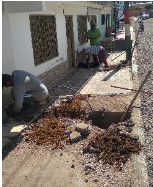
Imagen 129. Arreglo de las acometidas por parte del personal del acueducto. Barrio Patio Bonito.
