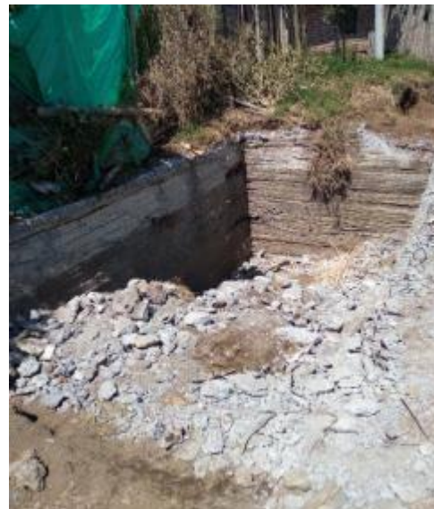
Imagen 146. Continuación de la demolición del tanque de pozo séptico. Barrio Villa del Sol.
