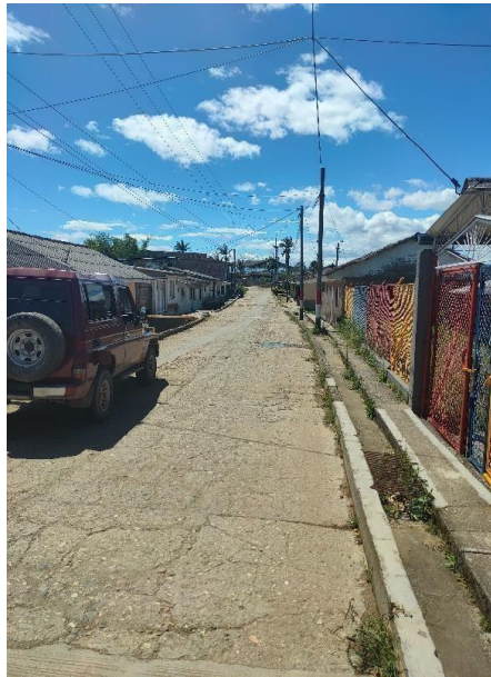
Imagen 10.Estado inicial, Barrio Patio Bonito.
