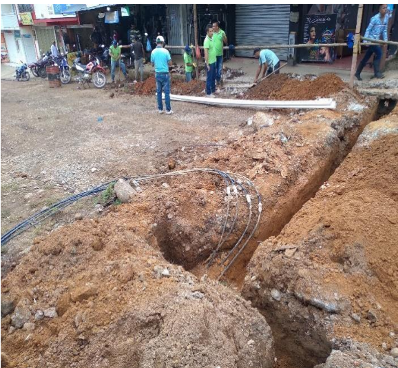
Imagen 55. Excavación por parte del personal del acueducto. Barrio Obrero.
