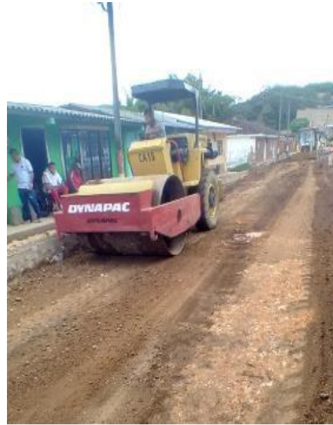
Imagen 109. Compactación de la subrasante con vibro compactador. Barrio Patio Bonito.
