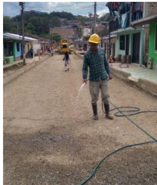
Imagen 123. Humedecimiento de la subbase manualmente con manguera. Barrio Patio Bonito.
