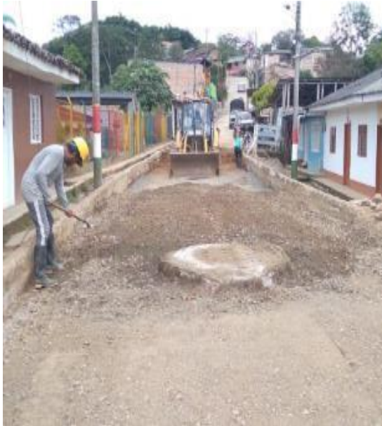
Imagen 121. Adecuación de subbase manualmente alrededor de una recámara. Barrio Patio Bonito.
