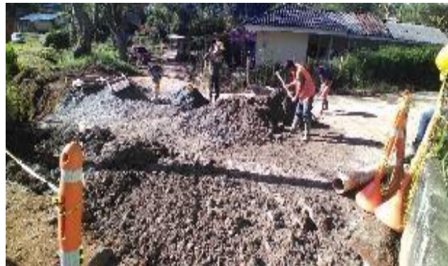
Imagen 20. Terminación de relleno de la zanja de la alcantarilla. Barrio La Playa.
