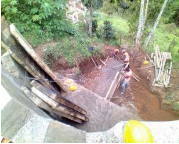
Imagen 80. Colocación de formaletas para fundición de las bases de los disipadores de la alcantarilla. Barrio Obrero.
