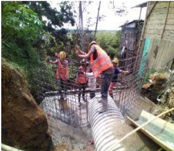
Imagen 71. Armado del acero de refuerzo para las aletas de la alcantarilla. Barrio Obrero.
