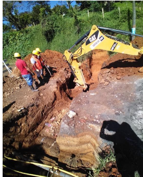
Imagen 53. Excavación con retroexcavadora para zanja del alcantarillado. Barrio Obrero.
