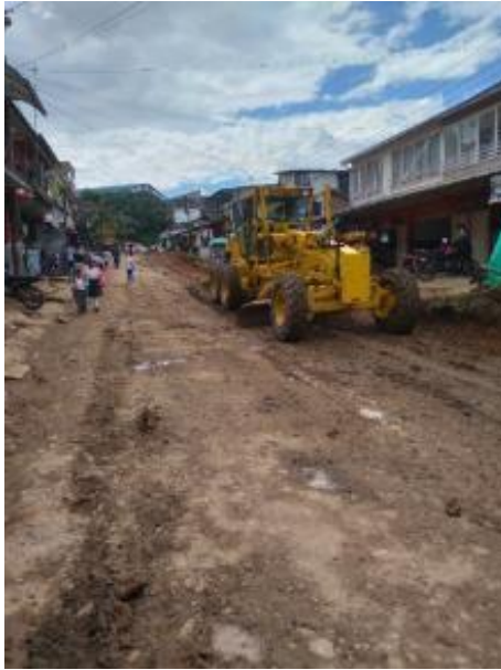
Imagen 91. Conformación y perfilación de la subrasante con motoniveladora. Barrio Obrero.
