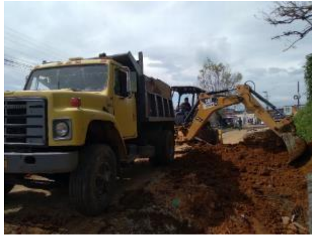
Imagen 64. Retiro de tierra proveniente de la excavación de alcantarilla. Barrio Obrero.
