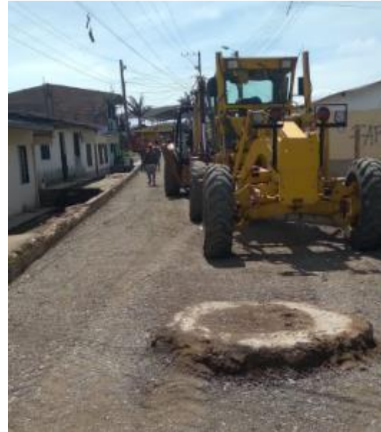
Imagen 120 Conformación de la subbase tramo recto. Barrio Patio Bonito.
