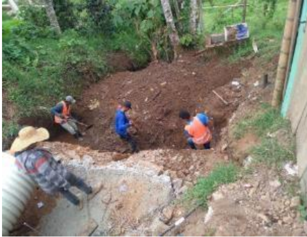
Imagen 75. Excavación manual para disipadores de la alcantarilla k0+60. Barrio Obrero.
