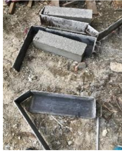
Imagen 36. Desencofre de vigas para el curado. Barrio La Capilla.
