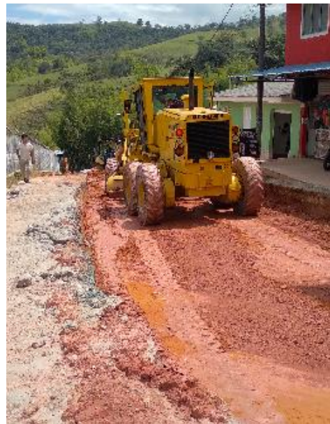
Imagen 155. Explanación de la subrasante con la motoniveladora. Sector Galería.
