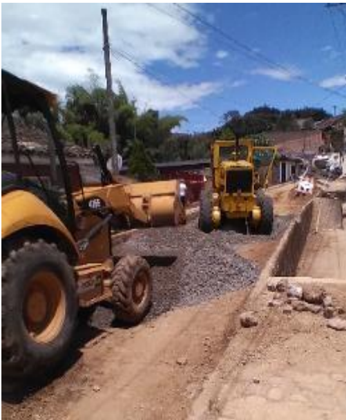
Imagen 119. Riego de la subbase. Barrio Patio Bonito.
