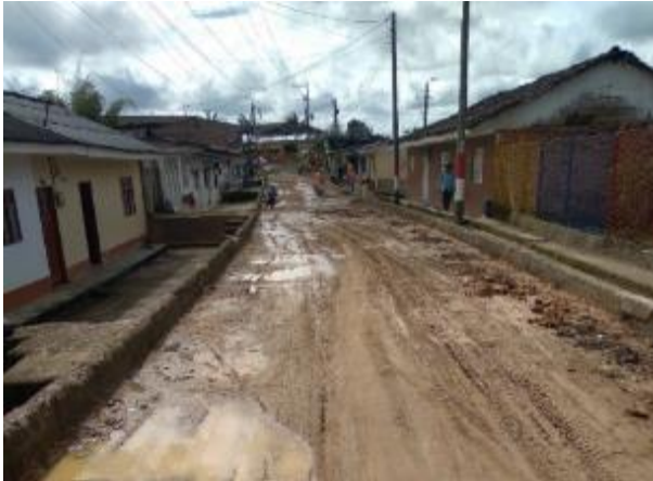
Imagen 106. Limpieza de la superficie de rodadura. Barrio Patio Bonito.
