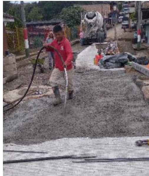
Imagen 142. Vibrado del concreto placas reforzadas. Barrio Patio Bonito.
