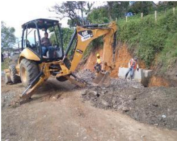
Imagen 81. Relleno con mejoramiento (roca muerta) para reemplazar tierra saturada. Barrio Obrero.
