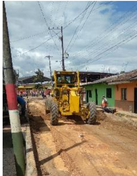
Imagen 107. Continuación de la explanación y nivelación de la subrasante con la motoniveladora. Barrio Patio Bonito.
