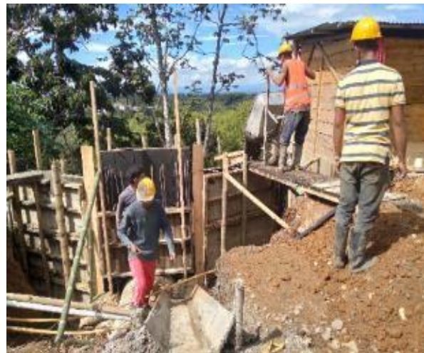
Imagen 70. Fundición de las aletas de la alcantarilla. Barrio Obrero.
