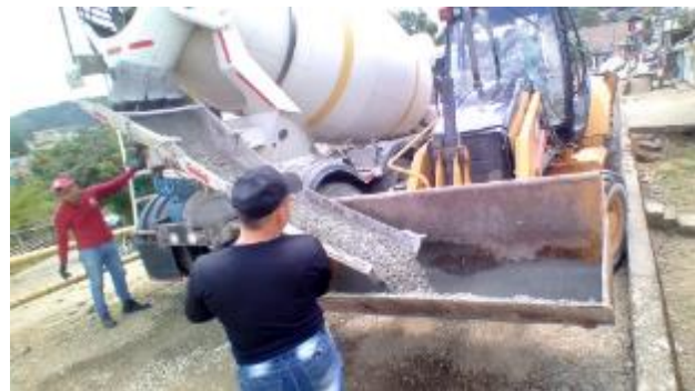
Imagen 135. Inicio de la fundición del primer carril con mixer y ayuda de la retroexcavadora. Barrio Patio Bonito.
