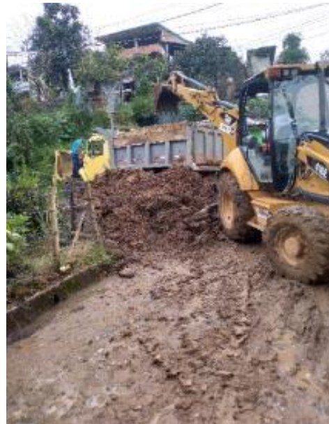
Imagen 17. Retiro de tierra saturada de la vía y cargue en volqueta para botar. Barrio La Playa
