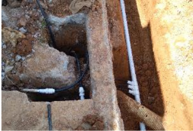
Imagen 161. Cambio de accesorios para acometidas domiciliarias. Sector Galería.
