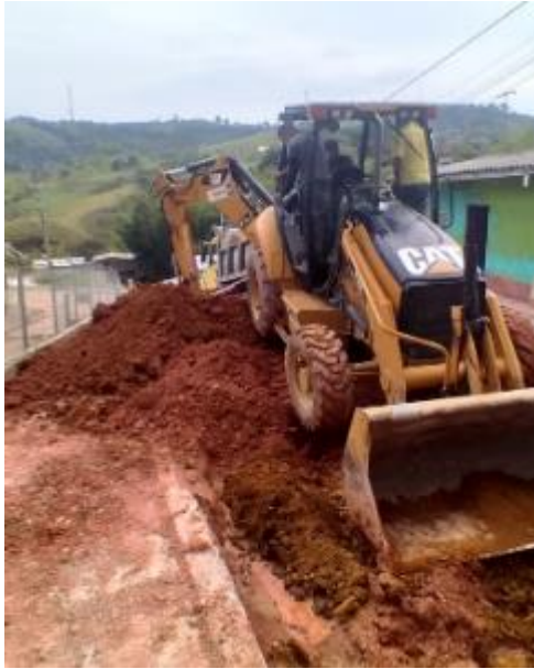
Imagen 157. Retiro de tierra proveniente de la excavación. Sector Galería.
