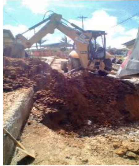
Imagen 114. Excavación con retroexcavadora para retiro de fallo. Barrio Patio Bonito.
