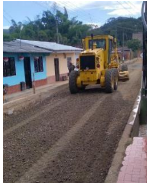
Imagen 118. Continuación del riego y conformación de la subbase con la motoniveladora. Barrio Patio Bonito.
