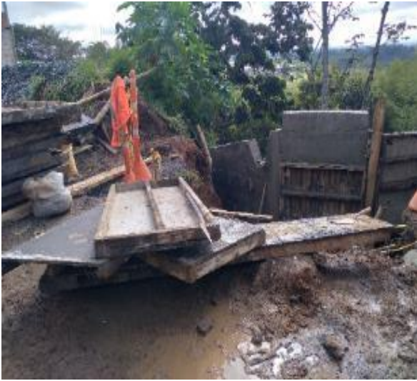
Imagen 72. Retiro de formaletas de las aletas de la alcantarilla. Barrio Obrero.
