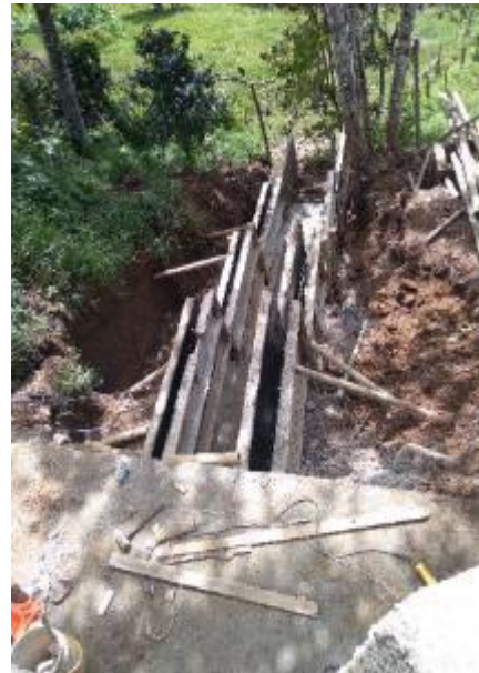
Imagen 82. Colocación de formaletas para fundir las paredes de los disipadores de la alcantarilla. Barrio Obrero.
