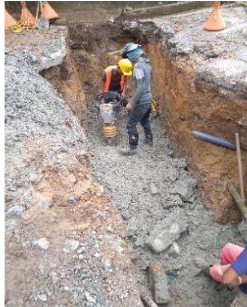
Imagen 19. Relleno con material de mejoramiento (roca muerta) y compactación con saltarín. Barrio La Playa.
