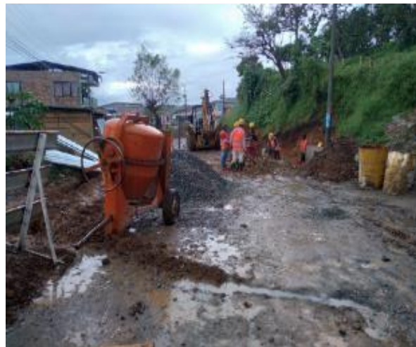
Imagen 66. Fundición de concreto de solado para base de aletas de la alcantarilla. Barrio Obrero.
