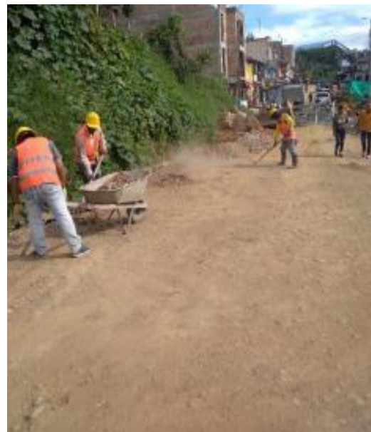
Imagen 62. Adecuación y limpieza de la vía con escoba y pala. Barrio Obrero.
