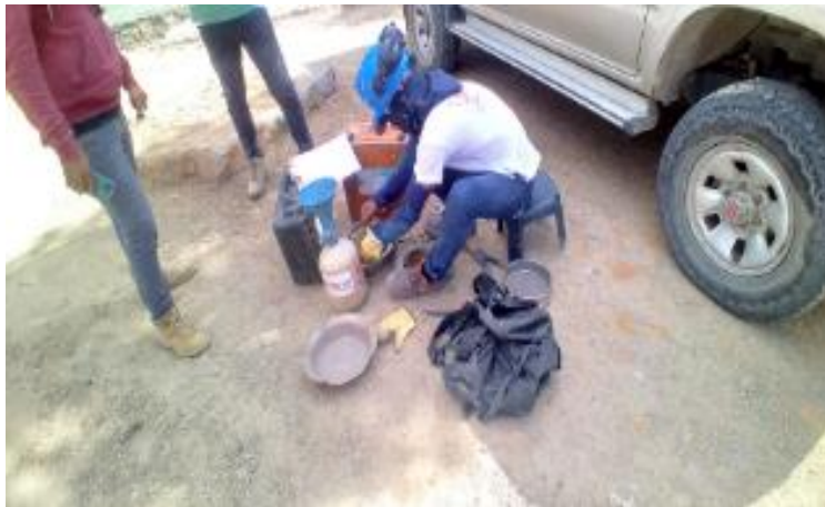
Imagen 30. Toma de densidades de la subbase. Barrio La Capilla.
