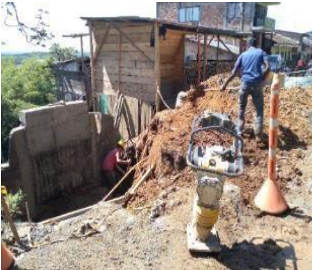
Imagen 74. Relleno con tierra amarilla, compactación con saltarín. Barrio Obrero.
