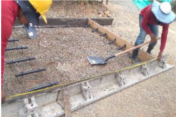
Imagen 33 Colocación de las dovelas para las dilataciones en las placas de concreto. Barrio La Capilla.
