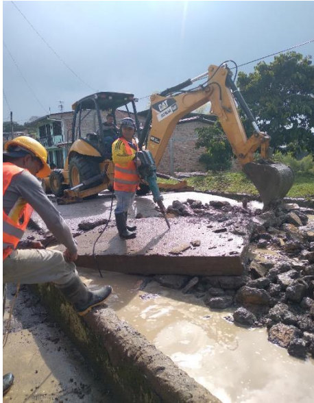
Imagen 102. Demolición concreto rígido. Barrio Patio Bonito.
