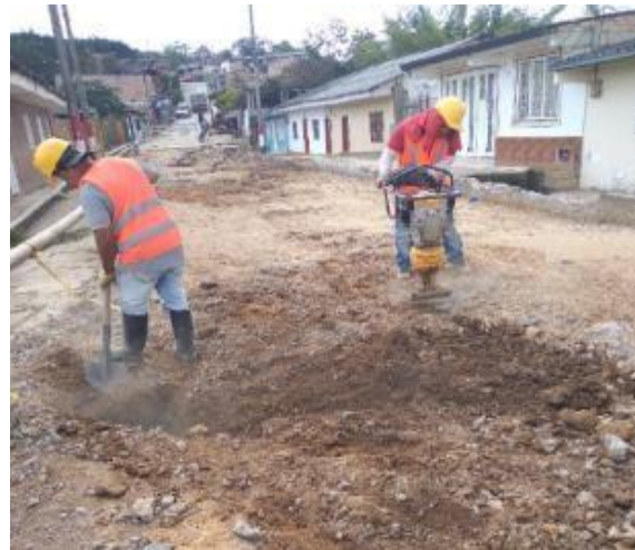
Imagen 104. Compactación con saltarín. Barrio Patio bonito.
