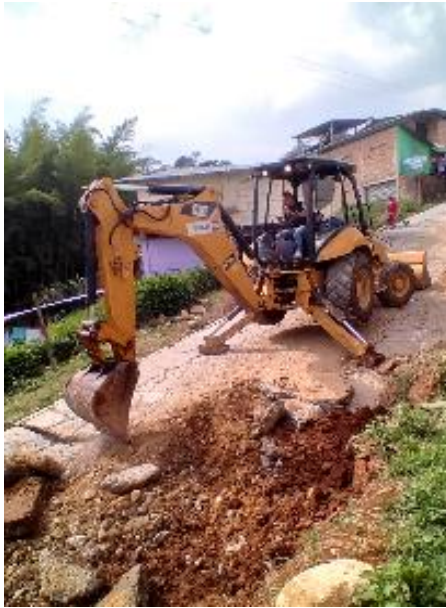
Imagen 152. Demolición de pavimento rígido con retroexcavadora. Sector Galería.
