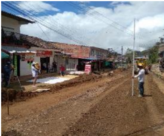
Imagen 93. Verificación y colocación de niveles con ayuda de la comisión de topografía. Barrio Obrero.
