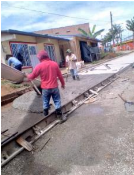
Imagen 139. Continuación de la fundición del primer carril. Barrio Patio Bonito.
