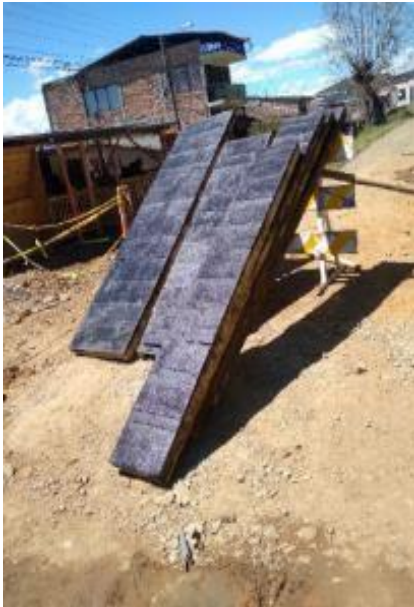
Imagen 61. Colocación de formaletas para fundición del cabezal de la alcantarilla. Barrio Obrero.
