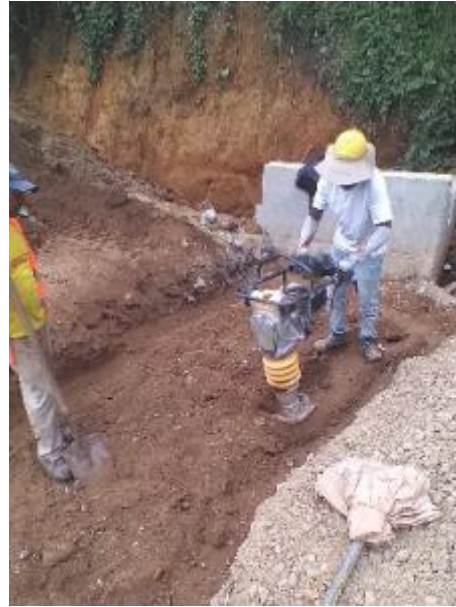
Imagen 98. Relleno y compactación del relleno con saltarín. Barrio Obrero.
