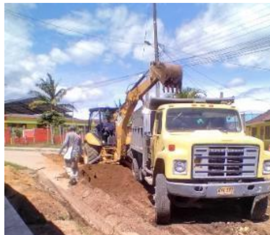
Imagen 112. Retiro de tierra proveniente de la excavación de los empalmes. Barrio Patio Bonito.
