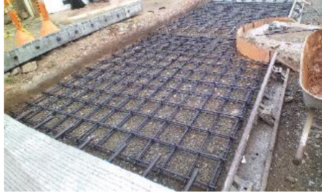
Imagen 141. Armado de parrillas en acero de 1/2" para refuerzo. Barrio Patio Bonito.
