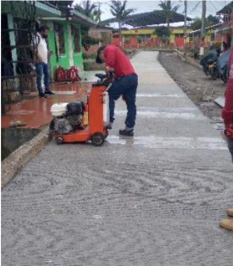
Imagen 140. Corte de las juntas de dilatación con la cortadora de concreto. Barrio Patio Bonito.
