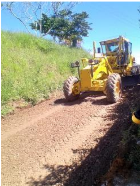
Imagen 25. Riego y conformación de la subbase utilizando la motoniveladora. Barrio La Capilla.
