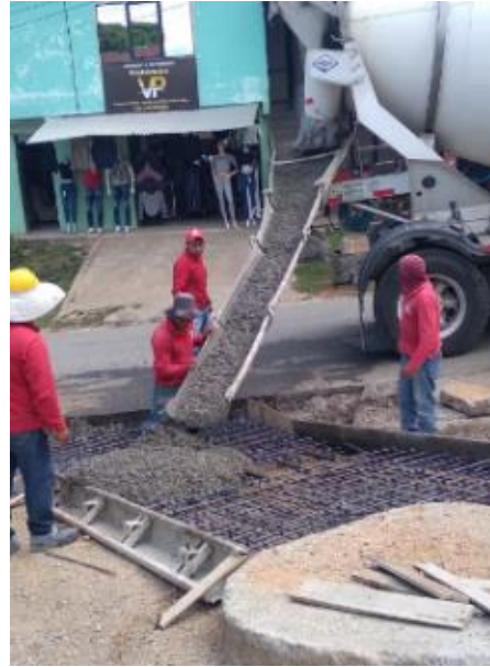
Imagen 44. Fundición de las losas reforzadas y primer carril hasta el empalme. Barrio La Capilla.
