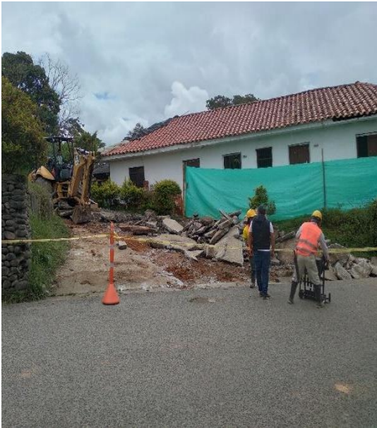
Imagen 21. Demolición pavimento existente. Barrio La Capilla.
