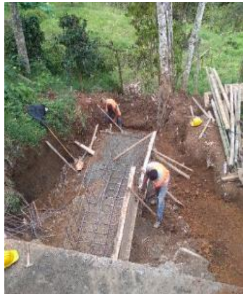
Imagen 78. Armado de acero de refuerzo para los disipadores de la alcantarilla. Barrio Obrero.
