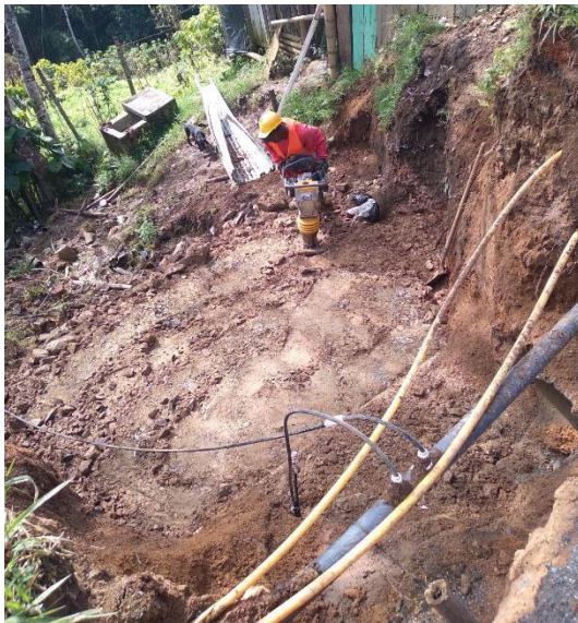
Imagen 56. Relleno y compactación de roca muerta, alcantarilla. Barrio Obrero.
