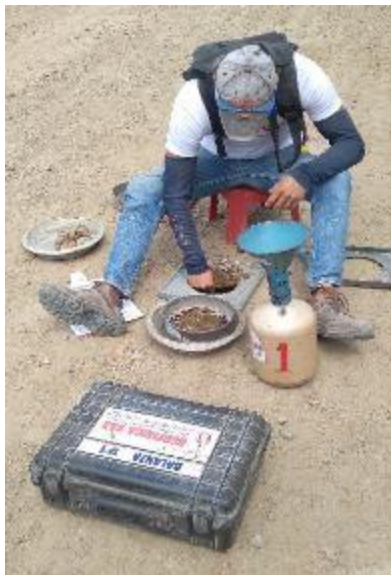
Imagen 96. Toma de muestras para calcular y verificar la densidad de la subbase. Barrio Obrero.
