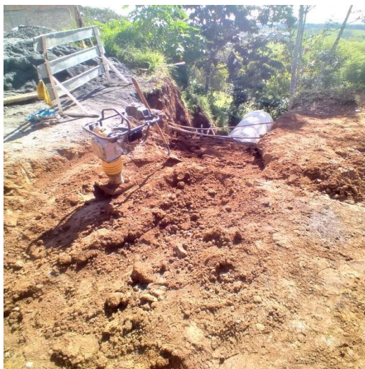
Imagen 58. Relleno y compactación tierra amarilla del alcantarillado. Barrio Obrero.
