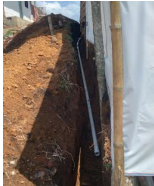
Imagen 148. Instalación de tubería de agua potable. Barrio Villa del sol.
