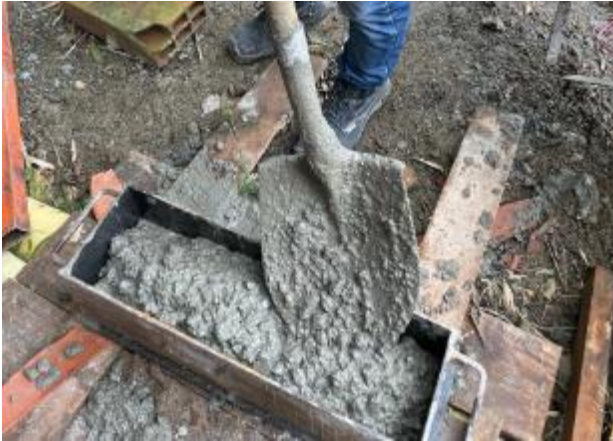
Imagen 35. Toma de muestras de vigas de concreto. Barrio La Capilla.
