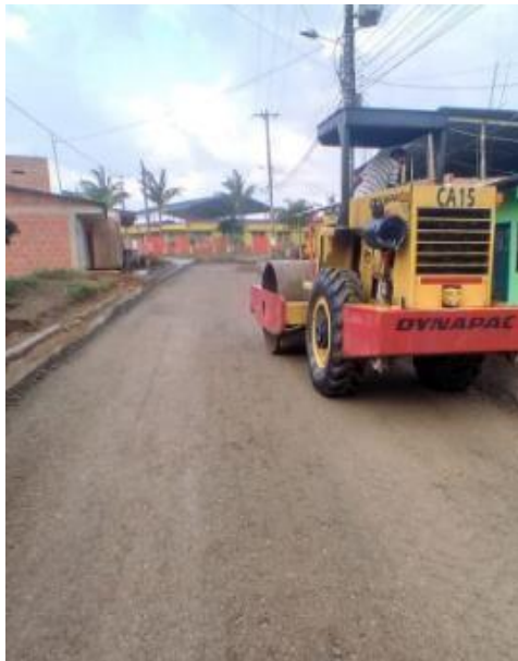
Imagen 122. Compactación de la subbase con el vibro compactador. Barrio Patio Bonito.
