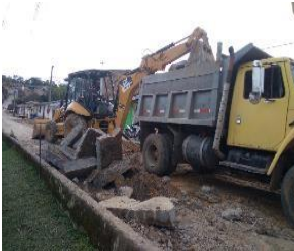
Imagen 103. Continuación de demolición y retiro de escombros. Barrio Patio Bonito.
