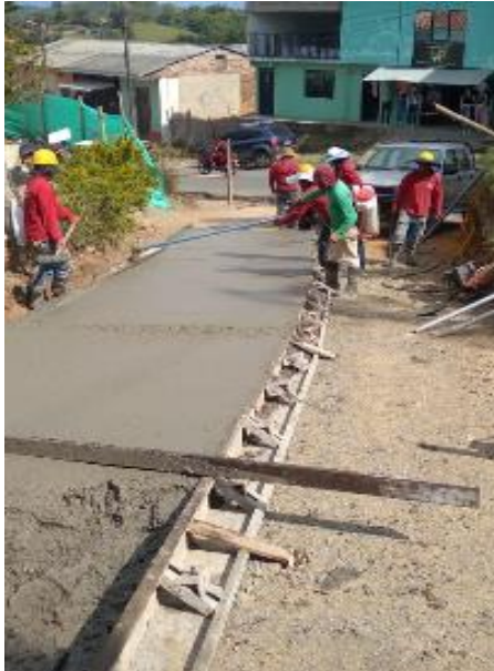
Imagen 40. Acabados y detalles en la placa de concreto primer carril. Barrio La Capilla.
