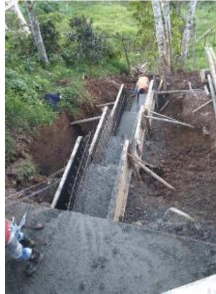
Imagen 79. Fundición las bases de los disipadores. Barrio Obrero.
