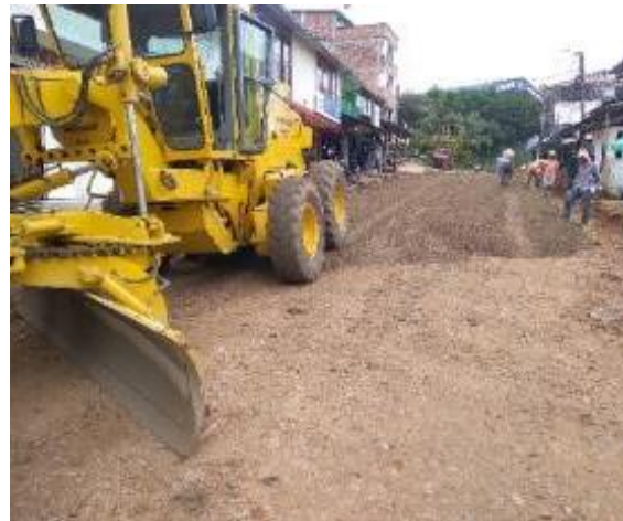
Imagen 92. Riego del material de subbase con motoniveladora. Barrio Obrero
