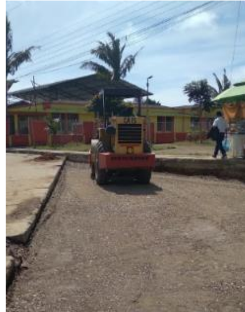
Imagen 125. Compactación de la subbase en el empalme con el vibro compactador. Barrio Patio Bonito.
