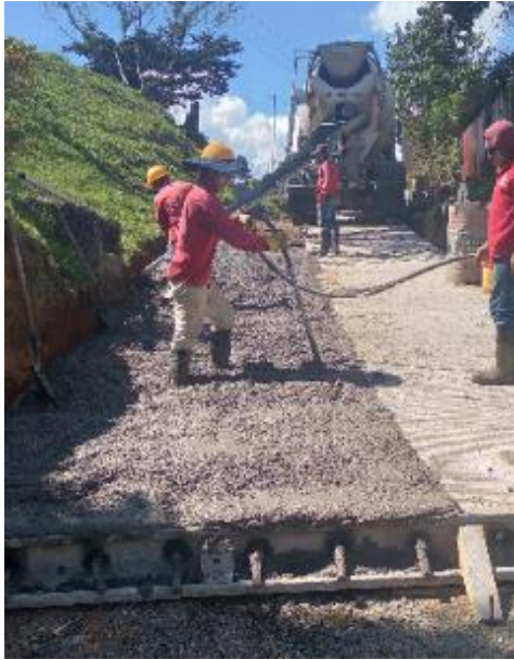
Imagen 43. Vibrado del concreto. Barrio La Capilla.
