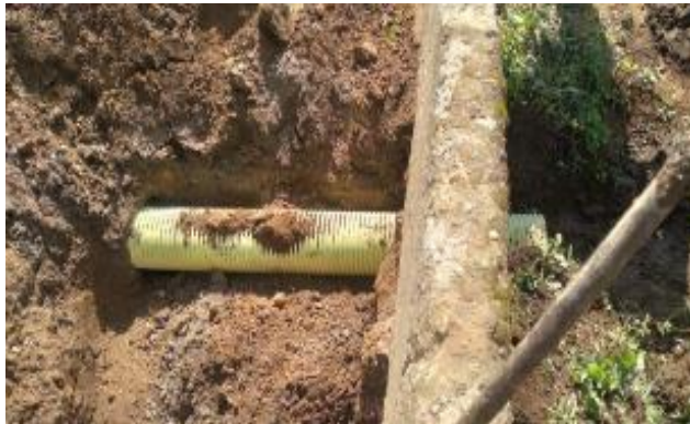
Imagen 115. Cambio de tubería de aguas lluvias y arreglo de fallo. Barrio Patio Bonito.
