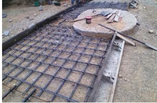
Imagen 32. Armado de parrillas de refuerzo para el brocal y el empalme, doble parrilla por placa de varilla de 1/2". Barrio La Capilla.
