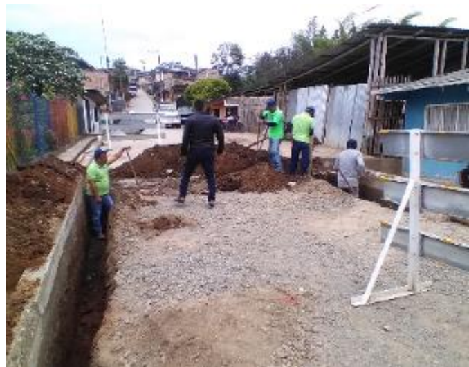
Imagen 127. Colocación de accesorios hidráulicos para red de agua potable por parte del personal del acueducto. Barrio Patio Bonito.
