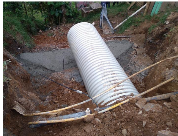
Imagen 59. Concreto ciclópeo base tubería de alcantarilla. Barrio Obrero.
