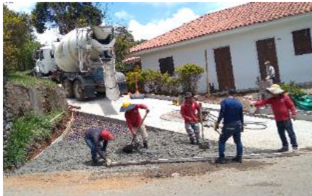
Imagen 45. Fundición para terminar la ampliación de la vía. Barrio La Capilla.
