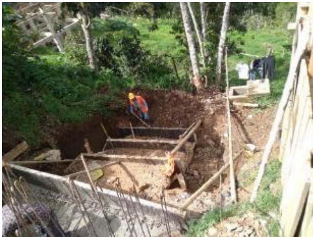
Imagen 77. Compactación manual del relleno de los disipadores con pisón. Barrio Obrero.
