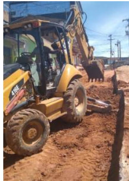
Imagen 162. Demolición de andén para cumplir con el ancho. Sector Galería
