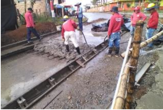
Imagen 136. Vibrado del concreto. Barrio Patio Bonito.
