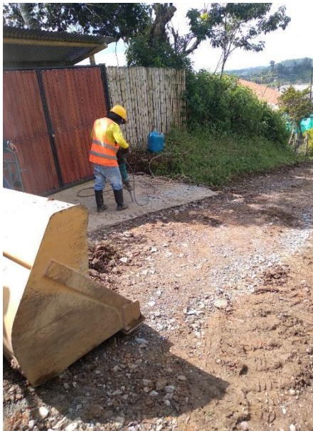
Imagen 24. Demolición acceso vehicular. Barrio La Capilla.
