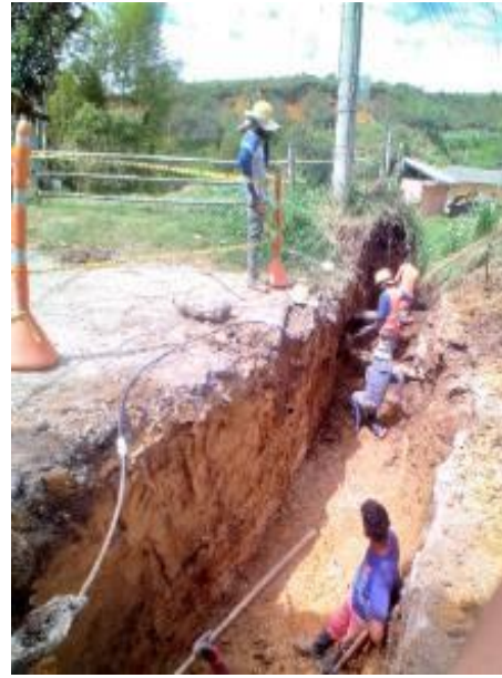
Imagen 15. Perfilación y adecuación de la zanja para instalación del tubo de 36" para alcantarilla. Barrio La Playa.
