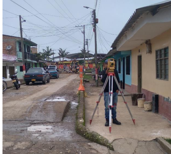
Imagen 101. Levantamiento topográfico de la calzada. Barrio Patio Bonito.
