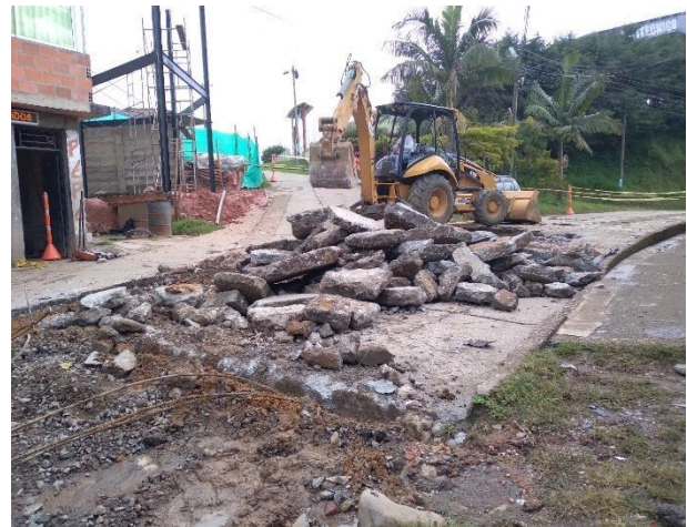
Imagen 51. Demolición de los metros lineales faltantes. Barrio Obrero
