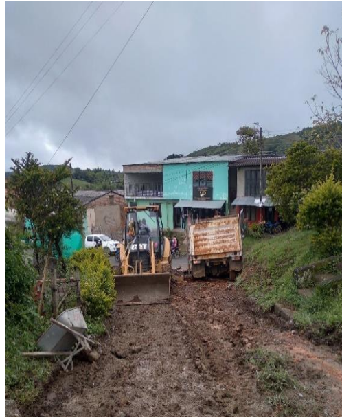
Imagen 22. Perfilación de la vía y retiro de escombros. Barrio La Capilla.
