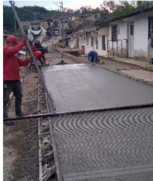
Imagen 138. Tallado para acabados y detalles de la losa de concreto. Barrio Patio Bonito.
