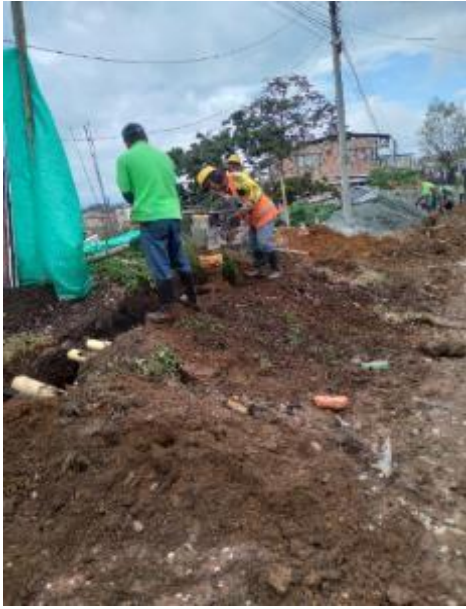
Imagen 87. Relleno y compactación de la excavación hecha por el acueducto. Barrio Obrero.
