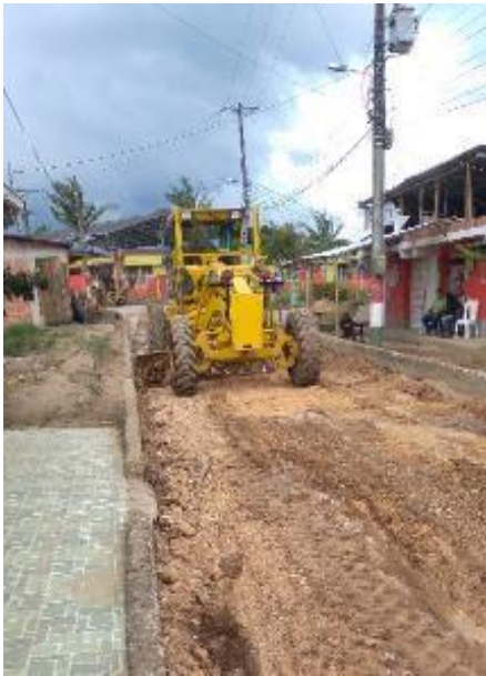
Imagen 108. Excavación de la explanación con la motoniveladora. Barrio Patio Bonito.
