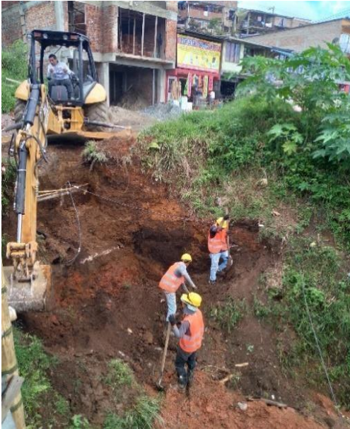
Imagen 54. Obrero Excavación para cambio de tubo de alcantarillado; abscisa k0+60. Barrio Obrero.
