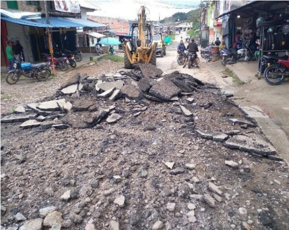
Imagen 49. Demolición de la carpeta asfáltica. Barrio Obrero.
