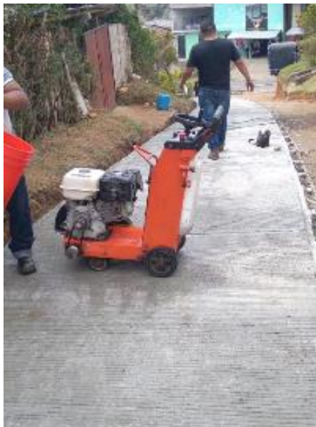
Imagen 42. Corte de dilataciones del primer carril. Barrio La Capilla.
