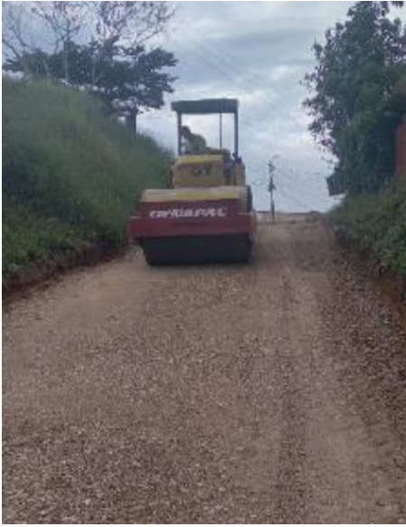
Imagen 27. Compactación de la subbase con el vibro compactador. Barrio La Capilla.
