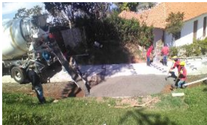
Imagen 41. Fundición del segundo carril con mixer. Barrio La Capilla.
