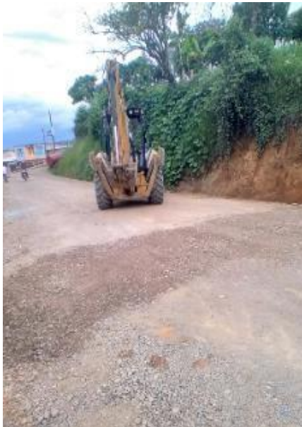
Imagen 100. Terminación del relleno y adecuación nuevamente de la subbase. Barrio Obrero.
