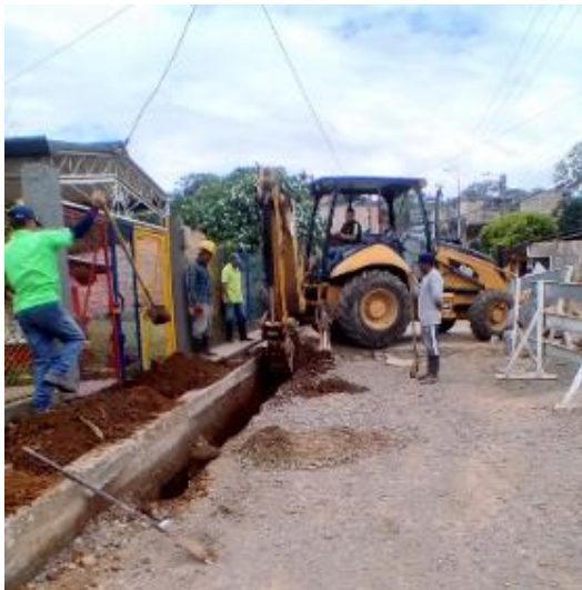
Imagen 126. Excavación para colocación de accesorios de unión en redes de agua potable. Barrio Patio Bonito.
