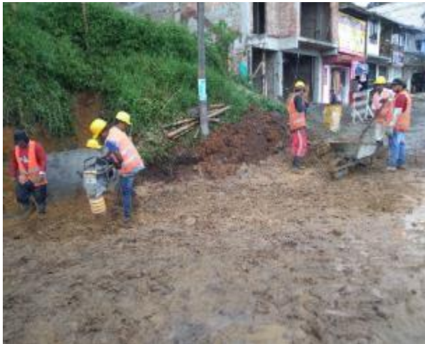
Imagen 67. Relleno y compactación para reemplazar tierra saturada sobre la alcantarilla. Barrio Obrero.
