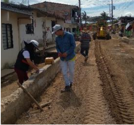
Imagen 113. Presencia de la comisión de topografía colocando niveles para riego de subbase. Barrio Patio Bonito.
