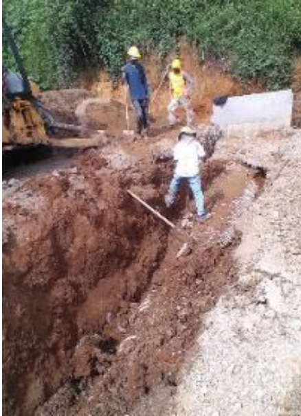
Imagen 99. Reemplazo de relleno saturado. Barrio Obrero.
