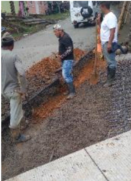
Imagen 37. Excavación manual de la viga para el empalme. Barrio La Capilla.
