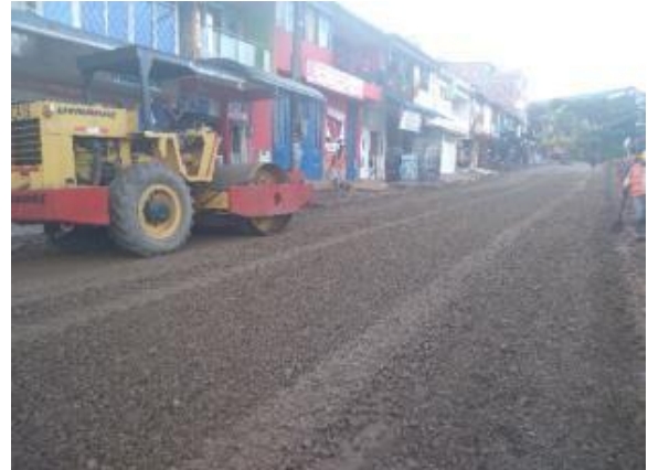
Imagen 95. Compactación de la subbase con vibro compactador. Barrio Obrero.
