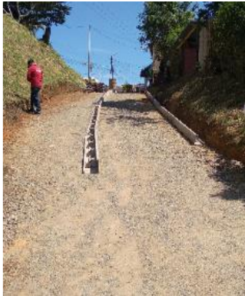
Imagen 31. Colocación de formaletas para la respectiva fundición. Barrio La Capilla.
