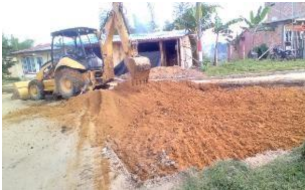
Imagen 111. Excavación con retroexcavadora para los empalmes con las vías existentes. Barrio Patio Bonito.
