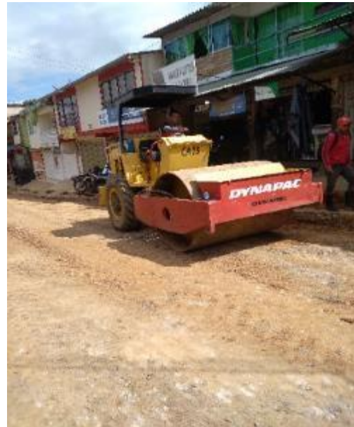
Imagen 90. Compactación de la subrasante con el vibro compactador. Barrio Obrero.
