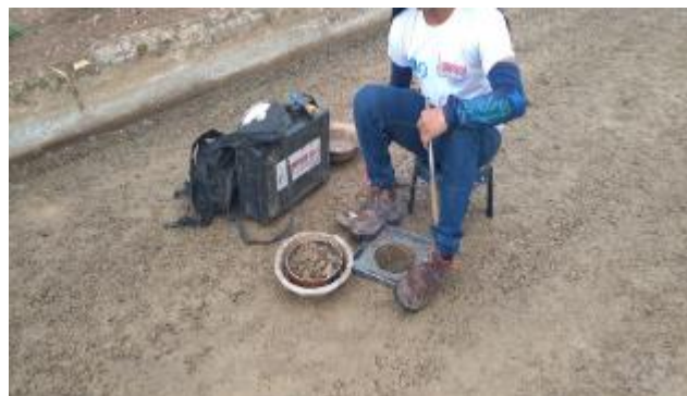
Imagen 130. Toma de densidades de la subbase. Barrio Patio Bonito.
