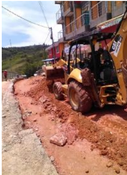
Imagen 163. Retiro de la tierra proveniente de la excavación del acueducto. Sector Galería.
