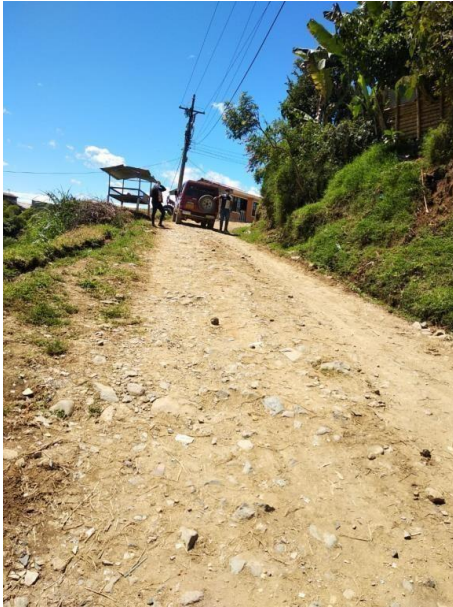
Imagen 8. Estado inicial, Barrio San Fernando.
