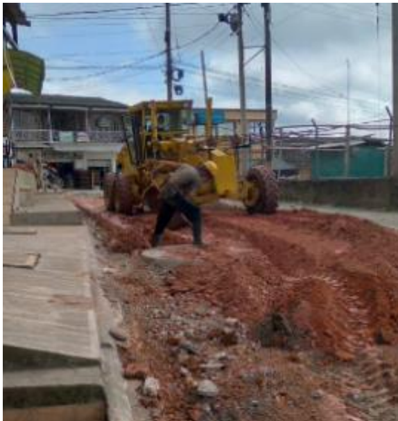
Imagen 154. Excavación y limpieza alrededor de brocales. Sector Galería.
