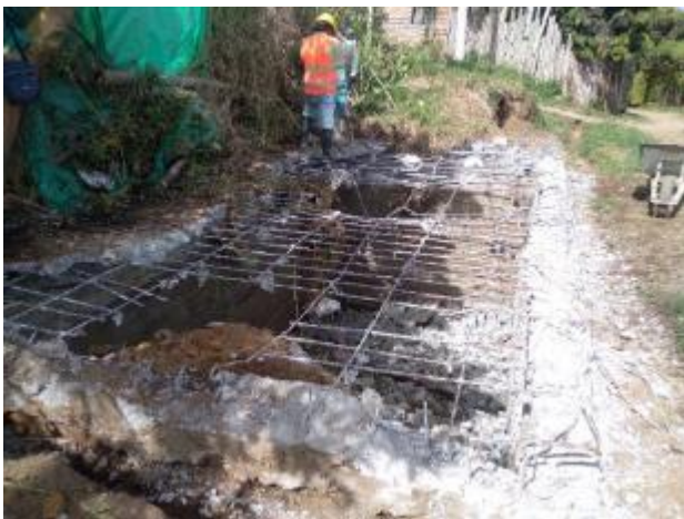
Imagen 147. Demolición con rotomartillo de tanque de pozo séptico. Barrio Villa del Sol.
