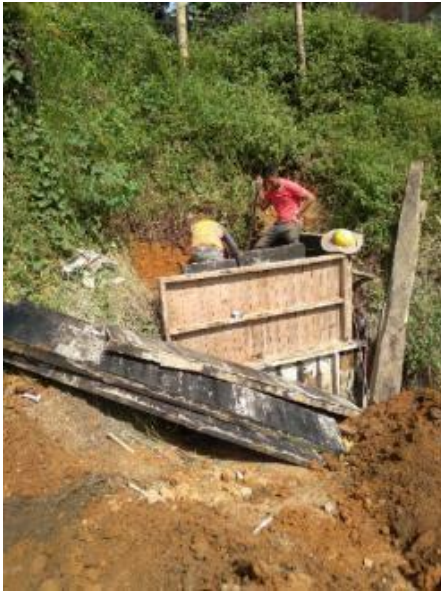
Imagen 65. Retiro de formaletas del cabezal de alcantarilla. Barrio Obrero.
