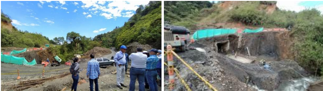
Fotografía 1. Visita a Construcción de Boxcoulvert
