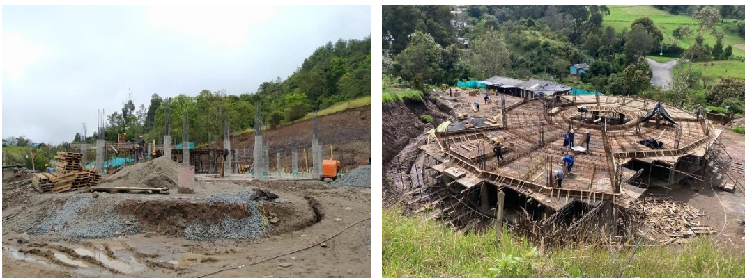
Fotografía 8. Construcción Centro Comunitario
