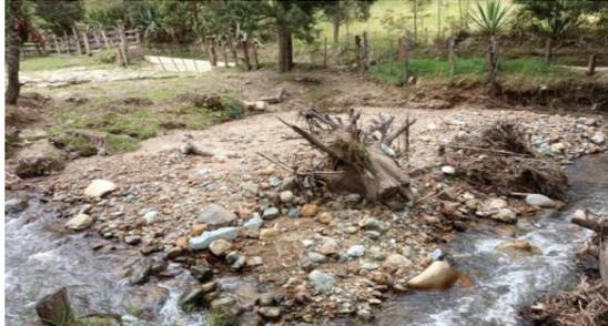
La quebrada Manchay tiene un comportamiento zigzagueante durante todo el recorrido hasta llegar al punto de localización del sector crítico PR1+611 en el margen izquierdo en el sentido de avance del corredor vial. Las laderas del cauce presentan socavación lateral en las patas de los taludes, se evidencia poca vegetación en los mismos.
