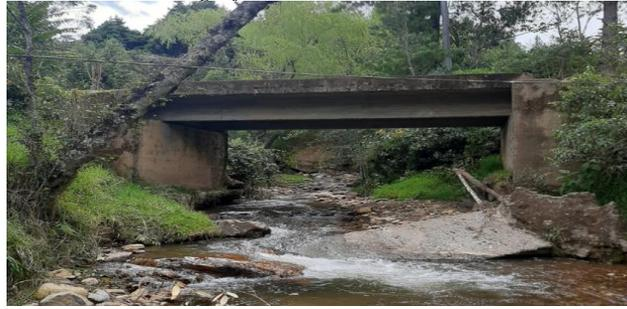
La Fotografía 13 presenta la estructura del puente la cual presenta socavación en el estribo derecho y volcamiento de la aleta izquierda en la estructura de salida.
