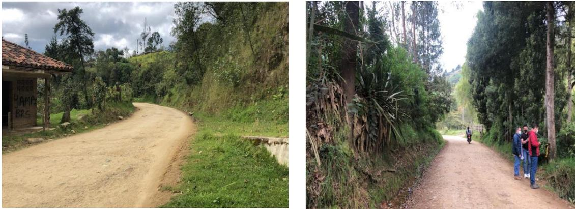
Sin embargo, el ancho de la calzada no es adecuado para el proyecto y existen tramos en los cuales las secciones de las cunetas no se encuentran bien definidas debido al poco mantenimiento preventivo o a la falta del mismo; las cunetas mediante la escorrentía van perdiendo su área hidráulica efectiva por acumulación de material de sedimentación hasta llegar al punto de que se queda sin sección.
