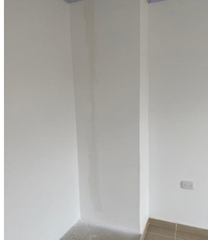
Figura 53: Fisuras en closet reparada (Después)
