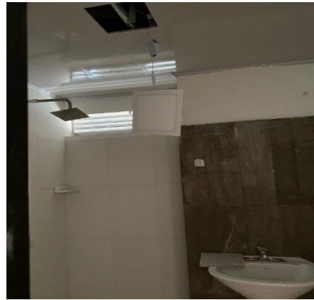
Figura 51: Reparación en baño apto 303 (después)
