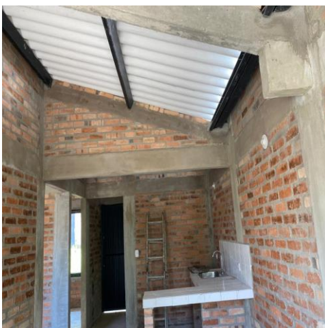
Figura 26: vista interna, cocina, enchapes, lavaplatos
