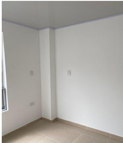
Figura 55: Fisura de columna reparada (después)
