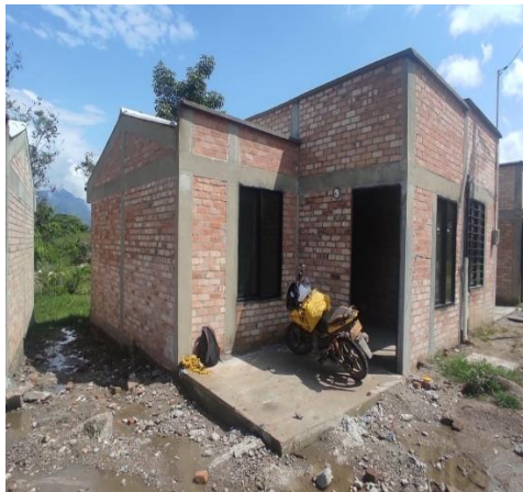
Figura 20: Vista frontal, puertas, ventanas
