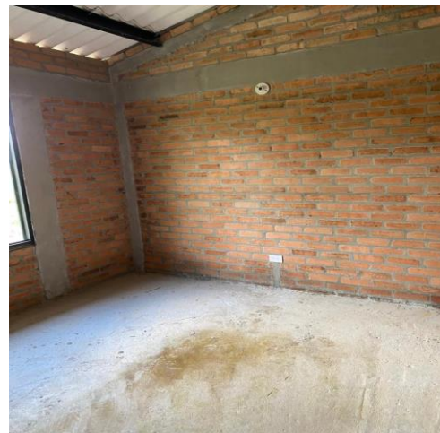
Figura 27: vista interna, cubierta, columnas viga
