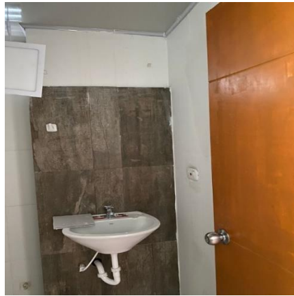
Figura 48: reparación baño apto 20 (después)
