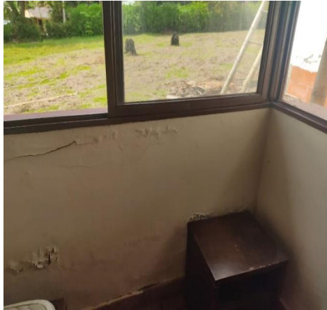
Figura 92: Esquina afectada por humedad
