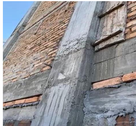
Figura 39, Figura 40: Hiladas de ladrillo en fachadas laterales con falta de mortero de pega
