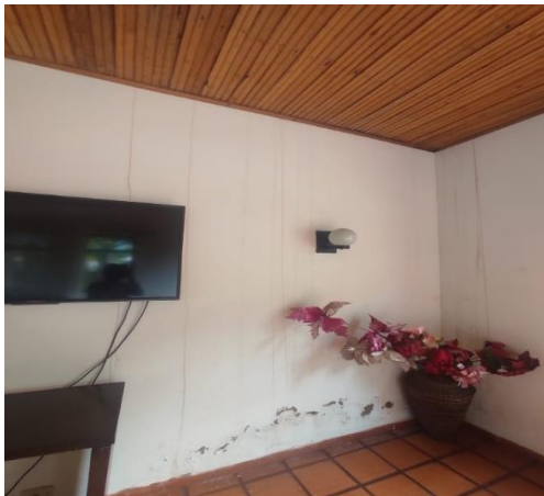
Figura 87: Esquina afectada por humedad
