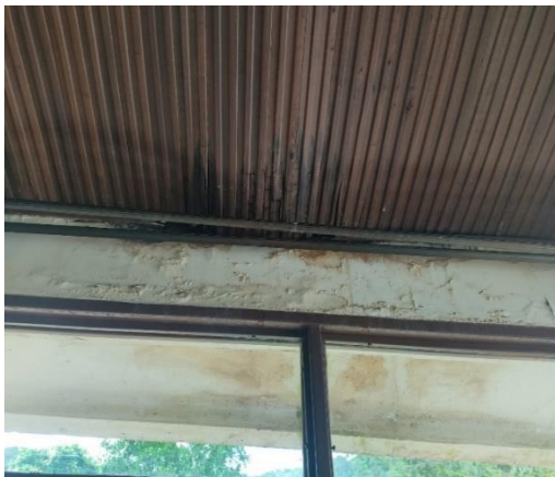
Figura 90: Cielo raso habitación 1
