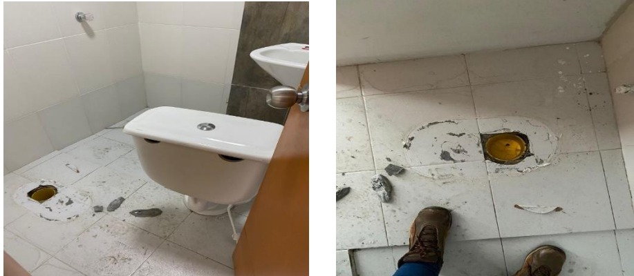
Figura 44, Figura 45: En recorrido evidencia de desmonte de baterías sanitarias apartamentos 203 y 303 para realizar emboquillados y ajuste de tuberías cumpliendo con sugerencias hechas en visita anterior
