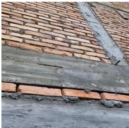
Figura 39, Figura 40: Hiladas de ladrillo en fachadas laterales con falta de mortero de pega
