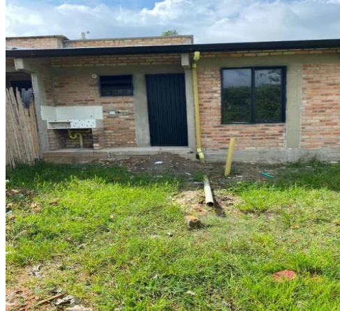
Figura 23: Vista posterior, bajante lavaderos canal
