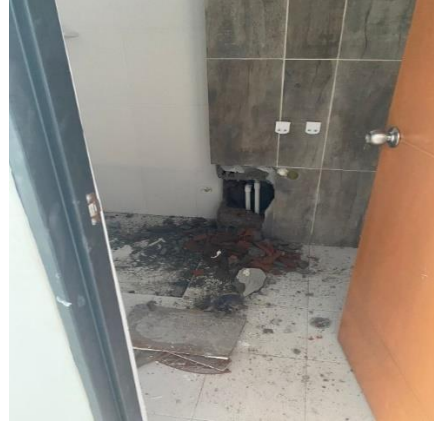
Figura 47: Reparación tubería lavamanos apto 303
