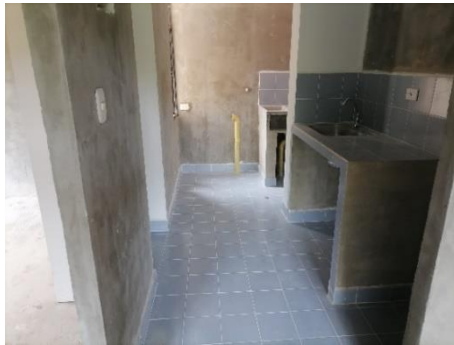
Figura 24. Acabado final Cocina.
