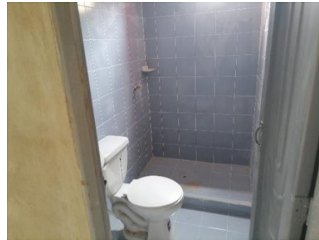
Figura 25. Acabado final Baño.
