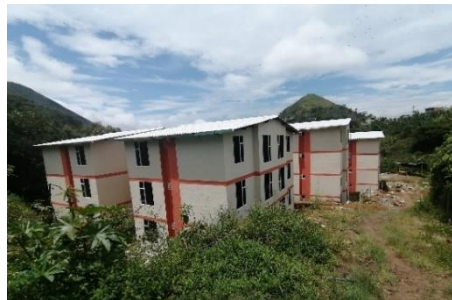
Figura 26. Acabados en Fachada Urbanización (Vinilo y Graniplas).
