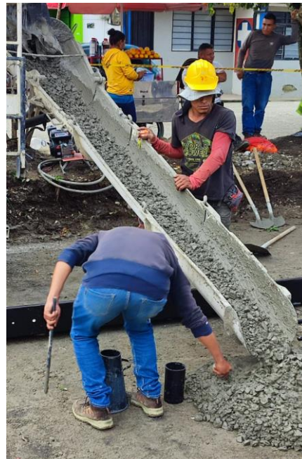
Ilustración 34. Toma de Muestras. Tomada in situ.
