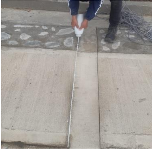
Ilustración 61. Sellado de Juntas. Tomada in situ.
