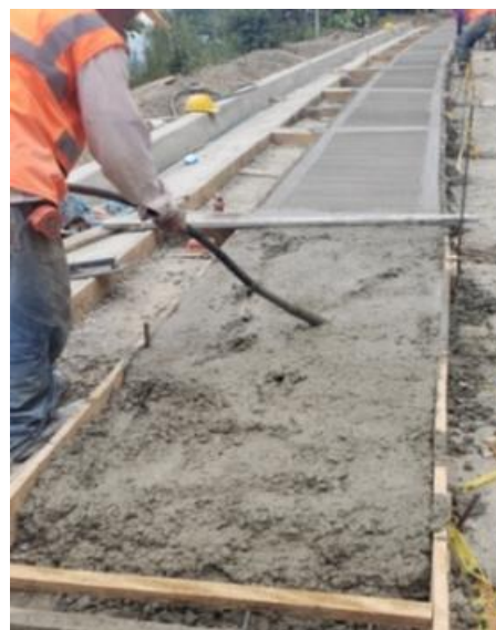
Ilustración 58. Colocación y Vibrado del Concreto. Tomada in situ.
