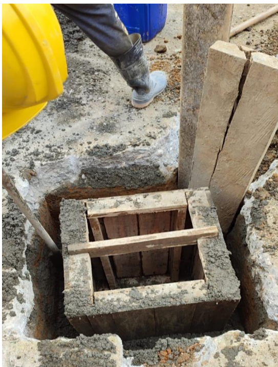
Ilustración 20. Formaleta y Fundición Caja de Inspección. Tomada in situ.
