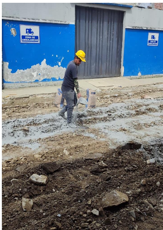
Ilustración 24. Mejoramiento con Cal. Tomada in situ.
