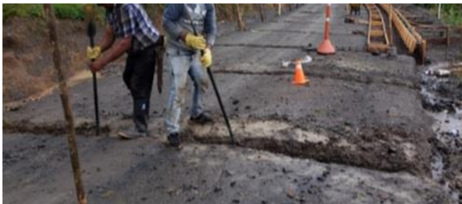
Ilustración 56. Excavación de Vigas Riostras. Tomada in situ.
