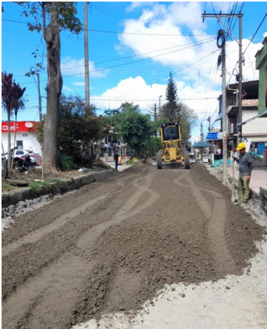
Ilustración 26. Extensión Material de Subbase. Tomada in situ.
