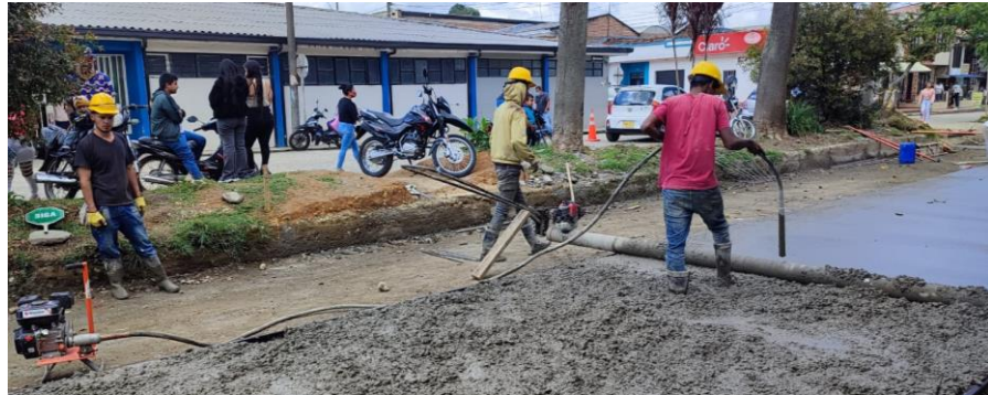
Ilustración 38. Vibrado y Extendido del concreto. Tomada in situ.
