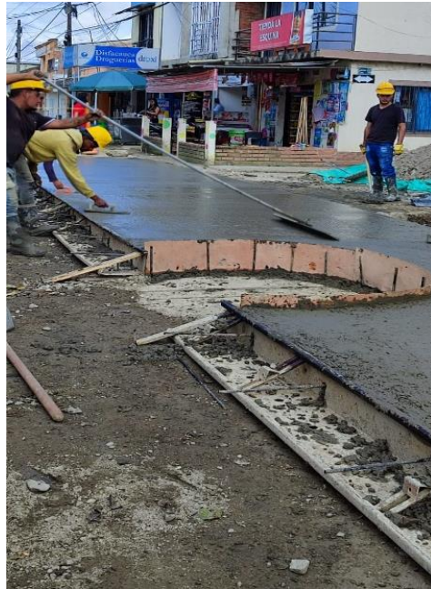
Ilustración 39. Flotado del Concreto. Tomada in situ.
