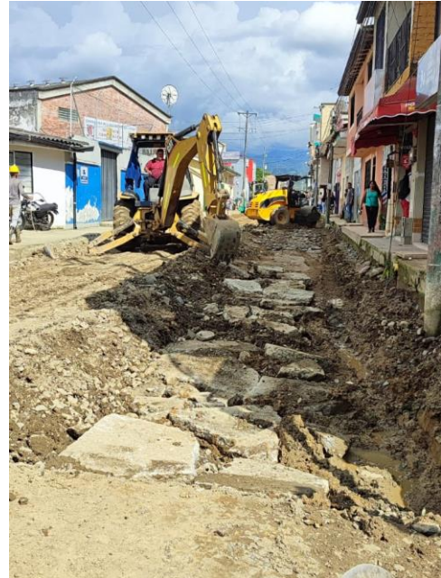
Ilustración 23. Extensión de Material de Mejoramiento Calle 18. Tomada in situ.
