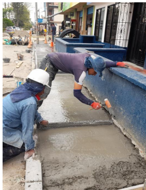
Ilustración 45. Construcción de Andenes. Tomada in situ.
