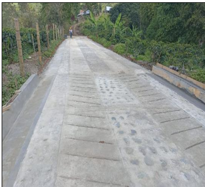
Ilustración 64. Construcción Placa Huella Pastalito. Tomada in situ.
