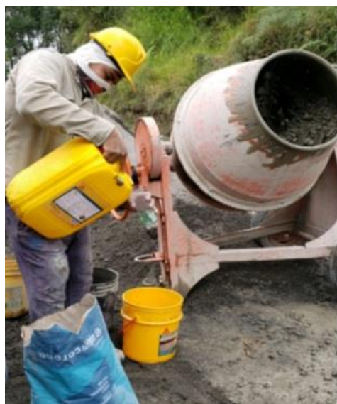
Ilustración 57. Preparación de Mezcla con acelerante Sikaset-L. Tomada in situ.
