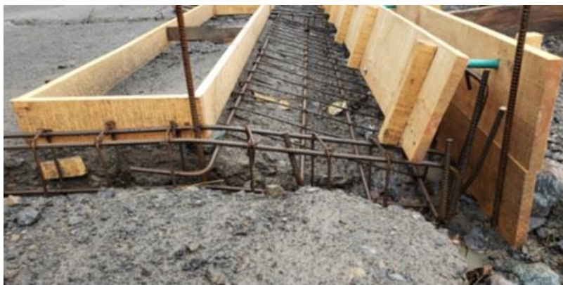
Ilustración 60. Berma, Cuneta y Bordillo. Tomada in situ.
