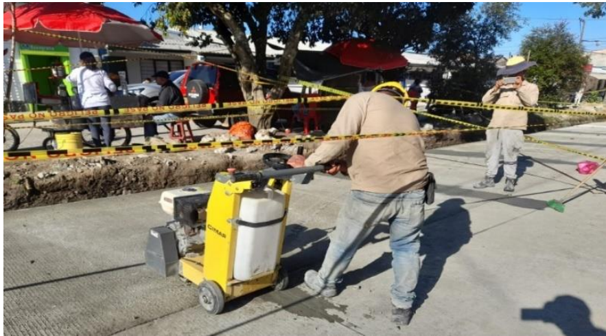
Ilustración 41. Corte de Juntas. Tomada in situ.
