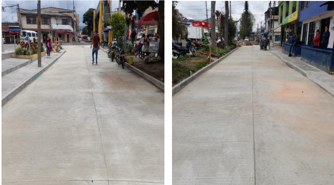
Ilustración 46. Losa de Concreto Hidráulico Calle 19. Tomada in situ.
