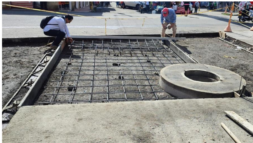
Ilustración 37. Refuerzo de Losas. Tomada in situ.
