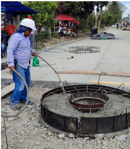
Ilustración 42. Construcción de Brocales. Tomada in situ.
