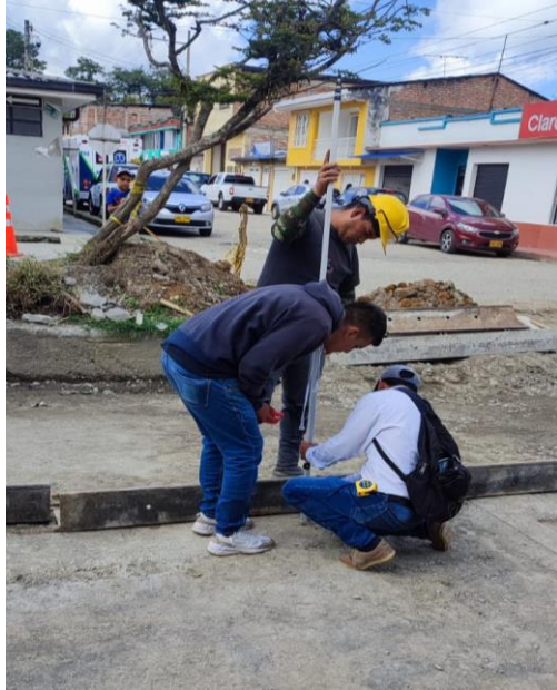
Ilustración 30. Ubicación de la Formaleta. Tomada in situ.
