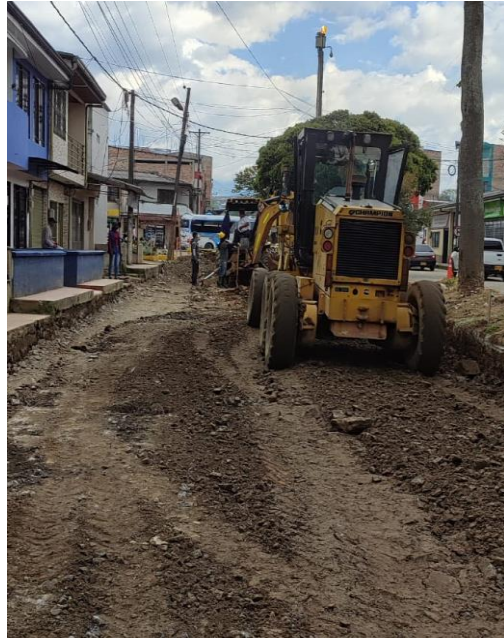
Ilustración 22. Extensión de Material de Mejoramiento Calle 19. Tomada in situ
