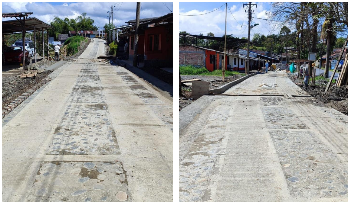
Ilustración 63. Construcción Placa Huella Las Cruces. Tomada in situ.
