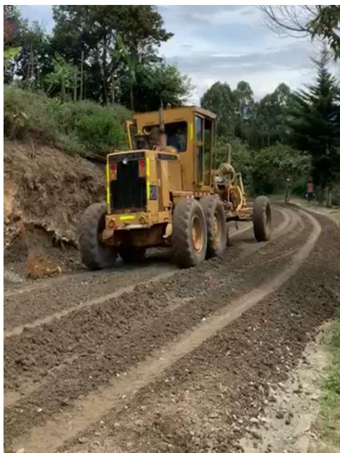
Ilustración 52. Extendido de Subbase. Tomada in situ.
