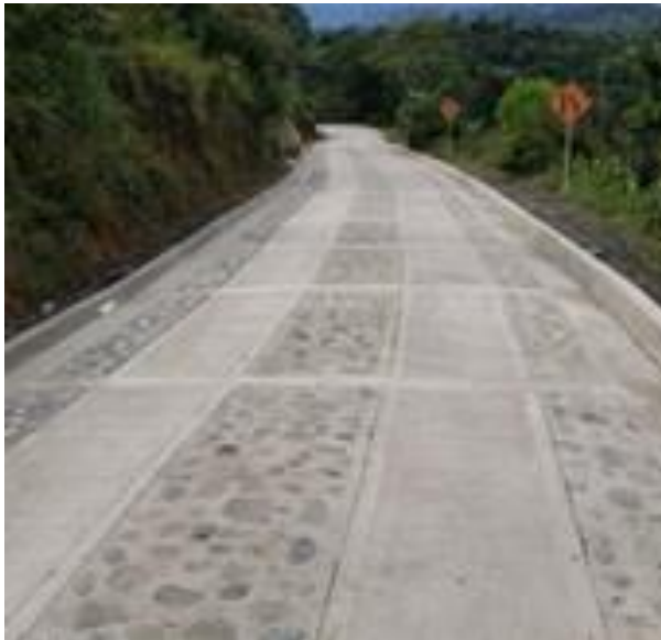
Ilustración 62. Detalle Placa Huella Terminada. Tomada in situ.
