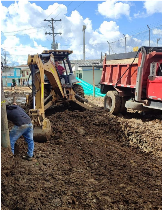
Ilustración 18. Excavación Calle 18. Tomada in situ.
