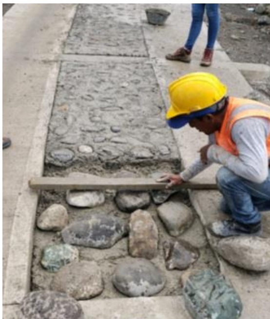
Ilustración 59. Colocación Concreto Ciclópeo. Tomada in situ
