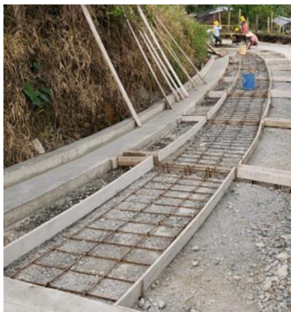
Ilustración 54. Colocación de Formaleta. Tomada in situ.
