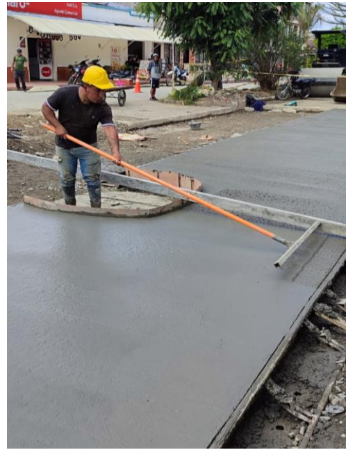
Ilustración 40. Macrotexturizado del Concreto. Tomada in situ.
