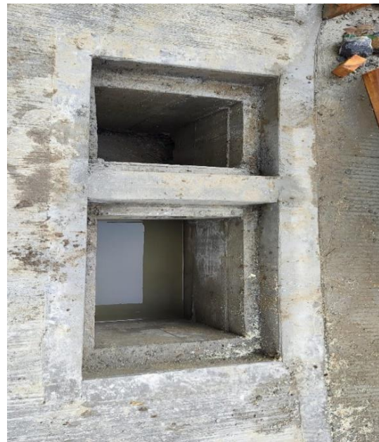
Ilustración 43. Construcción Sumideros. Tomada in situ.
