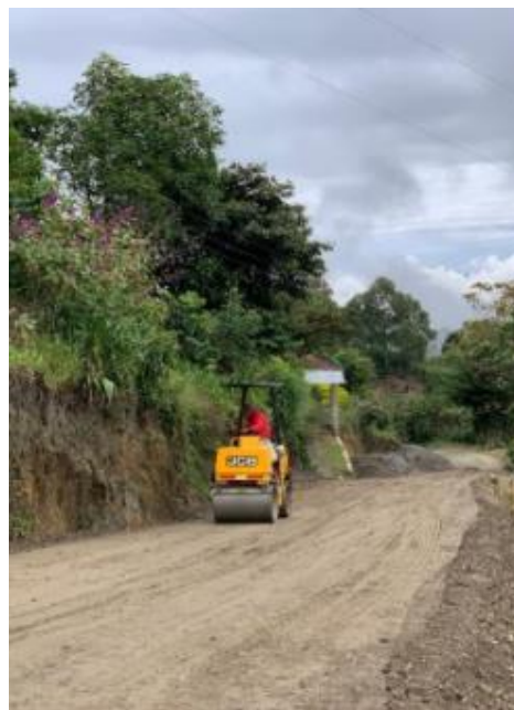
Ilustración 53. Compactación de Subbase. Tomada in situ
