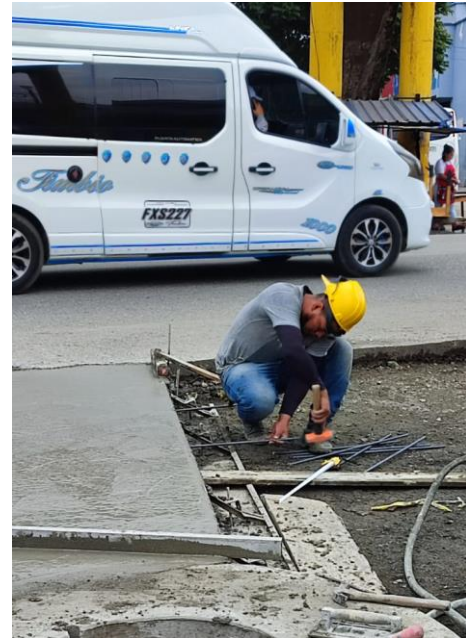
Ilustración 36. Colocación de las Barras de Amarre. Tomada in situ.
