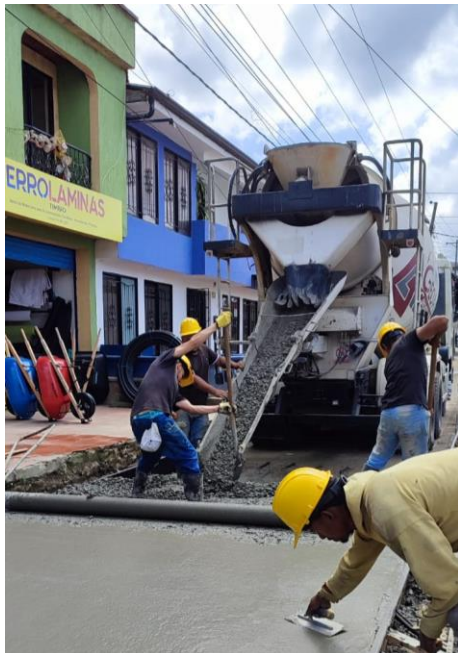
Ilustración 33. Vaciado del Concreto. Tomada in situ.
