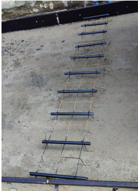
Ilustración 35. Ubicación de Pasajuntas en Canastillas. Tomada in situ.
