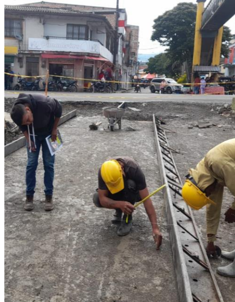
Ilustración 31. Formaleta Fija en Acero. Tomada in situ.
