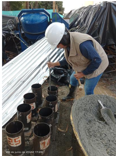
Ilustración 82 Toma de muestras para ensayo de resistencia de concreto 55
