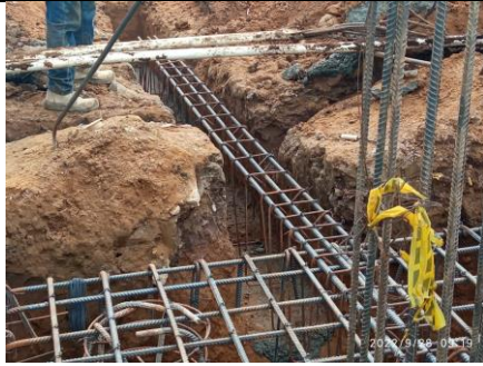
Ilustración 72 Amarre de acero en vigas
