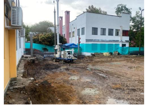
Ilustración 55 Piloteadora en funcionamiento
