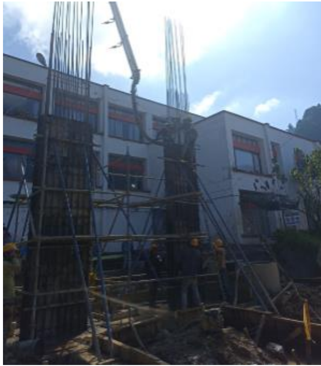
Ilustración 89 Fundición columnas 62
