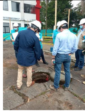
Ilustración 45 Identificación de alcantarillado
