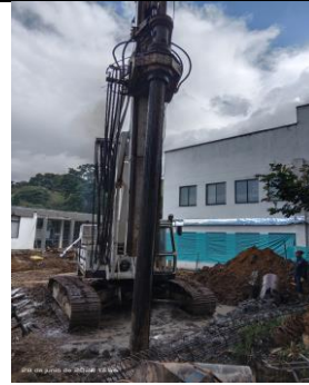
Ilustración 61 Piloteadora en funcionamiento
