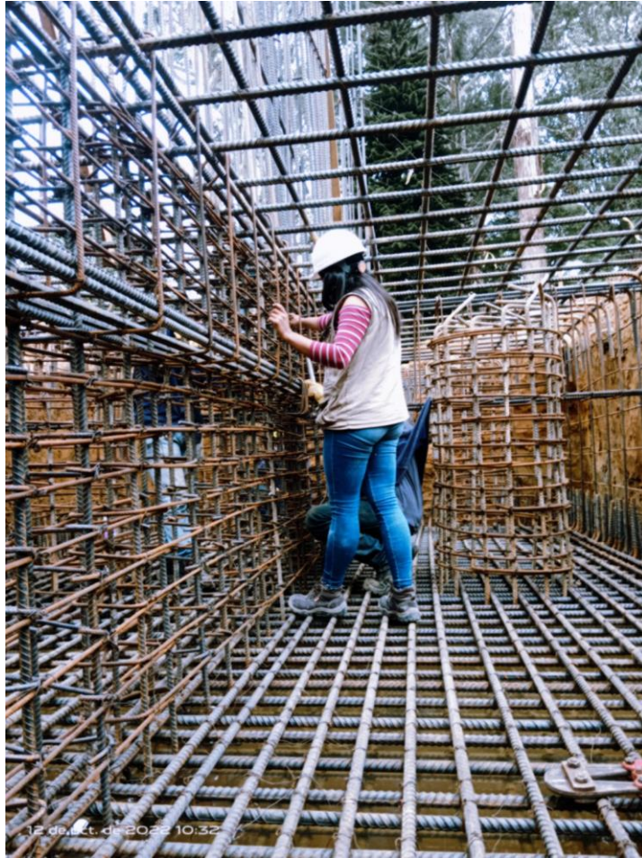
Ilustración 86 Supervisión de cantidad de aceros en dado de cimentación 59
