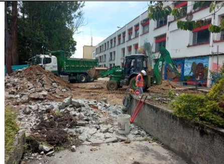
Ilustración 51 Cargue de demolición
