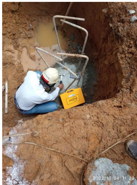
Ilustración 81 Ensayo integridad de pilotes 54
