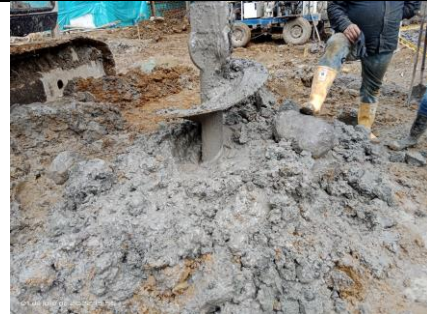
Ilustración 65 Material excavación de pilotes
