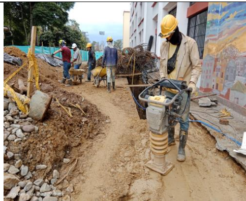
Ilustración 66 Compactación alcantarillado
