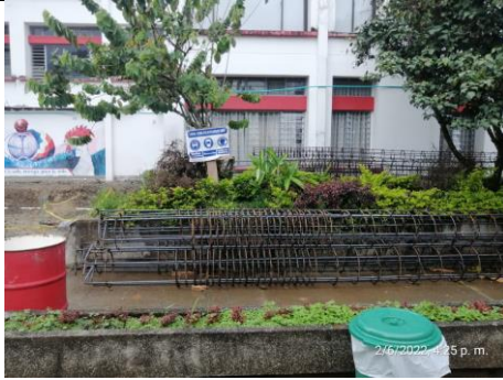
Ilustración 56 Canastas de acero para pilotes
