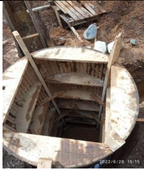
Ilustración 60 Reubicación cámaras de alcantarillado
