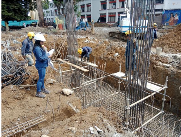
Ilustración 87 Supervisión de cantidad de aceros en dado de cimentación 60
