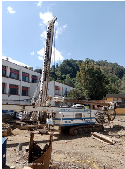
Ilustración 37 Piloteadora final del proyecto 45
