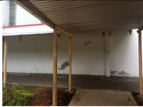
Ilustración 53 Construcción de corredores posgrados
