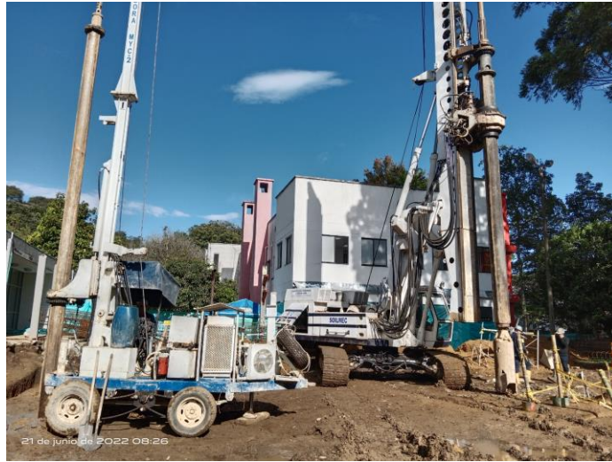
Ilustración 36 Piloteadoras inicio del proyecto 44
