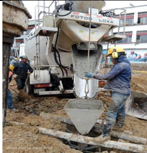
Ilustración 64 Fundición de pilotes
