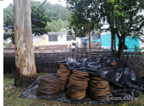
Ilustración 57 Estribos para pilotes
