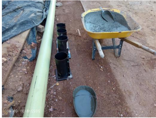
Ilustración 83 Toma de muestras para el ensayo de concreto 56
