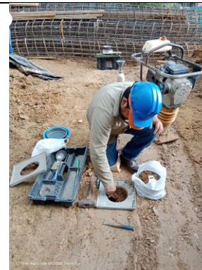
Ilustración 67 Ensayos de compactación
