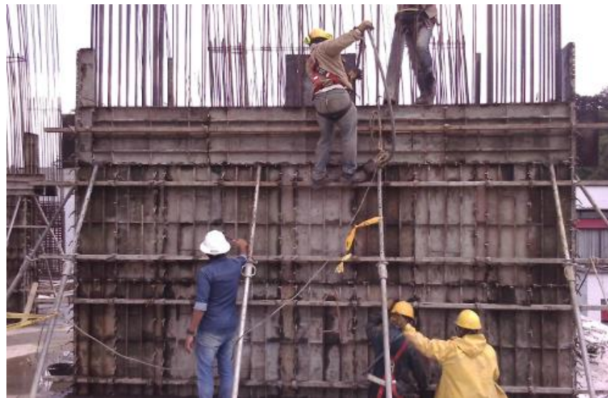
Ilustración 90 Fundición de pantalla 63
