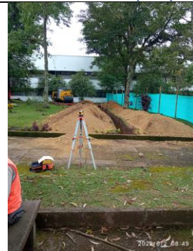
Ilustración 59 Excavación nueva red de alcantarillado
