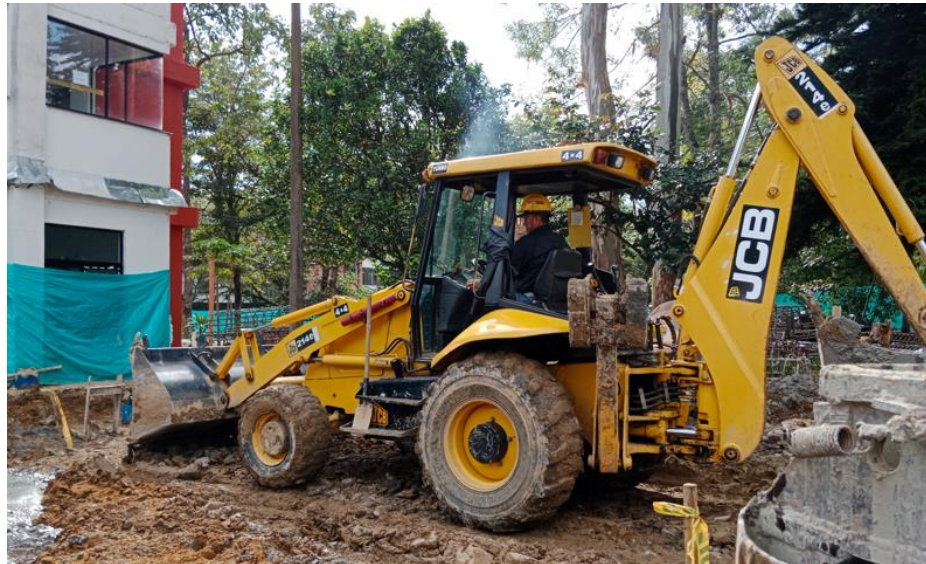
Ilustración 76 Retroexcavadora en funcionamiento 49
