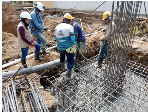
Ilustración 88 Supervisión de correcta fundición 61
