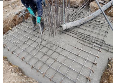
Ilustración 73 Fundición de dados
