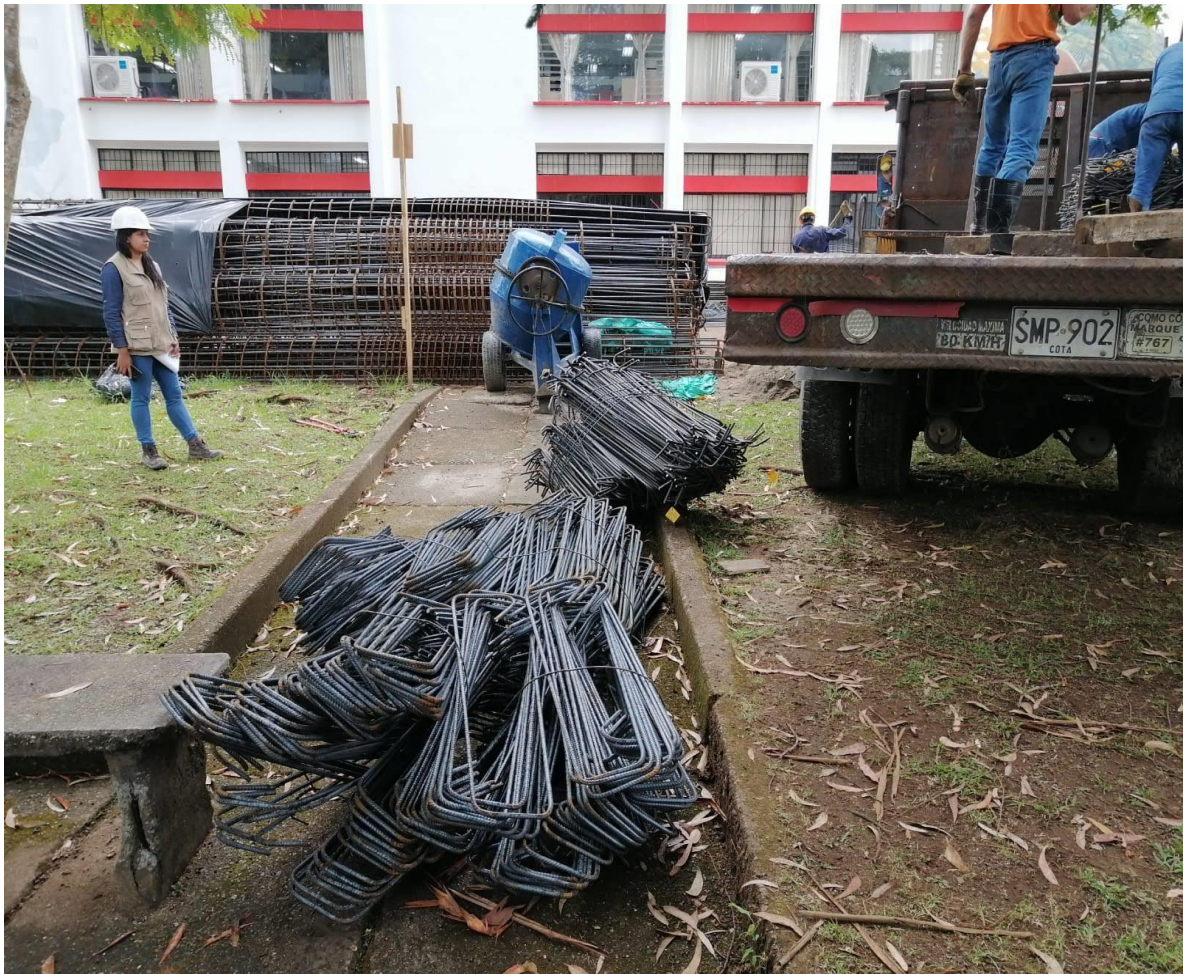
Ilustración 92 Supervisión descargue de materiales en obra 65
