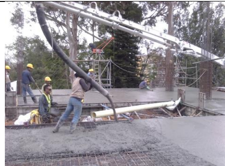
Ilustración 75 Fundición de losa
