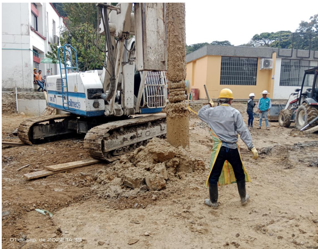
Ilustración 85 Piloteadora con presencia de suelo limoso 58
