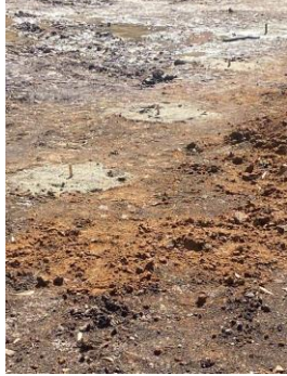
Ilustración 54 Realización de pre huecos para pilotes
