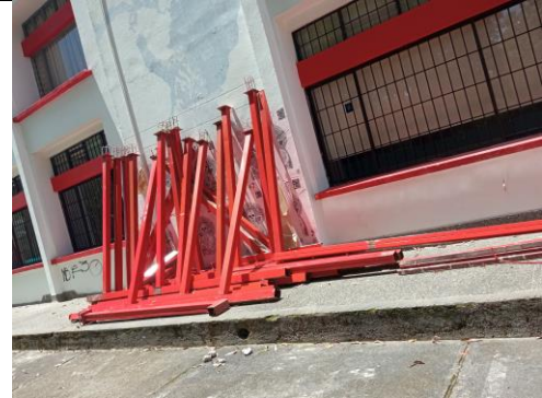
Ilustración 47 Desmonte estructura metálica
