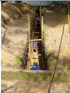
Ilustración 58 Excavación nueva red de alcantarillado
