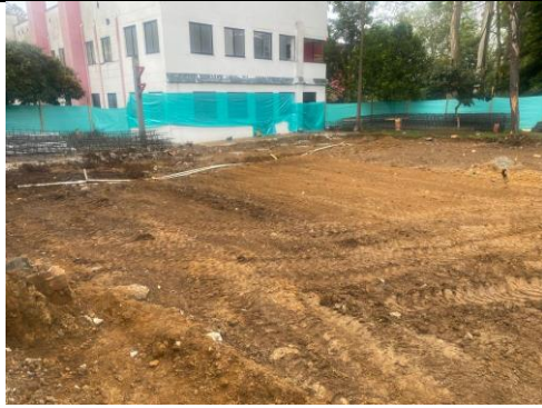
Ilustración 52 Descapote de terreno
