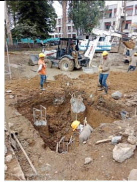
Ilustración 69 Excavación de dados de cimentación
