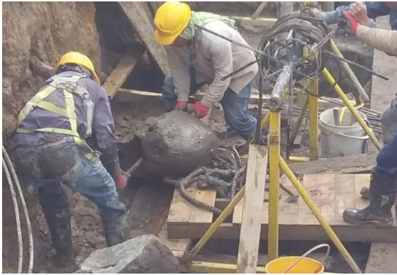
Imagen 90: Extracción manual con mallas en soga.
