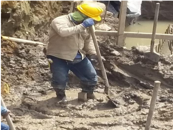
Imagen 13: Delimitación del caisson en el terreno. Caisson de diámetro 1.20 m, excavación diámetro 1.40m.
