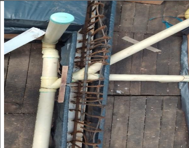
Imagen 86: Refuerzo en pases de tubería sanitaria.
