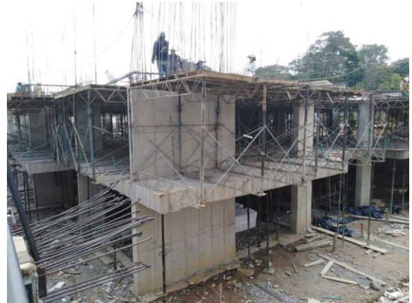
Imagen 6: Se da inicio al armado de columnas, pantallas, vigas.
