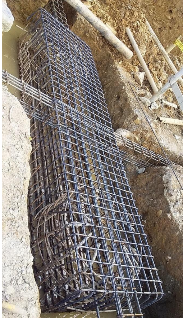
Imagen 59: Se define el paso de los aceros de la viga de cimentación de 0.30 m*0.40 m, para cumplir con el nivel del acero de la parrilla superior del cabezal.
