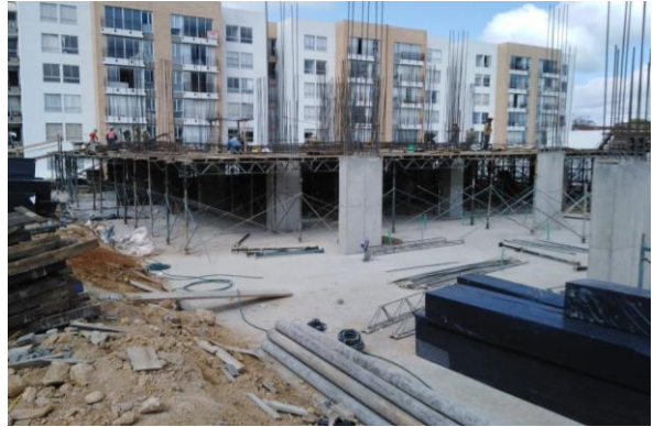
Imagen 4: N+5.95m, segundo piso de apartamentos se inicia entarimado.
