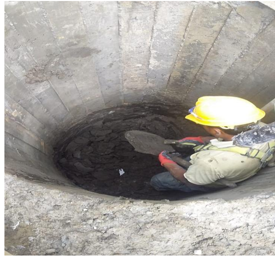
Imagen 16: Excavación manual segura por revestimiento en Concreto, se utilizan palas, picas y barras.
