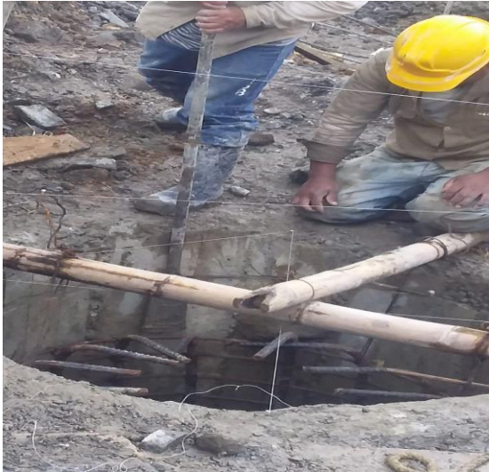
Imagen 42: Se replantean ejes y niveles.
