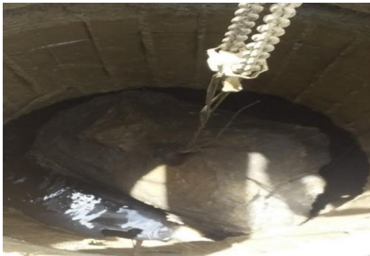
Imagen 92: Extracción manual, las rocas son perforadas con un martillo perforador y ancladas para ser retiradas por fragmentos.
