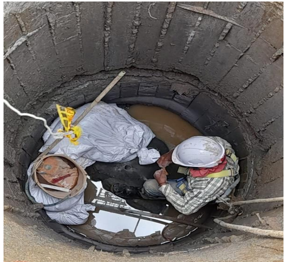
Imagen 106: 2. Roca perforada previamente, se instala el "Indugel" AV 800 y se tapa totalmente la roca con sacos de arena para reducir el impacto.
