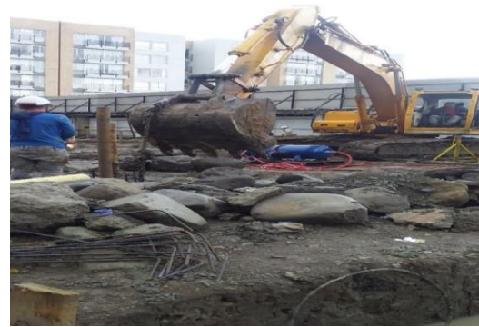
Imagen 91: Rocas extraídas manualmente que después son retiradas con la retroexcavadora.
