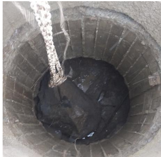
Imagen 110: 7. Se retira la roca fracturada con el diferencial.
