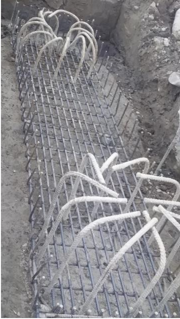
Imagen 58: Parrilla inferior para cabezal, aceros limpios libres de residuos de concreto.
