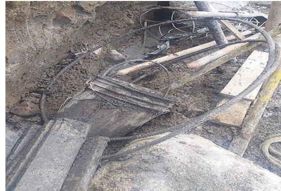
Imagen 12: Materiales para realizar la formaleta de construcción del anillo en concreto: madera, amarras, estribo circular #4 y Ccto de 2500 Psi.
