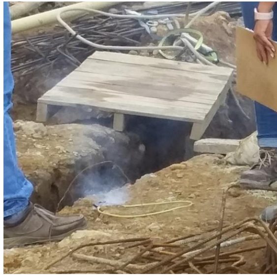
Imagen 108: 5. Se enciende la mecha de seguridad a una distancia segura.
