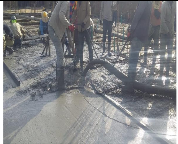
Imagen 87: Un buen tallado es fundamental durante la fundición.
