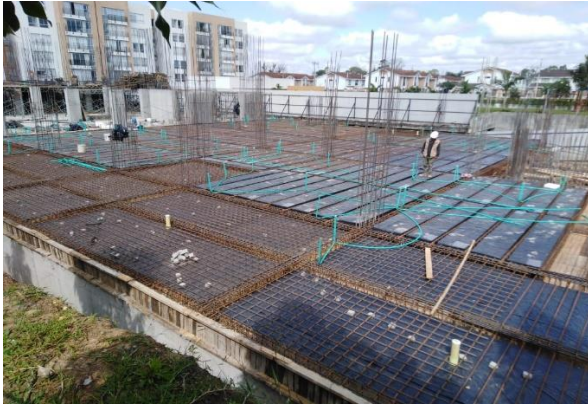
Imagen 3: N+3.10m, losa aligerada con casetones de icopor. Primer piso de apartamentos.
