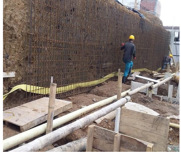
Imagen 68: Eje A. Muro de contención, Cinta Sika PVC
