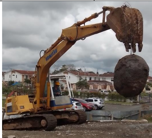
Imagen 100: Retroexcavadora se utilizó para extraer una de las rocas más grandes en la obra, la cual no fue soportada por el diferencial por lo que se presume un peso mayor a 5 Toneladas.
