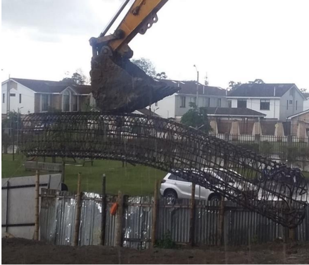
Imagen 39: Caisson L = 7.0 , masa de 542.9 kilos/m, 0.54 Ton.
