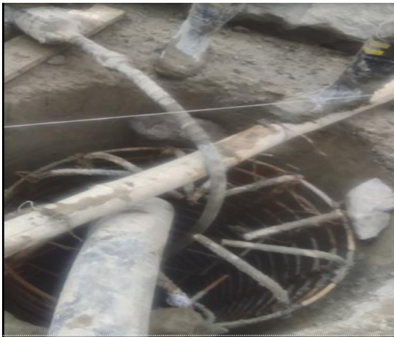
Imagen 44: Vibrado y vaciado del concreto 3000 Psi.
