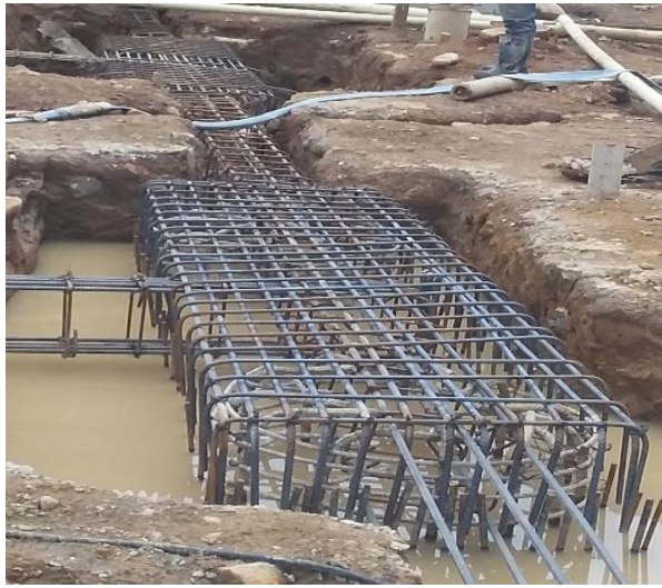
Imagen 54: Cabezal o dado tipo 2a
