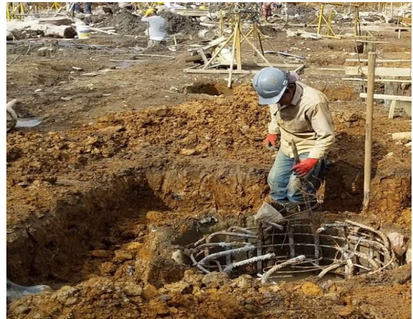
Imagen 51: Cabezal tipo 4 de 1.30 mx1.30 m.
