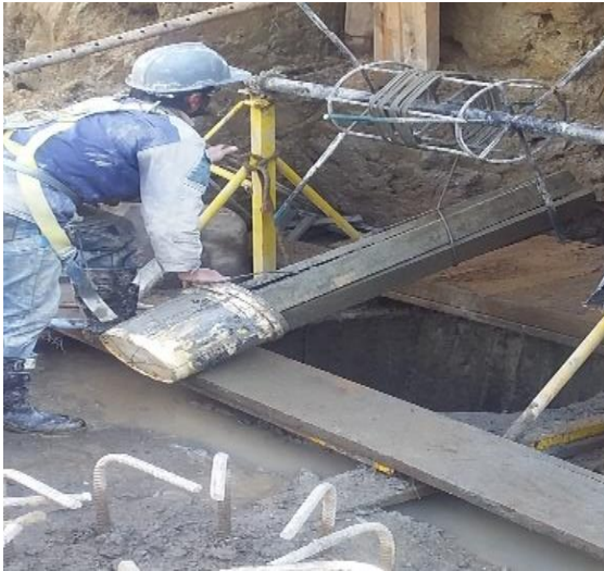
Imagen 15: Los materiales descargados son asegurados para evitar accidentes con el trabajador que recibe.
