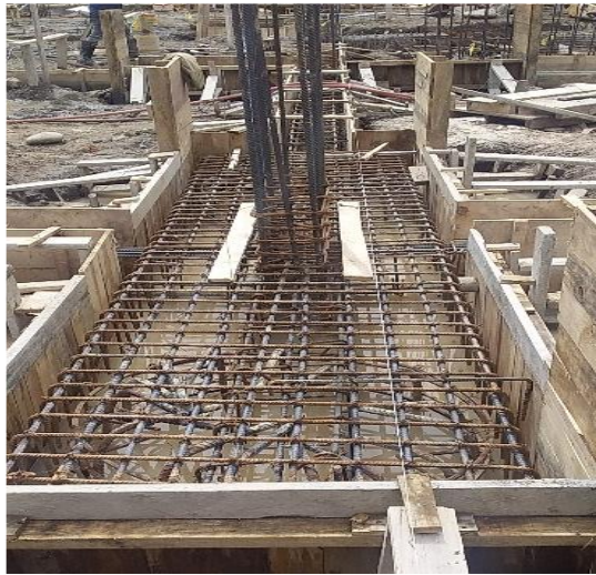
Imagen 70: Encofrado de cabezal
