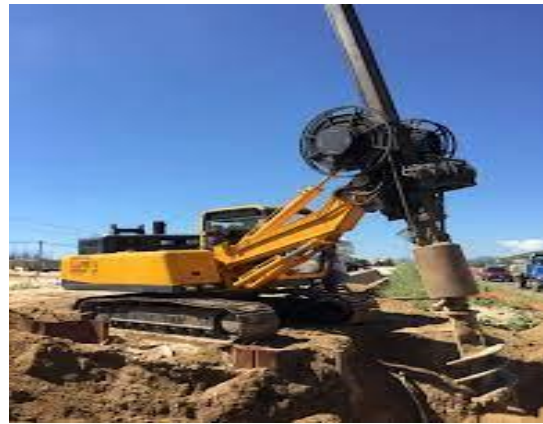
Imagen 99: Piloteadoras de rotación.
