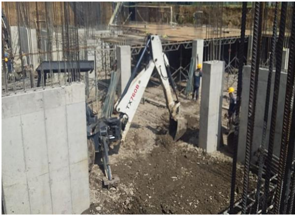
Imagen 72: Se reemplaza el suelo natural por roca muerta.
