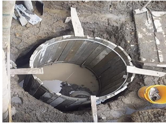
Imagen 14: Armado del Primer anillo formaleta conformada por estribo circular sobre el cual se apoyan las maderas para realizar un revestimiento en concreto de 0.10m en las paredes del caisson.
