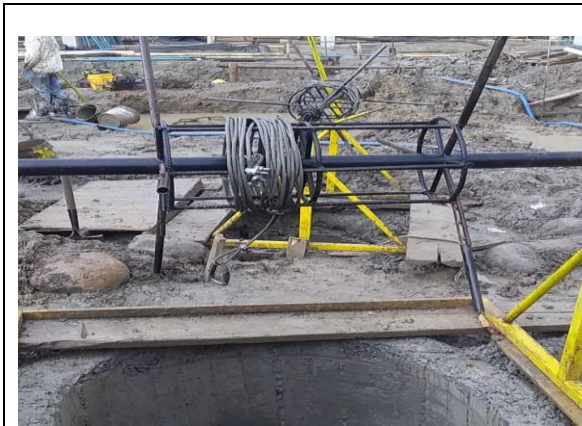
Imagen 11: Equipo de trabajo para realizar la excavación: Molinete gira un rollo de guaya de 3/8", balde de retiro de material excavado, pala, pica, martillo demolidor.
