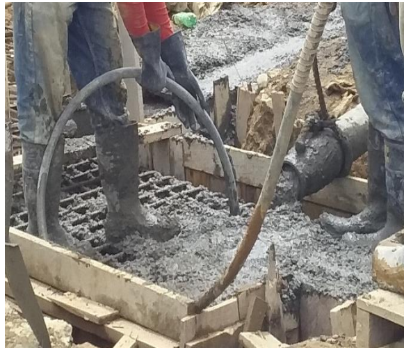
Imagen 71: Vibrado espaciado cada 0.30m aprox.
