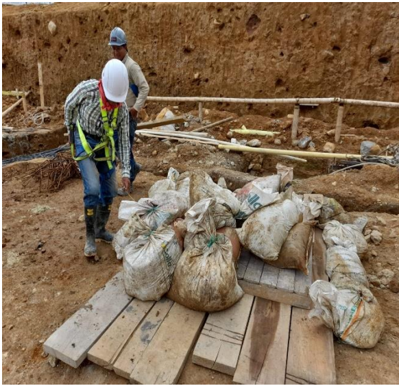
Imagen 107: 4. A nivel de la superficie también se cubre totalmente con sacos de arena.
