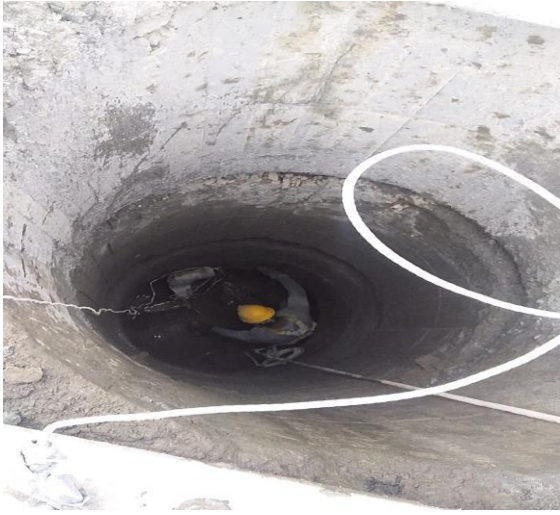
Imagen 20: tercer anillo, profundidad aprox. 4.90m. se verifica que las rocas no interfieran con el caisson.
