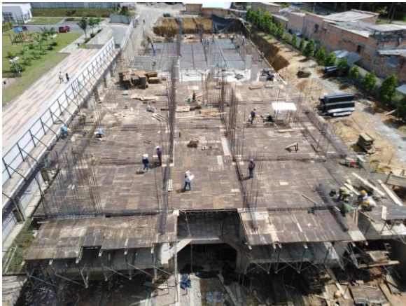
Imagen 5: N+5.95m, entarimado, nivelación, replanteo de ejes y cimbrado, losa tipo.
