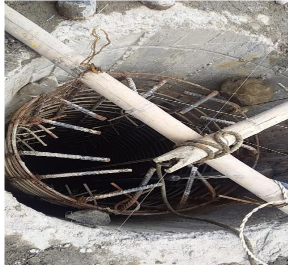
Imagen 43: Debe quedar centrado según los ejes de referencia.
