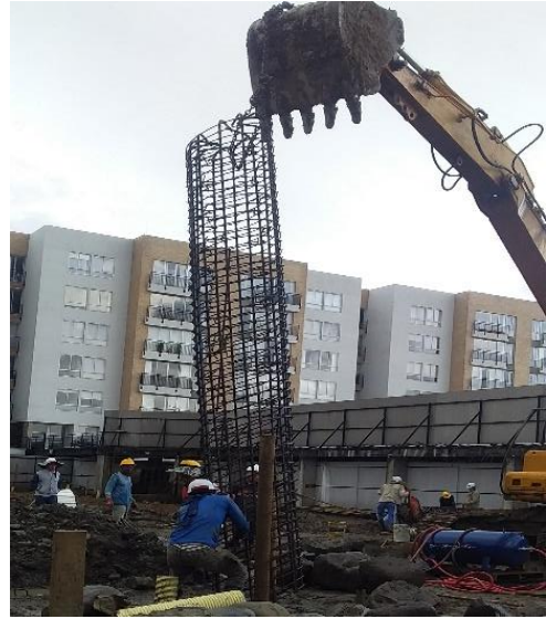
Imagen 40; Izada del castillo mecánicamente
