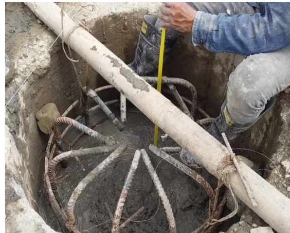
Imagen 45: Se pasa niveles y se determina el nivel de fundición del concreto.
