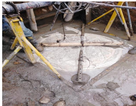
Imagen 47: Caso particular después de la fundición por Nivel freático alto. Para estos se utilizó concreto “tremí”.
