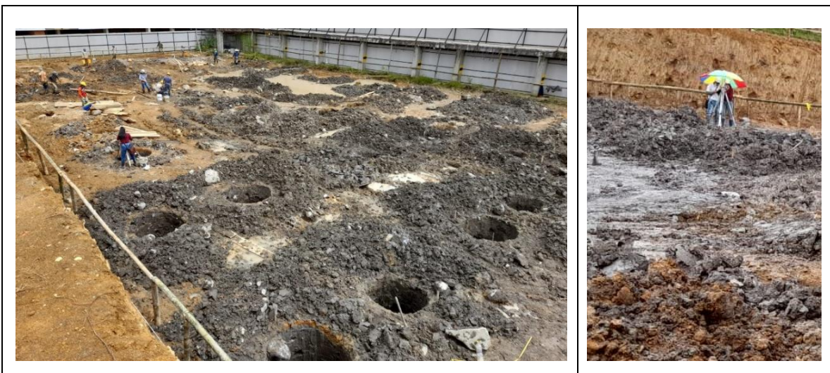
Imagen 9 y 10: Topografía, localización y replanteo de ejes, se realiza ejecución simultanea de los caisson por recomendación del Ing. Geotecnista.
