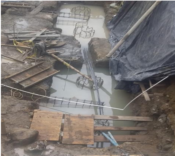
Imagen 61: Eje 2. Desplazamiento de dos caisson 113 y 116.
