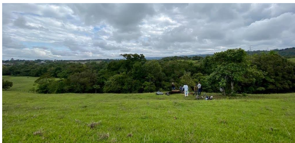
Figura 22. Equipo de excavación y vista del corte en el lote 19.
