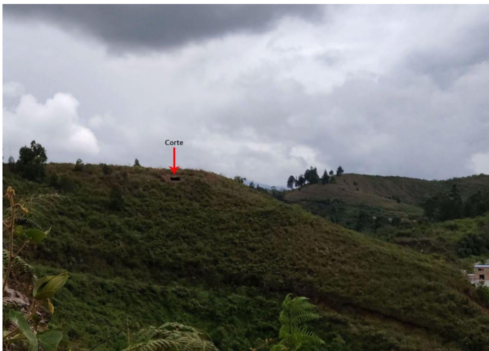
Figura 43. Panorámica de la ubicación del corte en la zona 1, Loma el Broncazo.
