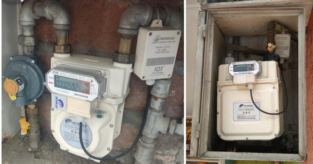
**Figura 26.** Instalaciones de medidores equipados con módulo de comunicación Sigfox. (A) Medidor modelo G4. (B) Medidor modelo G6. Fuente propia.
