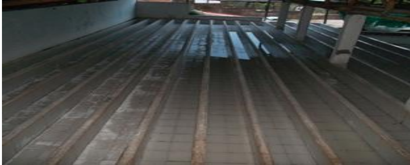
Imagen 17 Canales de Sedimentación de Almidón Agrio de Yuca
