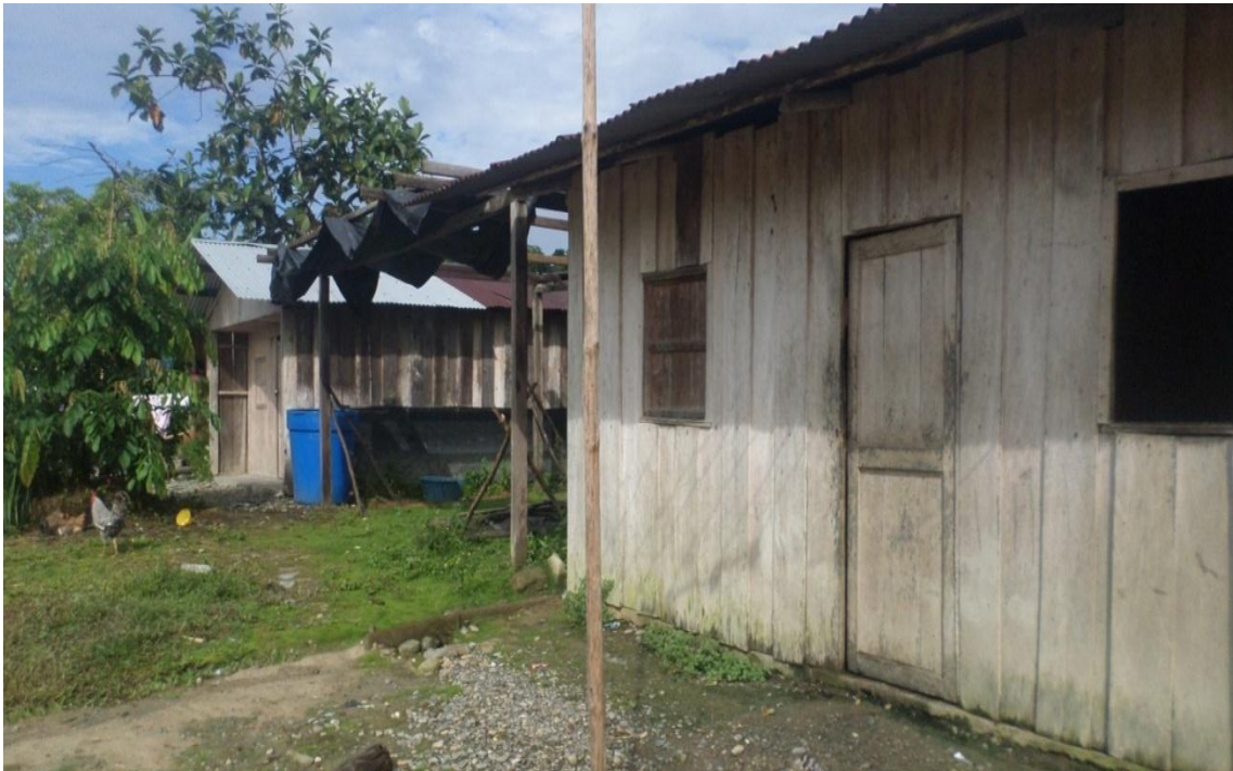
Foto19. Sistema de recolección de aguas lluvias. Fotografía: Sury Riascos y Martha rivera, 2013.
