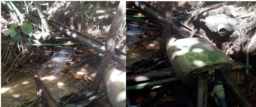
Figura: Adecuación y toma de agua del nacimiento de agua donde Doña Nidia para llevar agua a la casa de Doña Diomira (Shiomara Zuñiga, 2022)
