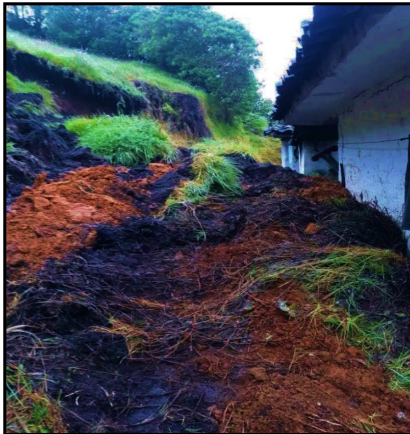
Imagen 3: Vivienda de la familia Yalanda afectada por derrumbe. Fuente: https://www.facebook.com/CaciqueMisak/photos (2022).
