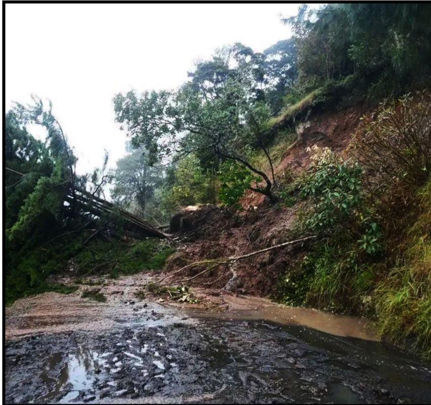
Imagen 6: Vía afectada por deslizamiento con flujo de tierra, sector Canteros.
