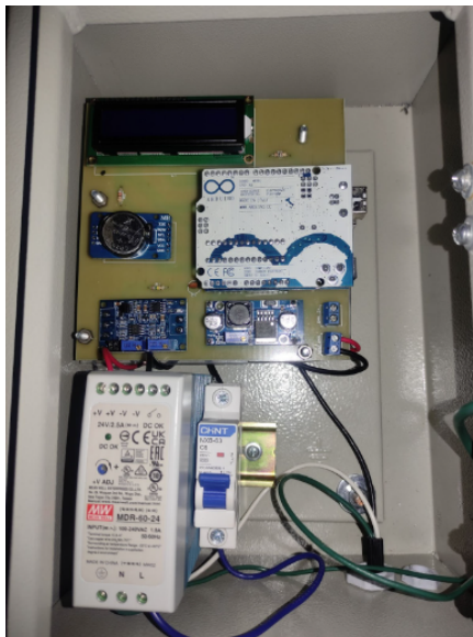
Figura 4.16: Montaje completo Elaboración propia.
