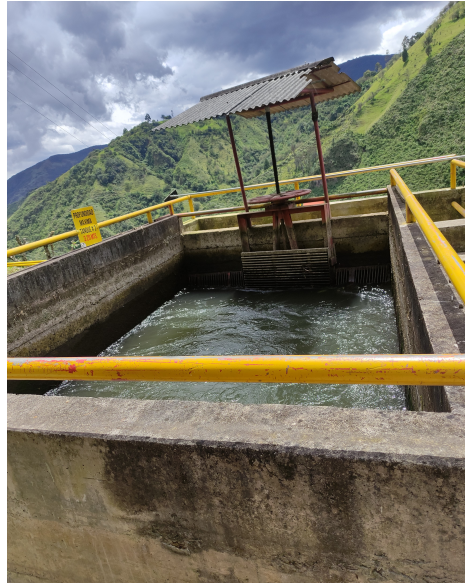
Figura 4.2: Tanque de carga Elaboración propia.
