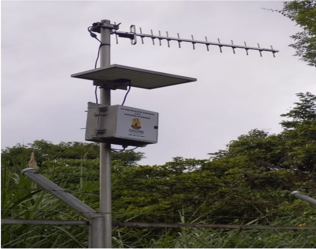
Figura E.2: Antena repetidora malla. Fuente: Elaboración propia.
