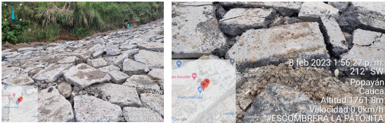
Ilustración 9. Material RCD – Escombrera
