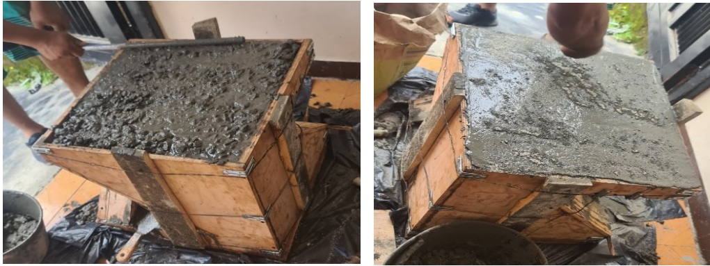
Figura 19. Fundición de losa superior y aplacado
