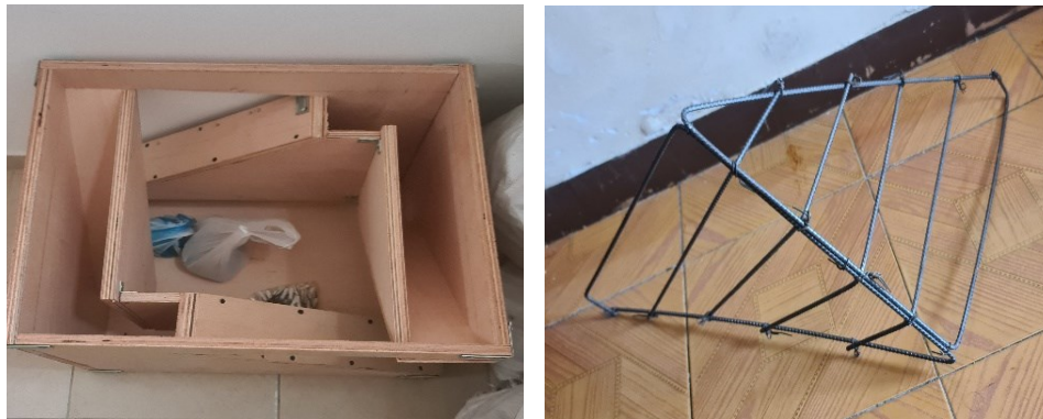
Figura 13. Armado provisional de la formaleta y flejado de varillas laterales.
