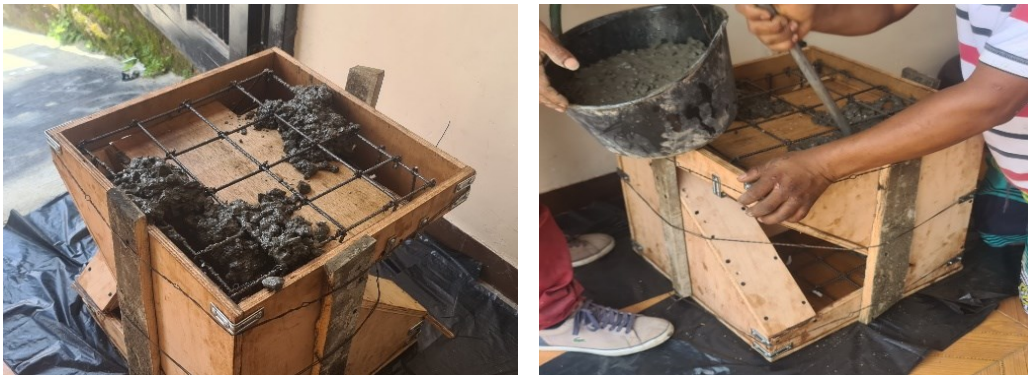
Figura 18. Vertimiento de la mezcla de concreto y vibrado manual
