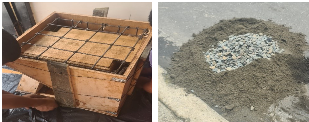
Figura 16. Refuerzo exterior de formaleta y mezcla de agregados
