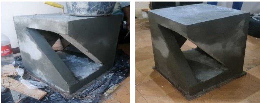
Figura 20. Desenfrado de Formaleta y aplacado de caras
