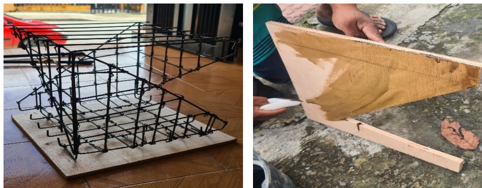
Figura 14. Armado de parrilla inferior, laterales y aplicación de desmoldante.
