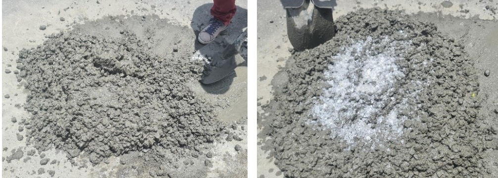
Figura 17. Adición de agua y PET a la mezcla de agregados
