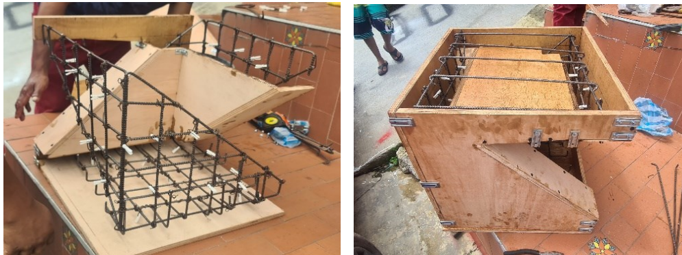
Figura 15. Colocación de distanciadores y Platinas
