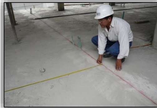
Ilustración N° 110. Demarcación con Cimbra.
