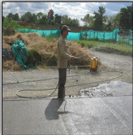
Ilustración N° 53. Curado Húmedo.
