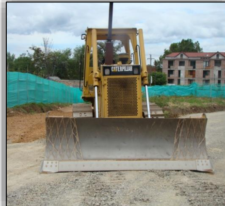
Ilustración N° 13. Extensión del material de Subrasante con Bulldozer D 6 D.
