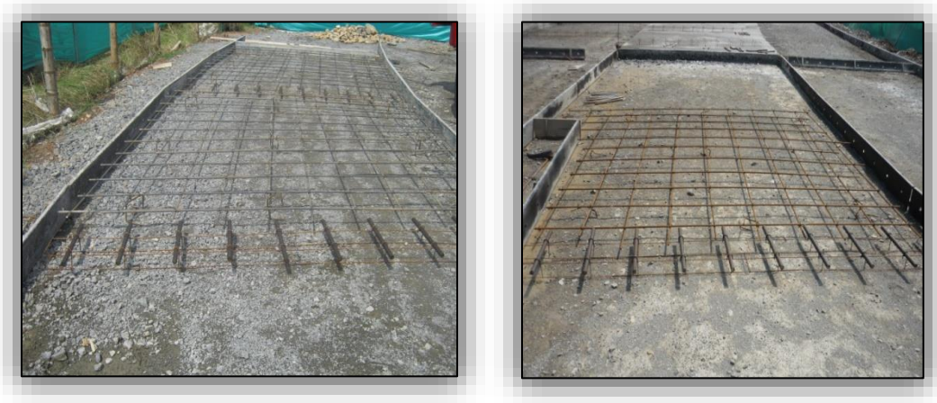
Ilustración N° 36. Colocación del refuerzo de las Losas.
