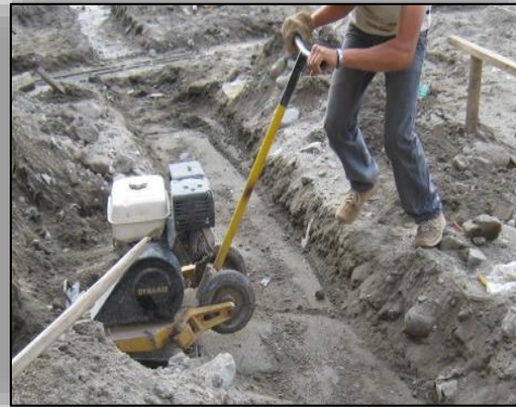
Ilustración N° 79. Compactación del soporte de la Vigas y Zapatas.
