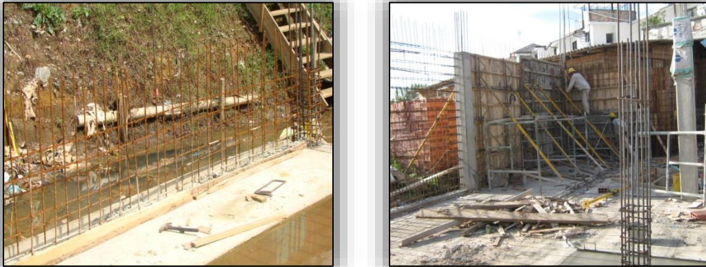
Ilustración N° 86. Adecuación del Collarín y de la Formaleta.
