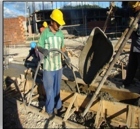
Ilustración N° 88. Vaciado y Vibrado interno del Concreto.
