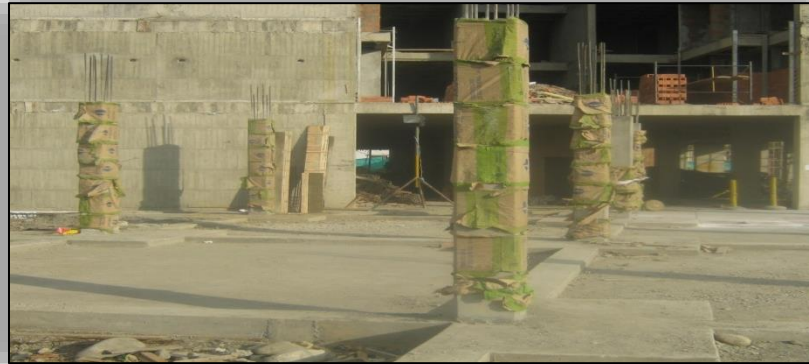
Ilustración N° 101. Curado de columnas.
