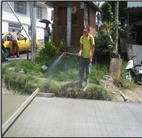
Ilustración N° 52. Curado Químico.
