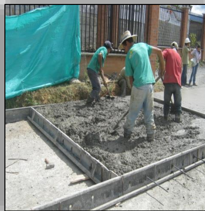
Ilustración N° 42. Distribución del Concreto.
