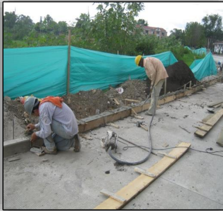
Ilustración N° 60. Vibrado del Concreto del Sardinel.
