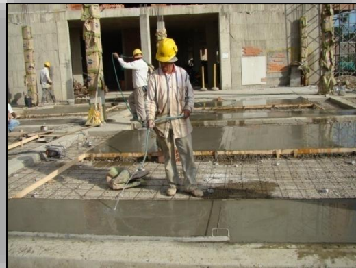
Ilustración N° 102. Curado del Concreto del Parqueadero.
