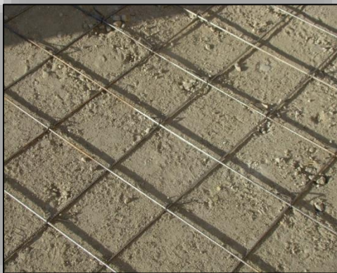
Ilustración N° 95. Malla de Refuerzo de las Losas.
