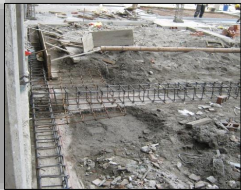
Ilustración N° 80. Adecuación del Solado de limpieza y de los castillos de las Vigas.
