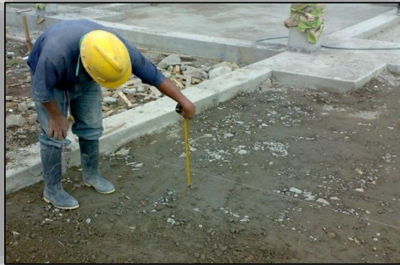
Ilustración N° 94. Verificación del espesor de las Losas.
