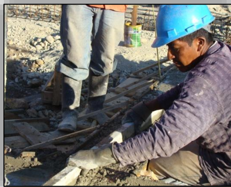
Ilustración N° 89. Nivelación del Concreto.
