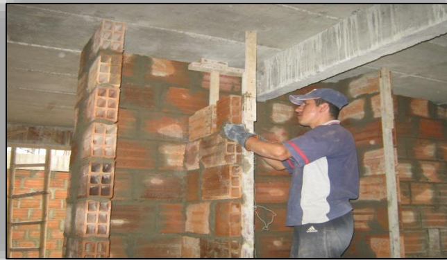
Ilustración N° 115. Terminado de Hiladas.
