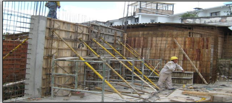
Ilustración N° 81. Muros de Carga.
