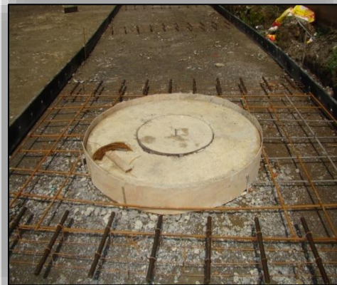
Ilustración N° 38. Refuerzo de las Cámaras de Inspección.
