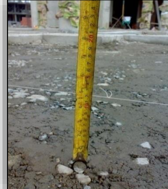
Ilustración N° 94. Verificación del espesor de las Losas.
