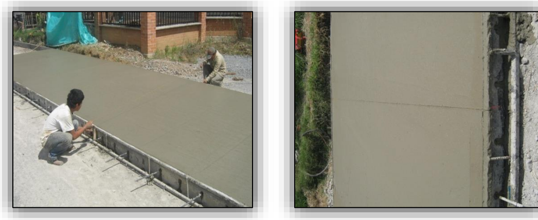
Ilustración N° 55. Cimbrado de Losas para el Corte.
