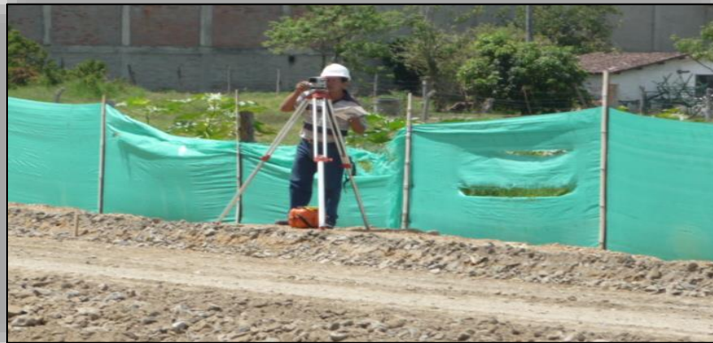
Ilustración N° 22. Nivelación de la Sub-base Granular.
