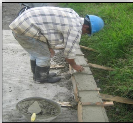
Ilustración N° 63. Acabado Superficial del Sardinel.
