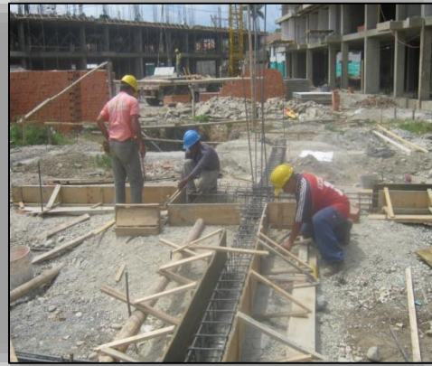
Ilustración N° 83. Instalación de formaletas para Vigas y Zapatas.
