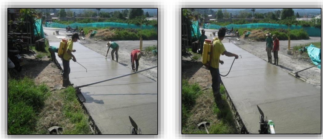
Ilustración N° 47. Aplicación de Sikafilm.
