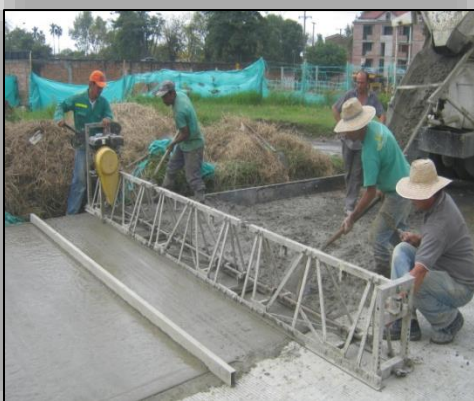
Ilustración N° 44. Vibrado externo del Concreto.
