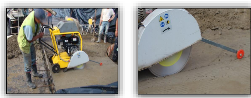
Ilustración N° 56. Corte de las Losas de Concreto.
