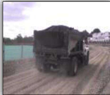
Ilustración N° 8. Desalojo del material orgánico por medio de Volquetas.
