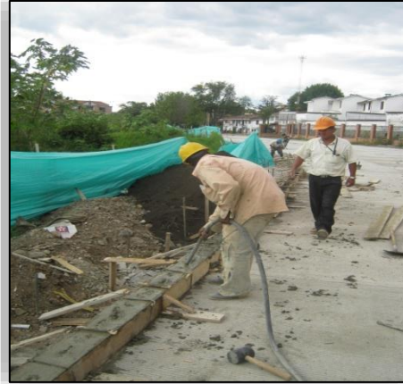
Ilustración N° 60. Vibrado del Concreto del Sardinel.
