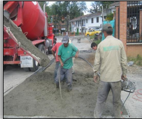
Ilustración N° 43. Vibrado interno del Concreto.
