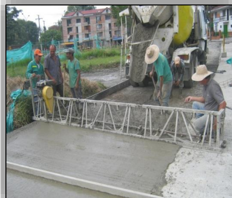
Ilustración N° 44. Vibrado externo del Concreto.
