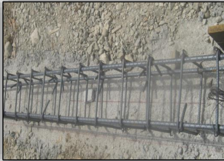
Ilustración Nº 87. Recubrimiento de los Castillos de Acero.
