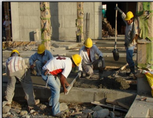
Ilustración N° 97. Nivelación de las Losas de Concreto.
