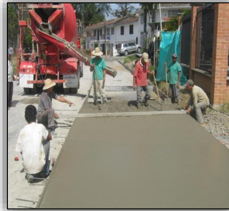
Ilustración N° 45. Nivelación del Concreto.
