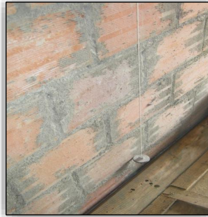
Ilustración N° 120. Chequeo con Plomo.
