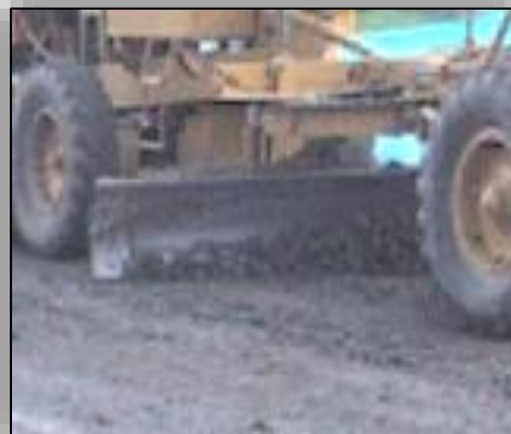
Ilustración N° 29. Escarificación de la Sub-base Granular por exceso de Humedad.
