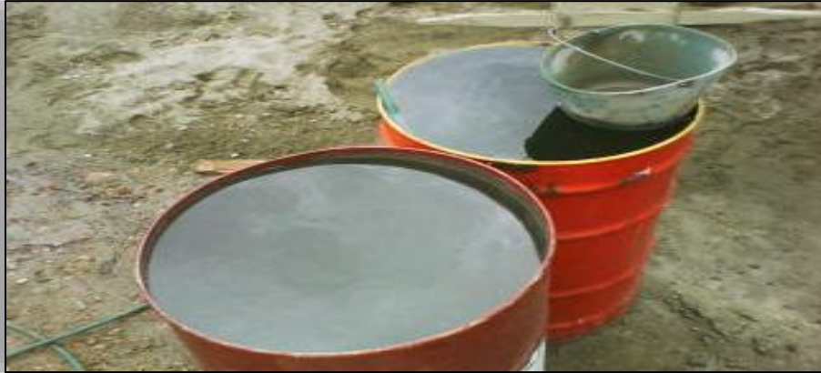
Ilustración N° 106. Agua para mezcla.
