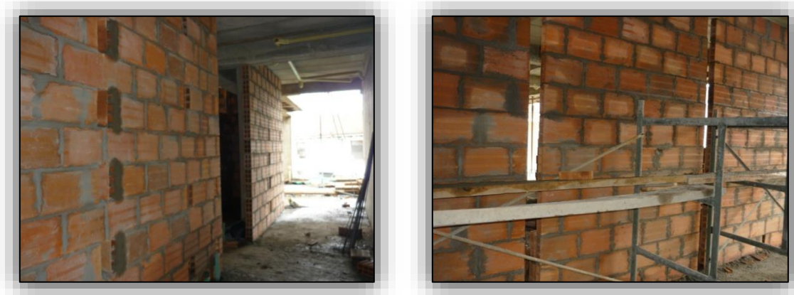
Ilustración N° 116. Trabado de Juntas.
