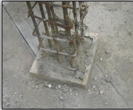
Ilustración N° 85. Adecuación del Collarín y de los Plomos.
