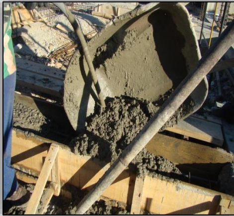
Ilustración N° 88. Vaciado y Vibrado interno del Concreto.
