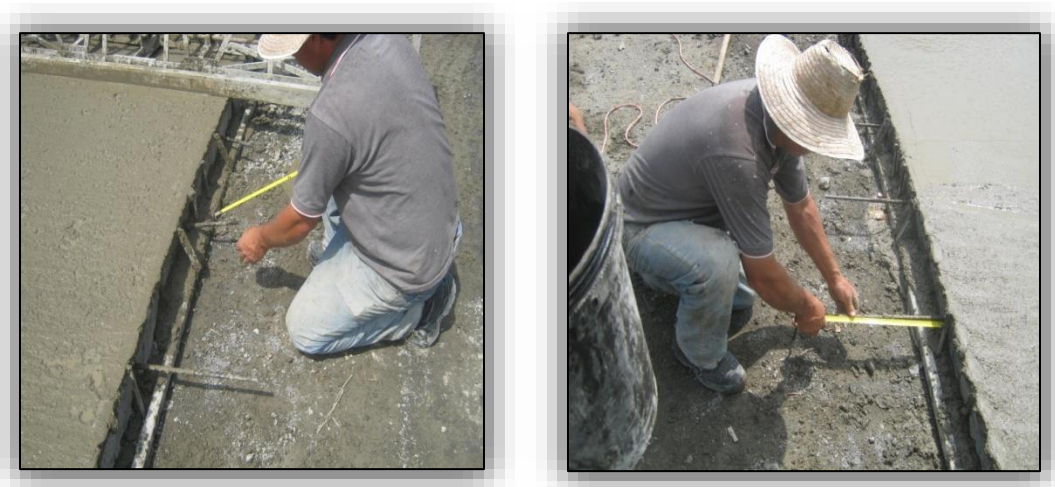
Ilustración N° 35. Colocación de los Pasadores de la Junta Longitudinal.
