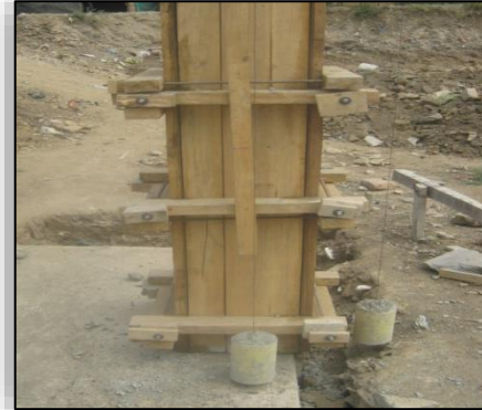
Ilustración N° 85. Adecuación del Collarín y de los Plomos.
