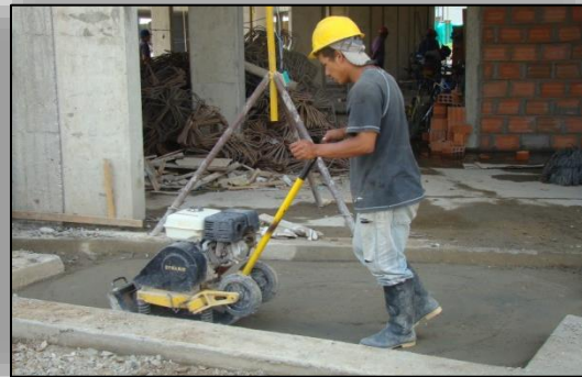
Ilustración N° 93. Compactación de la Superficie de Apoyo de las losas.
