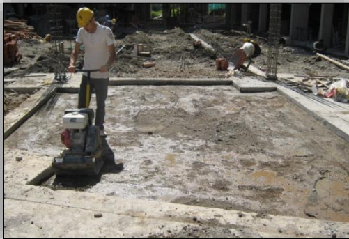
Ilustración N° 93. Compactación de la Superficie de Apoyo de las losas.
