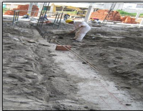
Ilustración N° 80. Adecuación del Solado de limpieza y de los castillos de las Vigas.
