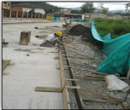
Ilustración N° 59. Instalación de Formaleta y Vaciado del Concreto.
