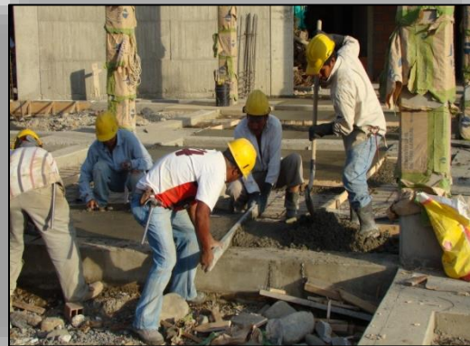
Ilustración N° 97. Nivelación de las Losas de Concreto.
