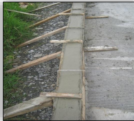
Ilustración N° 63. Acabado Superficial del Sardinel.
