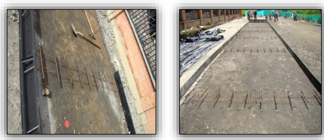
Ilustración N° 34. Colocación de los Pasadores de la Junta Transversal.
