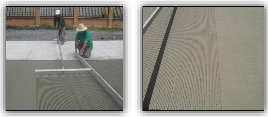
Ilustración N° 51. Finalización del Macrottexturizado.
