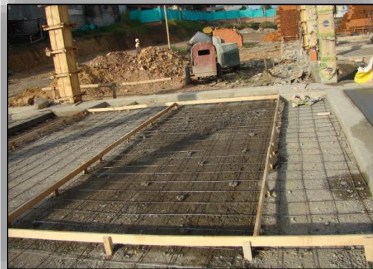
Ilustración N° 95. Malla de Refuerzo de las Losas.
