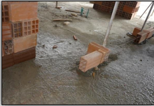
Ilustración N° 114. Referenciación Horizontal.
