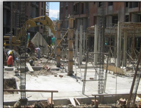
Ilustración N° 84. Instalación de Formaletas y de Puntales Metálicos.
