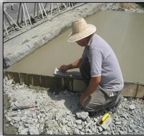
Ilustración N° 46. Enrase en los bordes de la Losa de Concreto.
