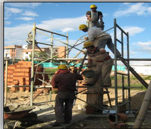
Ilustración N° 91. Fundición de las Columnas.
