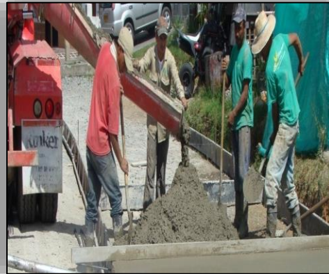
Ilustración N° 41. Vaciado del Concreto.
