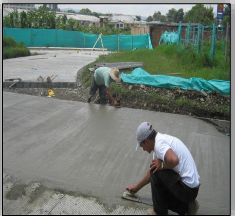
Ilustración N° 46. Enrase en los bordes de la Losa de Concreto.
