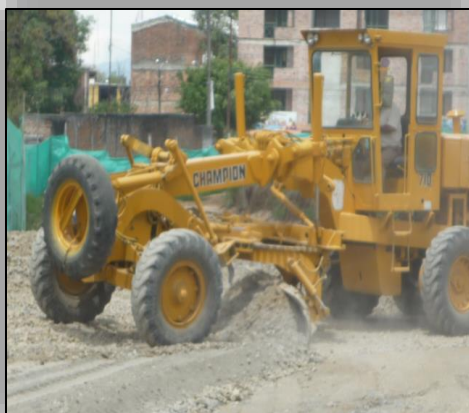
Ilustración N° 20. Extensión y conformación de la Sub-base granular.
