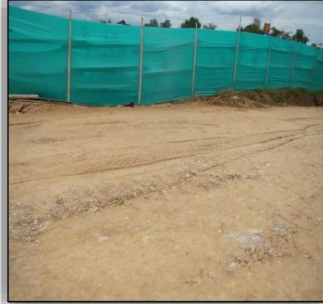
Ilustración N° 15. Compactación de la Capa de Subrasante.
