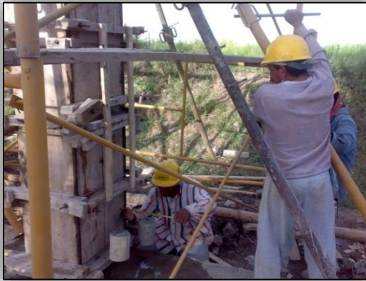
Ilustración N° 92. Chequeo de Plomos.
