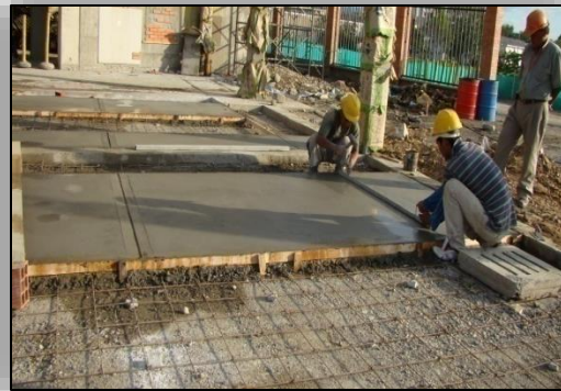
Ilustración N° 99. Juntas de Construcción.
