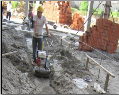
Ilustración N° 79. Compactación del soporte de la Vigas y Zapatas.
