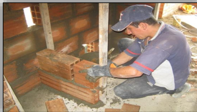
Ilustración N° 113. Conformación de Hiladas.
