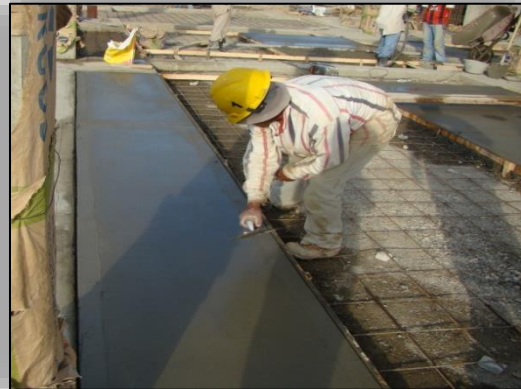
Ilustración N° 98. Acabado Superficial de las Losas de Concreto.
