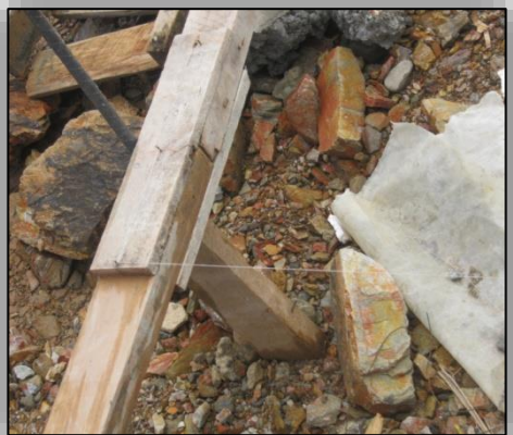
Ilustración N° 77. Puentes e Hiladeros del Parqueadero.
