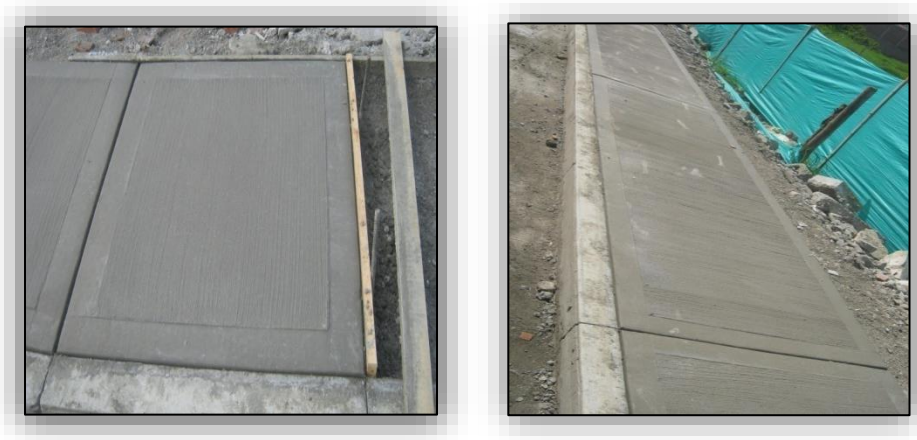
Ilustración N° 64. Acabado Superficial del Andén.
