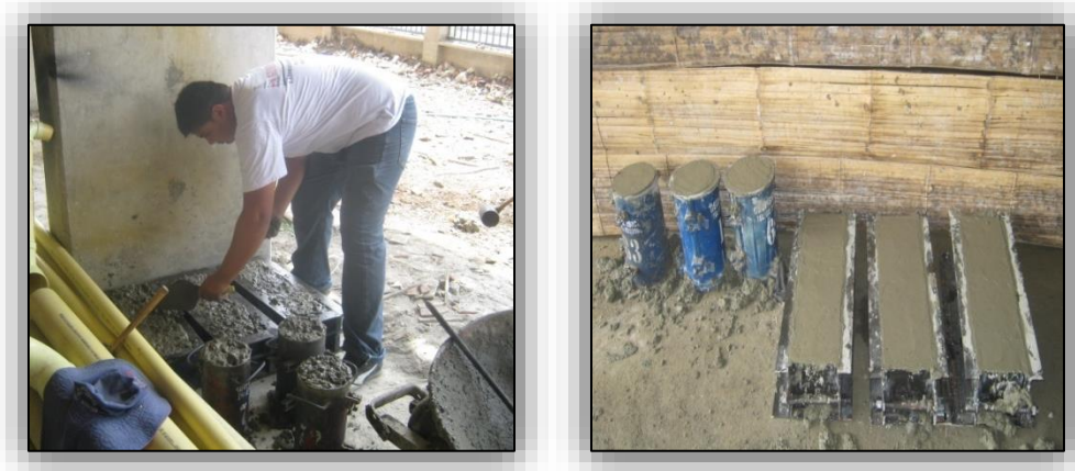
Ilustración N° 68. Muestras de Cilindros y Vigas de Concreto.
