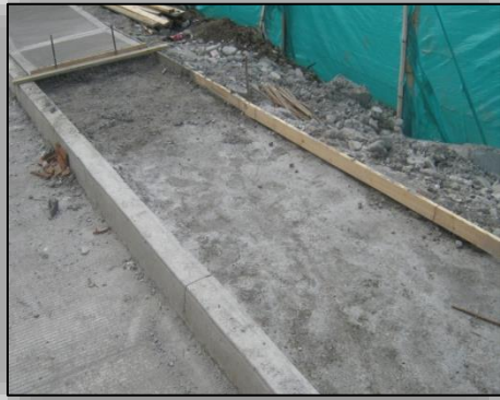
Ilustración N° 62. Instalación de Formaleta y Transporte del Concreto.
