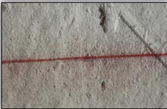
Ilustración N° 110. Demarcación con Cimbra.
