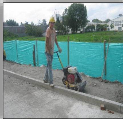
Ilustración N° 61. Compactación de la Superficie de Apoyo del Andén.
