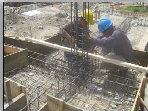
Ilustración N° 82. Conformación de Vigas.
