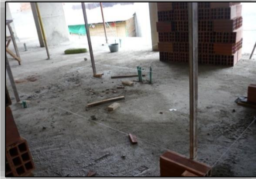
Ilustración N° 114. Referenciación Horizontal.
