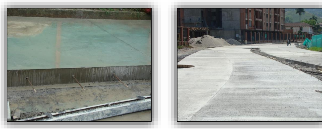
Ilustración N° 57. Retiro de Formaletas.
