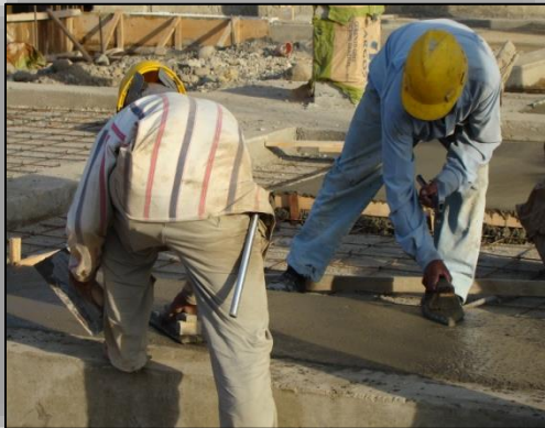
Ilustración N° 98. Acabado Superficial de las Losas de Concreto.
