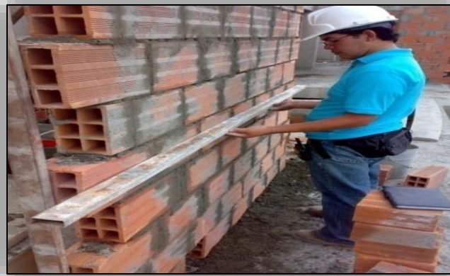
Ilustración N° 121. Chequeo con Codal.
