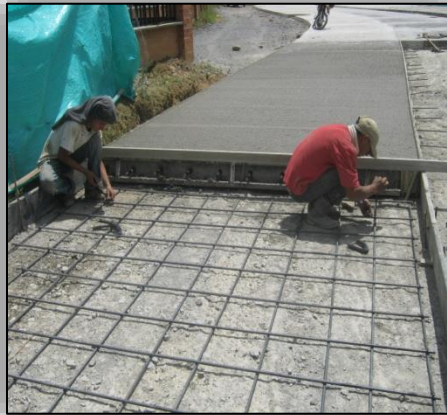
Ilustración N° 37. Armado de las Parrillas de refuerzo.
