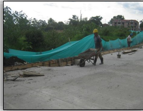
Ilustración N° 62. Instalación de Formaleta y Transporte del Concreto.
