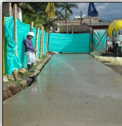
Ilustración N° 53. Curado Húmedo.
