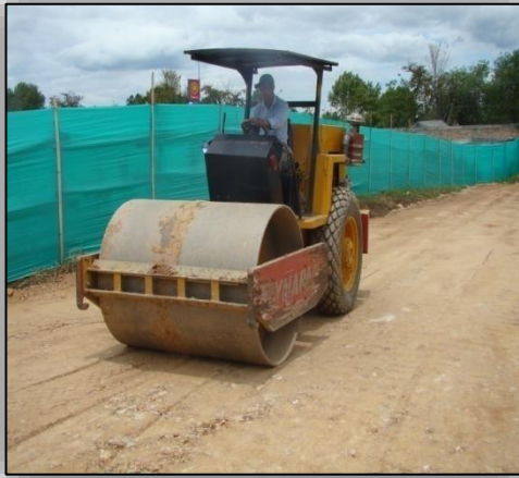
Ilustración N° 15. Compactación de la Capa de Subrasante.
