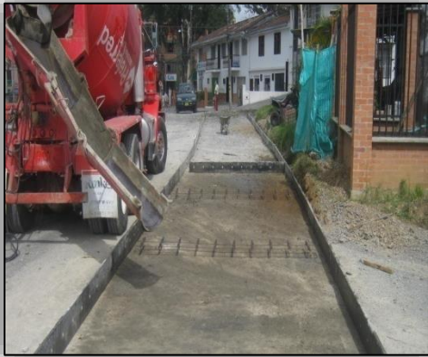
Ilustración N° 41. Vaciado del Concreto.
