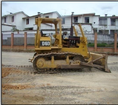
Ilustración N° 13. Extensión del material de Subrasante con Bulldozer D 6 D.
