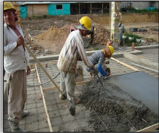
Ilustración N° 96. Vaciado y vibrado interno del Concreto de las Losas.
