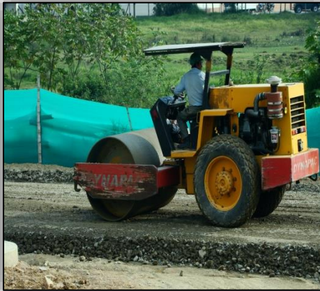
Ilustración N° 19. Vibrocompactador Dinapack CA15 y Motoniveladora.
