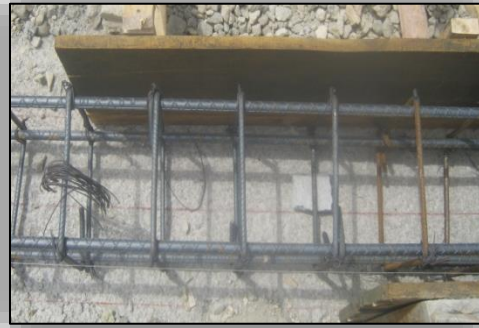
Ilustración Nº 87. Recubrimiento de los Castillos de Acero.
