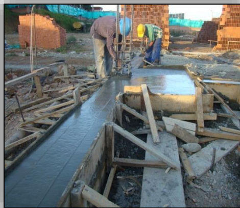
Ilustración N° 90. Acabado Superficial del Concreto.
