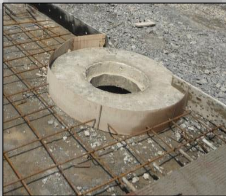
Ilustración N° 38. Refuerzo de las Cámaras de Inspección.
