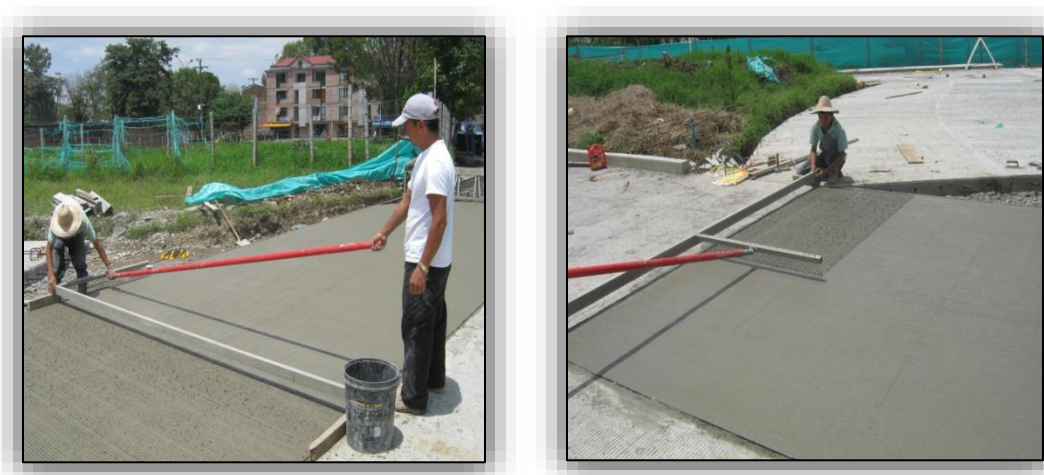
Ilustración N° 50. Implementación del Rayador para el Macrottexturizado.
