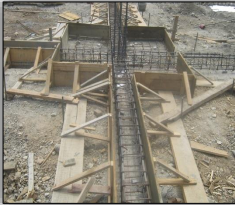
Ilustración N° 83. Instalación de formaletas para Vigas y Zapatas.
