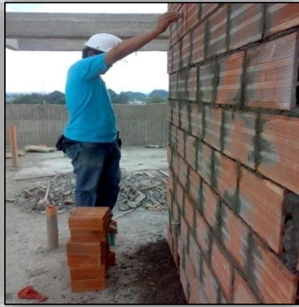
Ilustración N° 120. Chequeo con Plomo.
