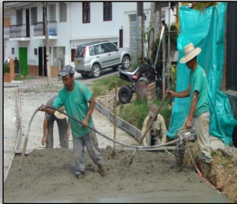
Ilustración N° 43. Vibrado interno del Concreto.
