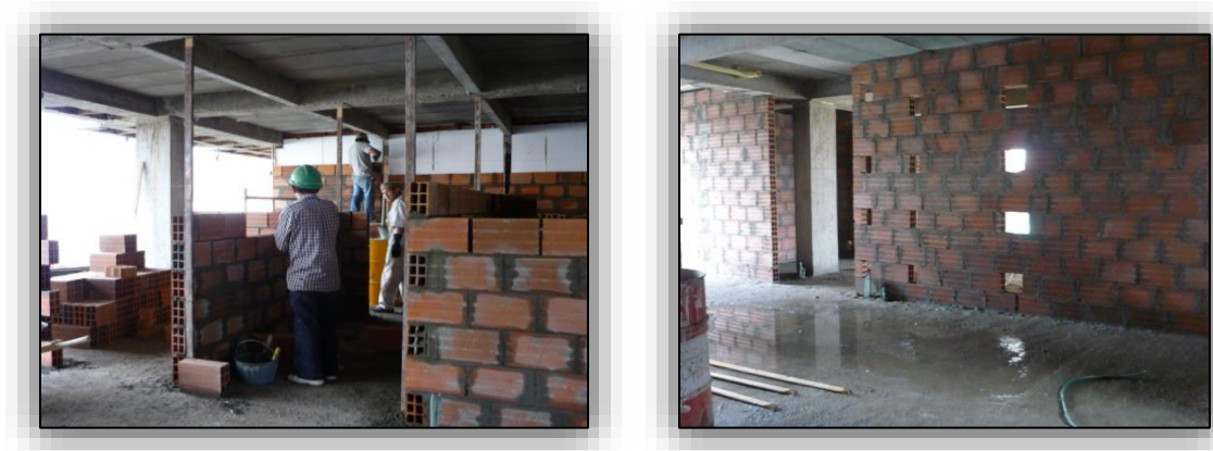
Ilustración N° 117. Terminado de Muros.
