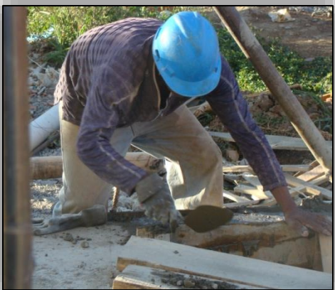
Ilustración N° 90. Acabado Superficial del Concreto.
