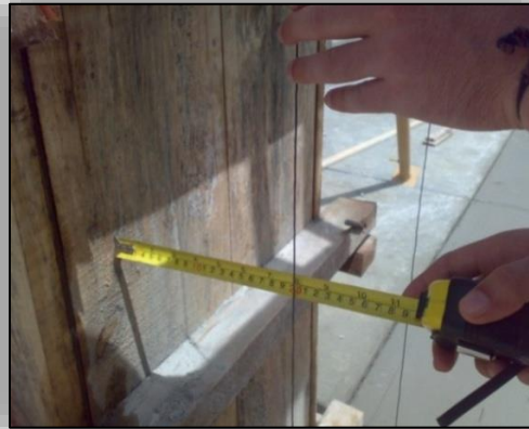
Ilustración N° 92. Chequeo de Plomos.
