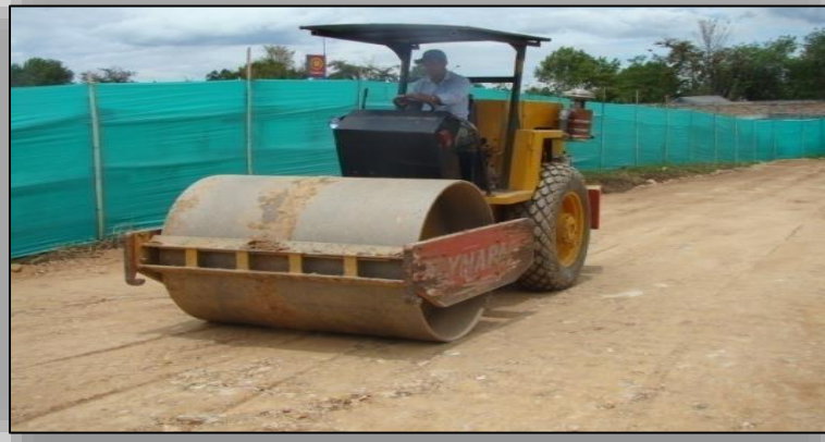
Ilustración N° 78. Conformación de la Subrasante.
