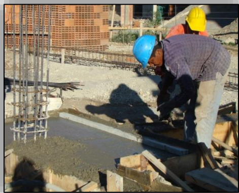
Ilustración N° 89. Nivelación del Concreto.
