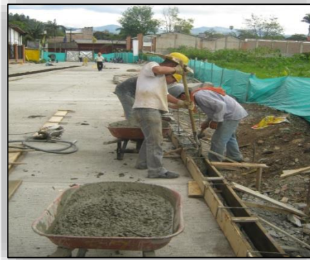
Ilustración N° 59. Instalación de Formaleta y Vaciado del Concreto.
