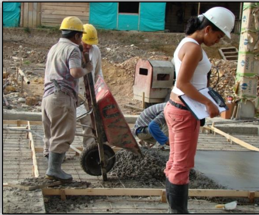
Ilustración N° 96. Vaciado y vibrado interno del Concreto de las Losas.
