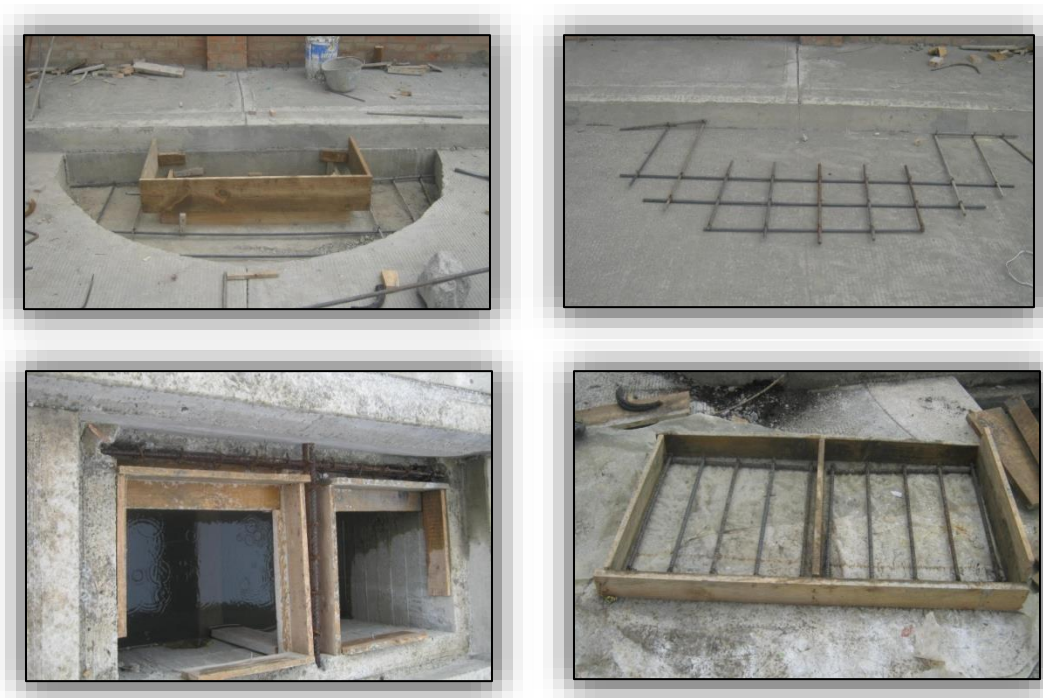
Ilustración N° 39. Refuerzo de los Sumideros.
