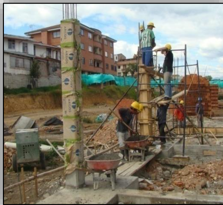
Ilustración N° 91. Fundición de las Columnas.
