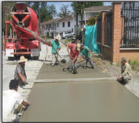
Ilustración N° 45. Nivelación del Concreto.
