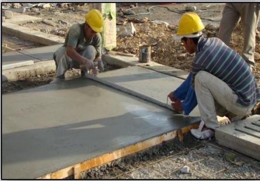
Ilustración N° 99. Juntas de Construcción.
