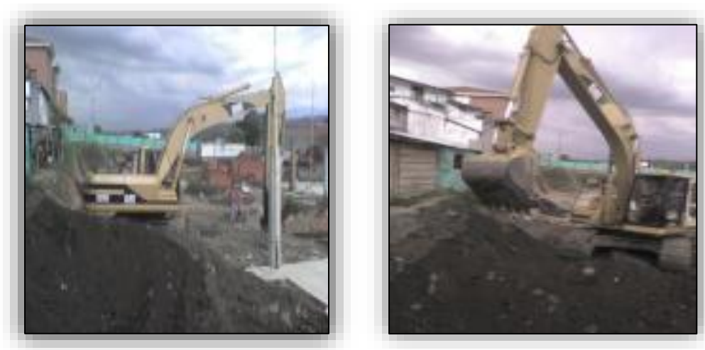
Ilustración N° 6. Remoción del material orgánico por medio de la Retroexcavadora CAT 320 B.
