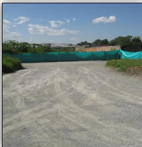
Ilustración N° 25. Compactación de la Sub-base Granular.
