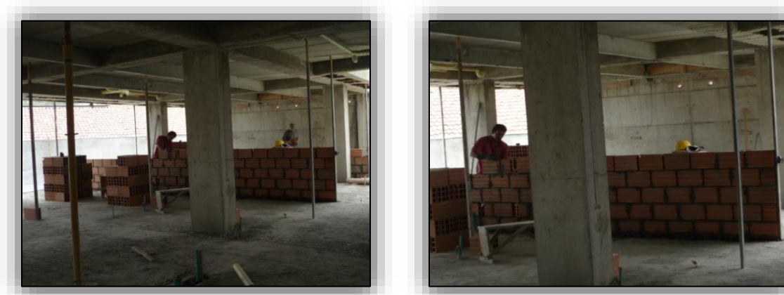
Ilustración N° 111. Colocación de las Reglas Metálicas.
