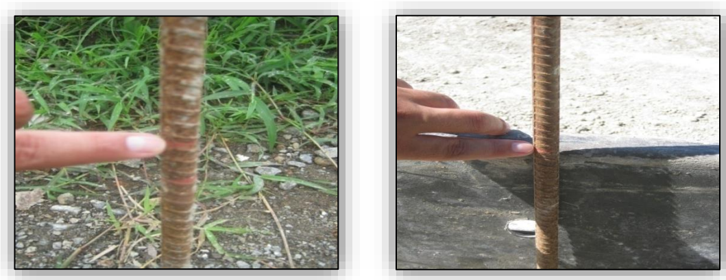
Ilustración N° 33. Demarcación de los Niveles de la Formaleta Metálica.
