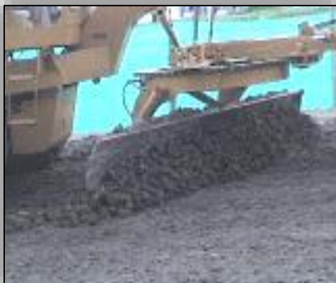
Ilustración N° 29. Escarificación de la Sub-base Granular por exceso de Humedad.
