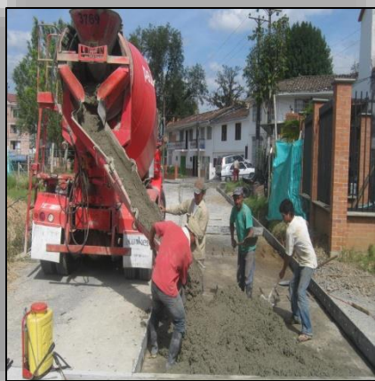
Ilustración N° 42. Distribución del Concreto.
