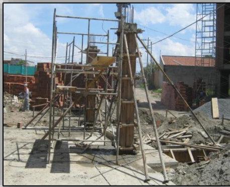
Ilustración N° 84. Instalación de Formaletas y de Puntales Metálicos.
