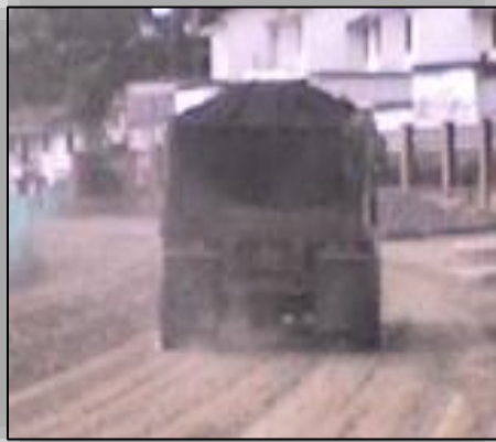
Ilustración N° 8. Desalojo del material orgánico por medio de Volquetas.
