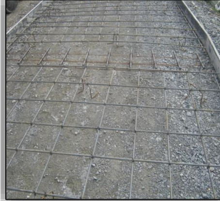
Ilustración N° 37. Armado de las Parrillas de refuerzo.
