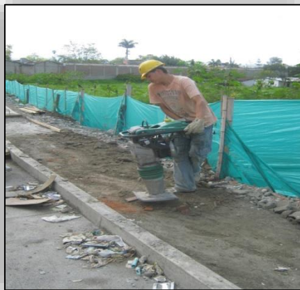
Ilustración N° 61. Compactación de la Superficie de Apoyo del Andén.
