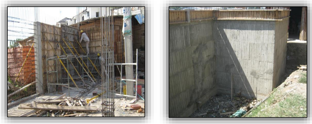
Ilustración N° 100. Fundición de Muros de Carga.
