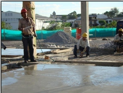
Ilustración N° 102. Curado del Concreto del Parqueadero.
