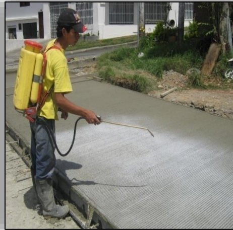
Ilustración N° 52. Curado Químico.
