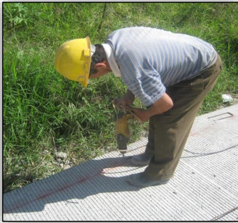
Ilustración N° 58. Conformación del Sardinel.
