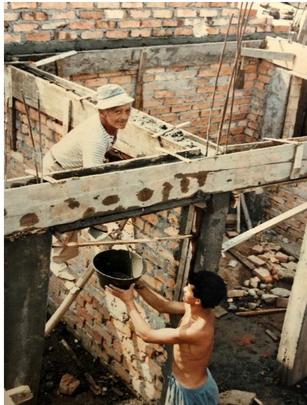
Imagen 13. Autoconstrucción barrio El Lago. Fuente: archivo personas Luis Botina.
