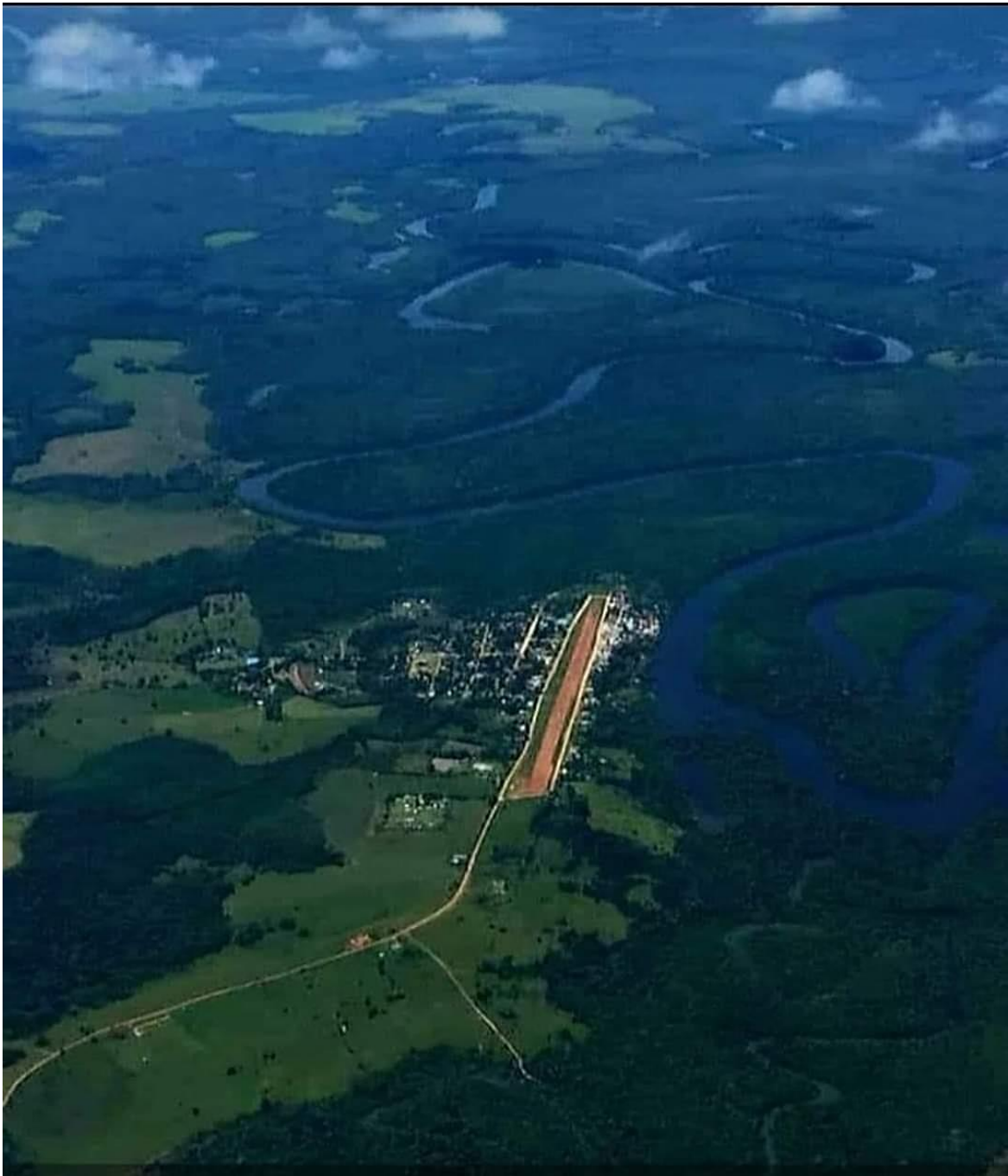
Vista aérea de la cabecera municipal de Miraflores Guaviare en sentido sur-norte. En la fotografía se destaca la pista de aterrizaje construida en el tiempo de la cauchería que dio origen al municipio y el puerto sobre el río Vaupés. Siguiendo el curso hacia el sur (arriba de la fotografía) el río es el camino hacia el Resguardo Indígena de Puerto Nare. Fuente: Alcaldía Municipal de Miraflores.
