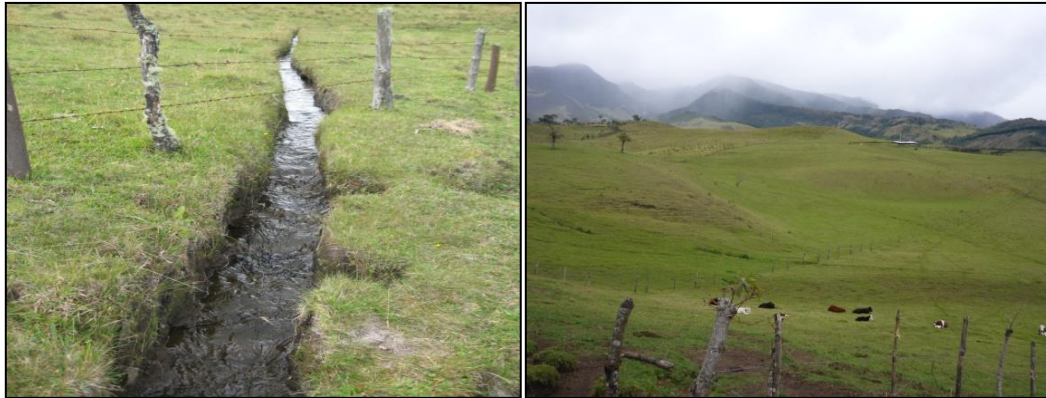
Fotografía 8: Zanjas o canales - Terraplenes Alto San Juan
