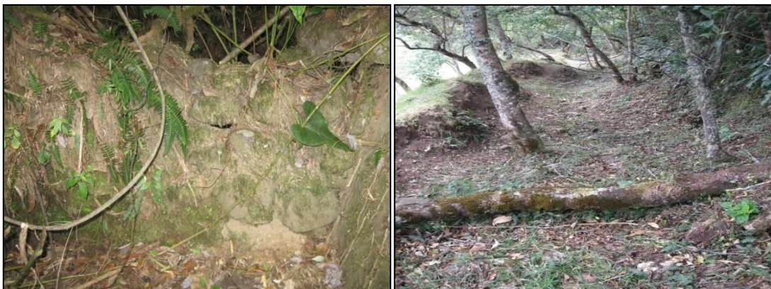
Fotografía 10: Muro al lado de la piedra – Camino
