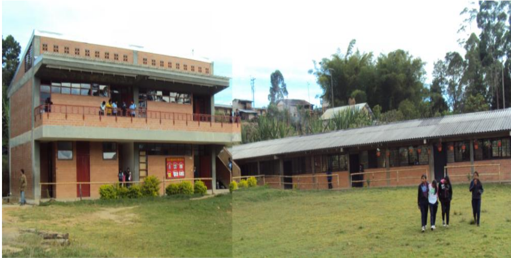
Ilustración 5. Estructura Sede Principal Institución Educativa Kwe'sx Dxi'j
