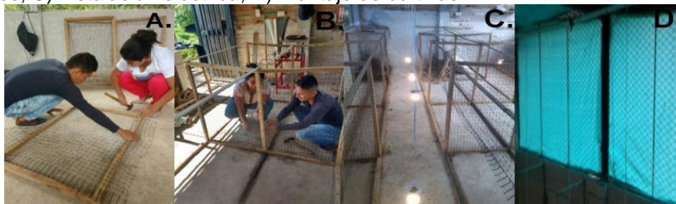
Figura 6. Adecuación del galpón. A) Construcción de divisiones; B) Ensamble de divisiones; C) Instalación eléctrica; D) Montaje de cortinas
