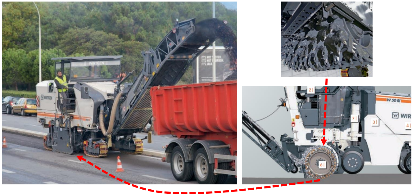
Grafica No 2. Actividad de fresado con equipo fresadora en frio. (Obsérvese la ubicación del tambor de fresado y la posibilidad del mismo de no cargar a la banda transportadora).
