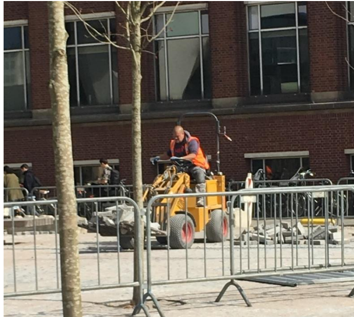
Figura 7.2 Transporte de adoquines de concreto después de retirarlos para realizar una reparación de la zona inferior en la ciudad de Amsterdam (Fuente propia)
