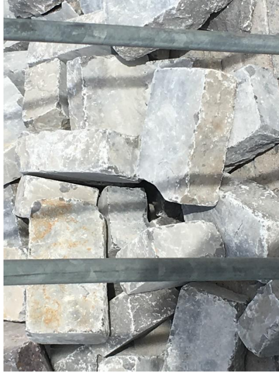
Figura 7.3 Almacenamiento de adoquines de concreto después de retirados, para reutilizarlos en la misma obra, ciudad de Ámsterdam (Fuente propia)
