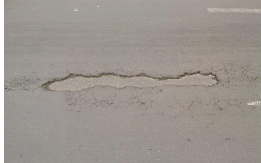
Fotografía 2. Descascaramiento. Fuente: Esta investigación.
