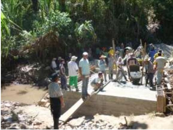
**Fig.64** Vaciado del concreto
