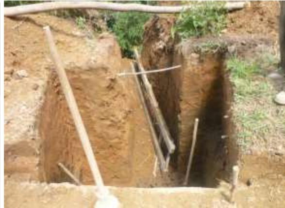
**Fig.132** Excavación para el descole
