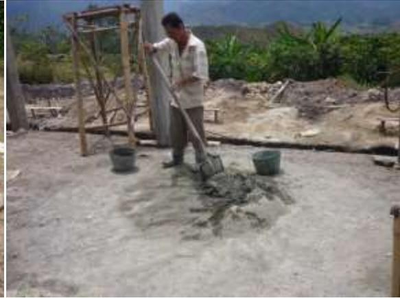
**Fig.102 Preparación de la mezcla**
