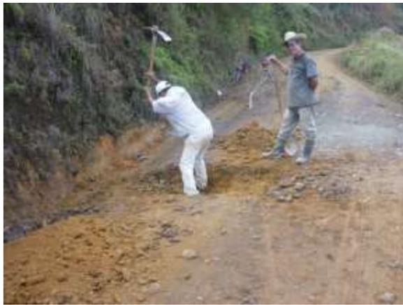
Fig.134 Excavación manual
