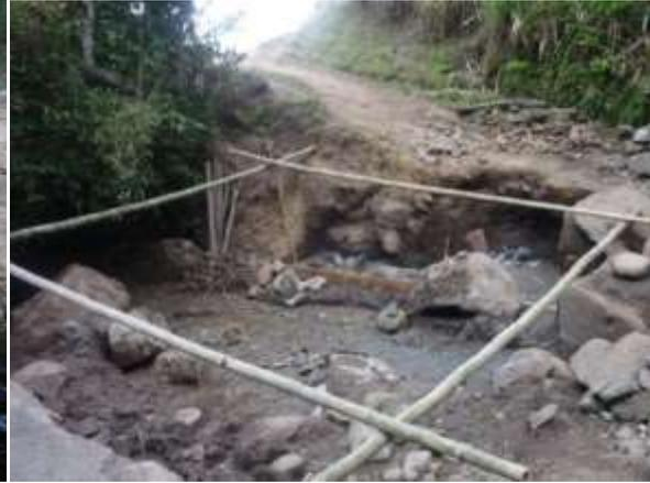
Fig.55 Excavación para la fundición de los estribos
