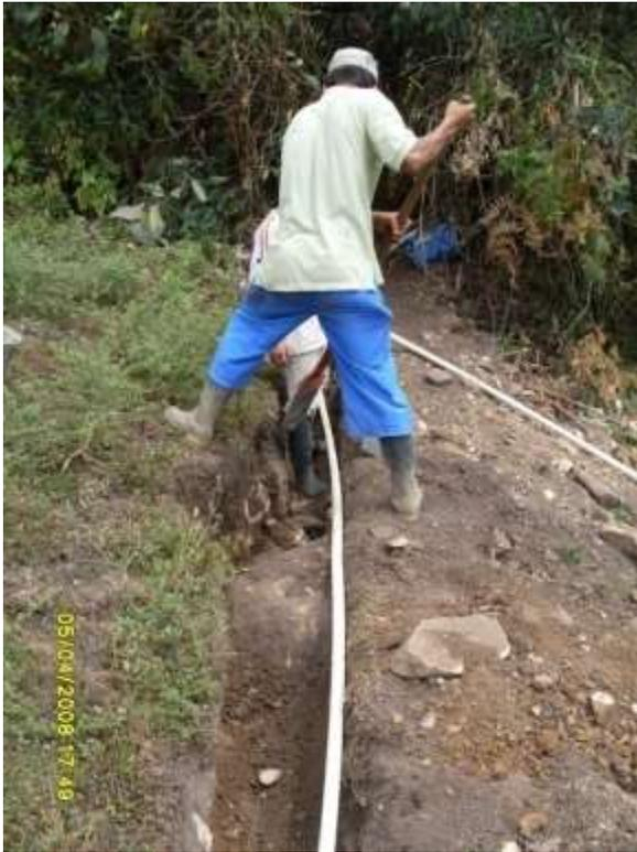
Fig.169 Excavación y colocación de la tubería
