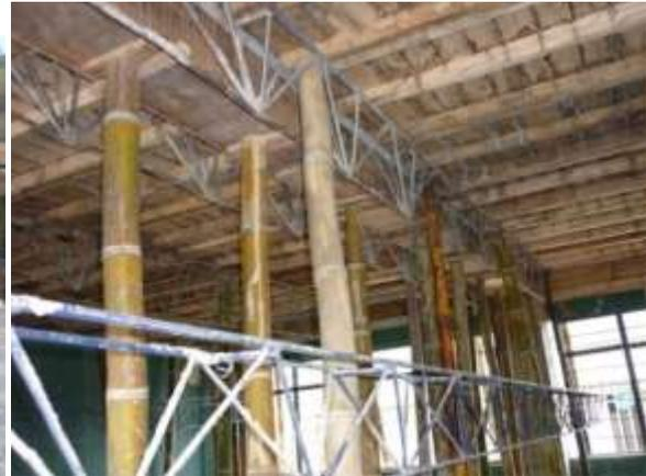
Fig.12 Encofrado listo para fundir la losa
