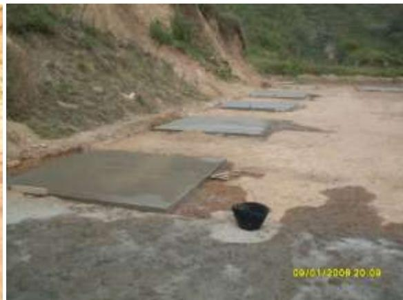
Fig.21 Construcción intercalada de las placas
