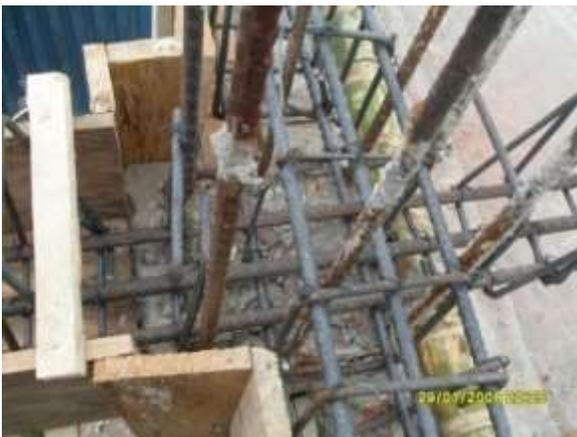
Fig.15 Detalle de de un nudo entre una columna y dos vigas
