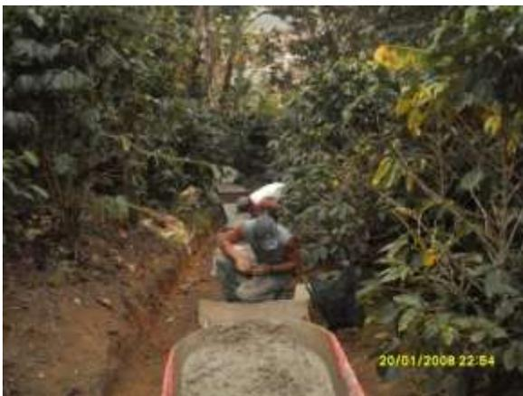
Fig.38 Colocación del concreto
