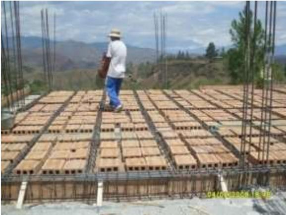
Fig.13 Colocación de ladrillo farol para aligerarla losa
