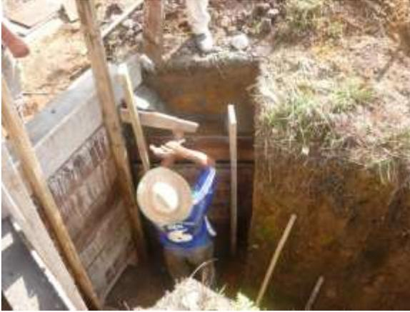
**Fig.138 Desencofrado de la alcantarilla**
