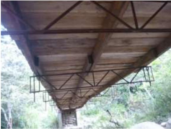
**Fig.32** Vista inferior del puente después de realizadas las reparaciones
