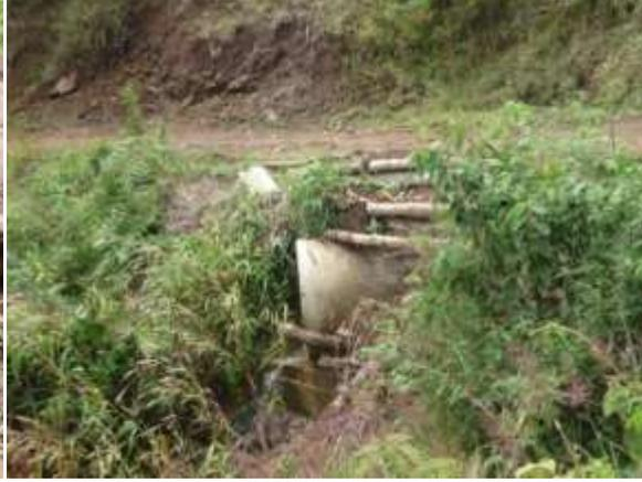
**Fig.158 Salida de la alcantarilla**
