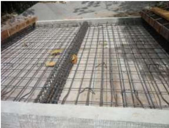
**Fig.62 Acero para las vigas y la losa**
