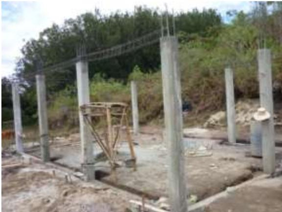
**Fig.103 Viga de cimentación y columnas**
