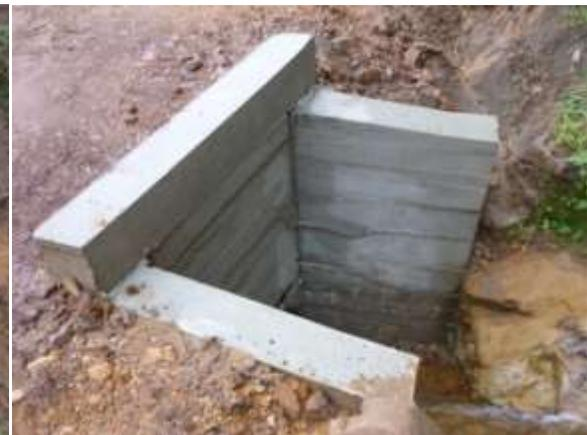
Fig.156 Cabezal de entrada
