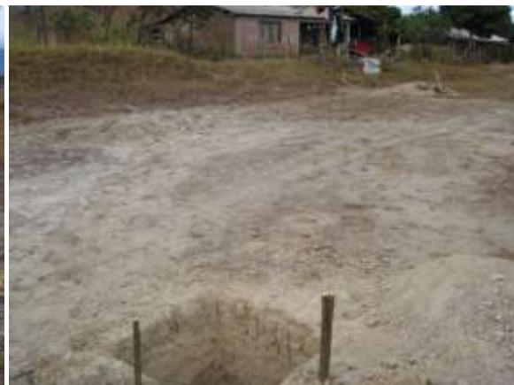
Fig.76 Excavación para las zapatas
