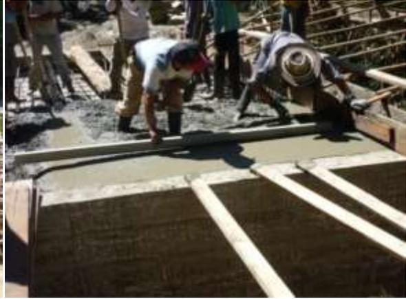
**Fig.65** Colocación del concreto
