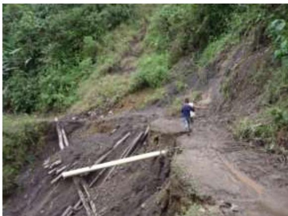
Fig.114 Deslizamiento de la banca
