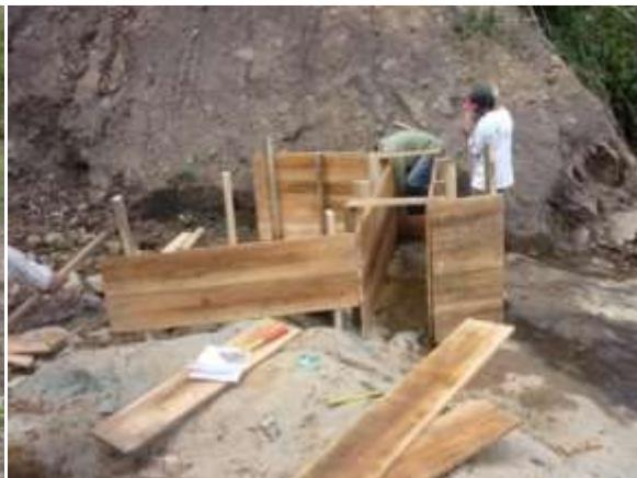
Fig.69 Formaleta para la bocatoma
