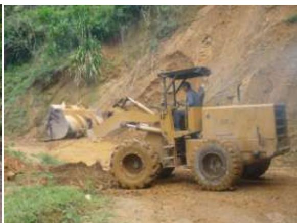
Fig.115 Retiro de derrumbos de la vía
