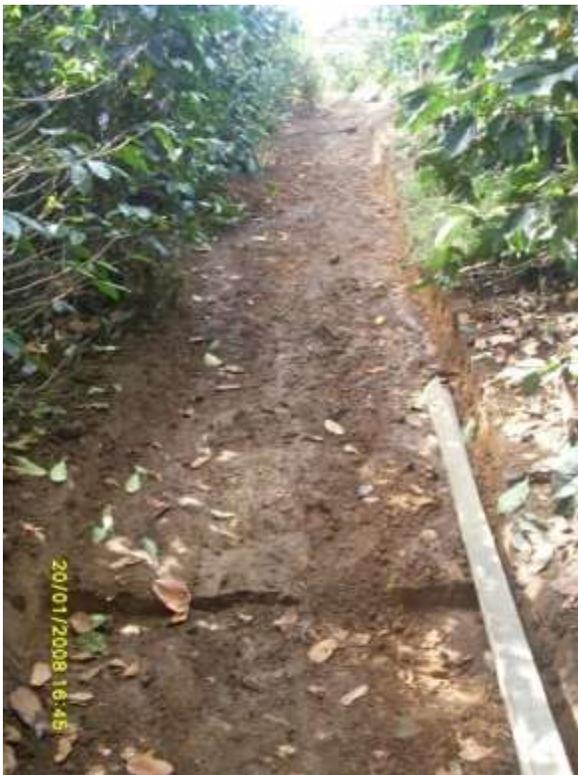
Fig.36 Descapote del camino existente
