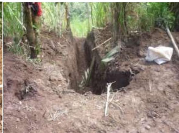
Fig.124 Excavación para el descole
