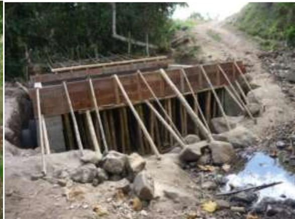
**Fig.61 Encofrado para fundir las vigas y la losa**
