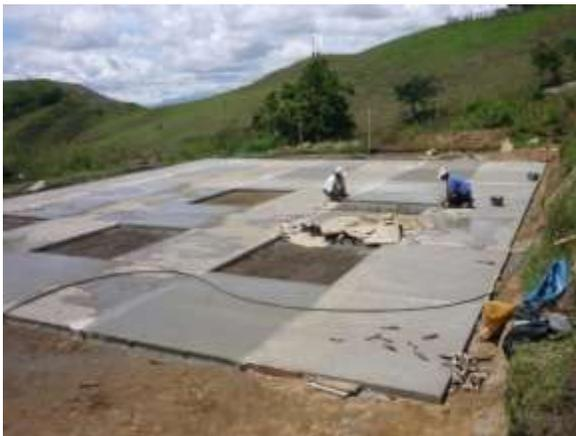
Fig.112 Proceso constructivo de la cancha
