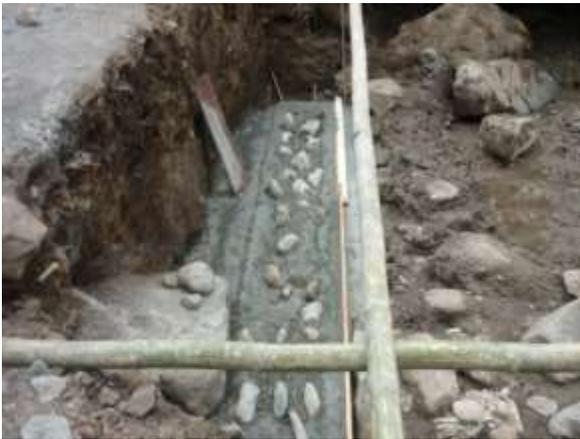
Fig.56 Fundición de un estribo
