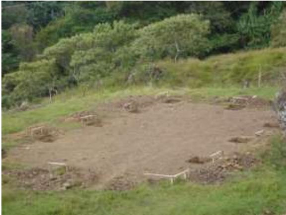
Fig.42 Nivelación del terreno
