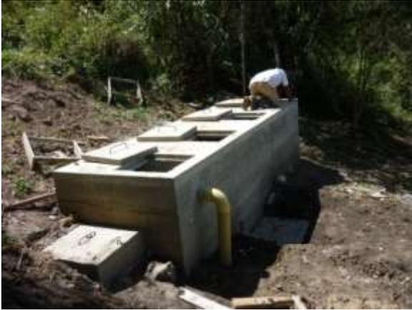
Fig.72 Vista general del desarenador
