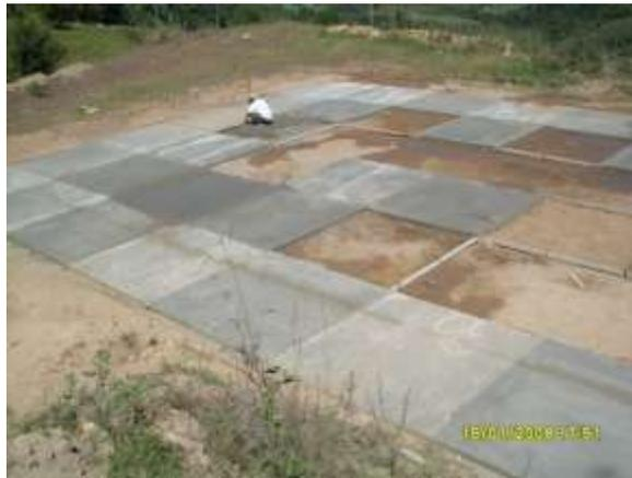
**Fig.24** Construcción de las placas internas de la cancha
