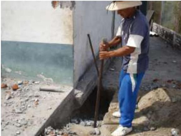
Fig.9 Excavación para construir la zapata
