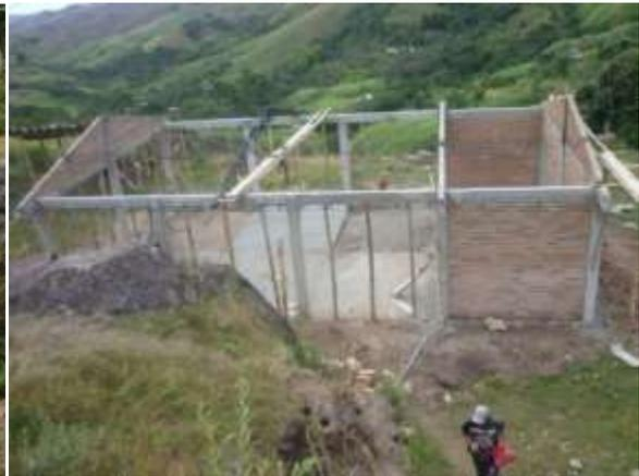
**Fig.47** Vista de las culatas y la cercha para colocar la Cubierta
