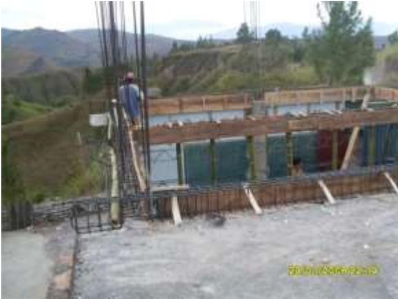
Fig.11 Colocación del acero de refuerzo
