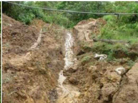
Fig.164 Excavación para construir el filtro
