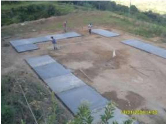
**Fig.22** Continuación del proceso constructivo de placas intercaladas
