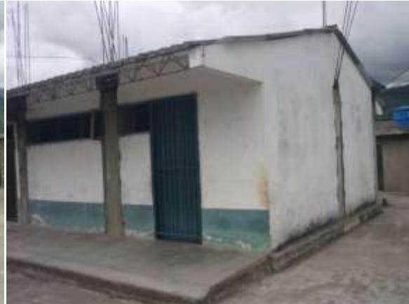
Fig.8 Esquina donde falta una columna de refuerzo
