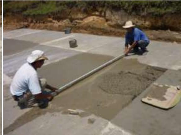
Fig.111 Colocación del concreto
