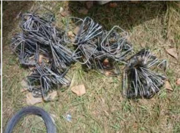
Fig.43 Estribos para vigas y columnas
