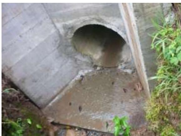
Fig.145 Cabezal de salida
