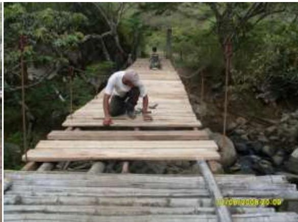
**Fig.31** Cambio de la estructura en guadua por piezas de madera
