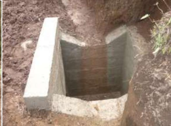
**Fig.128** Cabezal de entrada
