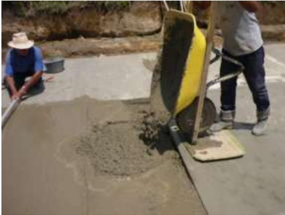
Fig.110 Vaciado del concreto
