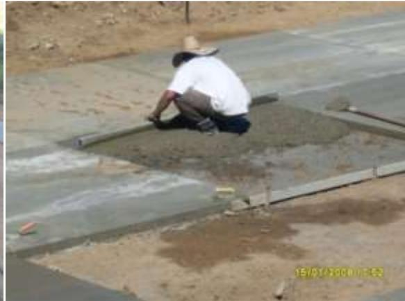
**Fig.23** Colocación del concreto
