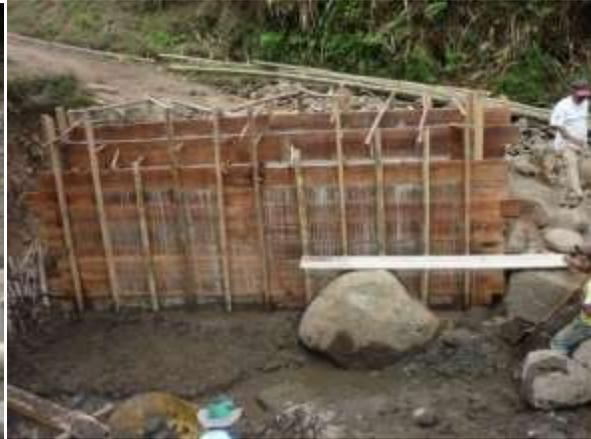
Fig.57 Estribo antes de desencofrar
