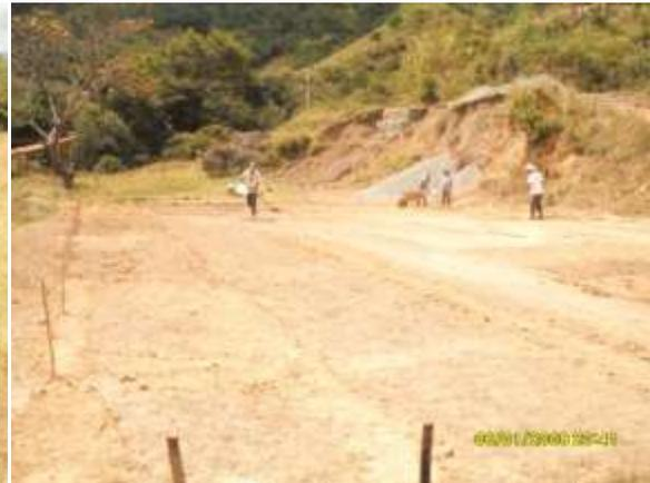
Fig.19 Descapote del terreno
