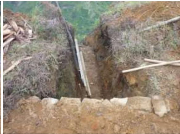
Fig.135 Excavación para el descole
