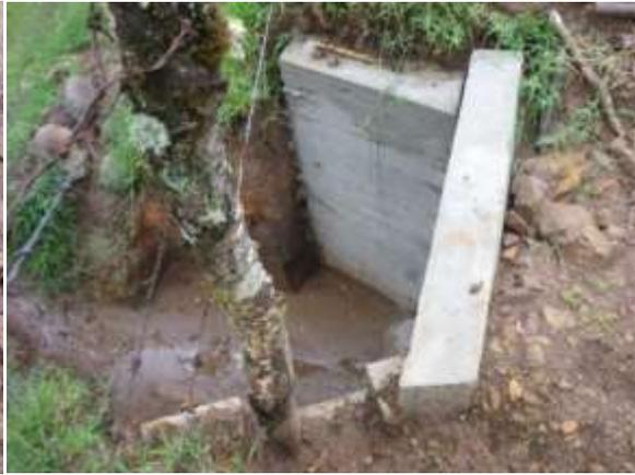
**Fig.160 Cabezal de salida**
