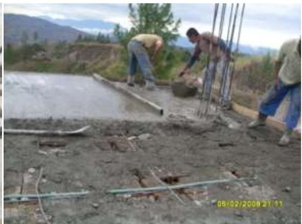
Fig.16 Colocación del concreto
