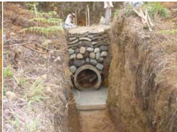
Fig.137 Salida de la tubería
