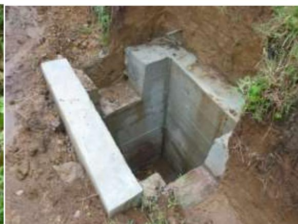
Fig.149 Cabezal de entrada
