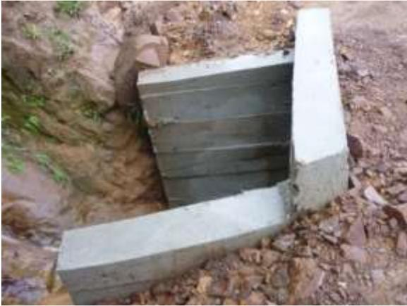
**Fig.159 Cabezal de entrada**
