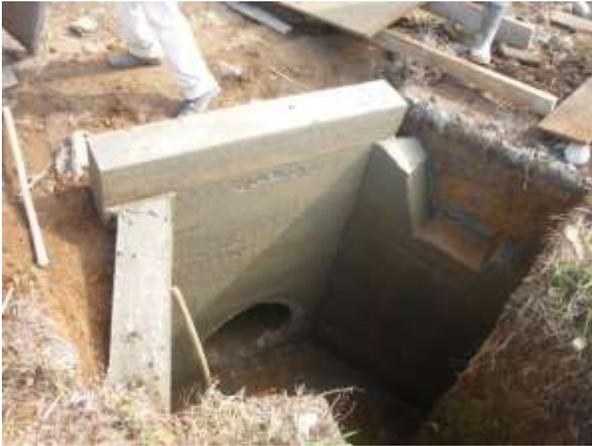
**Fig.140 Cabezal de salida**
