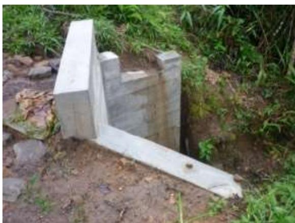
Fig.150 Cabezal de salida
