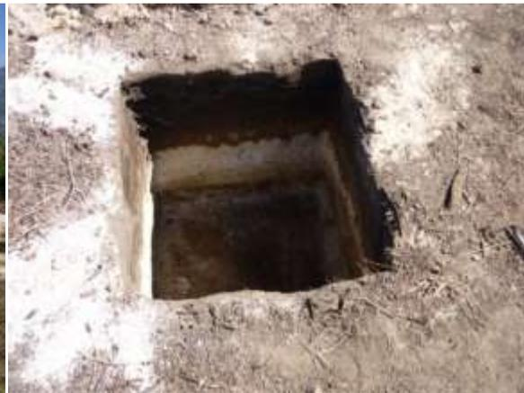
Fig.98 Excavación para las zapatas
