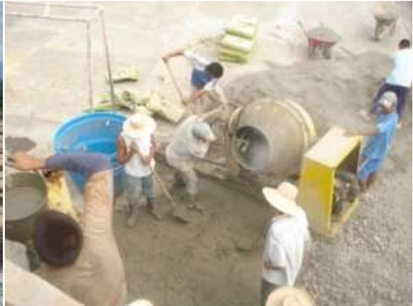
Fig.14 Preparación de la mezcla para la fundición
