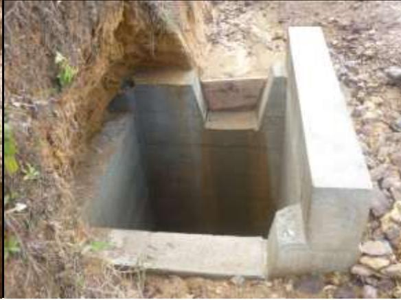
**Fig.139 Cabezal de entrada**
