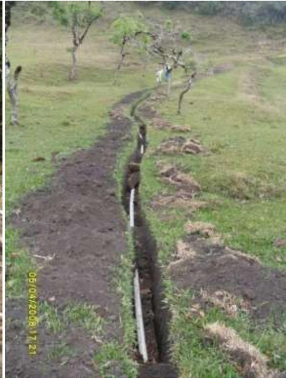
Fig.170 Tubería colocada
