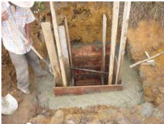
Fig.136 Fundición del cabezal de entrada
