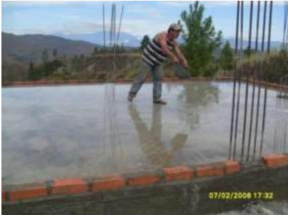
Fig.17 Curado de la losa
