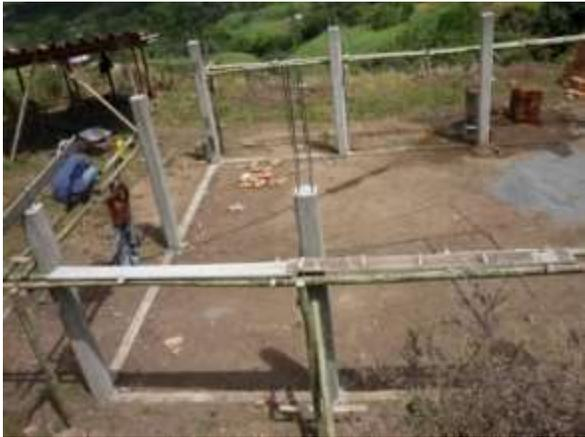
**Fig.44** Viga de cimentación y columnas
