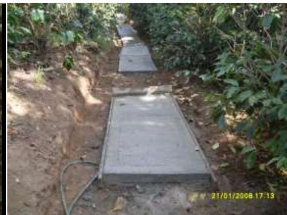
Fig.39 Construcción intercalada de las placas
