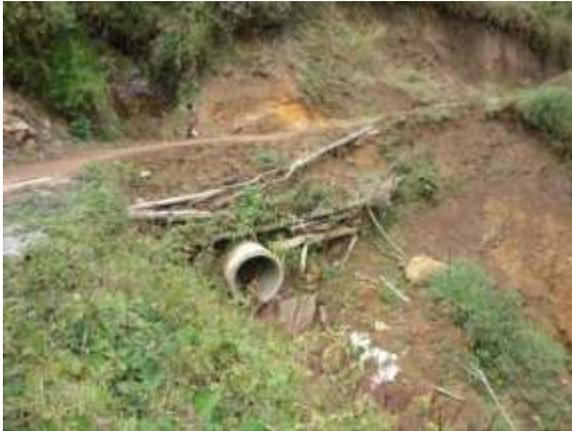
Fig.151 Salida de la alcantarilla
