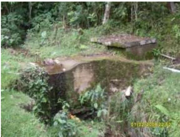
Fig. 167 Bocatoma y desarenador existente
