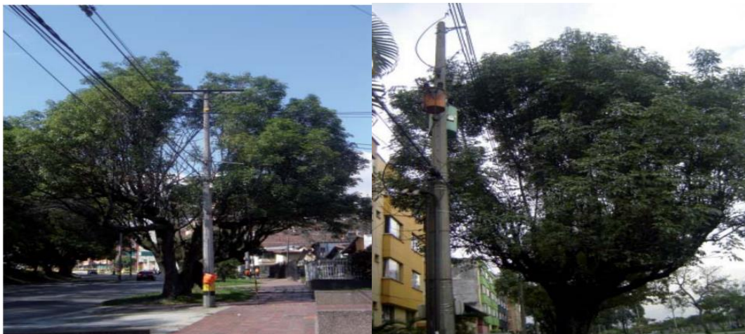
Figura 1. Árboles con necesidad de intervención a causa de su ubicación bajo redes eléctricas
