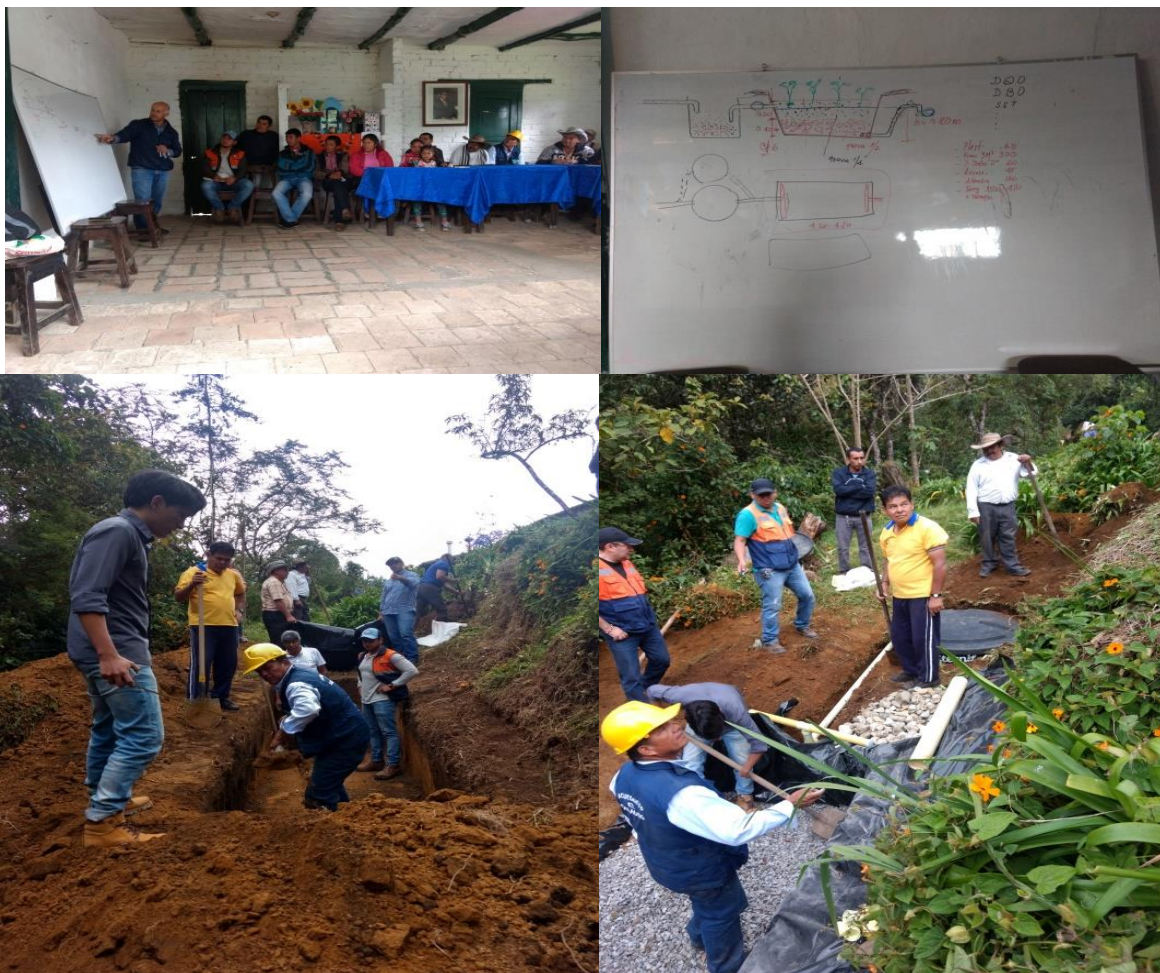
Figura 5. Capacitación para la instalación de Bio filtros
