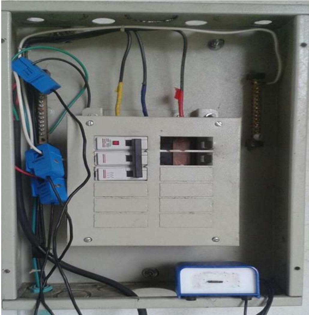
Figura A.4 Conexión del nodo sensor de corriente
