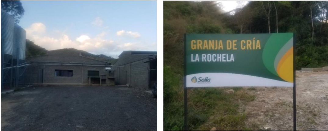
Figura 11. Entrada a la granja de cría la Rochela
