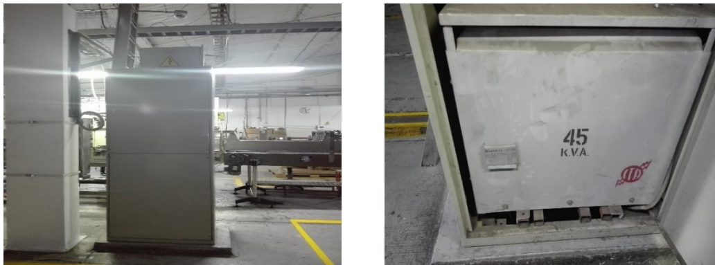
Ilustración 4.28: Transformador tipo seco de protección.
