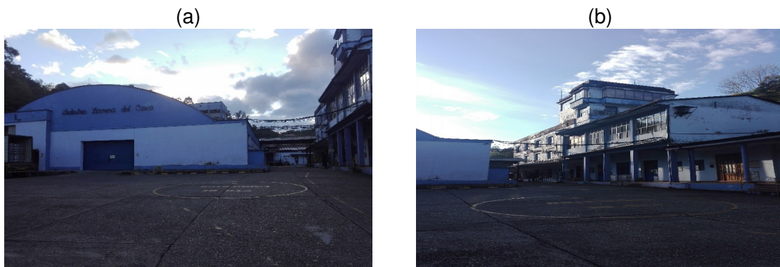
Ilustración 4.2: a) Bodega de suministros b) área de preparación y laboratorio. Industria Licorera del Cauca
