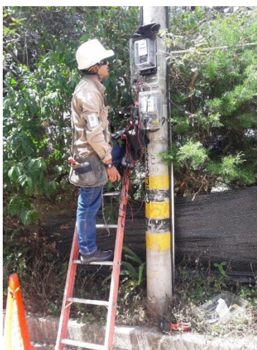
Figura 42. Operador MACRO realizando prueba de dosificación [Fuente Propia]
