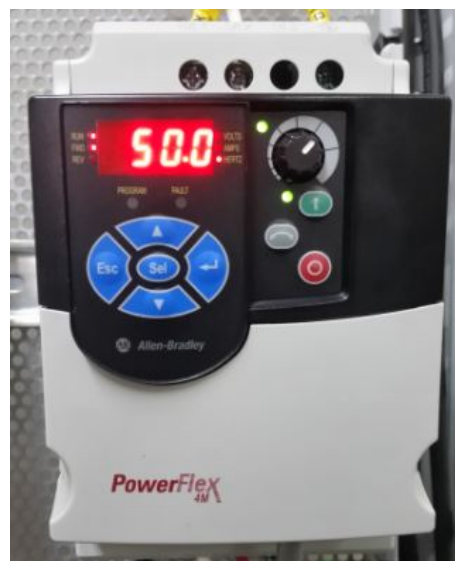
Figura 2.4: Variador de frecuencia Powerflex.
