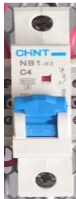
Figura I 4. Breaker de encendido.
