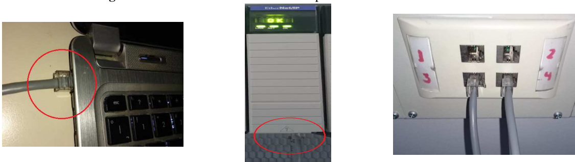
Figura J 6. Conexión Ethernet de los dispositivos a través de cable de red.
