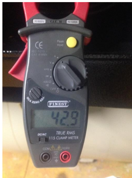
Imagen 12. Corriente compresor estado carga. Fuente Propia
