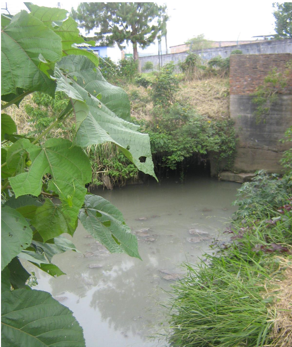
Salida de aguas residuales, fuente de malos olores y contaminación.
