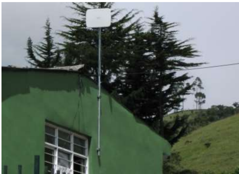
Figura 3-0-6 Mástil Instalado en Puracé.
